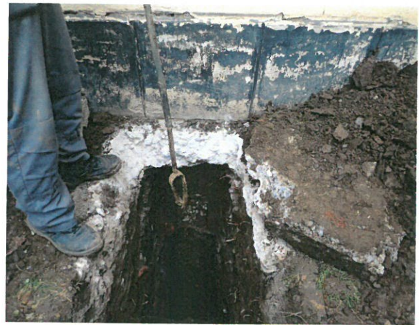
Foto 52 - vedere PVC13 +FmC 12
