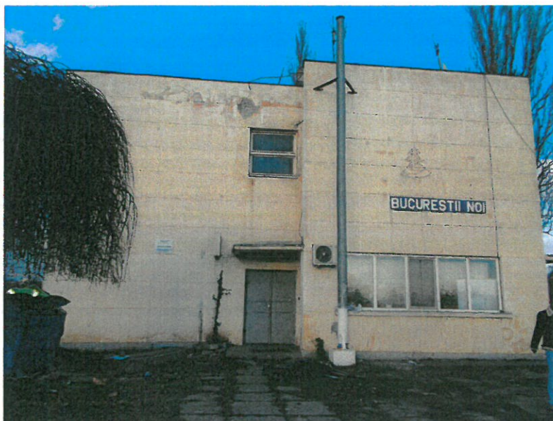
Foto 1 –vedere cabina CE
