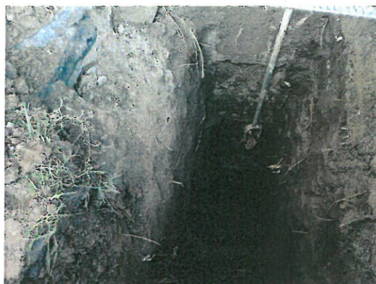
Foto 30 - vedere PVC 09+FMC 08
