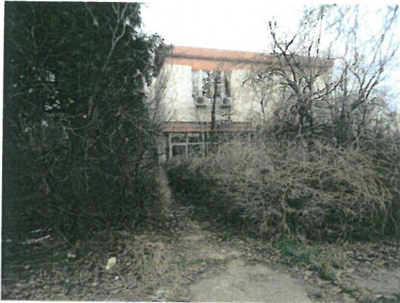
Foto 59 –vedere cladire CED
