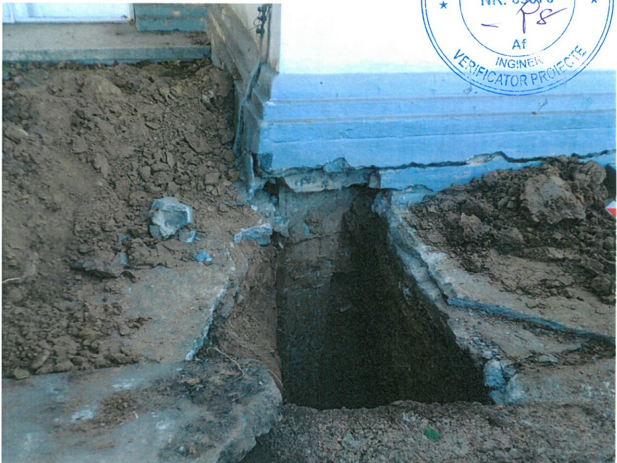
Foto 8 - vedere PVC 04-grinda sprijinita pe piloti
