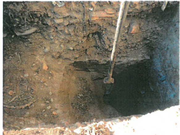
Foto 22 - vedere PVC 07+FMC 06
