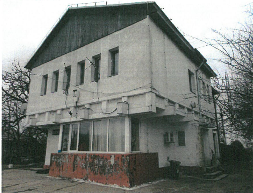
Foto 24 –vedere cladire CED
