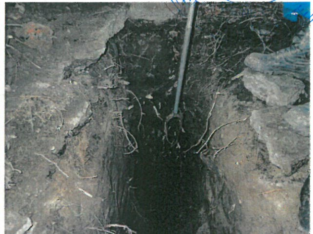
Foto 26 - vedere PVC 08+FMC 07
