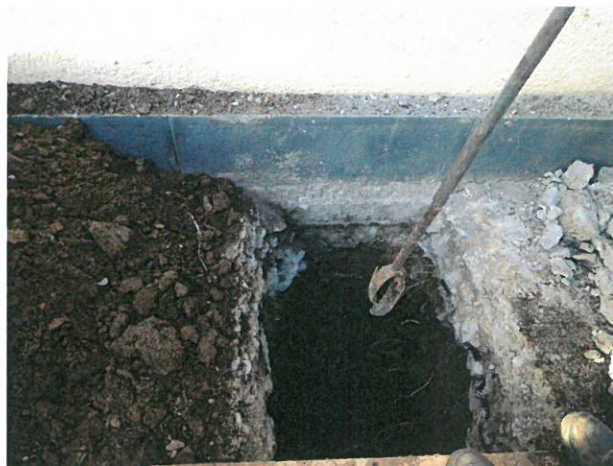
Foto 66 - vedere PVC17 +FmC 16
