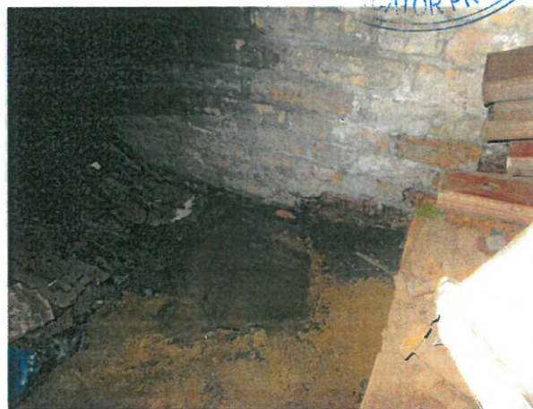
Foto 6 –vedere subsol - vedere PVC 03b
