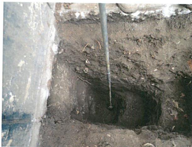
Foto 48 - vedere PVC11 +FmC 10
