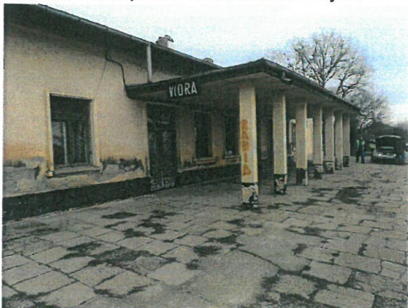
Foto 54 –vedere laterala cladire calatori
