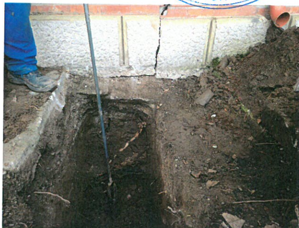
Foto 40 - vedere PVC12 +FmC 11
