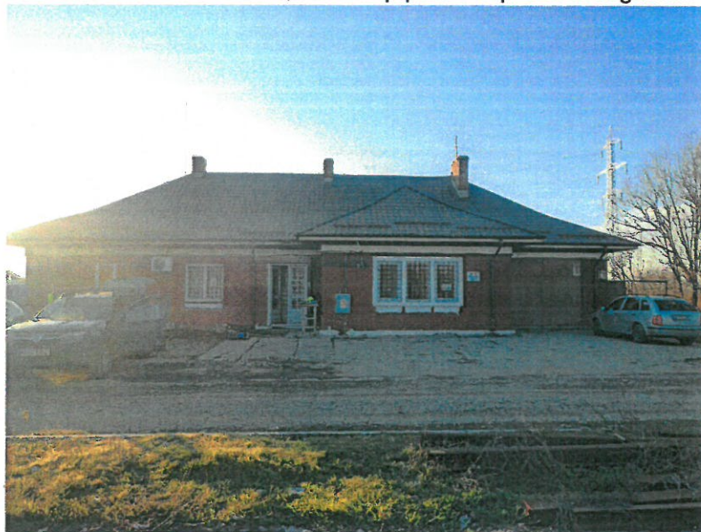
Foto 16 –vedere cladire calatori Bucuresti Vest
