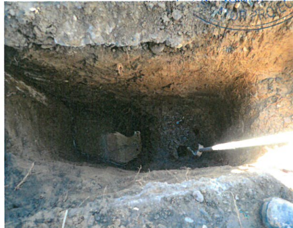
Foto 14 - vedere PVC 05+FMC 04
