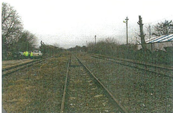
Foto 4.5. vedere km 17+850 spre km 18+000
