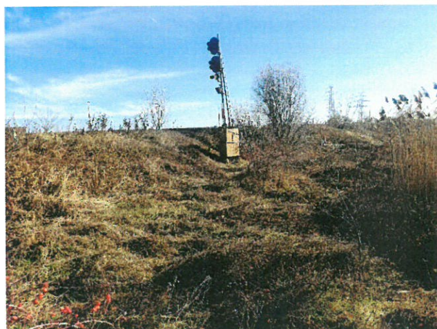
Foto 4.3. km 7+100 - vedere laterala rambleu
