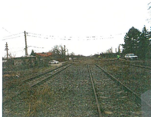
Foto 4.6. vedere km 17+850 spre km 17+500
