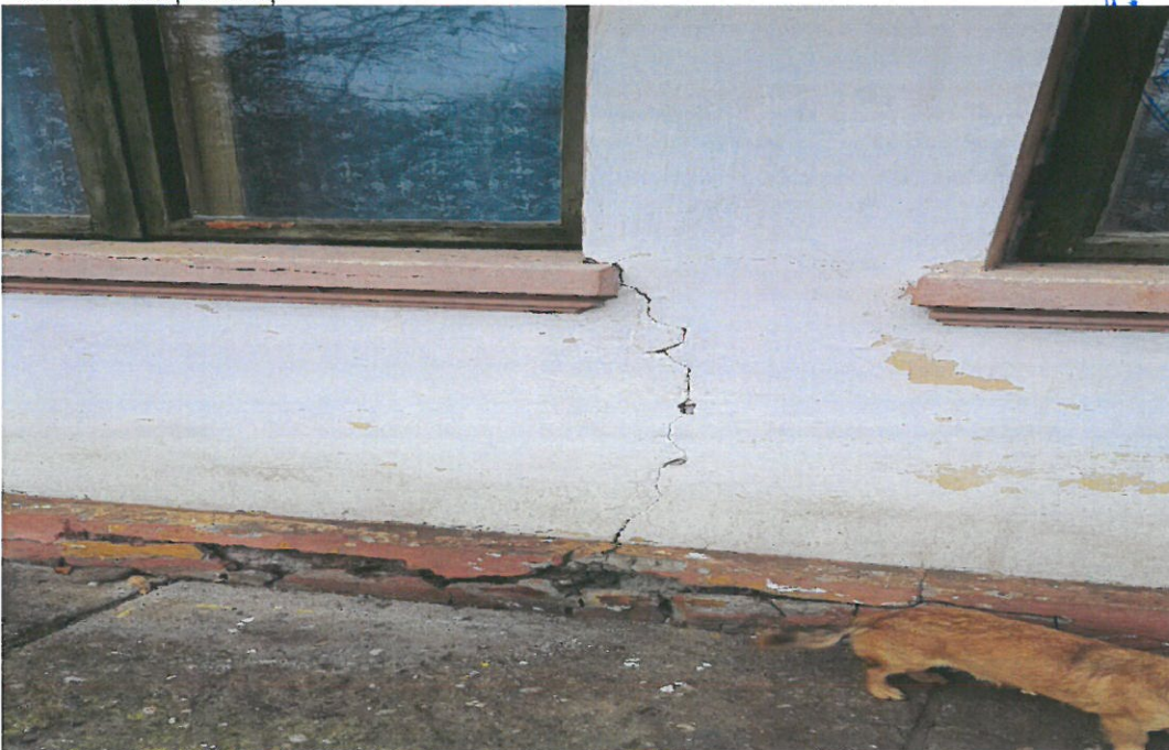
Exterior Pereți fisurați
