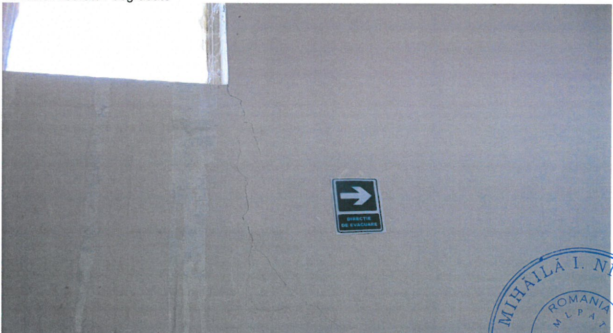
Tencuieli fisurate / degradate
