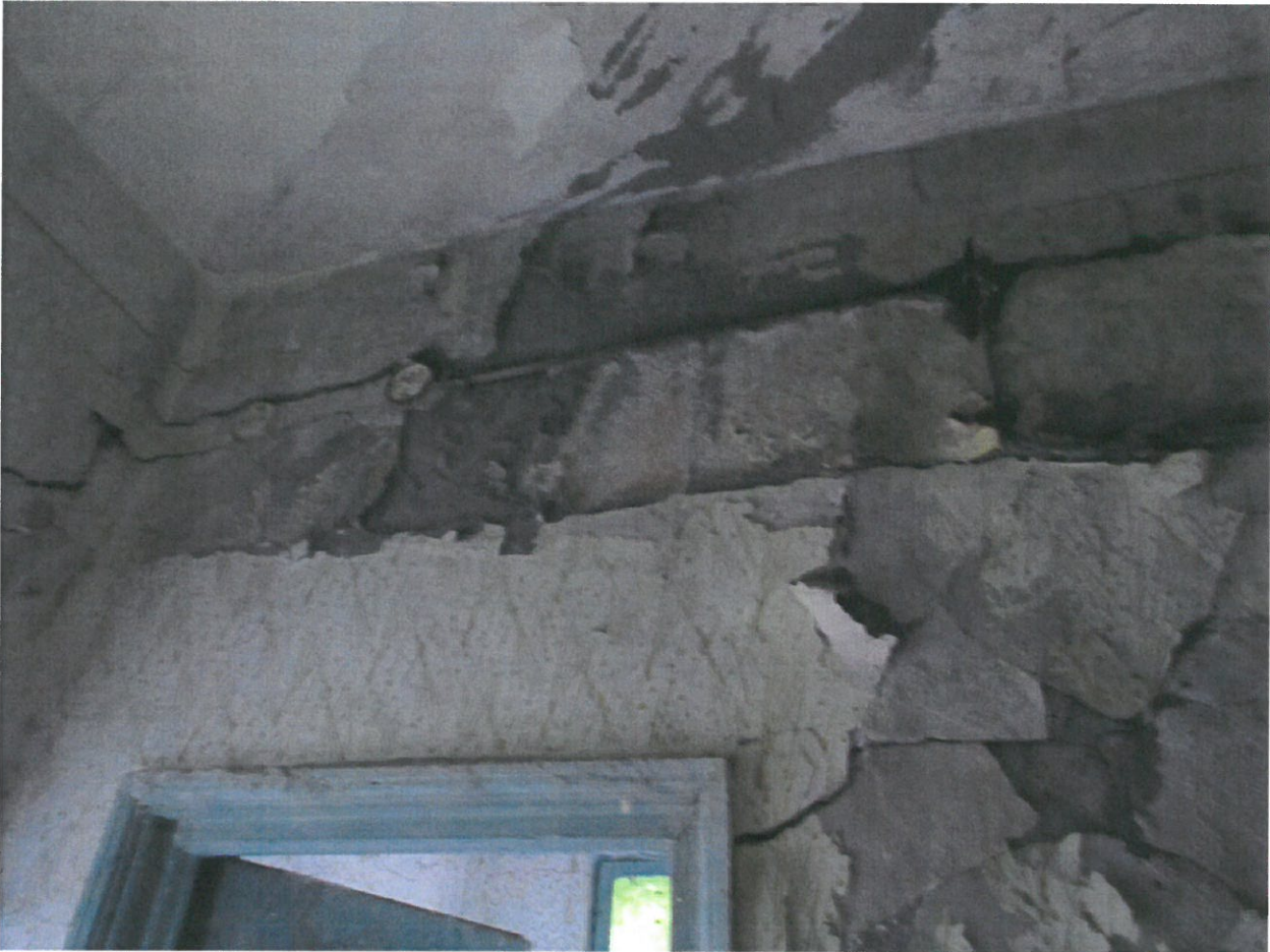
Tencuieli fisurate / degradate
