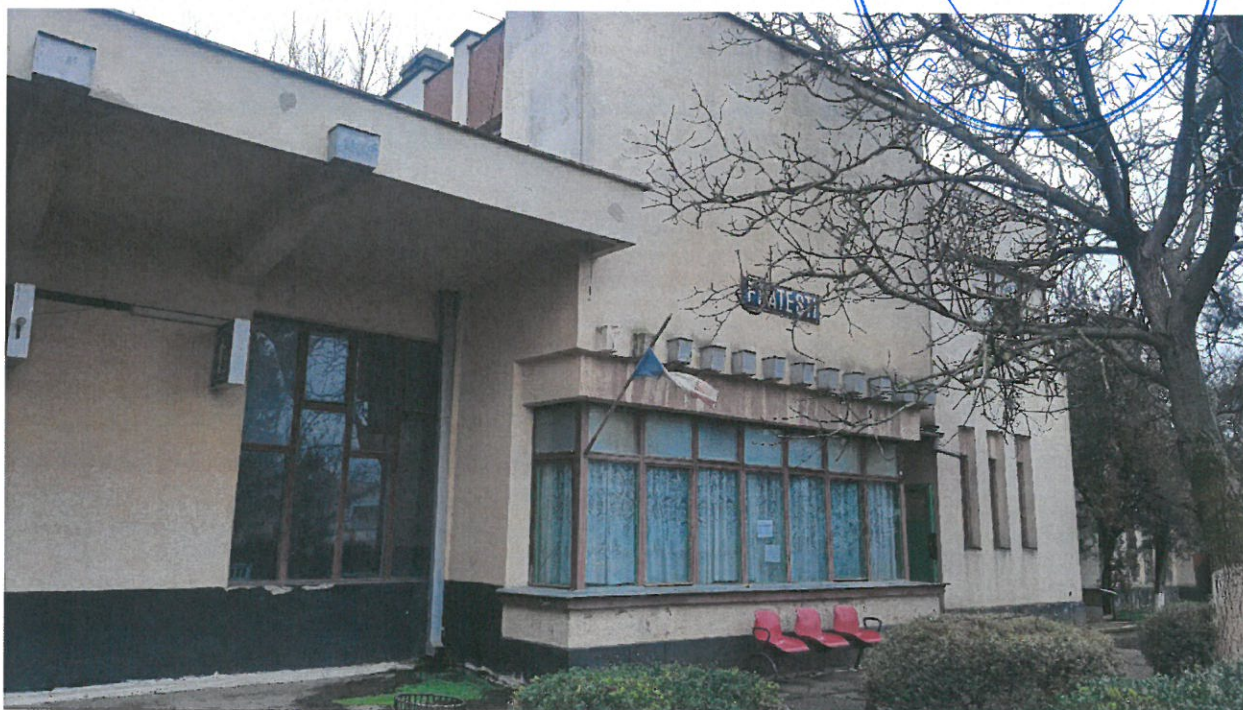
Exterioare. Tencuieli fisurate. Trotuare lipsă sau degradate
