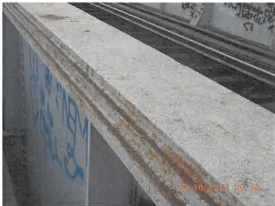
59. Suprafețe afectate de coroziune la talpa superioară a grinzii cu inimă plină, la nivelul ambelor platbande
