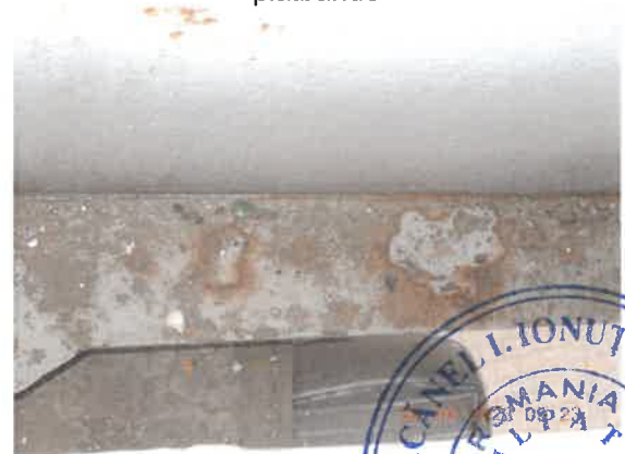
60. Zone cu vopsea exfoliată la talpa inferioară a grinzii, ceea ce a favorizat apariția coroziunii.
