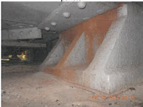
9. Vedere aparat de reazem fix. Plăcuțele de plumb sunt refulate. Aparatul de reazem prezintă rugină la partea superioară.
