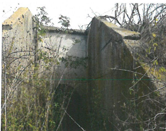
FOTO 8 Vedere aripi și timpan
