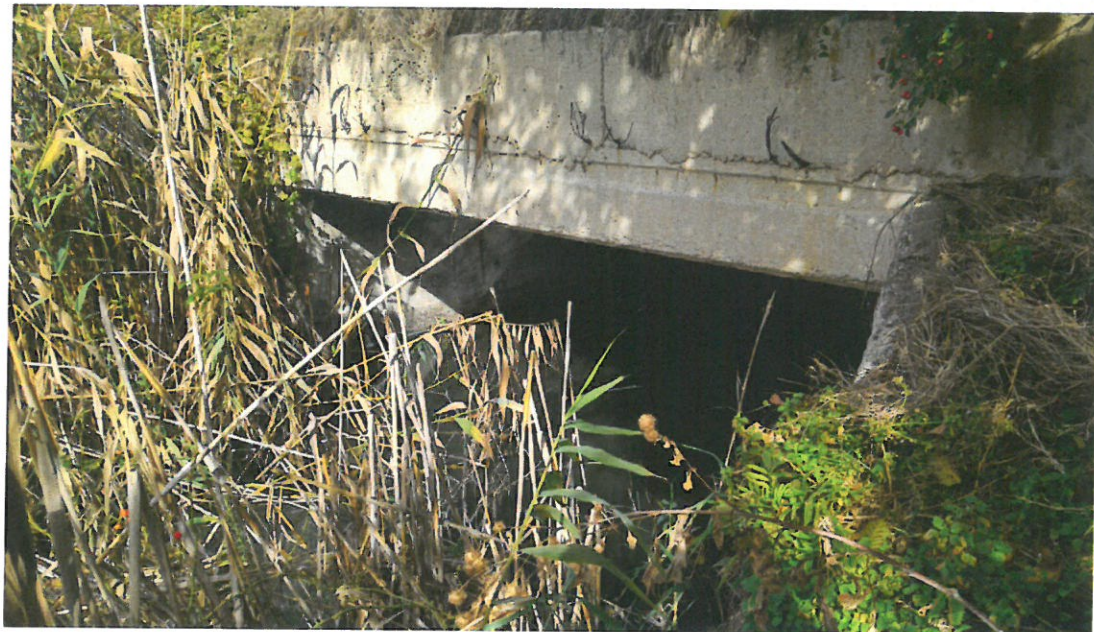
FOTO 2 – Vedere timpan amonte
