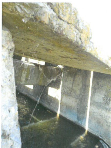
9. Vedere podeț din aval spre culeea București, grinda din primul pachet grinzi-antretoaze aval
