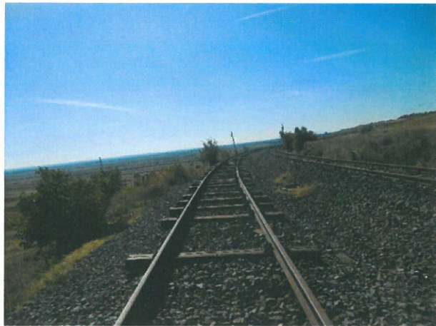
1. Șina și prinderea acesteia de traverse (vedere spre Giurgiu) - linia c.f. neutilizată, lipsă traverse
