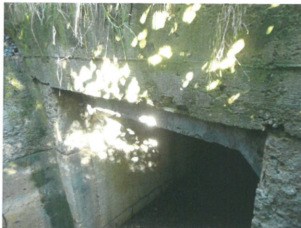
2. Vedere podet, din amonte
