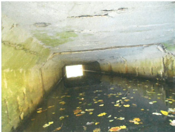
9. Vedere intrados podeț prefabricat tip C2
