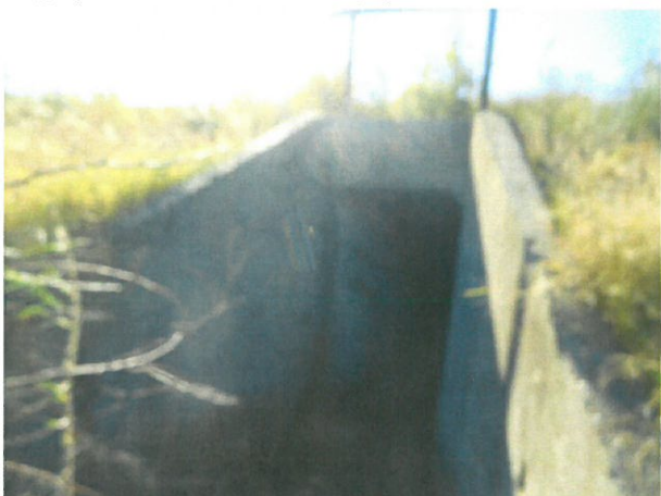
3. Vedere podet, din aval
