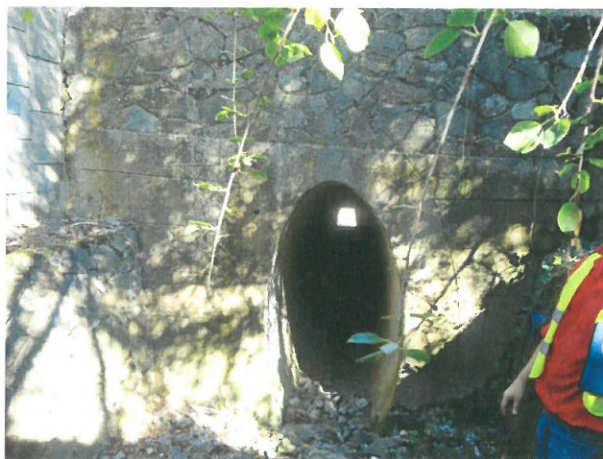
2. Vedere podet, din amonte
