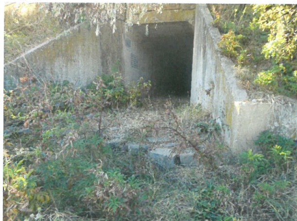
3. Vedere podet, din aval
