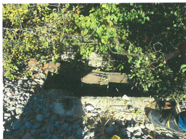
3. Vedere Cameră de cădere Amonte
