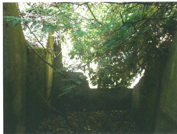
6. Vedere Cameră de Cădere
