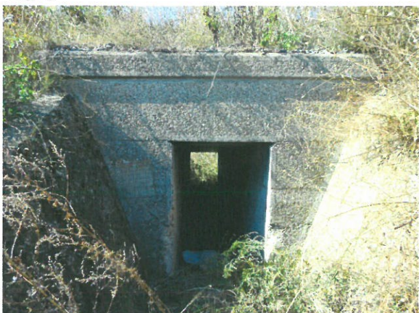
3. Vedere podet, din aval
