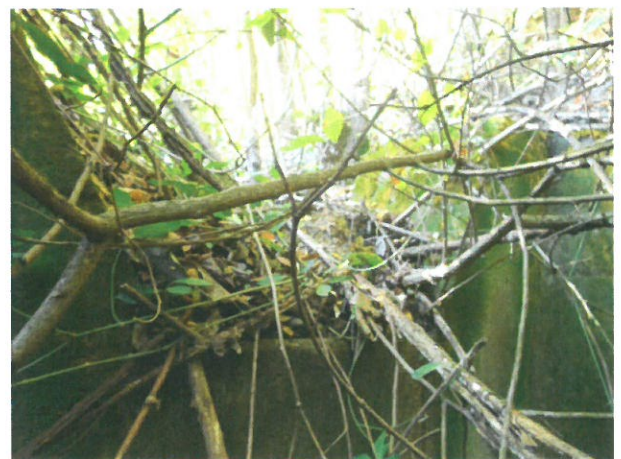
6. Vedere Cameră de Cădere
