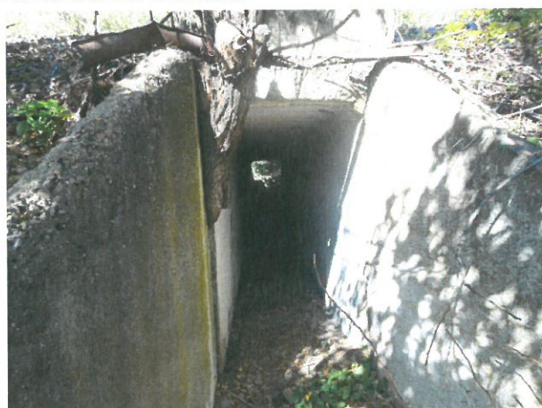
11. Elevație podet prefabricat tip C1 în aval
