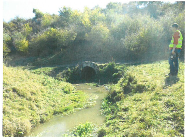
2. Vedere podet, din amonte
