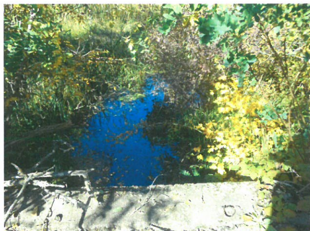
3. Vedere Timpan Amonte
