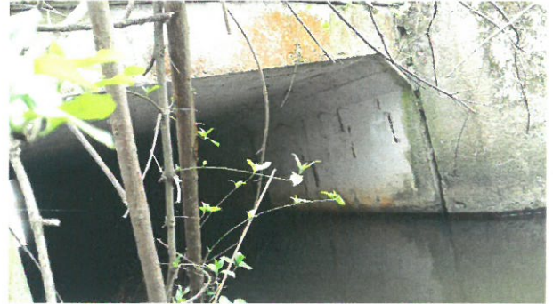
8. Vedere intrados podeț prefabricat tip C2. Armături fără strat de acoperire și corodate
