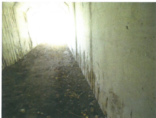
8. Fisuri, beton degradat și armături la vedere la partea inferioară a elementelor prefabricate
