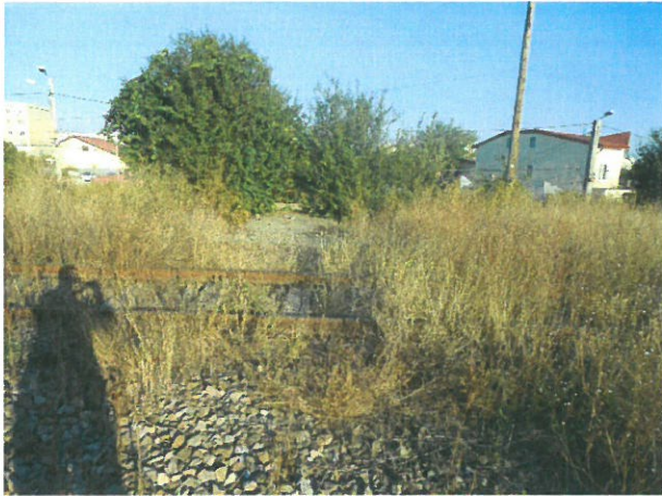
7. Vedere podeț, spre aval
