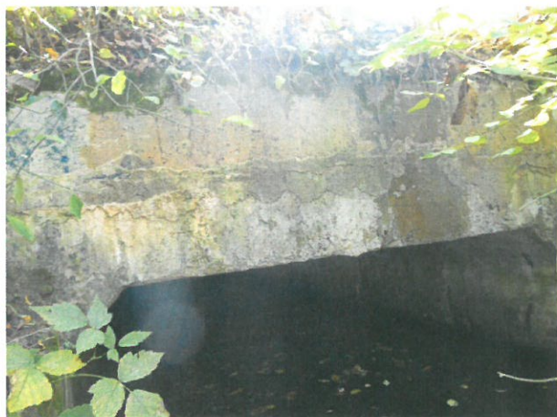
5. Elevație podeț prefabricat tip C2
