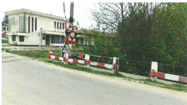
9. Vedere trotuar amonte, barieră, parapete, gară Comana
