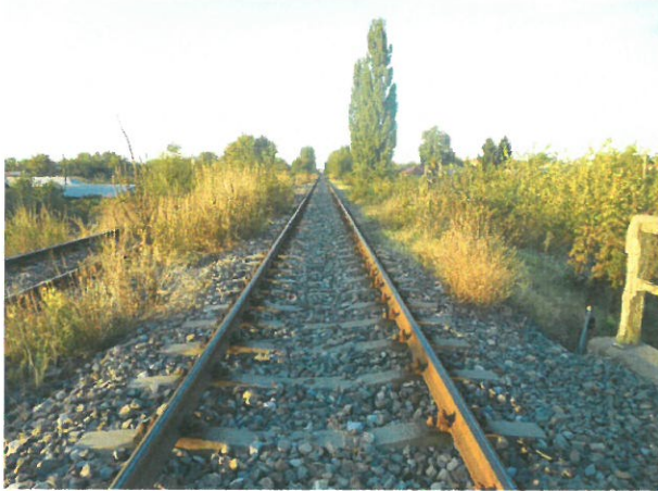
1. Șina și prinderea acesteia de traverse (vedere spre București)
