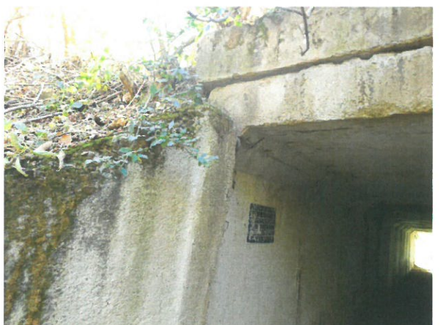
6. Vedere Aripă prefabricată, amonte, București deplasată
