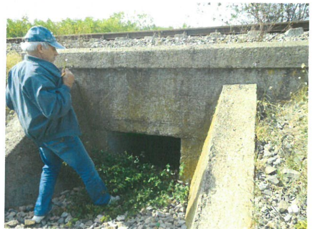
4. Vedere podet, din aval
