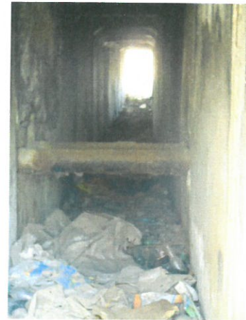
8. Conducte in interiorul podețului
