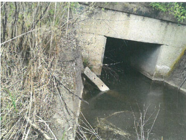
11. Vedere Aripa monolită, aval, Giurgiu
