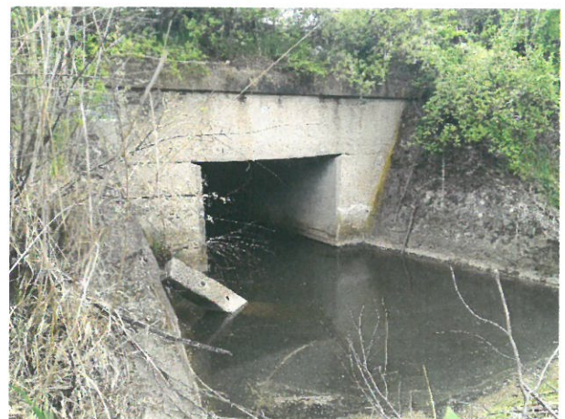
6. Elevație podet dalat. Apa stagnează în podet
