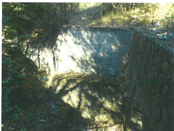
4. Vedere racordare cu terasamentul amonte – spre direcția București și albia
