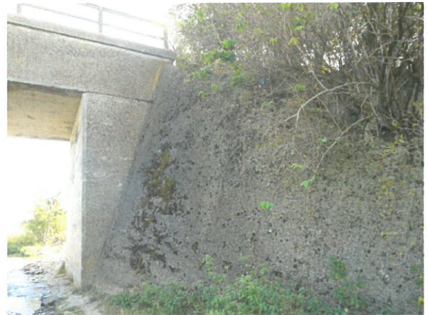
4. Vedere aripă și culee spre direcția Giurgiu - amonte
