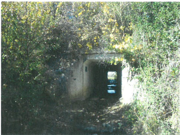
11. Elevație podet prefabricat tip C2 în aval
