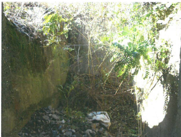
4. Vedere cameră de cădere amonte
