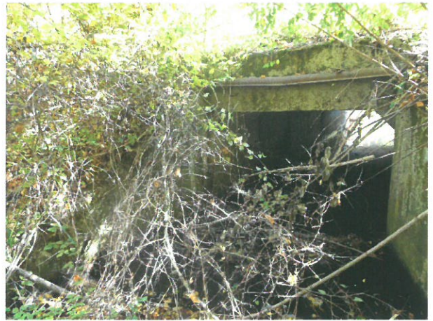
8. Vedere Aripa prefabricată, aval, București
