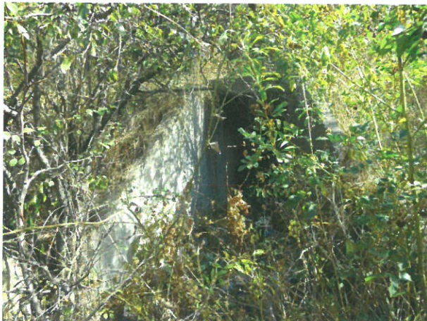
3. Vedere podet, din aval
