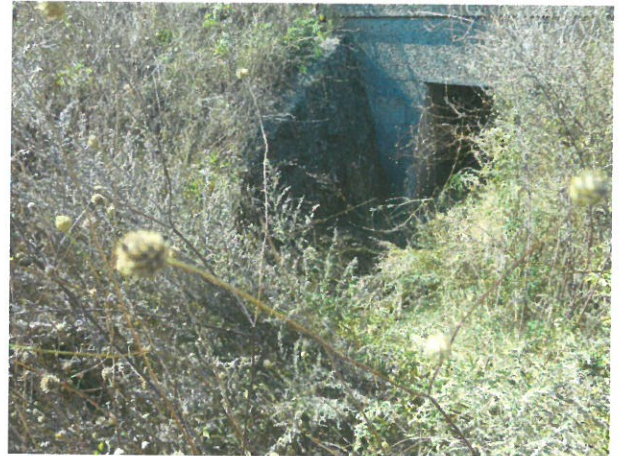
10. Vedere dinspre aval (aripa Giurgiu, albie cu vegetație, etc.)
