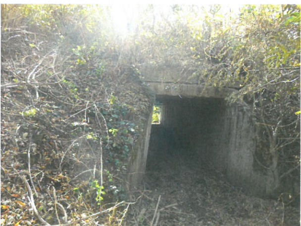
5. Elevație podet prefabricat tip C2 în amonte
