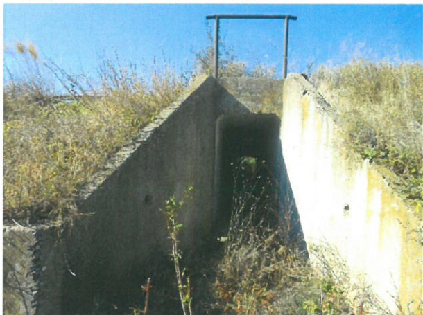
3. Vedere podet, din aval
