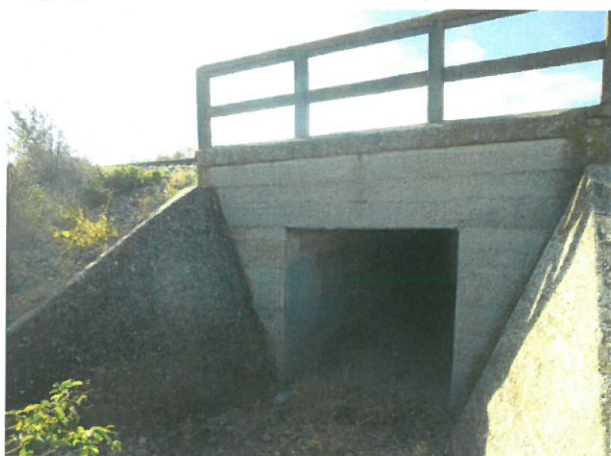
3. Vedere podet, din aval
