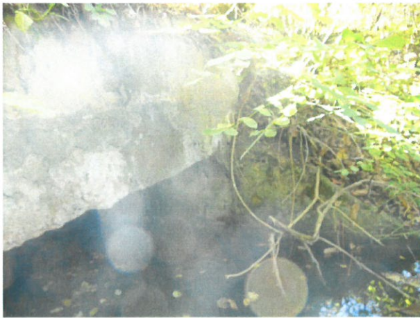
7. Vedere Aripa prefabricată, aval, Giurgiu
