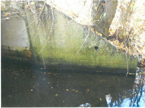
7. Vedere Aripa prefabricată, amonte, Giurgiu
