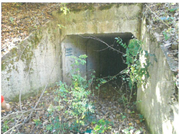
11. Elevație podet prefabricat tip C2 în aval
