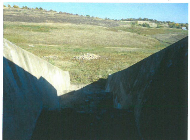
10. Vedere aripi aval și treptele pereului situate în exteriorul podețului
