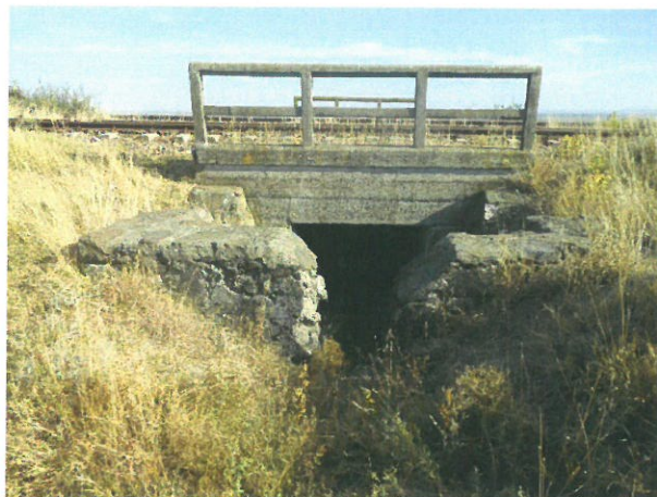
2. Vedere podet, din amonte
