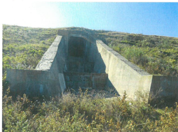
3. Vedere podet, din aval
