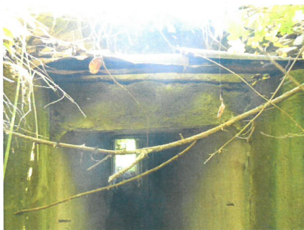
5. Elevație podeț prefabricat tip C1 în amonte
