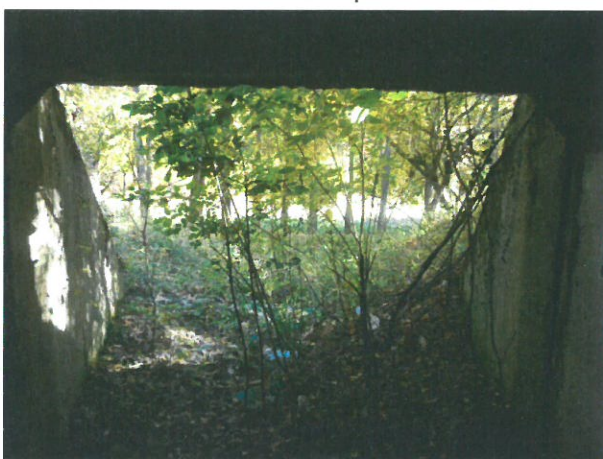
12. Vedere Aripa prefabricate Aval
