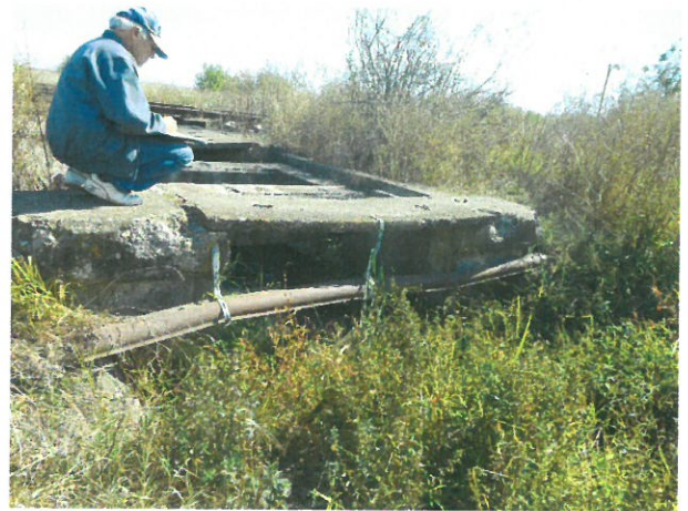
2. Vedere podet, din amonte
