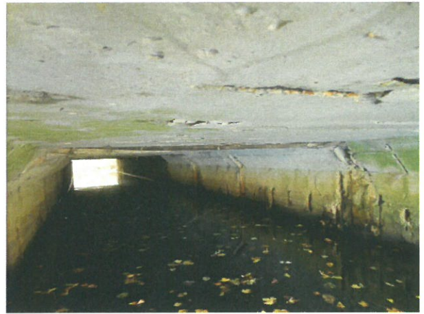
8. Vedere intrados podeț prefabricat tip C2
