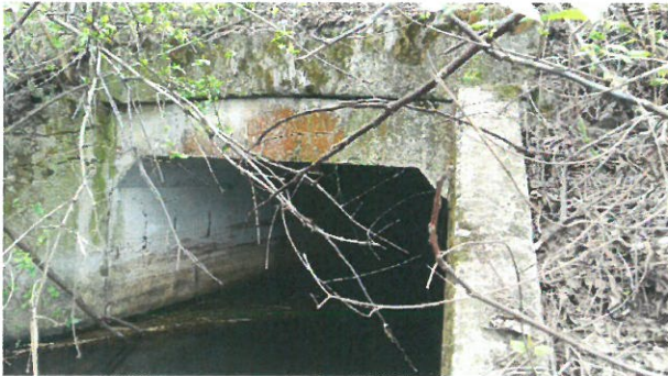
9. Vedere intrados podeț prefabricat tip C2
