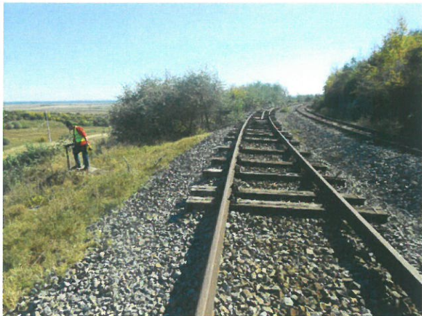
1. Șina și prinderea acesteia de traverse (vedere spre Giurgiu) - linia c.f. neutilizată, lipsă traverse
