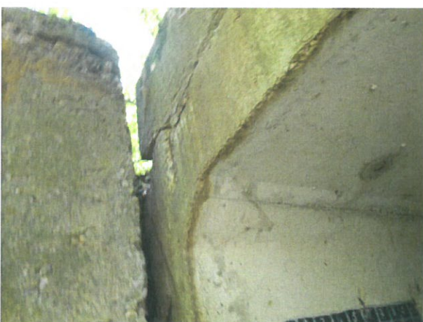
6. Aripă prefabricată, în amonte, București deplasată
