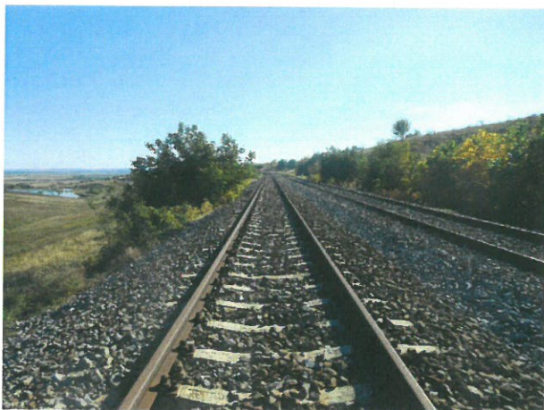
1. Șina și prinderea acestora de traverse (vedere spre Giurgiu)
