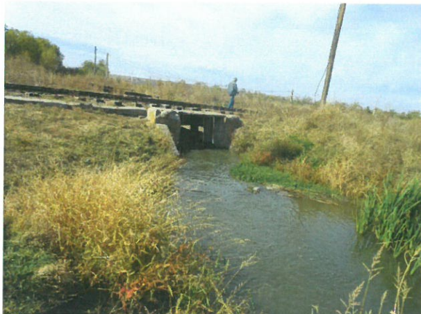
3. Vedere podet, din aval
