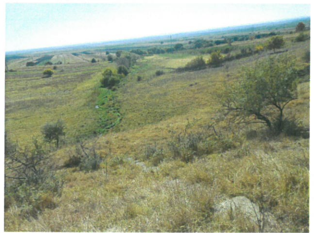
8. Vedere cu scările de pe taluzul din aval
