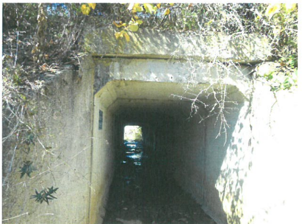
12. Elevație podet prefabricat tip C2 în aval
