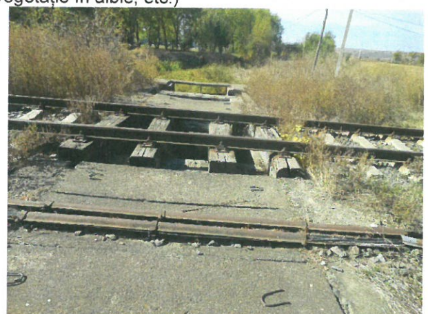
6. Vedere al treilea pachet de placi de beton dinspre amonte, traseu cabluri
