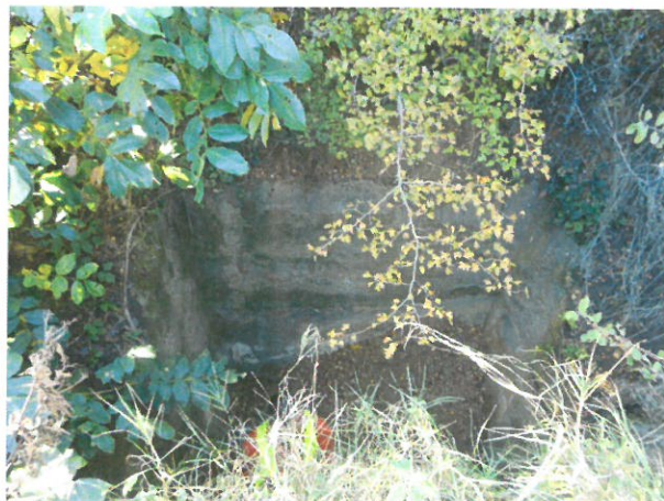
4. Vedere podet în amonte (camera de cădere)
