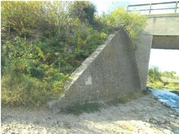
9. Vedere aripă și culee spre direcția Giurgiu - aval
