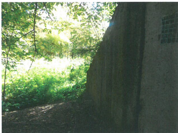
11. Vedere Aripă prefabricată, aval, Giurgiu
