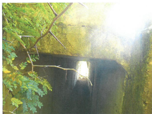
5. Elevație podeț prefabricat tip C1 în amonte
