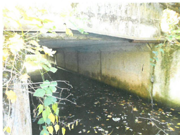
5. Elevație podeț prefabricat tip C2
