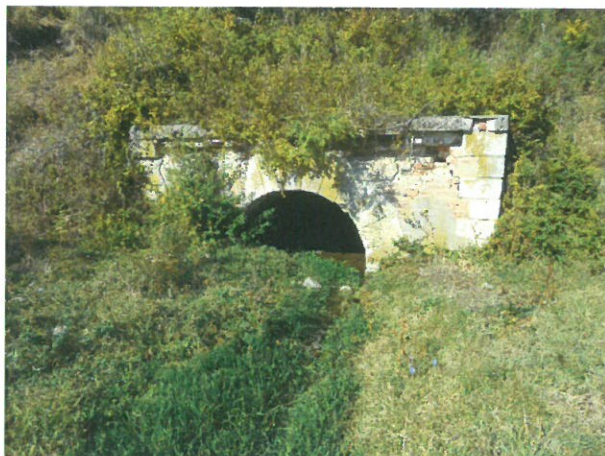
3. Vedere podet, din aval
