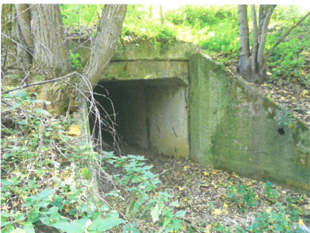
5. Elevație podet prefabricat tip C2 în amonte
