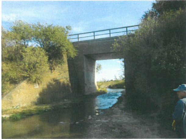
1. Vedere podet, din amonte
