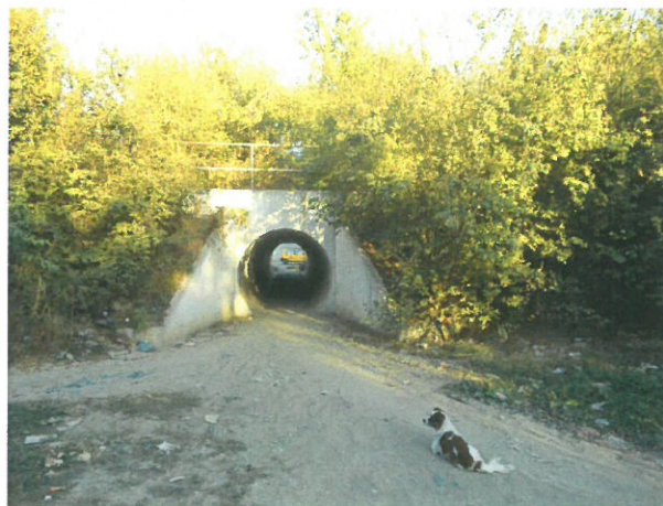
8. Vedere podet, din aval
