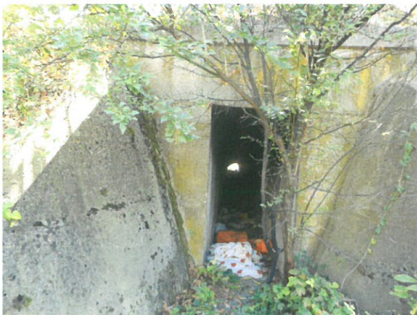
3. Vedere interior podet în aval
