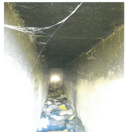
6. Vedere interior podet, dinspre aval
