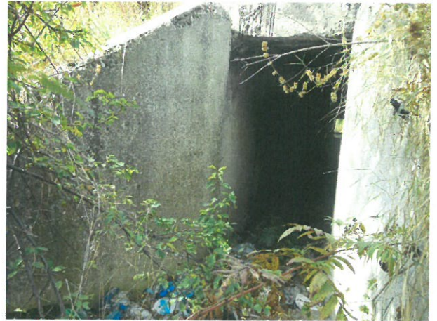
2. Vedere podet, din amonte
