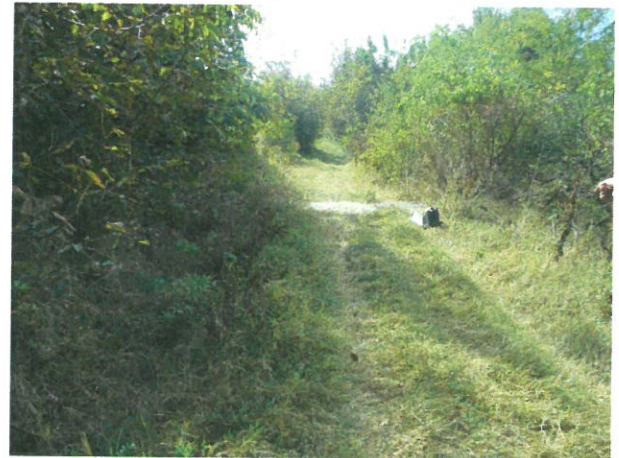
10. Drum local ce traversează tronsoane de podeț din aval
