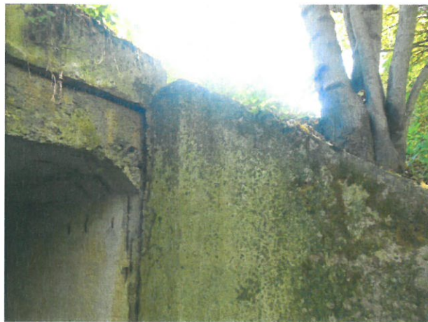
7. Vedere Aripa prefabricată, amonte, București
