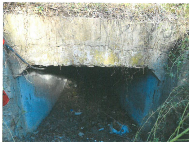
5. Elevație podet prefabricat tip C2 în amonte
