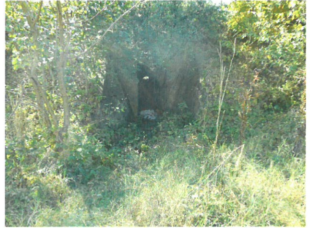
2. Vedere podet aval
