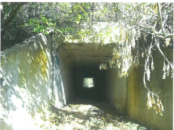
11. Elevație podeț prefabricat tip C1 în aval
