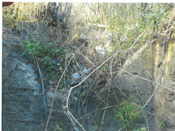
3. Vedere Cameră de cădere Amonte
