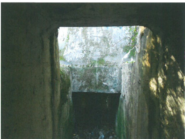
5. Vedere cameră de cădere amonte
