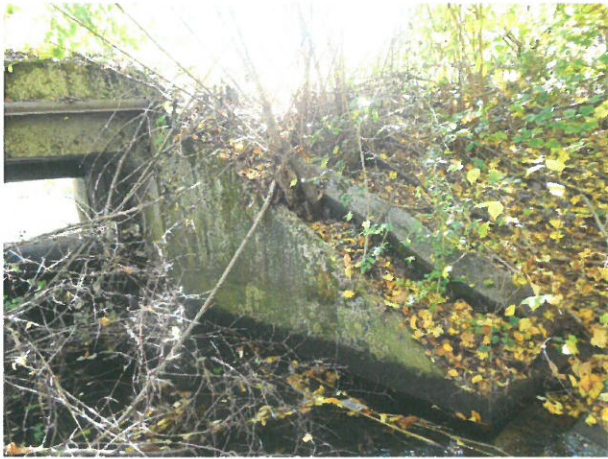
7. Vedere Aripa prefabricată, aval, Giurgiu
