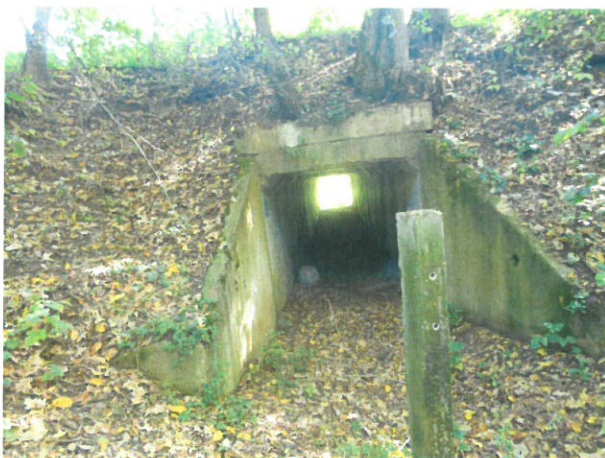
3. Elevație podeț prefabricat tip C2 în amonte
