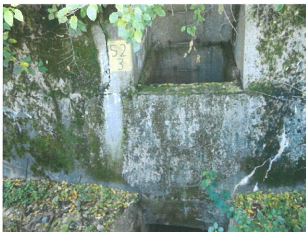
4. Vedere gură de vizitare amonte
