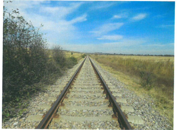
2. Șina și prinderea acesteia de traverse (vedere spre București)
