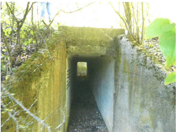
11. Elevație podeț prefabricat tip C1 în aval
