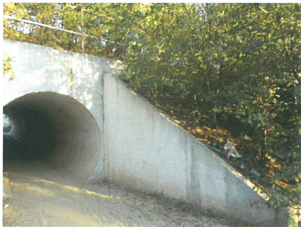
7. Vedere podet în aval (aripi prefabricate de tip A3)
