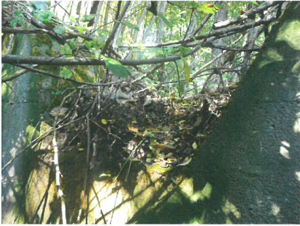
7. Vedere Cameră de Cădere
