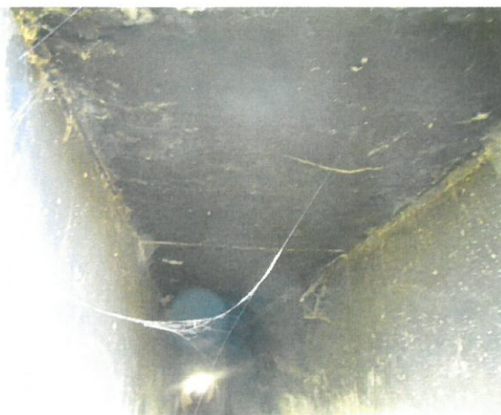
5. Vedere intrados, dinspre aval
