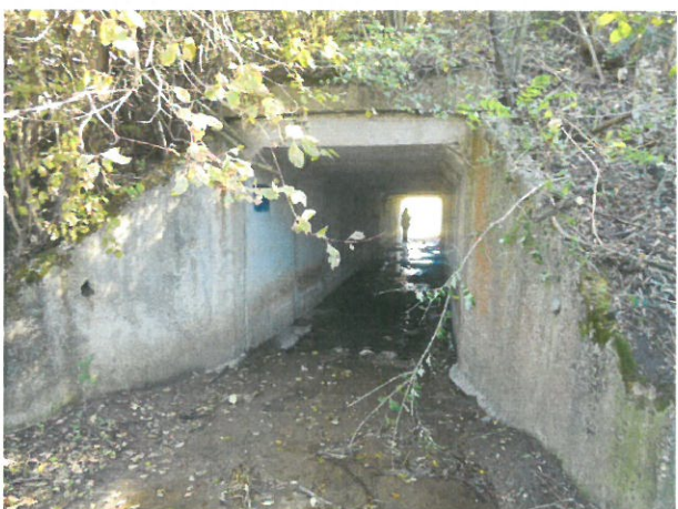
5. Elevație podet prefabricat tip C2 în amonte
