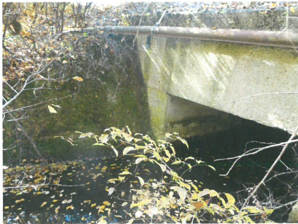
9. Vedere Aripa monolită, aval, Giurgiu
