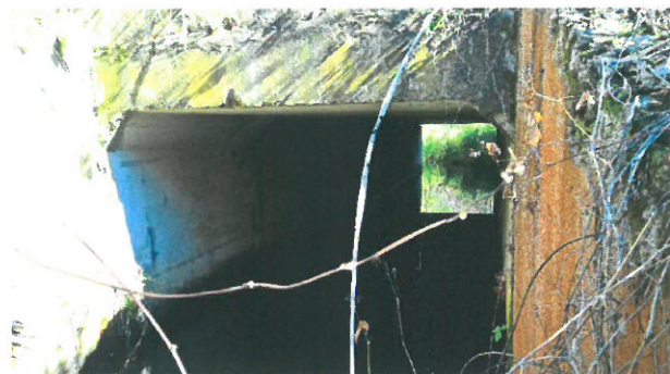
9. Vedere intrados podeț prefabricat tip C2
