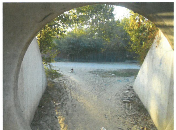
6. Vedere exterior podet, spre aval
