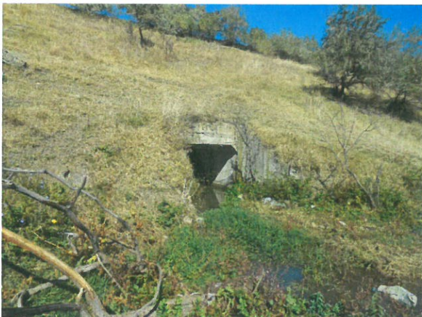
3. Vedere podet, din aval
