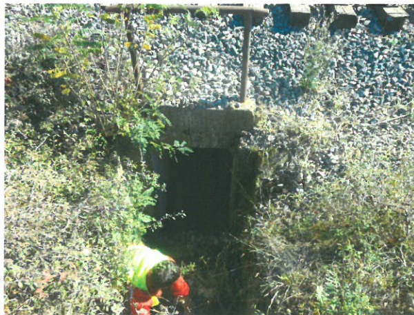
2. Vedere podet, din amonte
