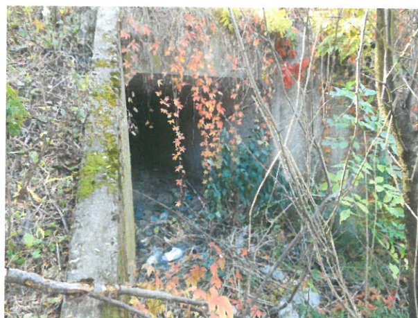
12. Elevație podeț prefabricat tip C2 în aval
