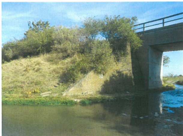
3. Vedere aripă, scări și culee spre direcția București - amonte
