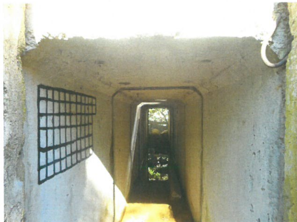
9. Vedere interior podeț
