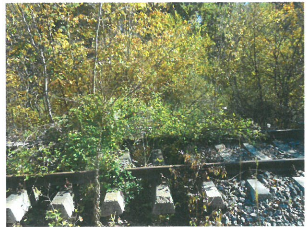
12. Lipsă prism de piatră spartă
