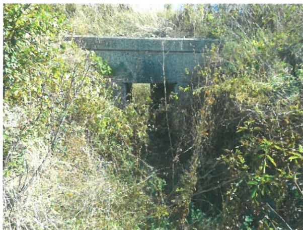
2. Vedere podet, din amonte
