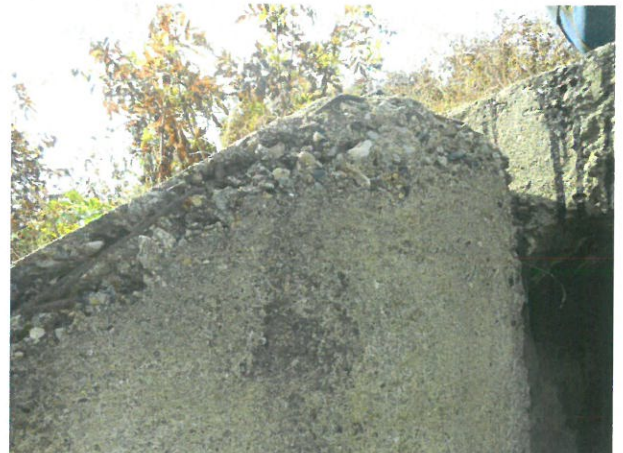
4. Vedere aripă amonte ușor deplasată spre interior
