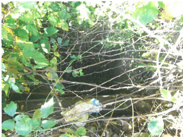
3. Vedere Cameră de cădere Amonte
