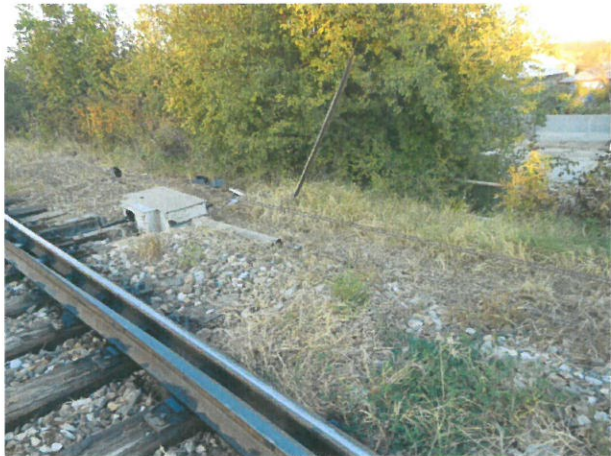
3. Vedere podet, spre amonte (schimbător de cale)
