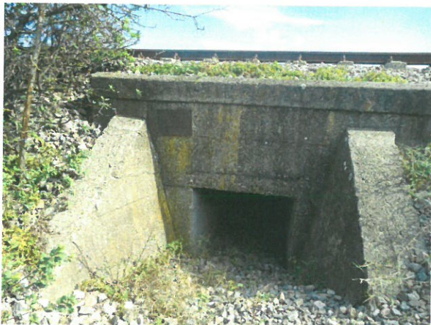
3. Vedere podet, din amonte
