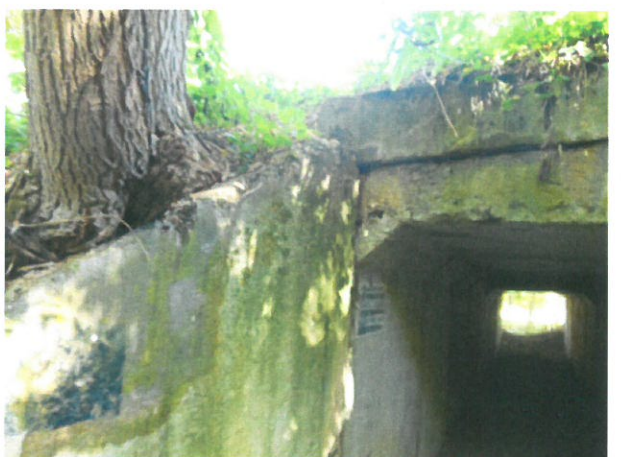
6. Vedere Aripa prefabricată, amonte, Giurgiu
