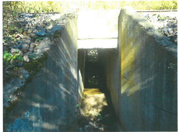
10. Elevație podeț prefabricat tip C1 în aval
