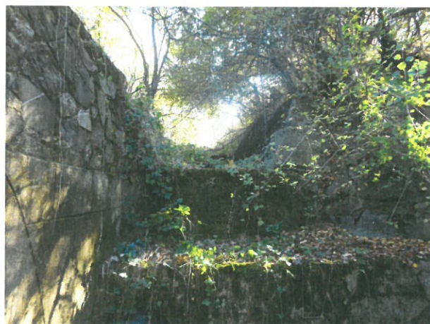
5. Vedere racordare cu terasamentul amonte – spre direcția Giurgiu și șanțul din lungul liniei
