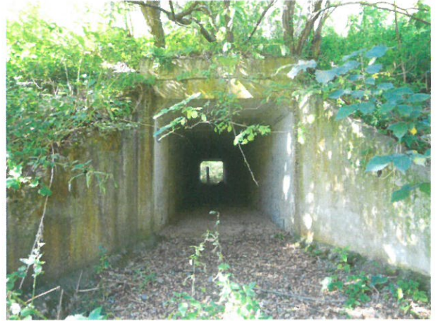
10. Elevație podeț prefabricat tip C2 în aval
