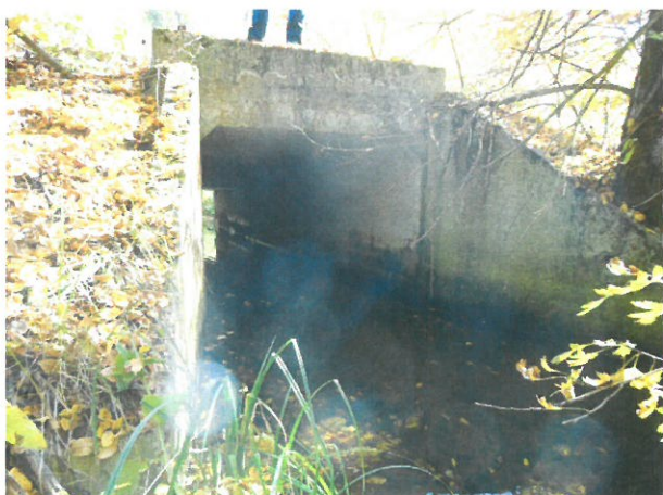
5. Elevație podeț prefabricat tip C2
