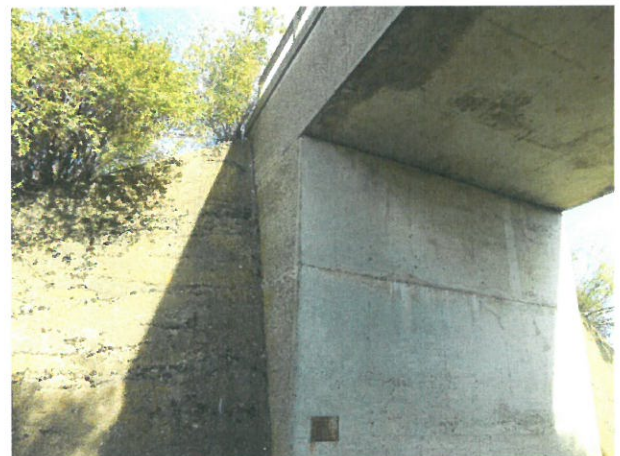
6. Vedere culee București și intrados dală (beton umed și ușor degradat, pete de rugină și de carbonatare, beton segregat, etc.)
