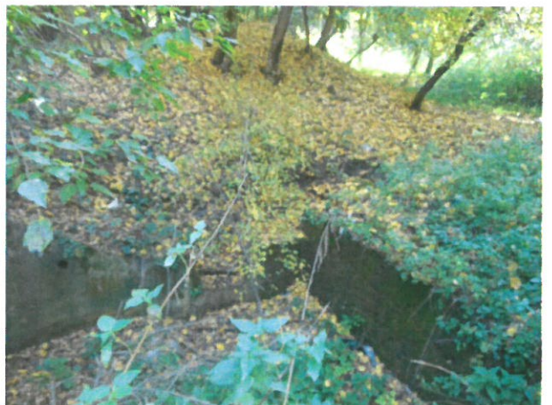
4. Vedere Camera de cădere Amonte
