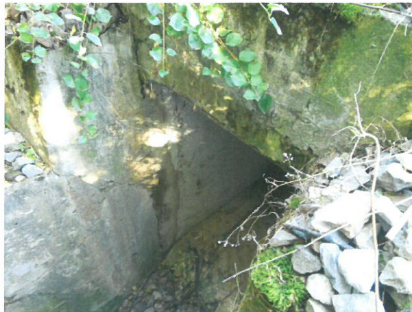
2. Vedere podet, din amonte
