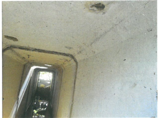
8. Vedere intrados podeț
