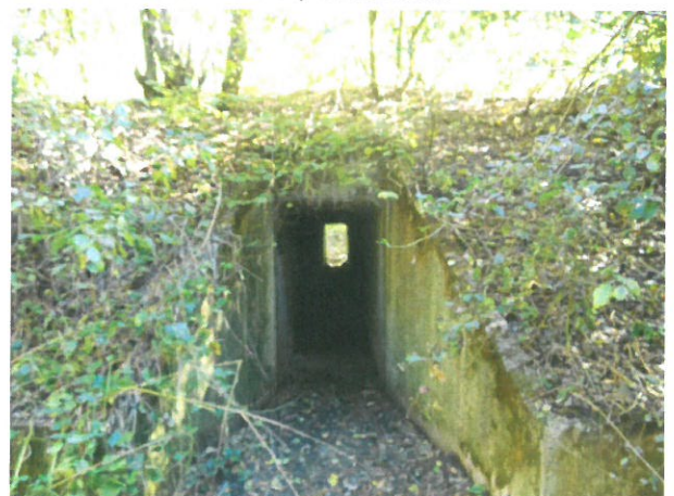
12. Elevație podeț prefabricat tip C1 în aval
