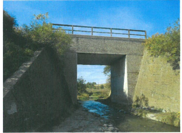
2. Vedere podet, din aval
