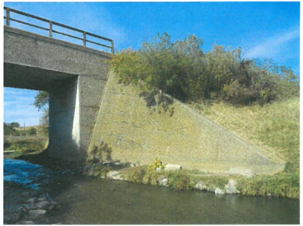
8. Vedere aripă și culee spre direcția București - aval
