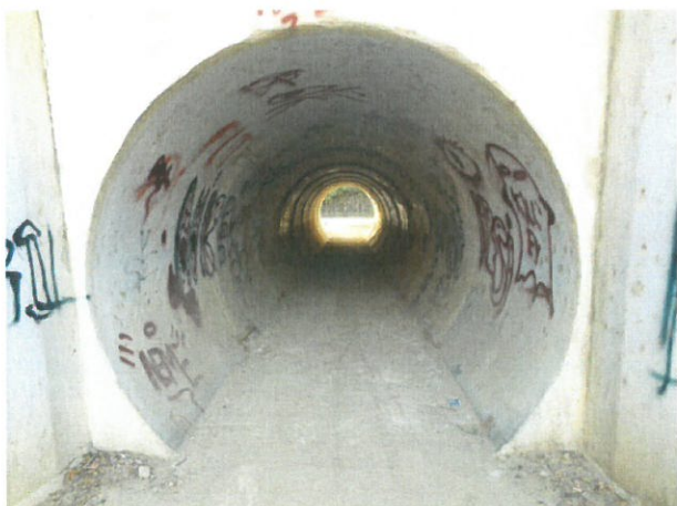
5. Vedere interior podet, dinspre amonte
