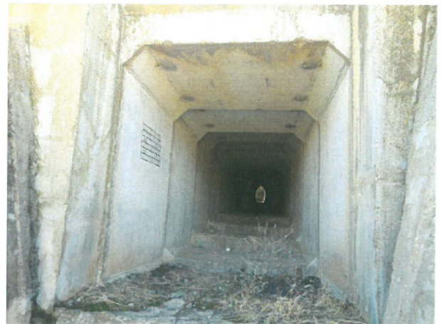
8. Vedere interior podeț dinspre aval (treptele pereului și cele de la partea superioară a prefabricatelor)
