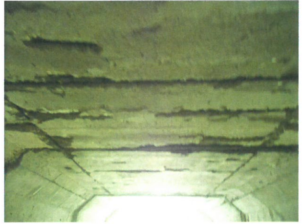
8. Vedere intrados cadre prefabricate cu beton degradat, fisuri și armături la vedere
