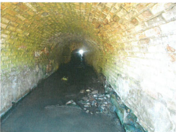
5. Vedere interior podet dinspre amonte (cărămizi degradate, zid de sprijin boltă erodat la bază, colmatare podet, etc)
