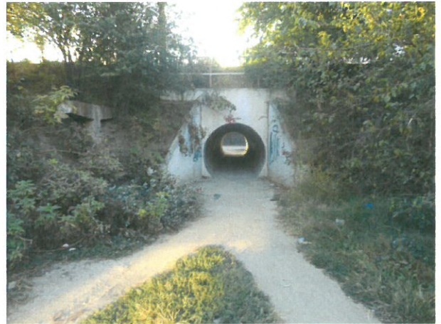
4. Vedere podet, din amonte
