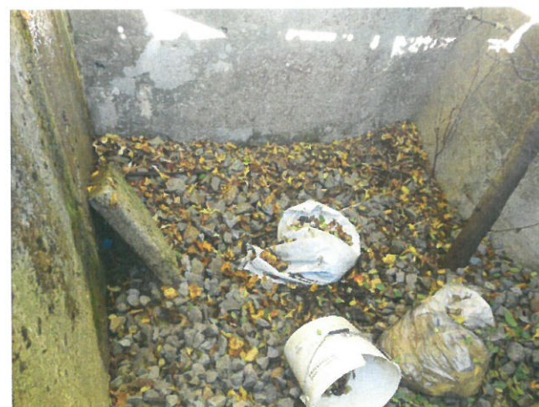
6. Vedere Cameră de Cădere
