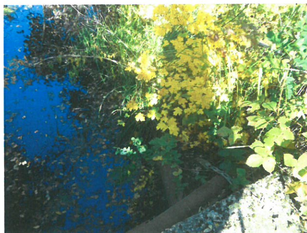
8. Vedere Aripa prefabricată, amonte, București
