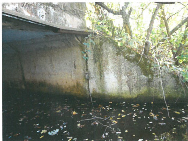
7. Vedere Aripa prefabricată, amonte, Giurgiu
