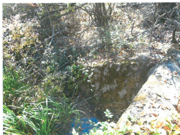
9. Vedere Aripa monolită, aval, Giurgiu
