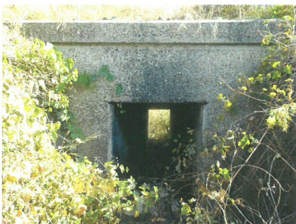
4. Vedere podet din amonte, culee dală și aripi (parapete lipsă, vegetație pe aripi și în albie, etc.)
