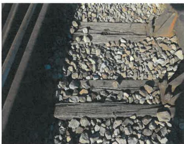
Traverse consecutive din lemn putrezite pe zona aparatelor de cale
