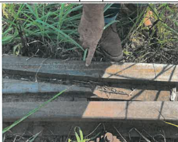
Uzuri la nivelul suprafeței de rulare
