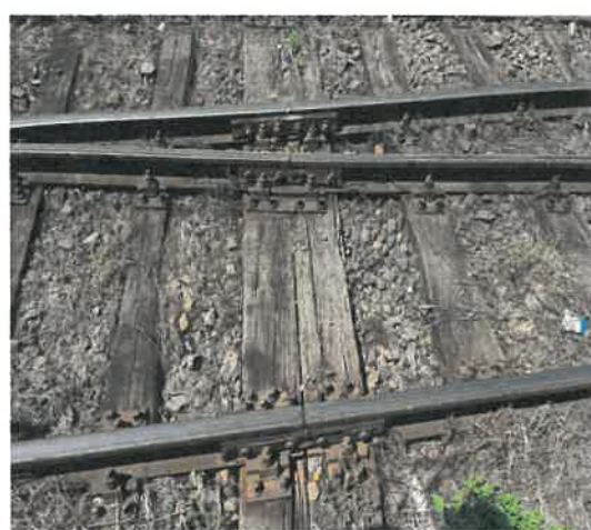
Traverse consecutive din lemn putrezite pe zona aparatelor de cale
