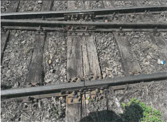
Uzuri la nivelul suprafeței de rulare pe zona aparatelor de cale
