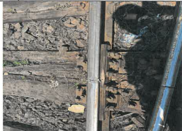
Uzuri la nivelul suprafeței de rulare pe zona aparatelor de cale
