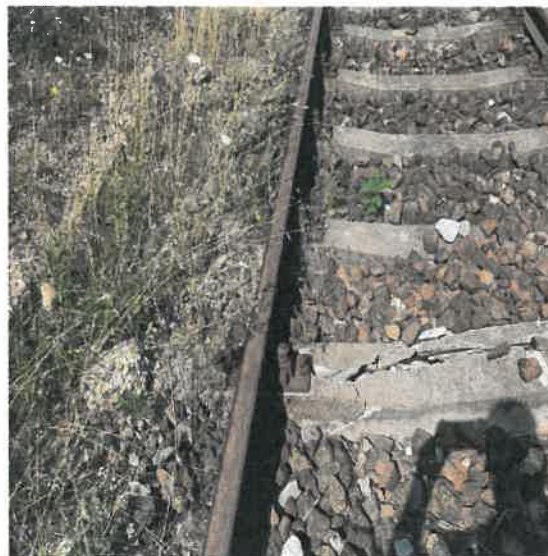
Traverse consecutive din lemn putrezite pe zona aparatelor de cale
