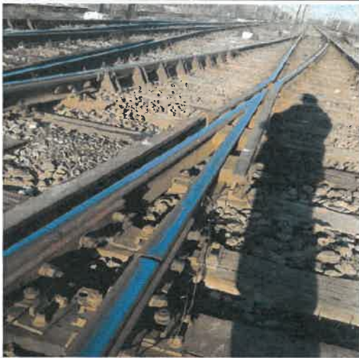
Uzuri la nivelul suprafeței de rulare pe zona aparatelor de cale
