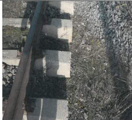
Platforma căii nu are lățime suficientă. Piatra spartă este cursă pe taluz.
