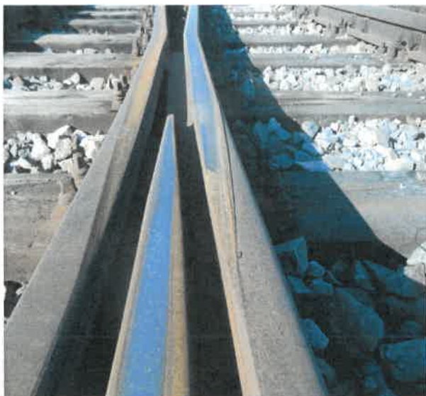
Uzuri la nivelul suprafeței de rulare
