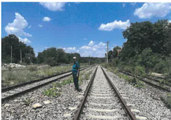
Platforma căii nu are lățime suficientă. Piatra spartă este cursă pe taluz.
