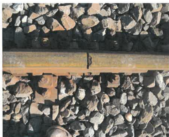
Desprinderi de material la nivelul suprafeței de rulare
