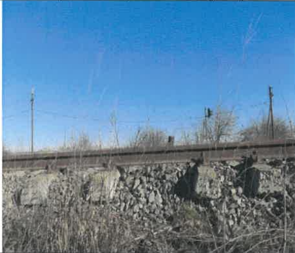
Platforma căii nu are lățime suficientă. Piatra spartă este cursă pe taluz.
