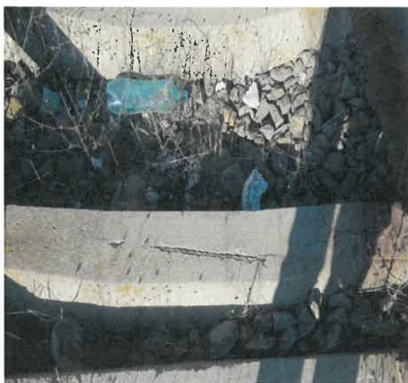
Traverse consecutive din lemn putrezite pe zona aparatelor de cale
