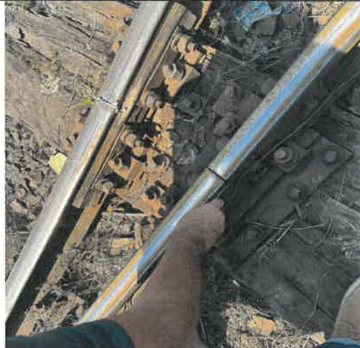
Uzuri la nivelul suprafeței de rulare pe zona aparatelor de cale
