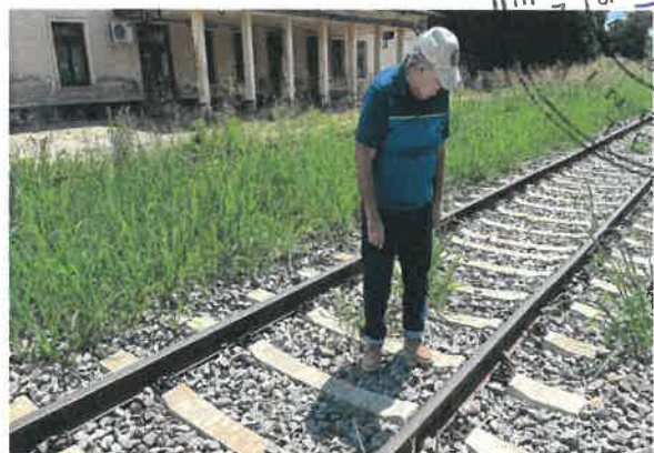
Platforma căii nu are lățime suficientă. Piatra spartă este cursă pe taluz.
