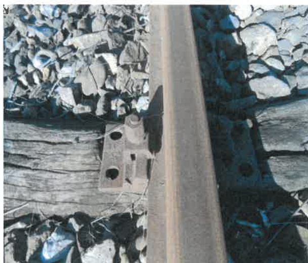
Lipsă elemente de prindere
