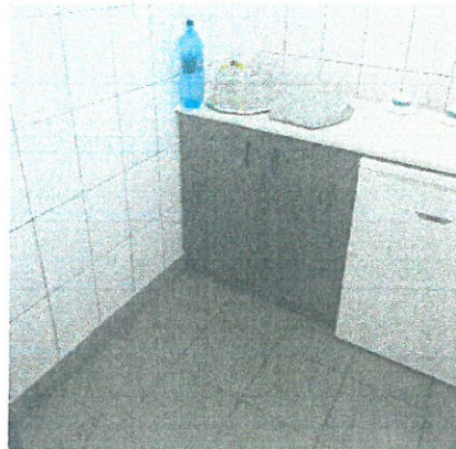
Pardoseală grup sanitar
