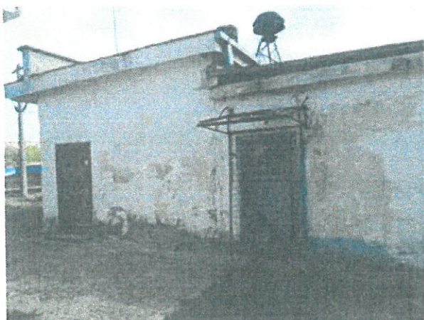
Exfolieri, desprinderi ale tencuiei exterioare
