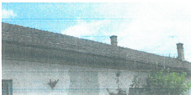
Acoperișul de tip șarpantă din lemn cu țiglă din ceramică
