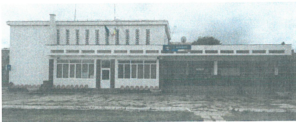
CLĂDIRE CĂLĂTORI + CED AGHIREȘU
