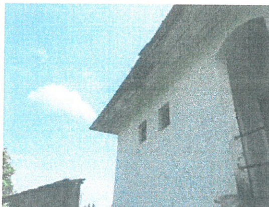
Pereți portanți din zidarie de cărămidă
