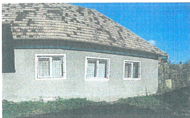
Pereți portanți din zidarie de cărămidă
