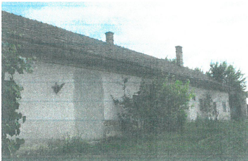
Pereți portanți din zidarie de cărămidă
