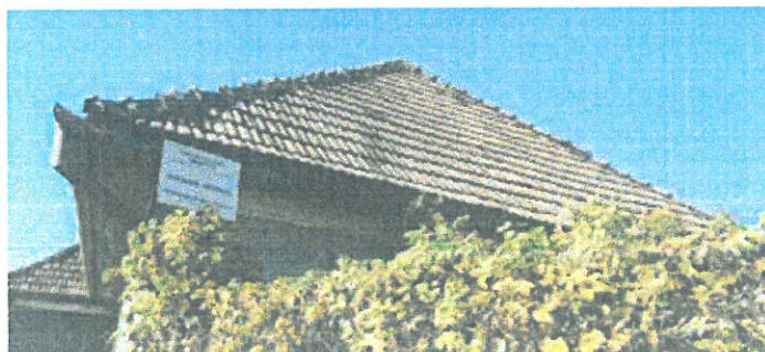
Acoperișul de tip șarpantă din lemn cu țiglă din ceramică
