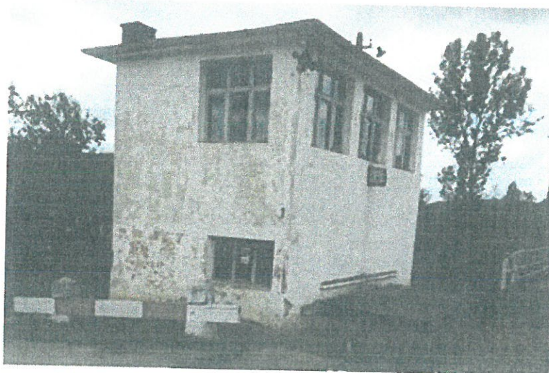
Cabina CEM km 522+515, comuna Gârbău, DC140, județul Cluj
