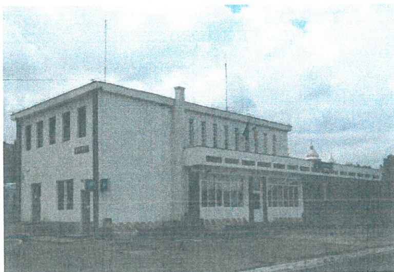
Pereți portanți din zidarie de cărămidă
