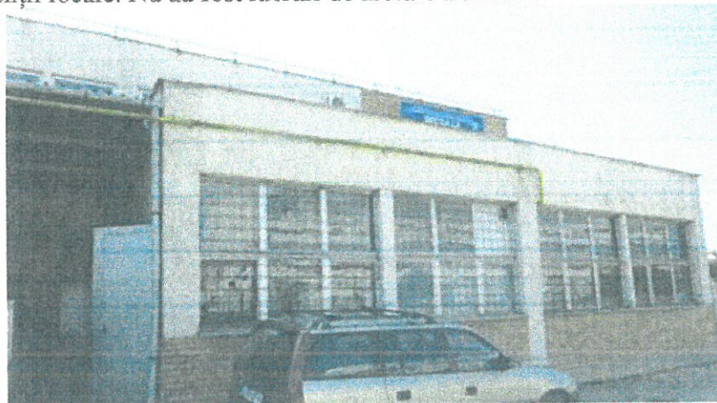
Pereți portanți din zidarie de cărămidă
