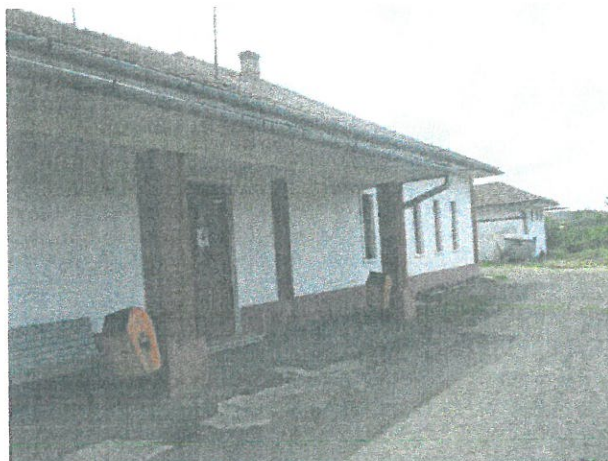
Pereți portanți din zidarie de cărămidă
