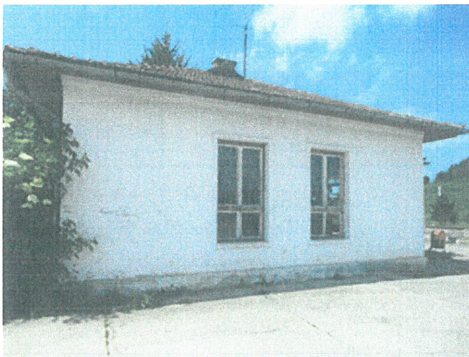
Pereți portanți din zidarie de cărămidă
