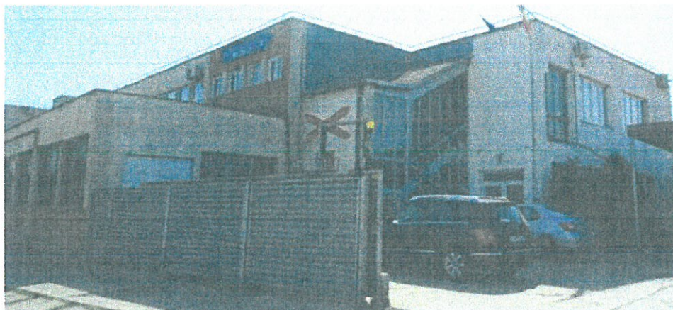
Stația Oradea Est. Clădire ADMINISTRATIVĂ L3.
