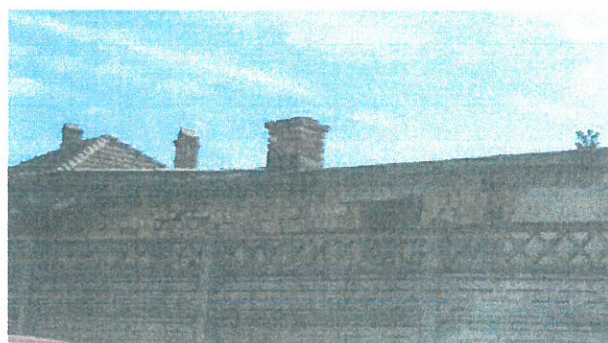
Desprinderi ale tencuielii exterioare
