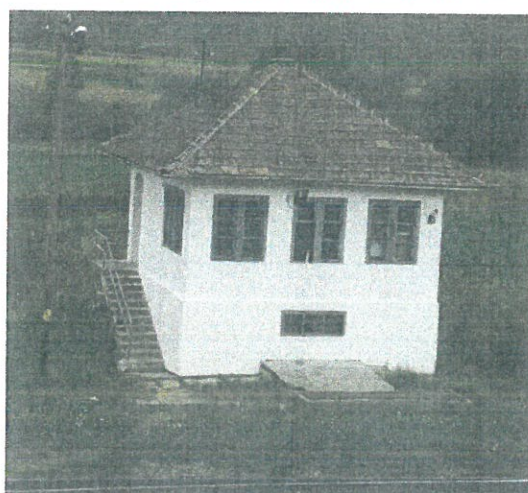
Acoperișul de tip șarpantă din lemn cu țiglă ceramică
