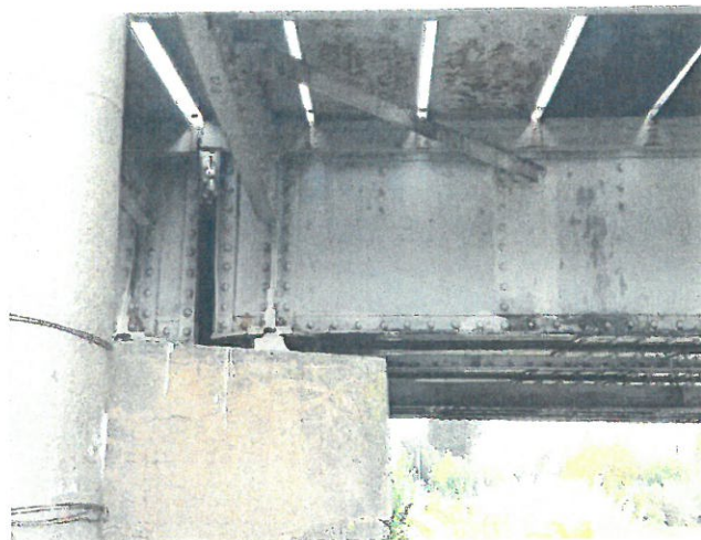
22. Aparat de reazem fix și grindă principală pe Pila 4
