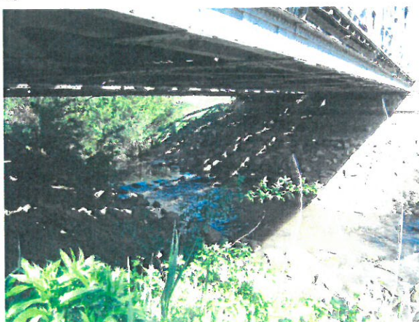
17. Vedere albie sub pod
