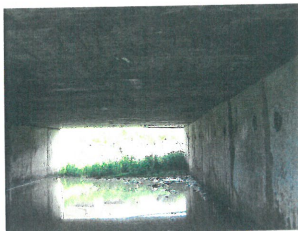
14. Suprastructura din dale D5 cu armatură la vedere corodată
