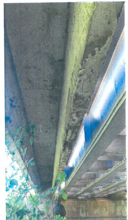
6. Vedere intrados tablier metalic G.G.I.P.C.S. – sudat, pe Firul I
