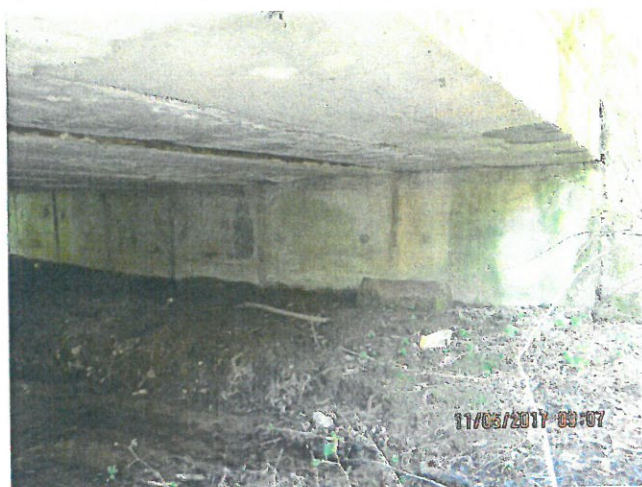
9. Vedere parte inferioară tablier spre culeea Cluj
