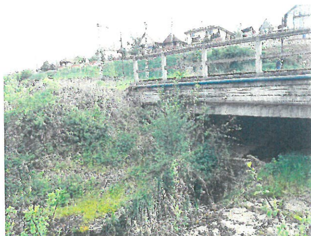
5. Elevație pod, în Aval
