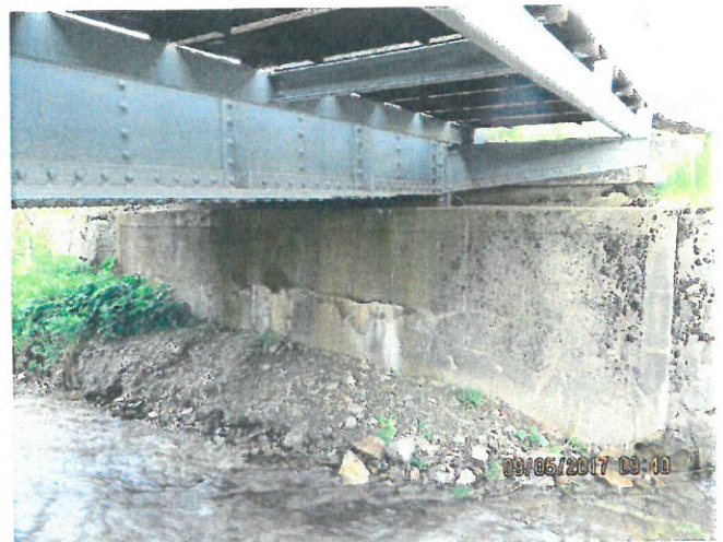
10. Elevații cu infiltrații la culeea Oradea
