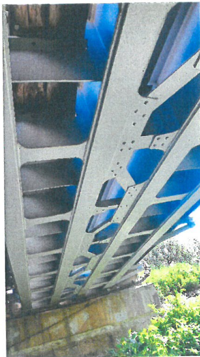
5. Vedere intrados tablier metalic G.G.I.P.C.S. – sudat, pe Firul II
