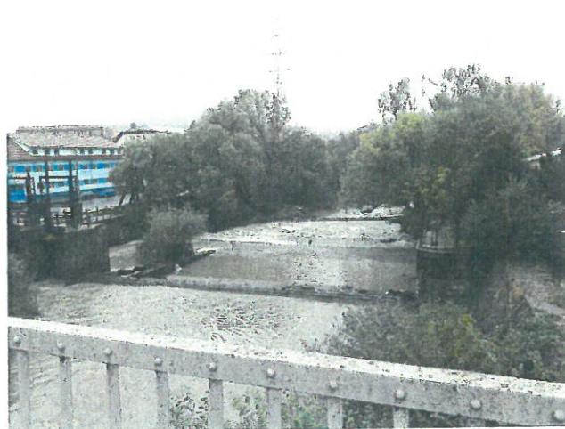
26.Vedere albie Aval
