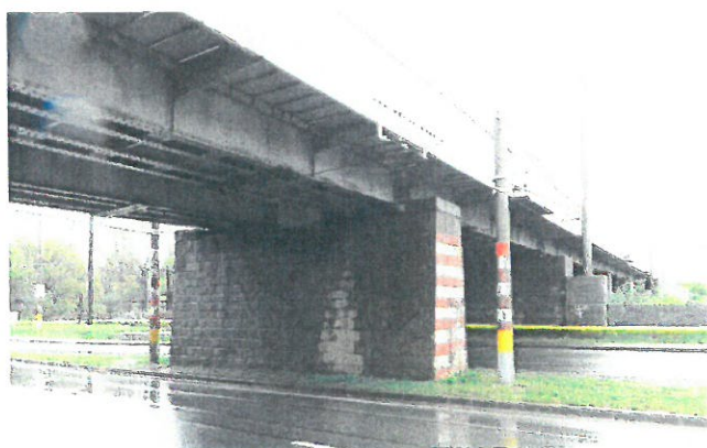
11.Vedere Elevație Pila 5
