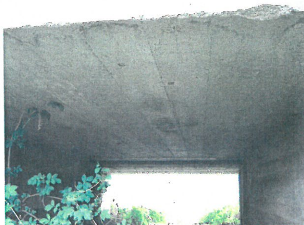
4. Vedere intrados dală de beton de pe Firul II
