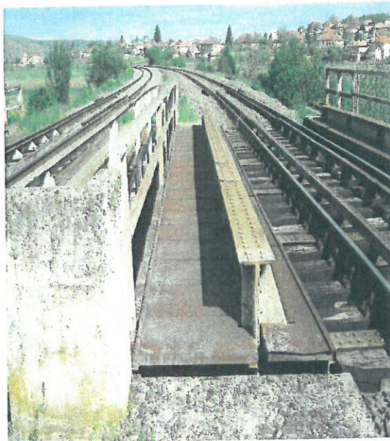
18. Talpă superioară grindă, pod linia II
