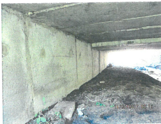
17. Dale cu denivelări între linia I și II
