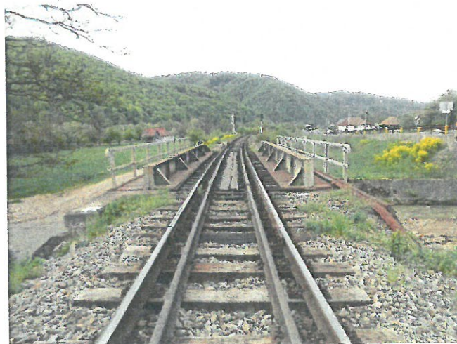
6. Contrașina pe pod și în afara podului
