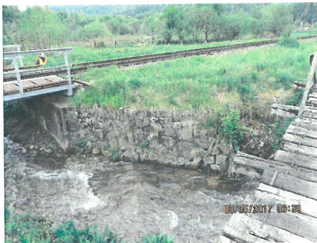
9. Apărarea amonte la culeea Oradea
