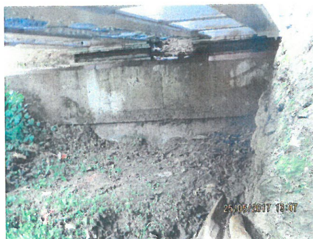
18.Vedere bancheta cuzineților culeea Oradea, pe Firul II
