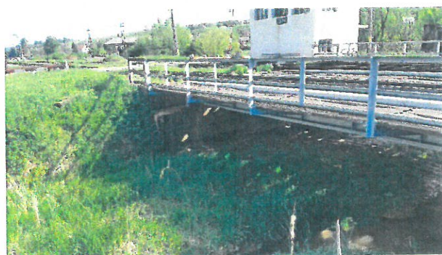
11.Vedere albie sub pod
