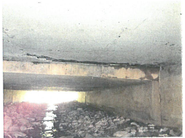
10.Vedere intrados dală beton
