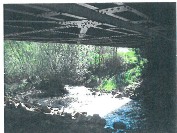
18. Vedere albie Aval
