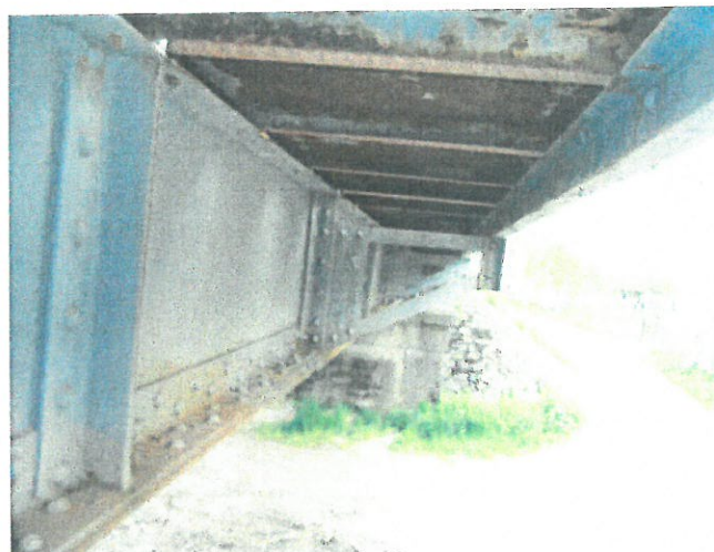
14. Elevație grindă principală afectată de rugină
