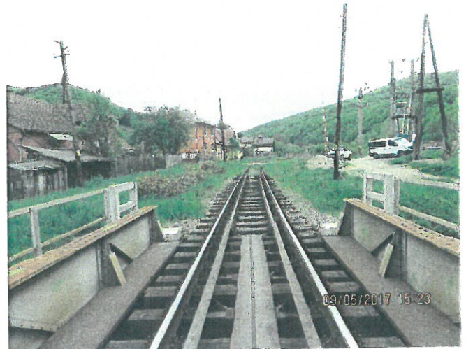
8. Vedere contrașine spre Cluj
