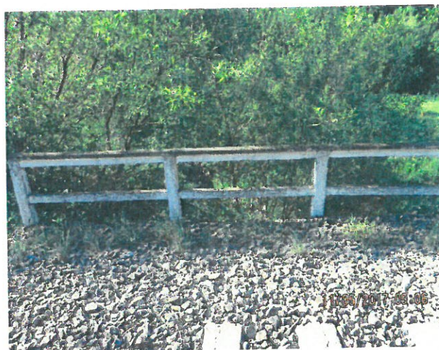
4. Vedere spre linia a-II-a, calea pe traverse de beton
