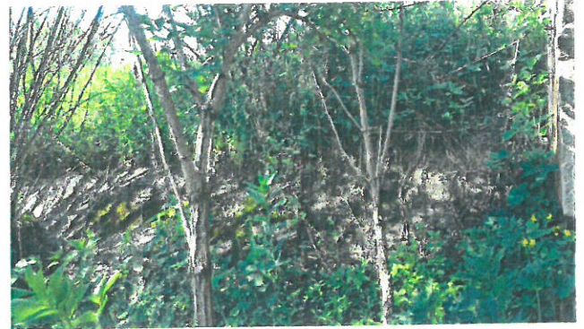
14. Zid de sprijin Amonte, mal stâng
