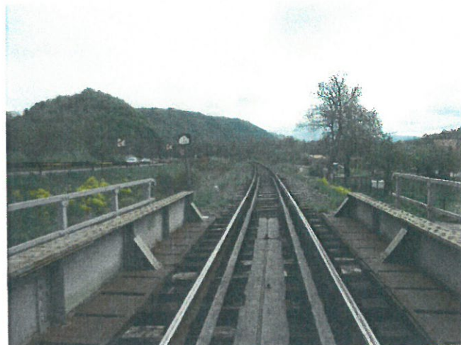
2. Vedere spre trecerea la nivel (Cluj)
