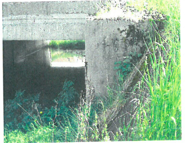
8. Vedere Culee Cluj cu elevație zid sprijin
