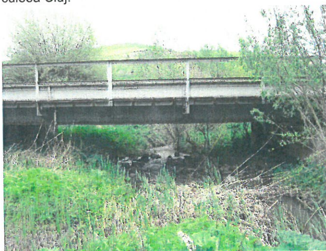
9. Vedere albie aval
