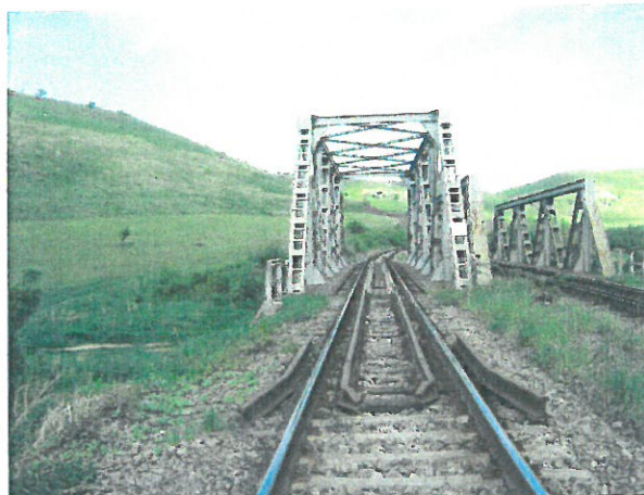
2. Calea, tipul traverselor și contrașinei pe Firul I
