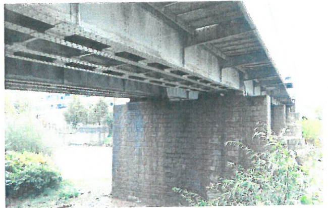
14. Vedere Elevație Pila 3
