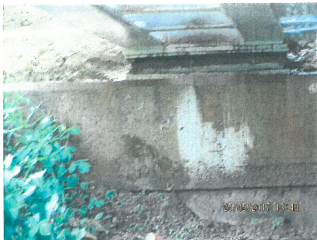
19. Aparat de reazem mobil culeea Oradea, pe Firul I
