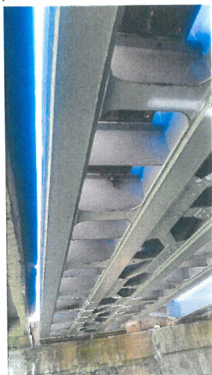
4. Vedere intrados tablă metalică G.G.I.P.C.S. – sudat, pe Firul I
