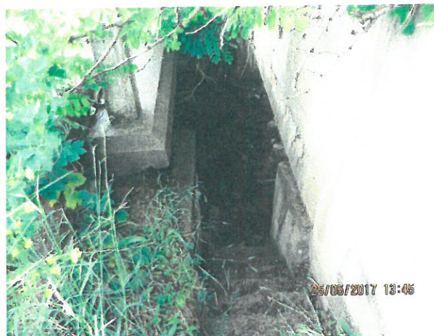
8.Scări de acces la Culeea Cluj Napoca, în aval
