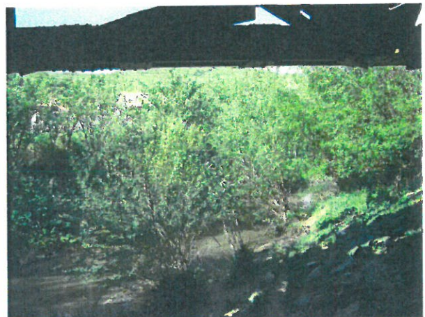
16. Vedere albie, Amonte
