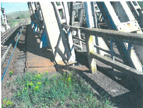
15. Parapet de beton de pe culee Cluj Napoca, între Fire
