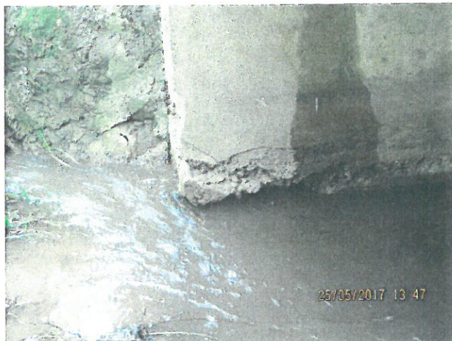
13.Degradare culee Oradea, pe Firul I
