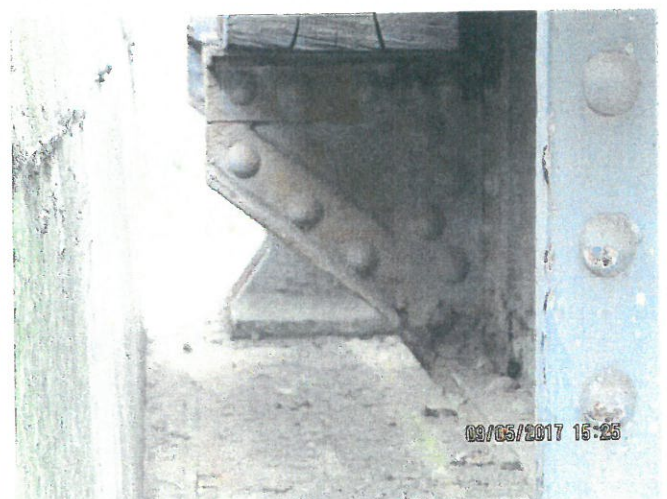
12. Consola lonjeronului cu nituri corodate
