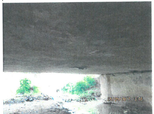
6. Vedere intrados tablier de beton, pe Firul I
