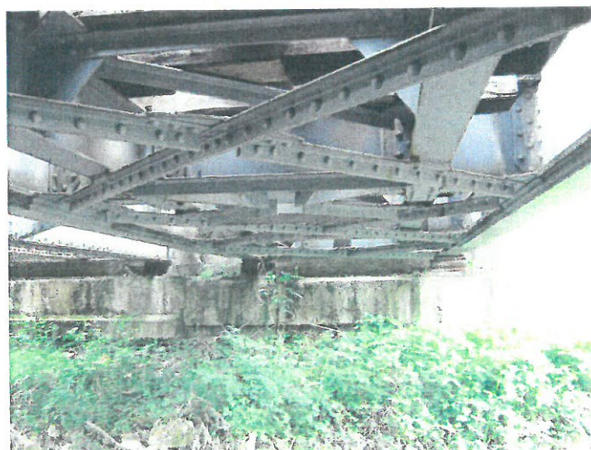
5. Vedere contravântuiri tablier linia I
