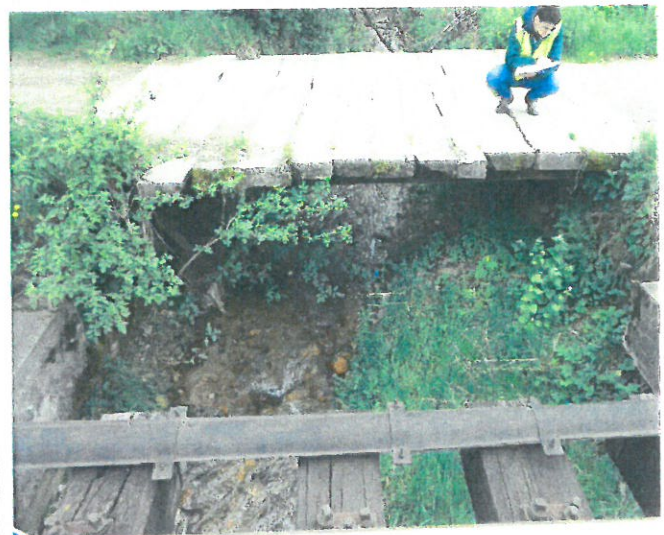
4. Vedere albie aval
