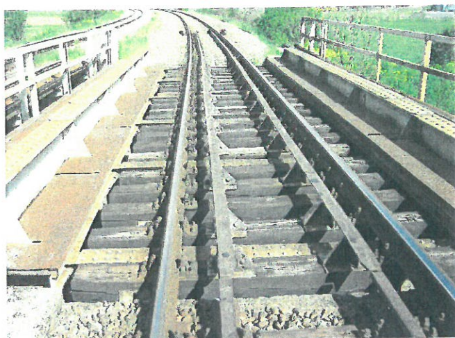
13. Trotuar și parapet linia II
