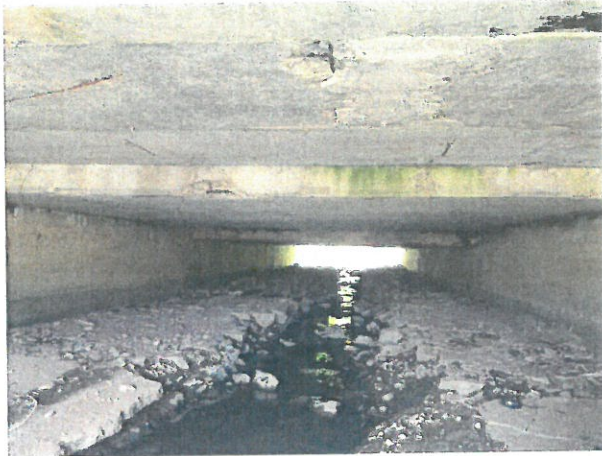
9.Vedere intrados dală beton
