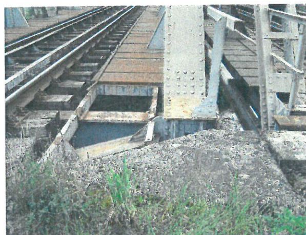
16. Lipsă tablă striată pe trotuarul tablierului de pe Firul II
