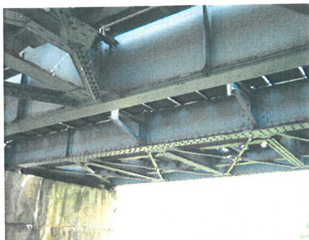
Contravântuiri pod linia 2, în planul al doilea
