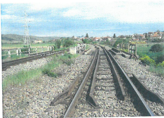
3. Vedere spre Cluj linia 2
