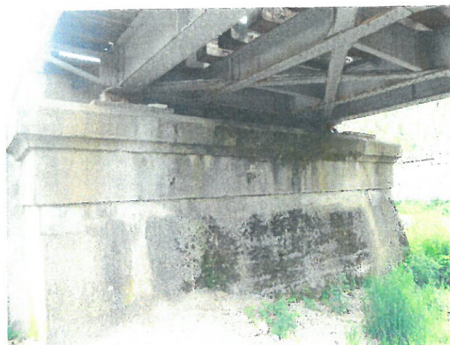
14. Elevație grindă principală afectată de rugină
