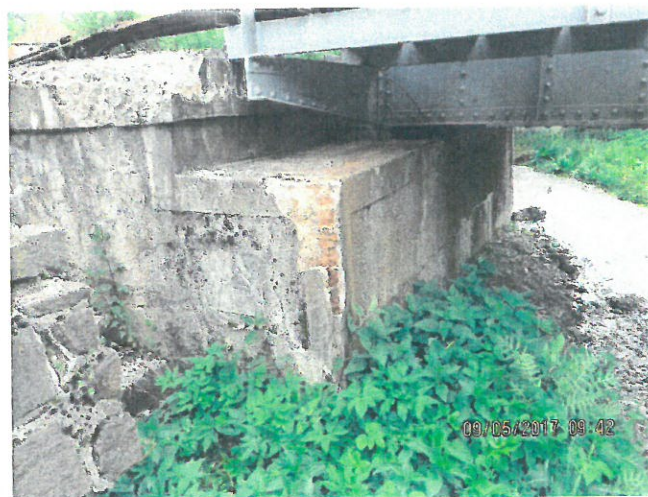
18. Vedere din aval spre culeea Oradea
