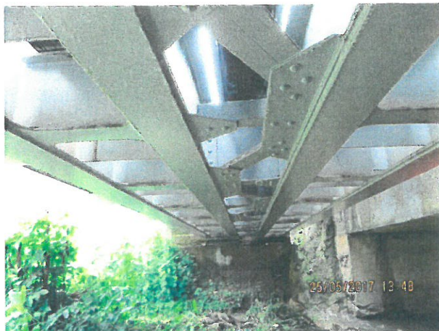
7.Vedere intrados tablier metalic G.G.I.P.C.S. – sudat, pe Firul II
