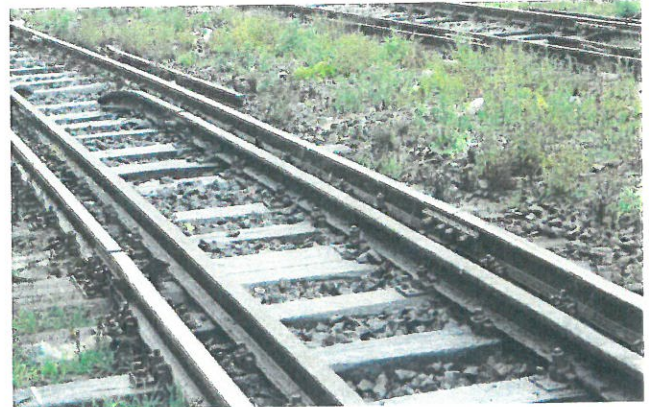
2.Calea și tipul contrașinei pe terasament
