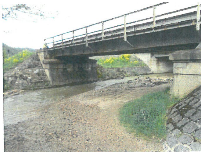
3. Vedere din aval, în amonte se poate vedea podul de șosea
