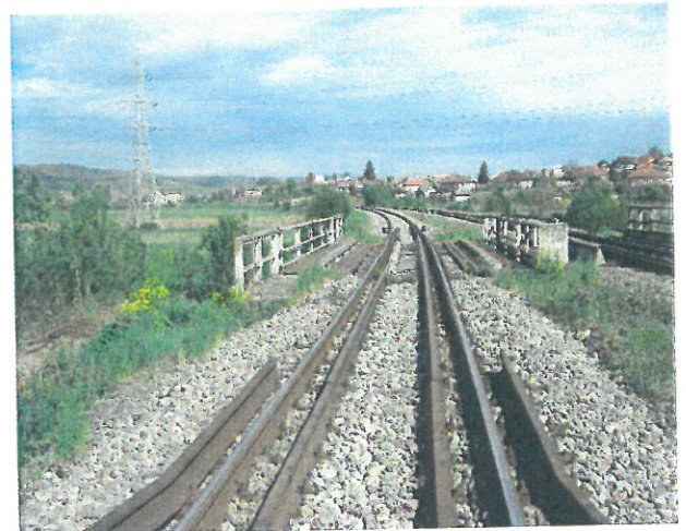
4. Vedere spre Cluj linia 1
