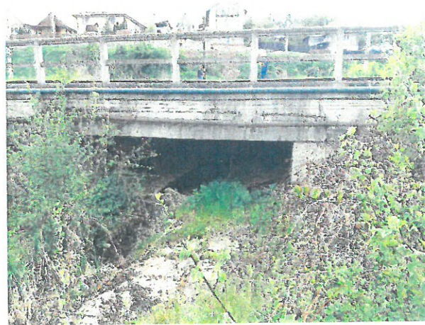
6. Elevație pod, în Aval
