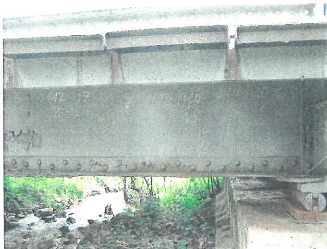
13. Vedere aparat de reazem mobil pod nituit
