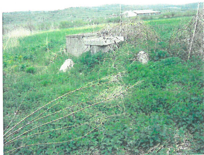
8. Puț de dren amonte
