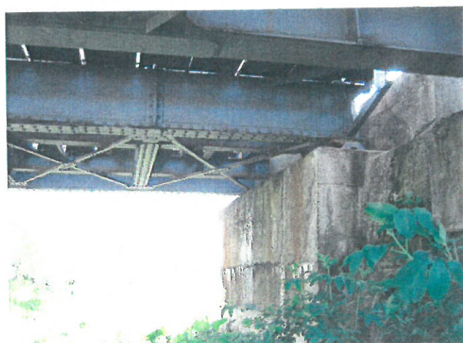
17. Vedere Culee Oradea, pod linia II
