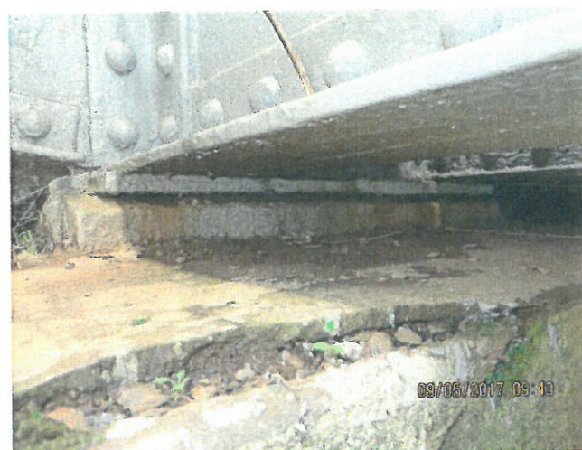
14. Zidul întors degradat
