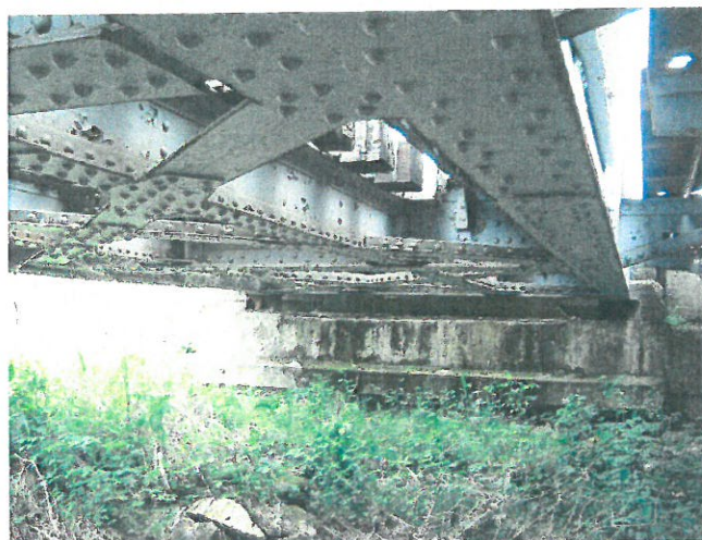
14. Contravântuirea inferioară pod linia II
