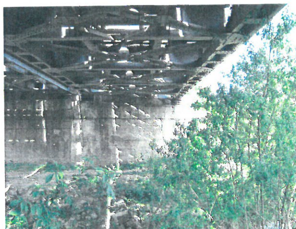
6. Vedere intrados tablier metalic G.Z.C.J – parțial sudat, pe Firul II
