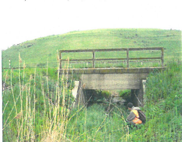
9. Elevație dală de beton, pe Firul II
