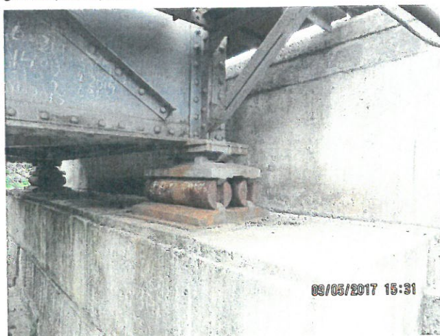
5. Aparate de reazem mobile pe culeea Oradea
