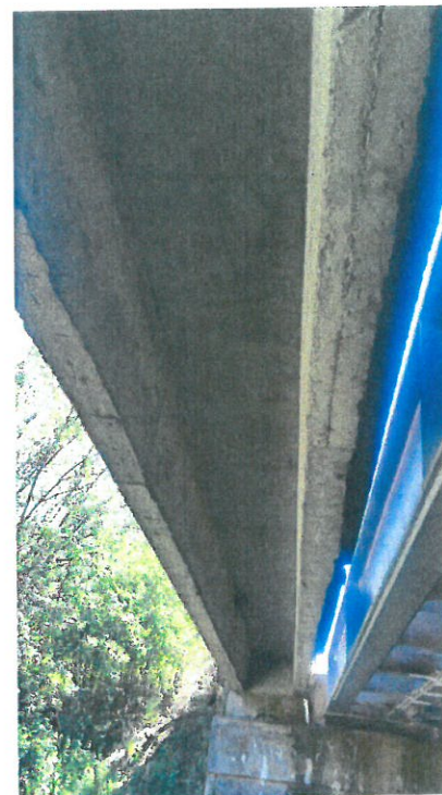
3. Vedere intrados trotuar chesonat, pe Firul I
