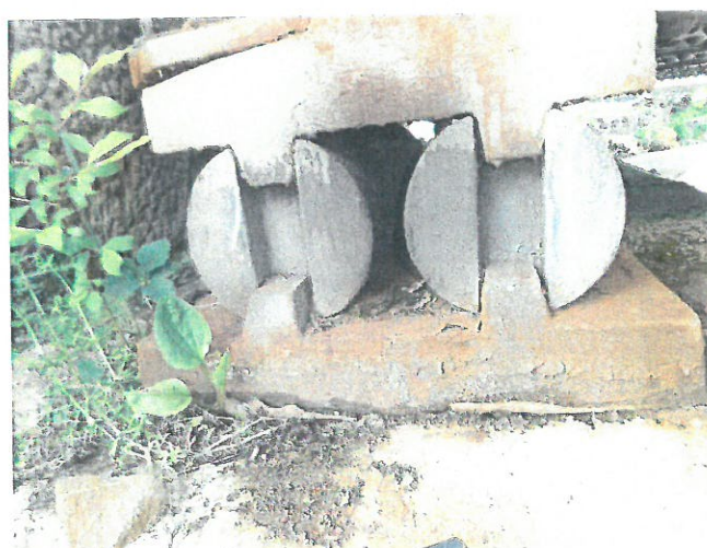
12. Aparatul de reazem mobil pe culeea Oradea
