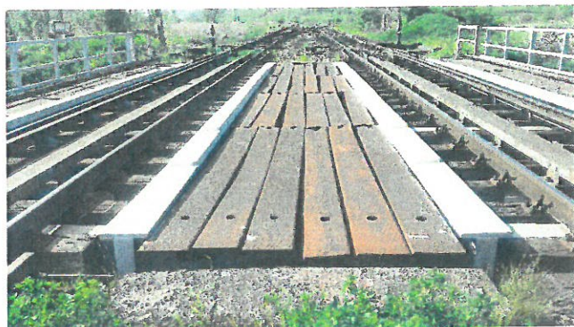
1.Calea, prinderea ei și tipul traverselor pe pod
