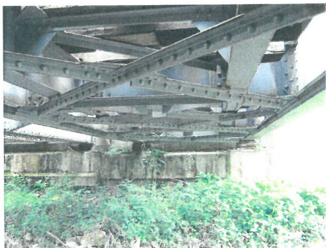
3. Vedere culee Cluj
