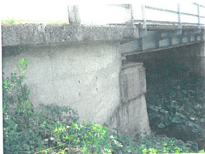
9. Rezemare cu despicarea orizontală a cuzinetului
