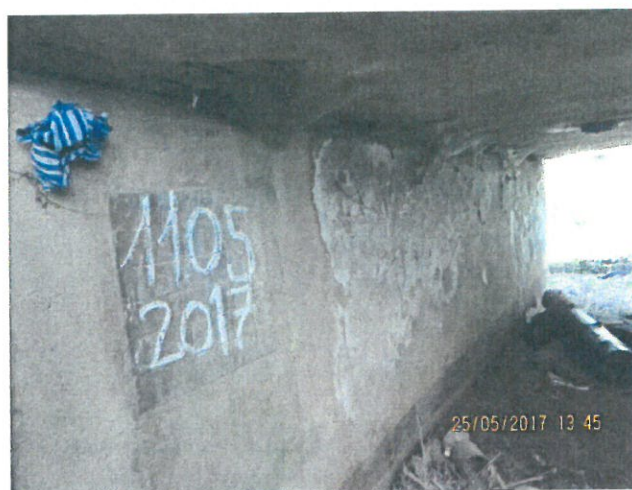
10.Vedere Elevație Culee Cluj Napoca, pe Firul I
