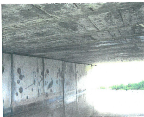
14. Suprastructura din dale D5 cu armatură la vedere corodată
