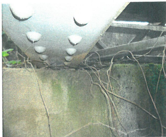
8. Vedere tolă inferioară grindă
