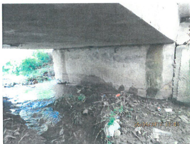
11.Vedere Elevație Culee Oradea, pe Firul I
