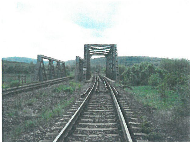
1. Calea, tipul traverselor și contrașinei pe Firul I
