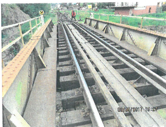
17. Contrașina pe zona podului
