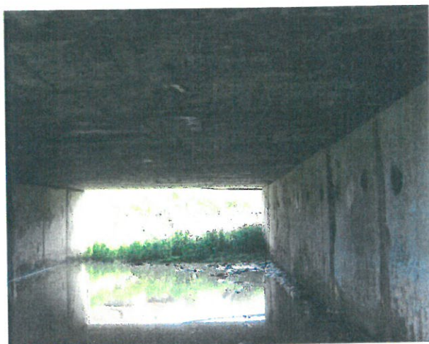
15. Rosturile între prefabricatele L decalate
