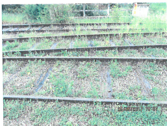
11. Liniile abătute în zona schimbătorului
