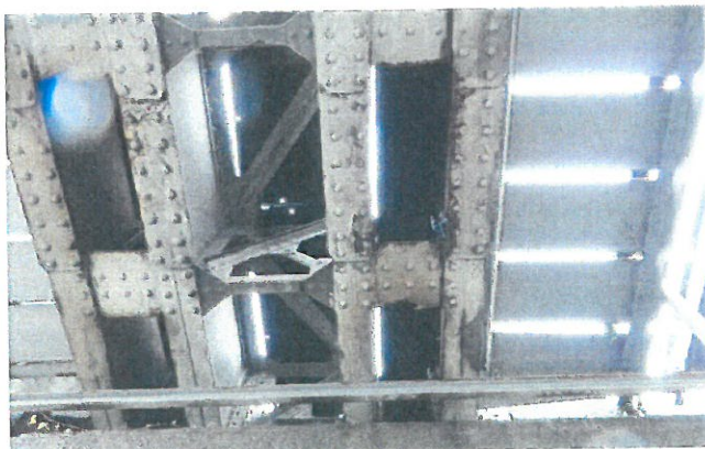
5.Vedere intrados tablier G.G.I.P.C.S.–nituit, Firul II (Pasaj Inferior)
