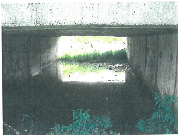
13. Vedere prefabricate în pod
