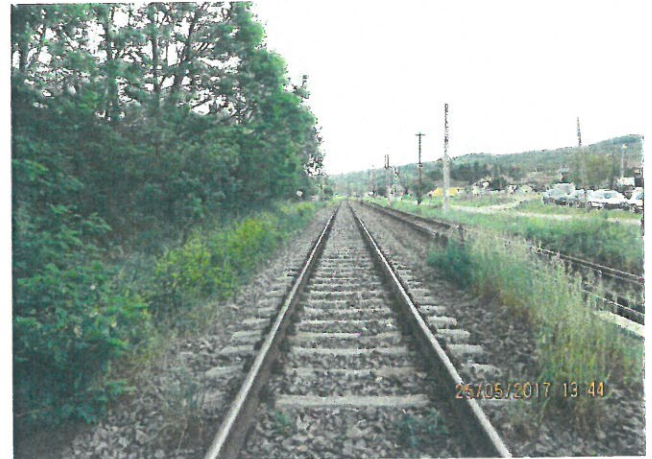
2.Calea și tipul traverselor pe Firul I
