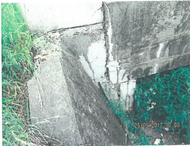
13. Vedere zid de sprijin (aripă)
