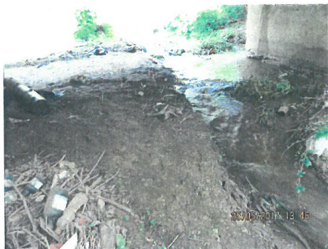
21. Vedere albie sub pod
