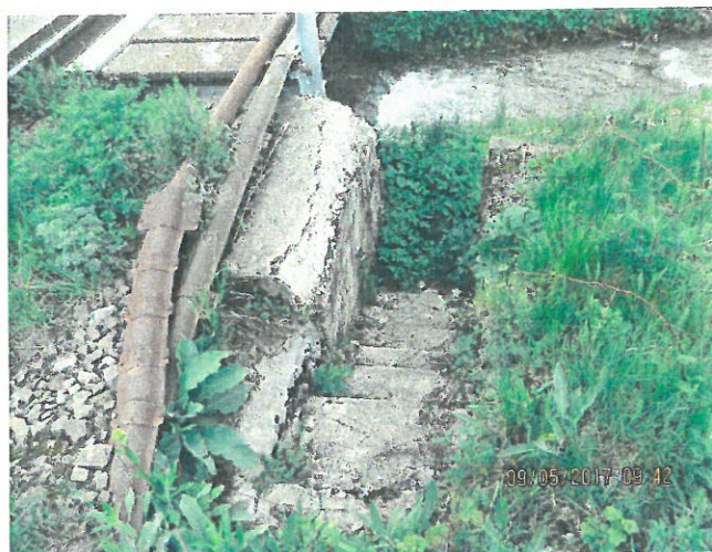
14. Zidul întors degradat
