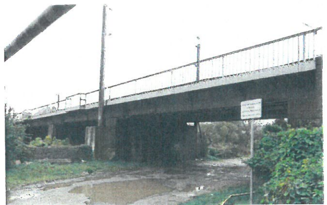
18. Elevație tablier G.G.I.P.C.S. – nituit
