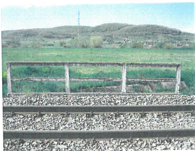
5. Vedere parapet amonte, linia II
