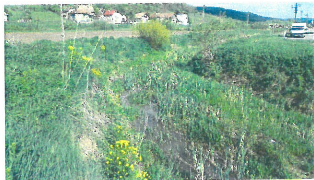
10.Vedere albie Aval
