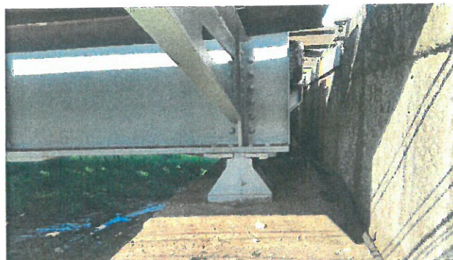
8.Aparat de reazem fix culee Cluj Napoca
