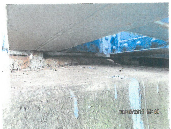
10. Elevații cu infiltrații la culeea Oradea
