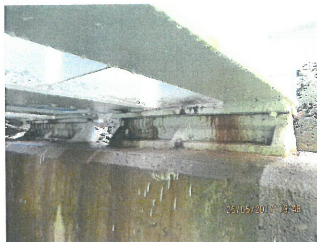
16.aparat de reazem fix Culeea Cluj Napoca, pe Firul II
