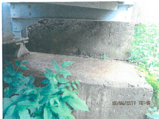
15.Zid de gardă și bancheta cuzineților culeea Cluj Napoca, pe Firul II
