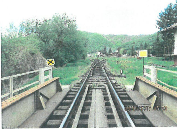
1. Vedere spre Stația Ciucea cu schimbători de cale
