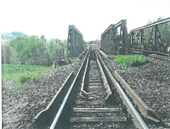
2. Calea, tipul traverselor și contrașinei pe Firul I
