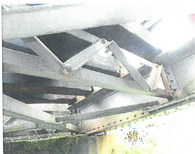
11. Contravantuire inferioară pod
