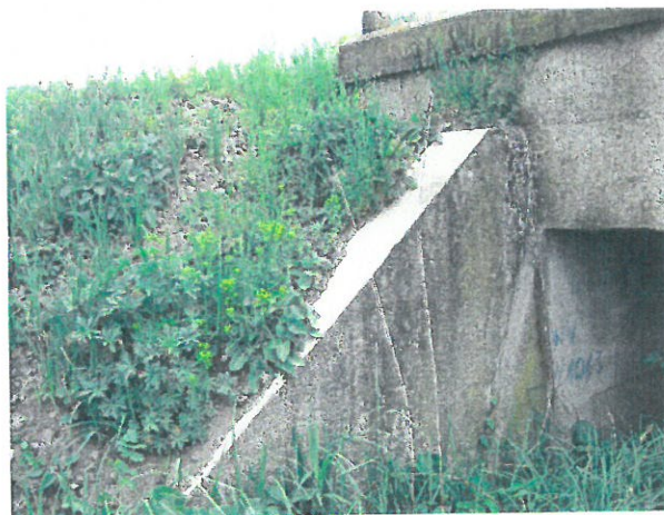
12. Aripă de beton culee Oradea, pe Firul II
