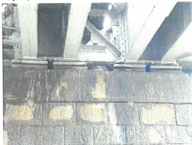
21. Aparat de reazem fix ruginit
