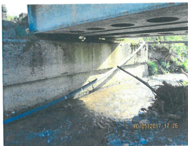
9. Vedere parte inferioară tablier spre culeea Cluj
