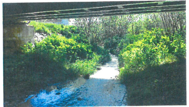
16. Vedere albie sub pod
