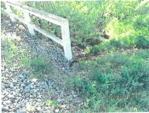
13. Parapet linia I
