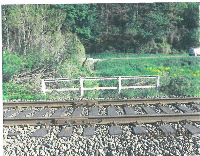
3. Vedere spre parapet linia I, calea pe traverse de lemn
