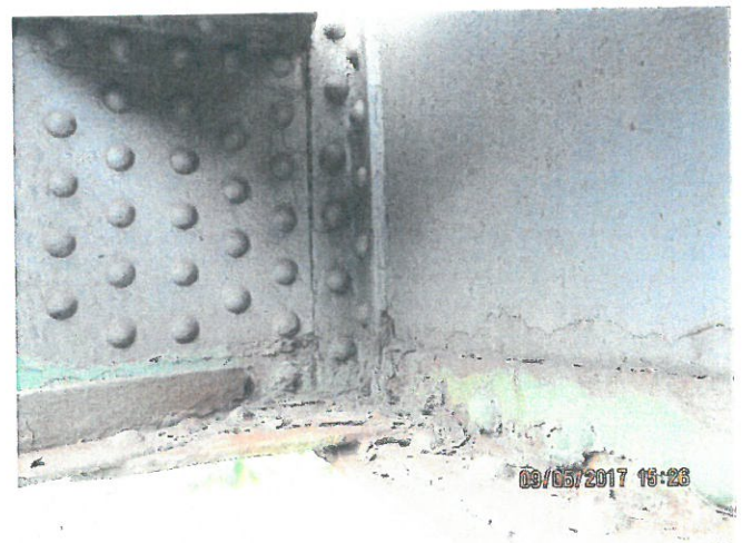
6. Prinderea antretoazei de grinda principală, zonă corodată cu reducerea secțiunii inimii
