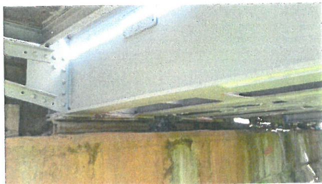
9.Aparat de reazem mobil Culeea Oradea, Fir II
