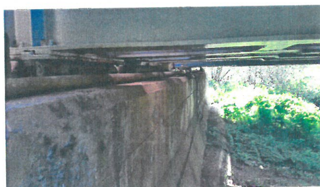
12. Aparat de reazem mobil Culeea Cluj Napoca, Fir I
