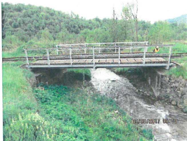
3. Vedere din amonte, valea oblică în raport cu podul
