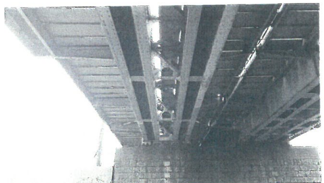
6. Vedere intrados tablier G.G.I.P.C.S. – nituit, Firul I (Pasaj Inferior)
