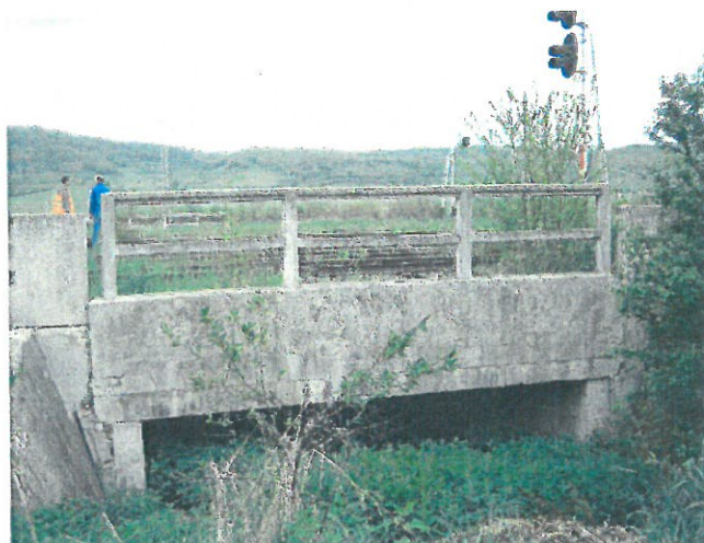
4. Vedere timpan și parapet aval
