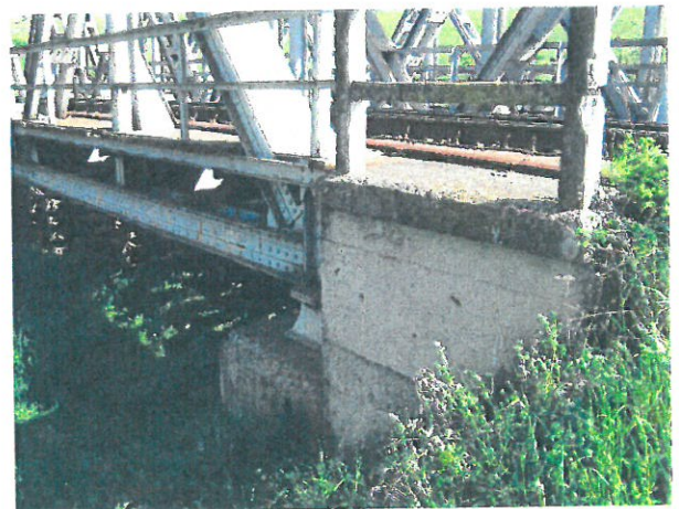
12. Vedere culee Cluj Napoca și aparat de reazem fix, pe Firul II
