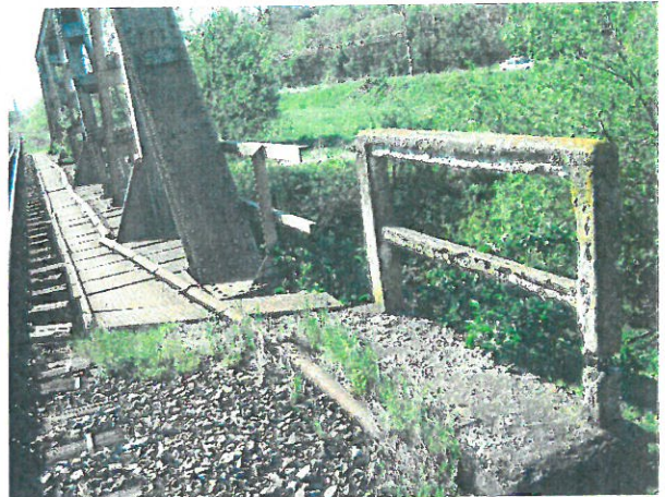
14. Parapet de beton de pe culee Oradea, pe Firul II
