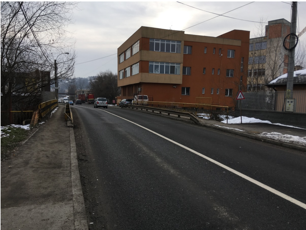
Str. Tudor Vladimirescu, vedere spre km 0+360 (podul peste Pârâul Nadăș).
