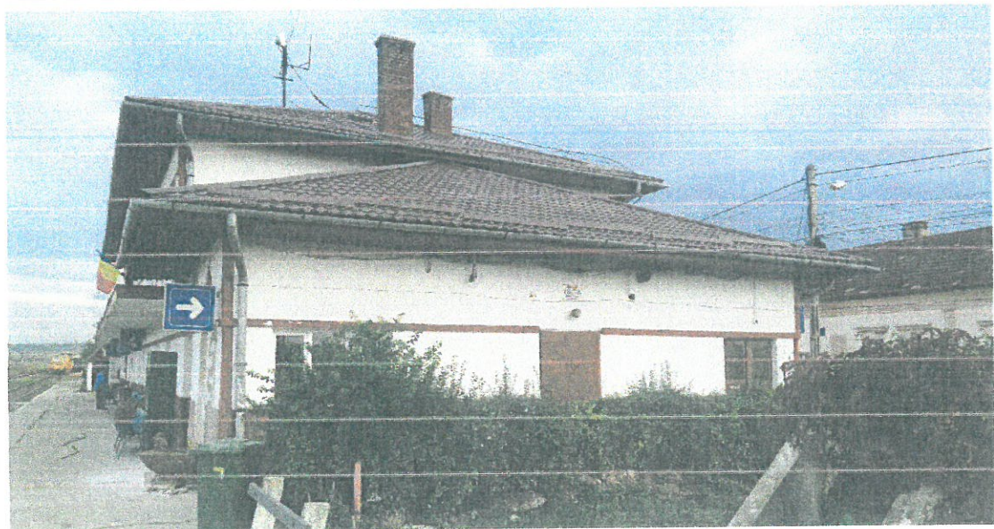
Acoperișul de tip șarpantă din lemn cu țiglă metalică
