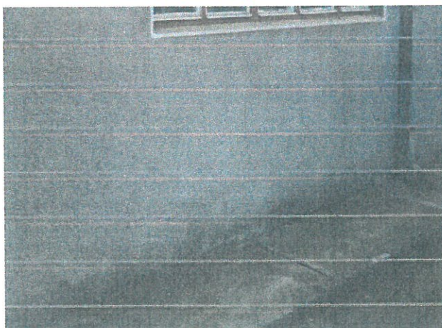
Exfolieri, desprinderi ale tencuielii exterioare
