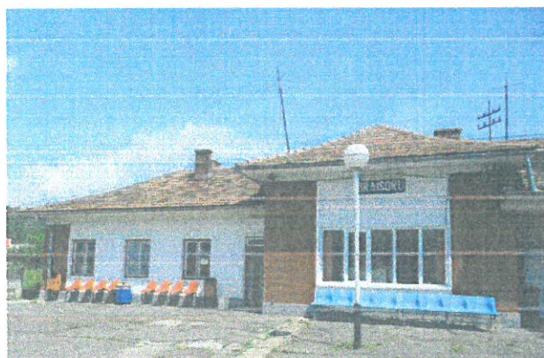
Acoperișul de tip șarpantă din lemn cu țiglă ceramică
