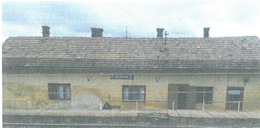
Clădirea de Călători +locuință Halta Aghireșu
