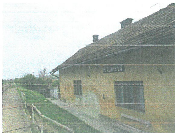
Acoperișul de tip șarpantă din lemn cu țigă
