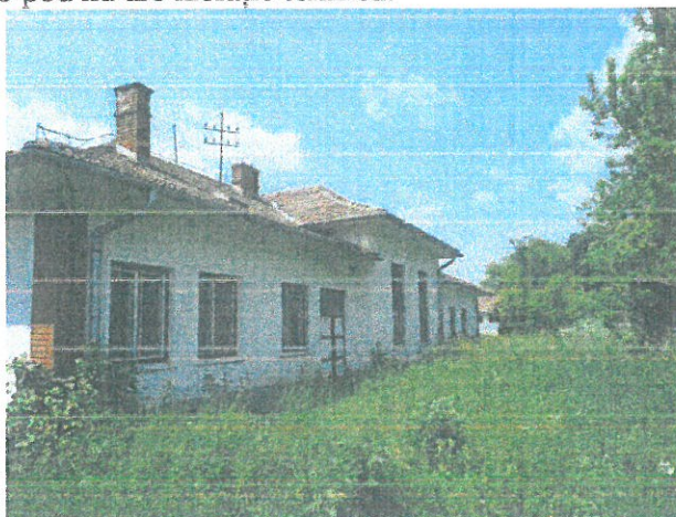
Pereți portanți din zidarie de cărămidă
