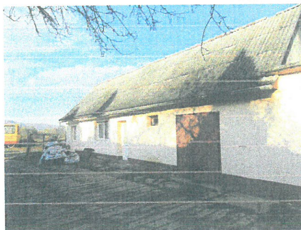
Pereți portanți din zidarie de cărămidă
