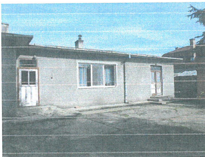
Tâmplăria exterioară – uși și ferestre din PVC
