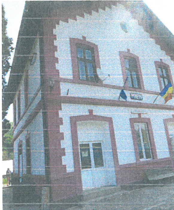
Pereți portanți din zidarie de cărămidă
