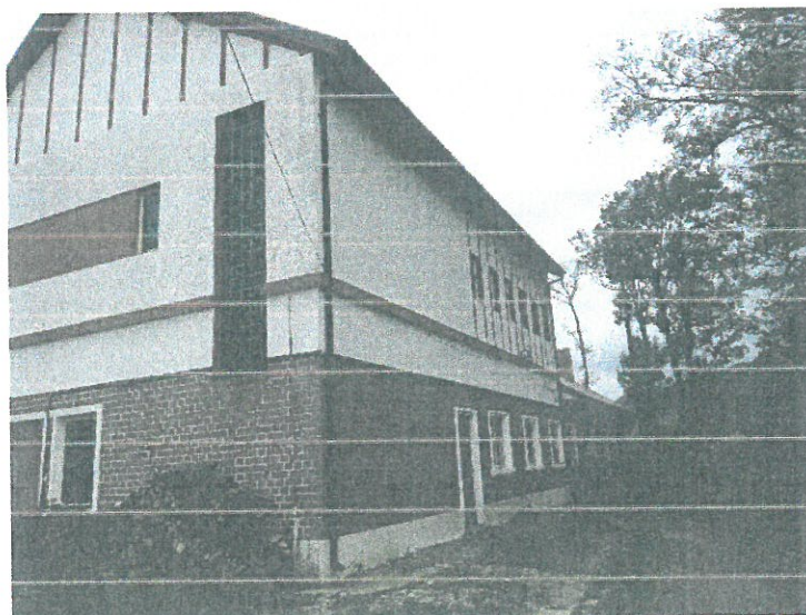
Acoperișul de tip șarpantă din lemn cu țigla din tablă
