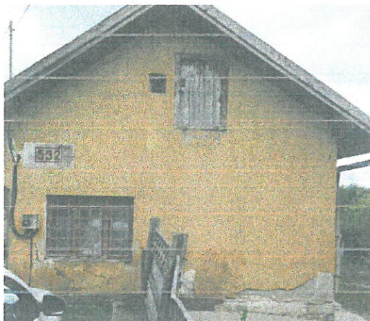
Pereți portanți din zidarie de cărămidă
