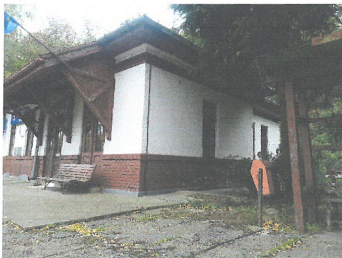
Pereți portanți din zidarie de cărămidă
