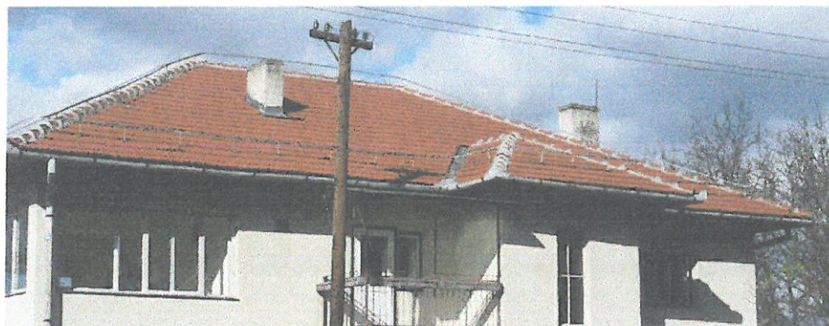
Acoperiș tip șarpantă din lemn
