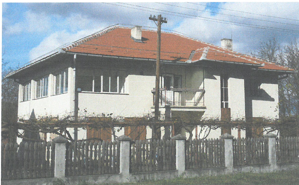
Clădire District L8 Halta Stana
