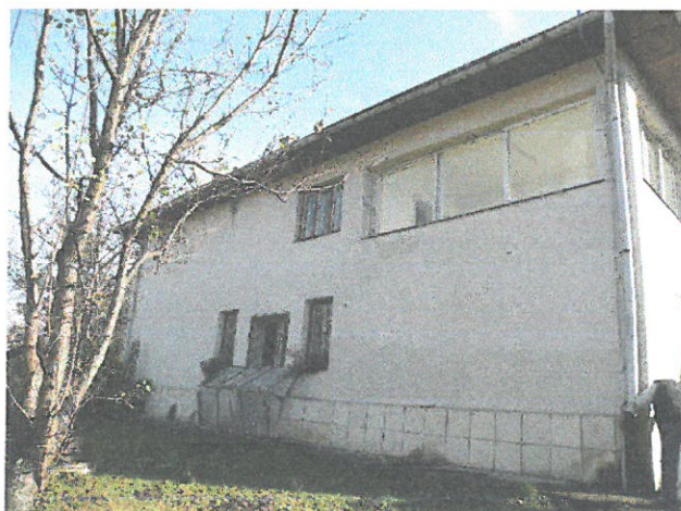
Pereți portanți din zidarie de cărămidă
