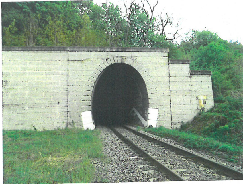
Portal Intrare tunel Stana fir I
