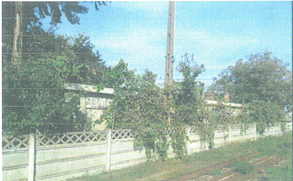
Stația Aleșd – CLĂDIRE DISTRICT L3D12+LOCUINȚĂ PICHER
