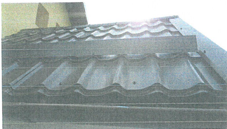
Acoperișul de tip șarpantă din lemn cu țiglă metalică
