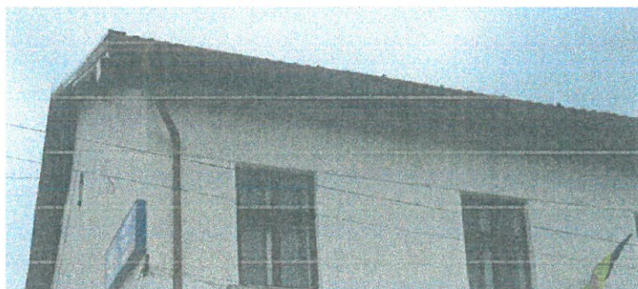
Acoperișul de tip șarpantă din lemn cu tablă LINDAB
