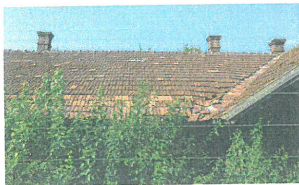
Acoperișul de tip șarpantă din lemn cu țiglă
