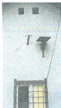
Pereți portanți din zidarie de cărămidă
