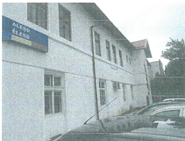
Pereți portanți din zidarie de cărămidă
