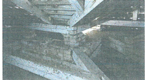
Acoperișul de tip șarpantă din lemn cu țigla
