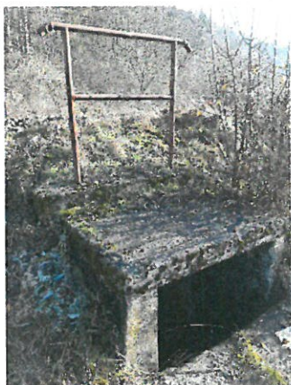
9. Vedere podeț aval
