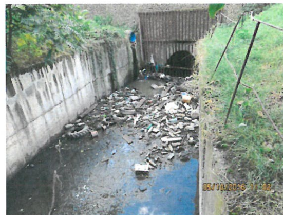
12. Vedere canal de scurgere aval
