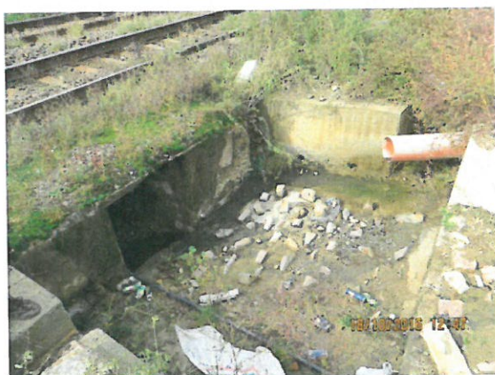
5. Vedere cameră de cădere amonte
