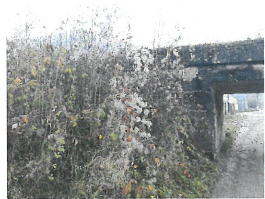
6. Vedere sfert de con amonte culee Oradea.
