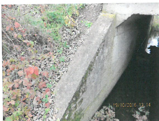
5. Vedere aripă prefabricată amonte
