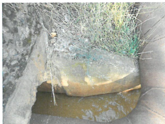
9. Vedere aripă aval
