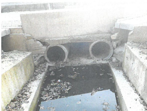
9. Vedere podeț de sosea și cameră de cadere.
