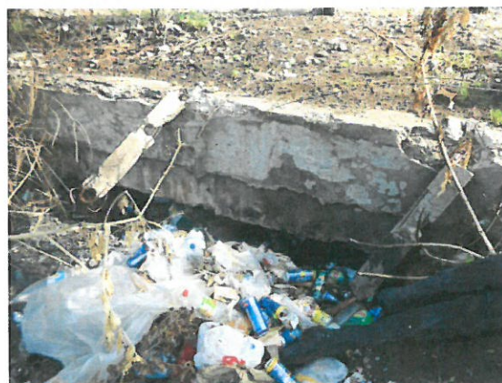
5. Vedere timpan și parapeti amonte
