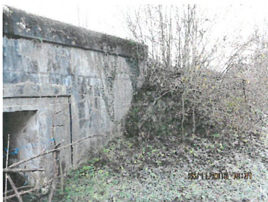
7. Vedere sfert de con amonte.
