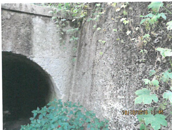
5. Vedere aripă din beton amonte
