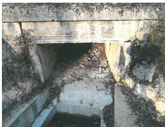
12. Vedere podeț aval.
