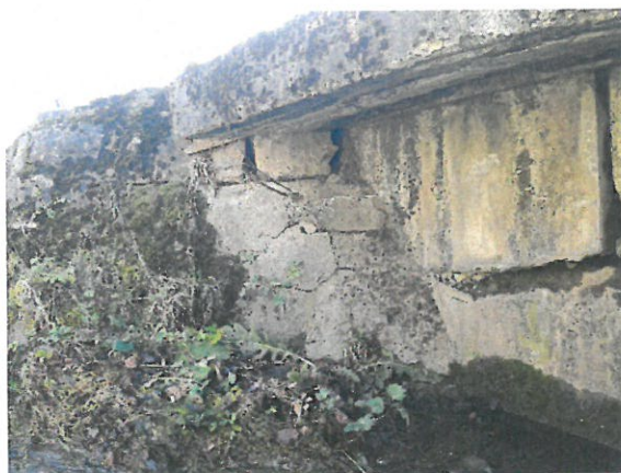
9. Vedere racordare cu terasementul amonte culee Cluj.
