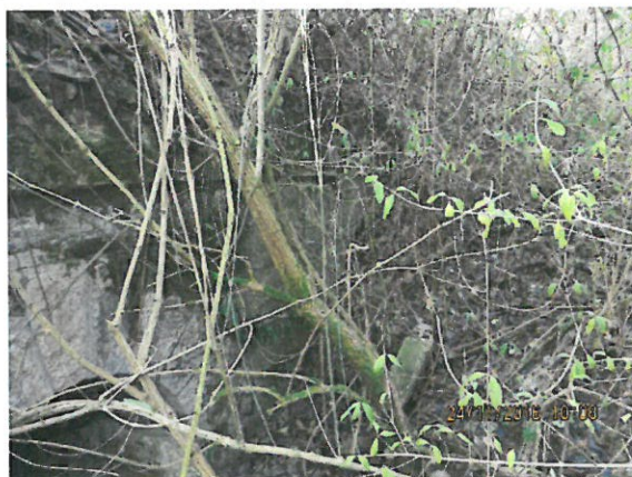
9. Vedere racordare cu terasamentul dreapta amonte
