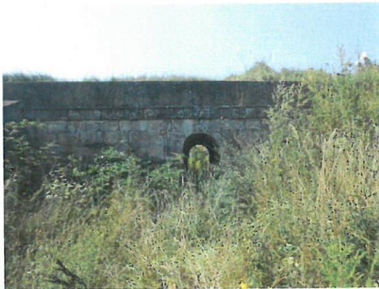
3. Vedere elevație amonte
