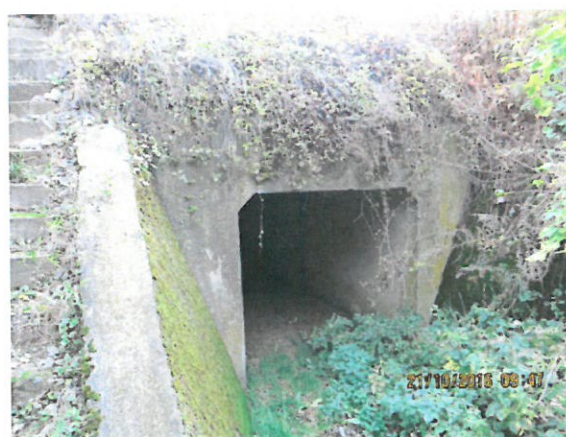
6. Vedere podet din amonte
