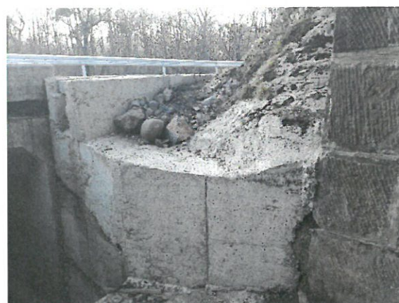
11. Vedere sfert de con aval culee Oradea.
