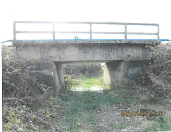
11. Vedere elevație aval
