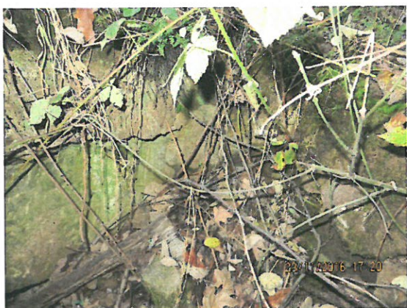
7. Colmatare cu piatră a camerei de cădere
