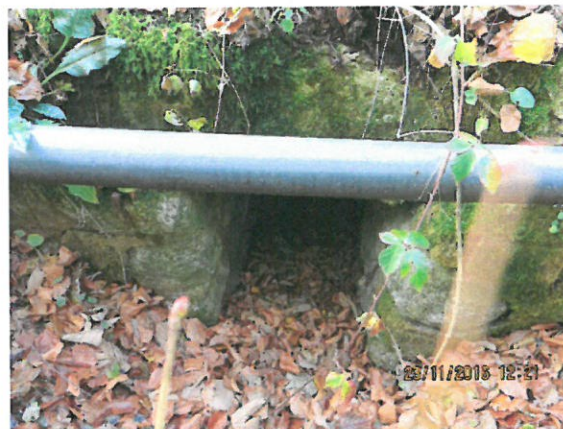
4. Vedere timpan amonte
