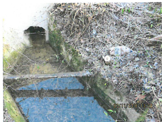
12. Pozare cablu aval
