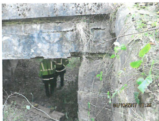
3. Vedere elevație amonte
