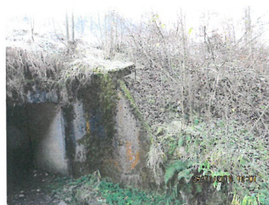
5. Vedere aripă amonte Oradea.
