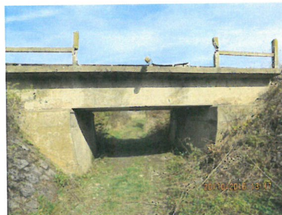
4. Vedere elevație amonte
