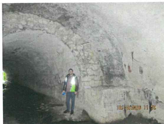
9. Vedere interior podeț spre amonte
