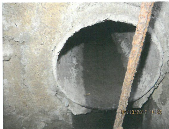
4. Vedere interior canalizare
