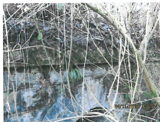
10. Acoperire cu vegetatie a timpanului amonte
