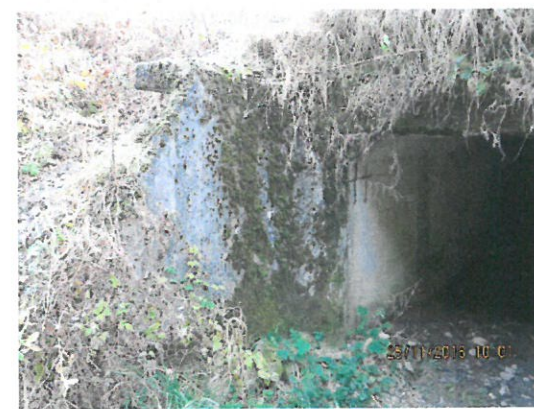
6. Vedere aripă amonte Cluj.
