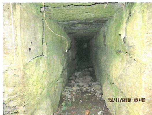
6. Vedere interior podeț din amonte.
