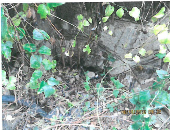
5. Vedere elevație amonte
