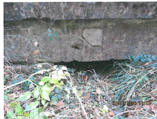
4. Vedere podet amonte .
