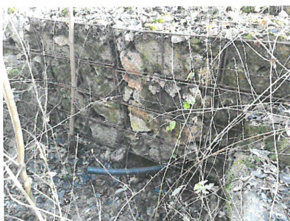
5. Vedere podeț amonte .
