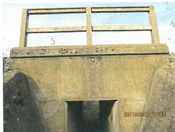
9. Vedere timpan și parapet aval
