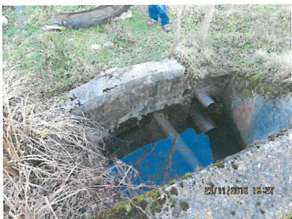
7.Vedere zid de beton între aripi în dreapta căii
