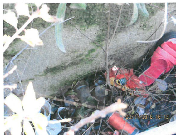
10. Vedere intrados cămin aval
