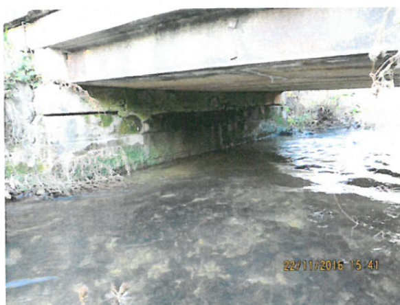
5. Vedere culee mal stâng amonte
