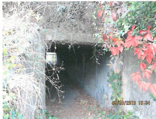
10. Vedere elevație aval
