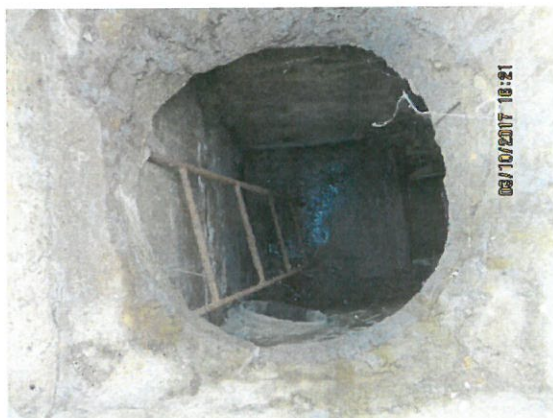
3. Vedere interior canalizare
