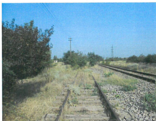
2. Vedere C.F. dezafectat
