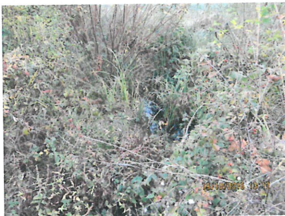
11. Vedere intrare în podet aval
