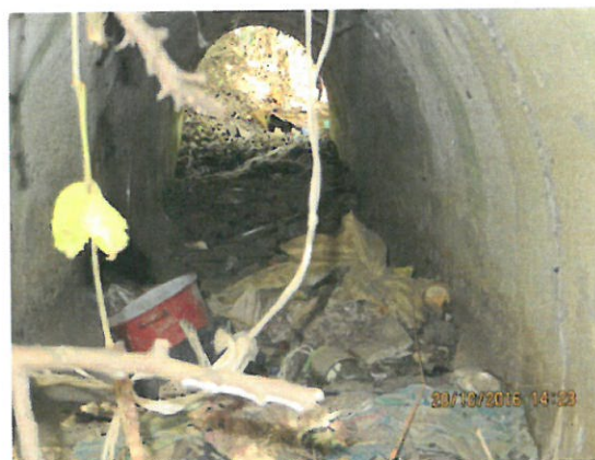
4. Vedere interior podet dinspre amonte
