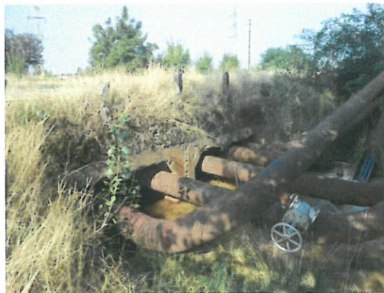
8. Vedere elevație aval
