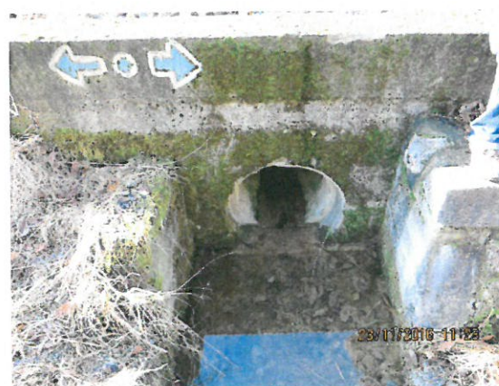
6. Cameră de cădere și timpan amonte
