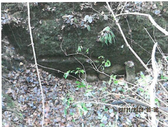
7. Vedere timpan amonte
