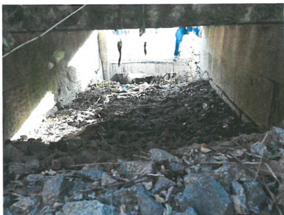
7. Vedere interior podeț.
