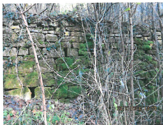
6. Vedere zid de sprijin amonte
