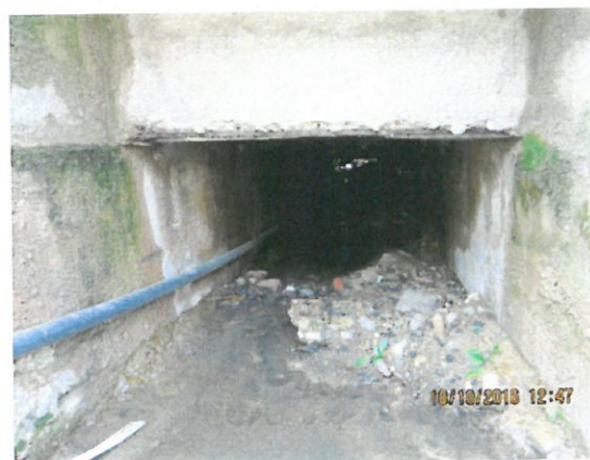
4. Vedere elevație amonte
