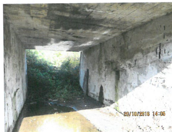
12. Vedere interior podeț
