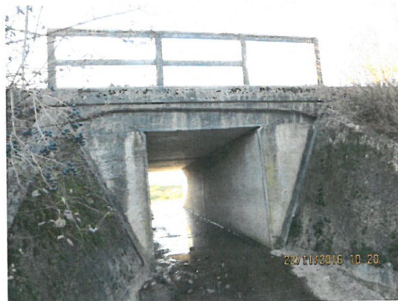
8. Interior podeț dinspre aval
