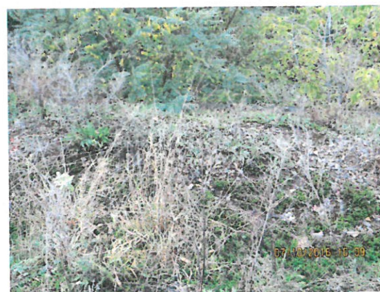
6. Vedere zid de sprijin acoperit de vegetație amonte
