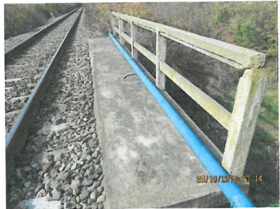
10. Vedere timpan, parapet și cabluri aval
