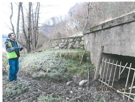
11. Vedere zid de sprijin si sfert de con culee Cluj.
