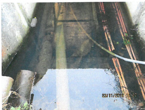
9. Vedere conductă și cabluri ce subtraversează podețul
