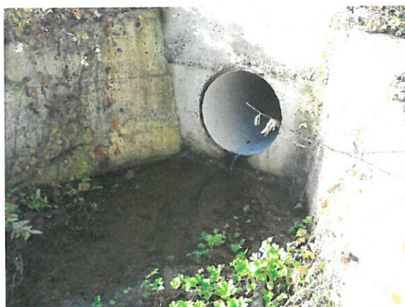
11. Vedere aval podeț de șosea.
