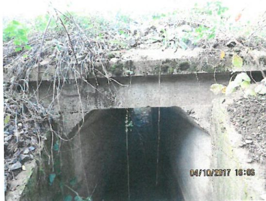
8. Vedere timpan aval
