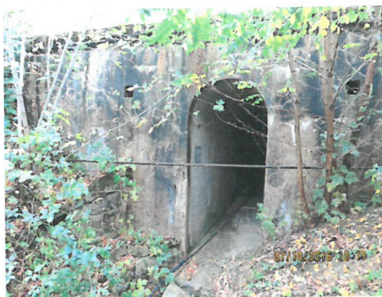
8. Vedere elevație aval
