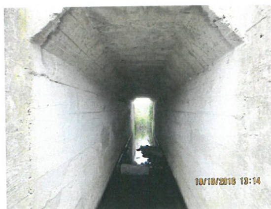
6. Vedere interior podeț dinspre amonte
