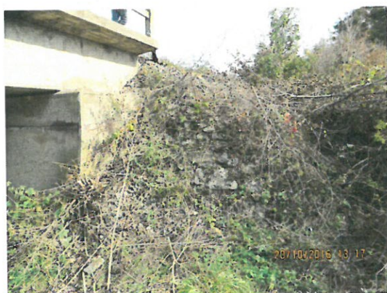
5. Vedere sfert de con amonte
