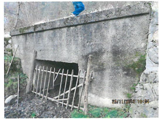
10. Vedere podeț dalat aval.
