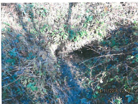
9. Vedere podeț aval
