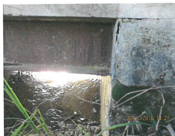
6. Vedere culee dreapta din amonte
