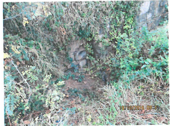
4. Vedere albie amonte
