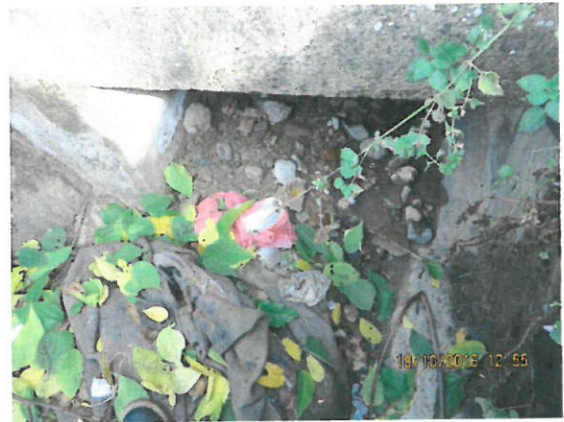
8. Vedere elevație aval
