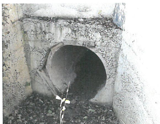
11. Vedere aval podeț de șosea.
