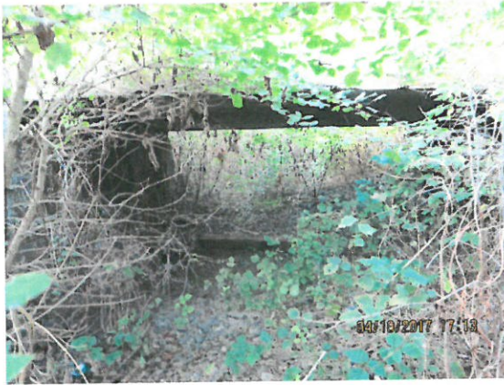
7. Vedere elevație aval
