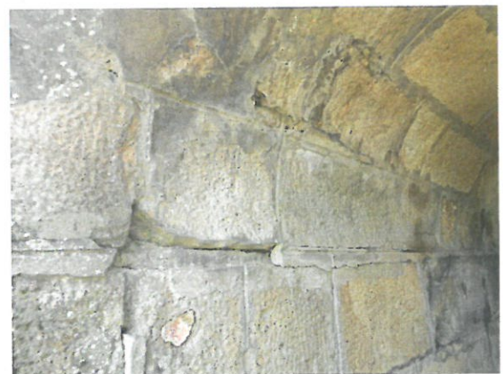
6. Vedere aripă amonte
