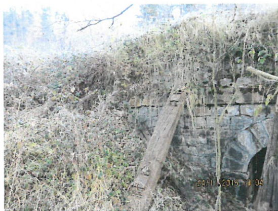
5.Vedere racordare cu terasamentul dreapta aval
