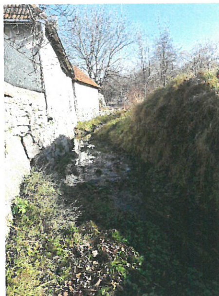
10. Vedere albie amonte și protecție case.
