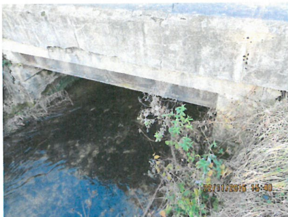
3. Vedere din amonte spre podet
