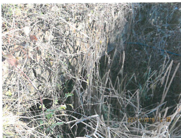
5. Vedere spre podet din amonte
