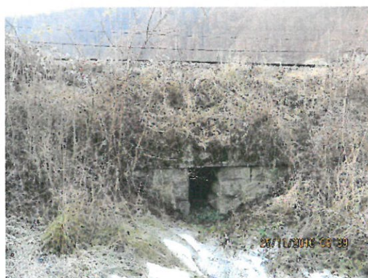
5. Vedere podeț amonte și racordarea cu terasamentul.
