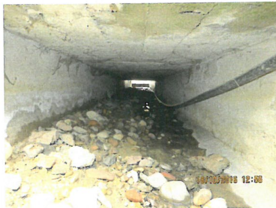
9. Vedere interior podeț dinspre aval
