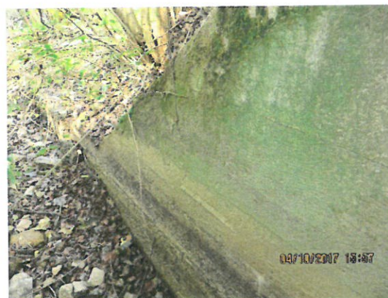
4. Vedere aripă prefabricată amonte
