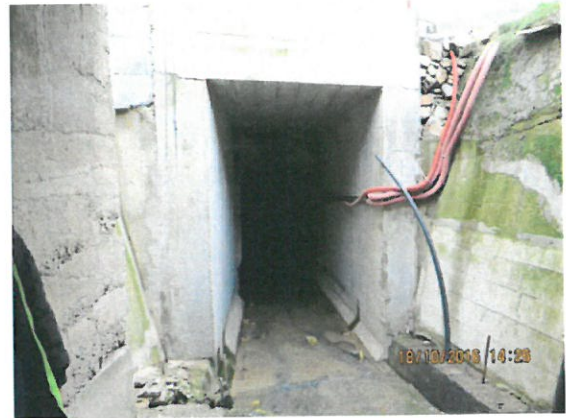
4. Vedere elevație amonte
