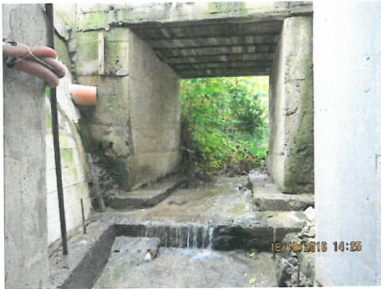
7. Vedere podeț sub drum amonte
