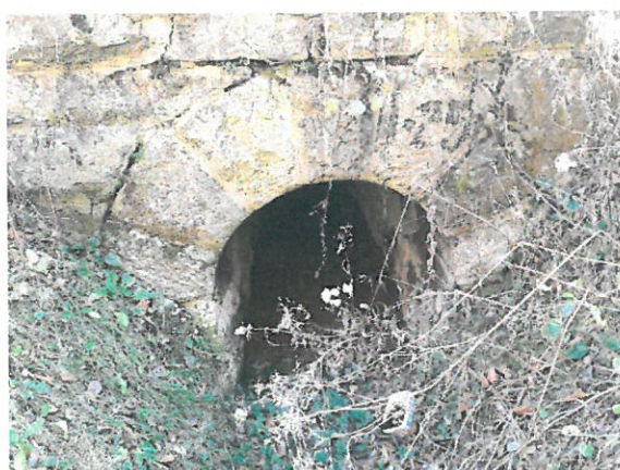
5. Vedere podeț amonte .
