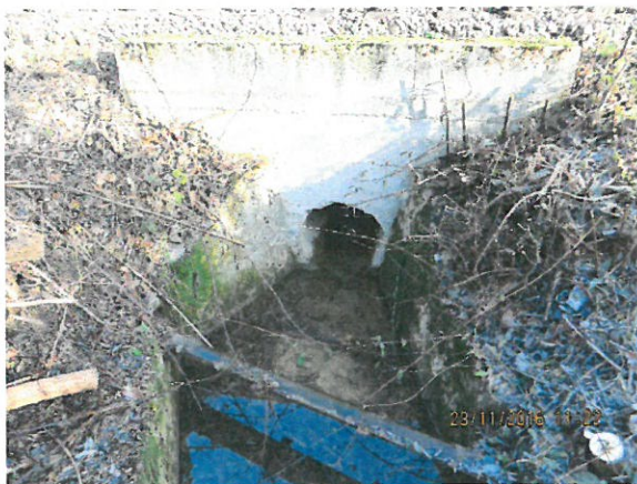
7. Vedere timpan aval
