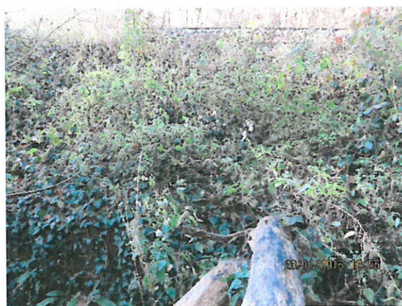
11. Vedere platformă C.F. dinspre amonte
