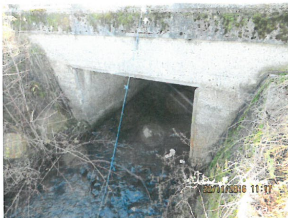
7. Vedere spre podeț din aval
