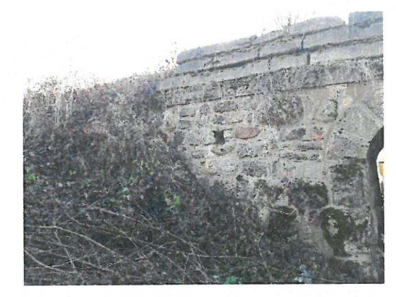
6. Vedere racordare amonte culee Cluj.
