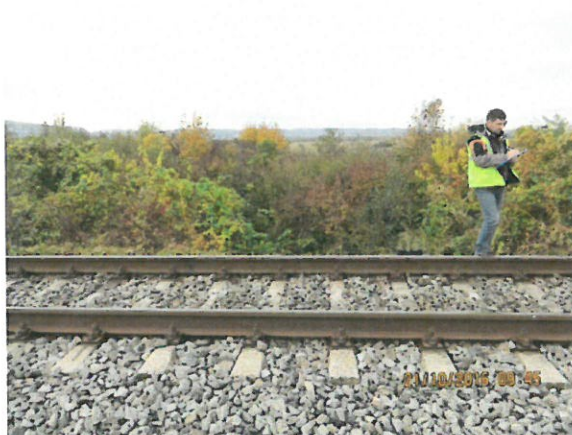
3. Vedere spre amonte
