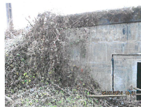
6. Vedere aripa amonte.
