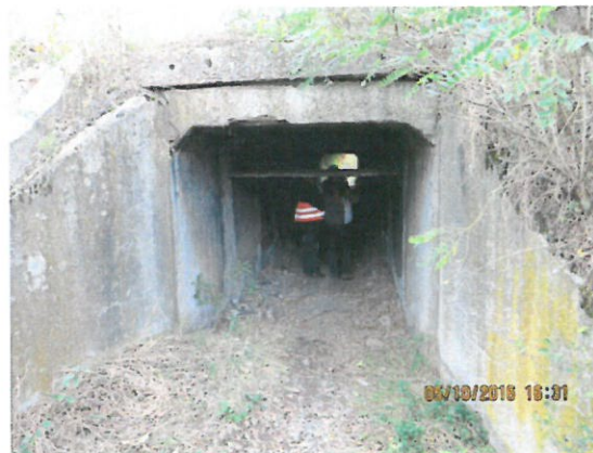
4. Vedere elevație amonte
