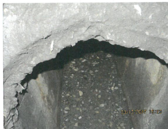
6. Vedere interior canalizare
