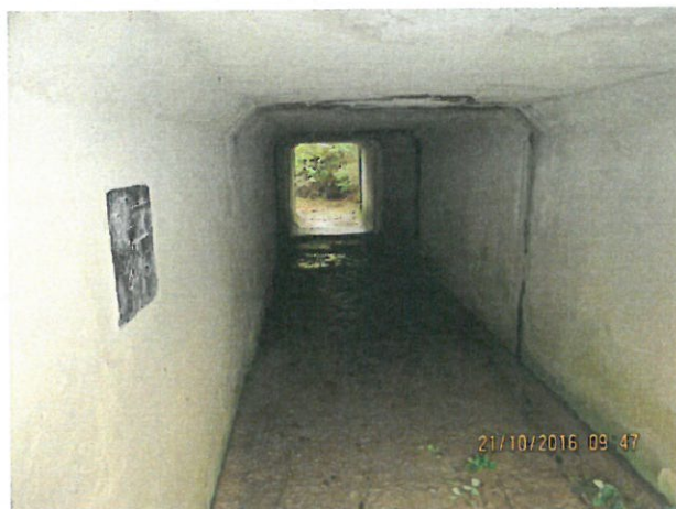
7. Vedere interior podeț din amonte
