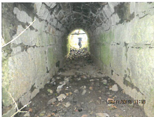
7. Vedere interior podeț.
