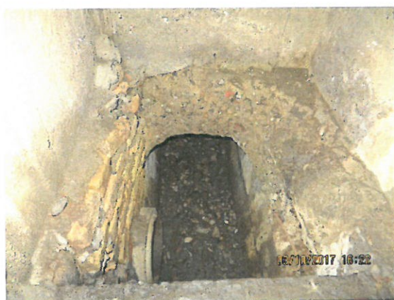
5. Vedere interior canalizare
