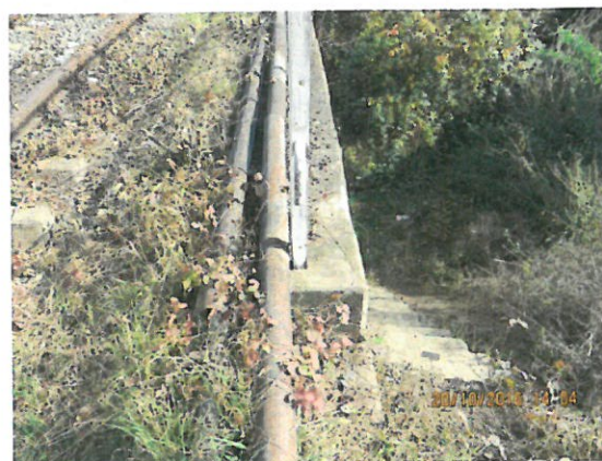
10. Vedere timpan, parapet metallic și cabluri aval
