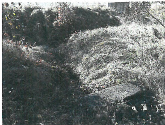
8. Vedere timpan aval.
