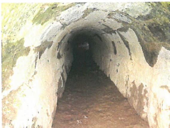
7. Vedere interior podeț.
