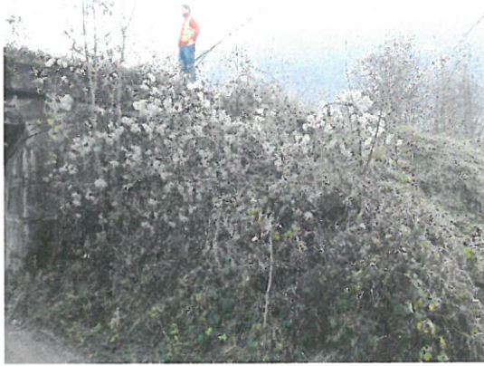
7. Vedere sfert de con amonte culee Cluj.
