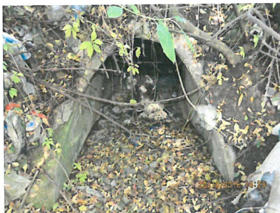
3. Vedere elevație amonte
