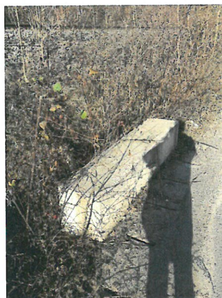
10. Vedere podeț aval.
