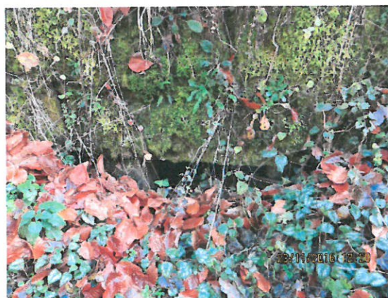
6. Vedere timpan aval
