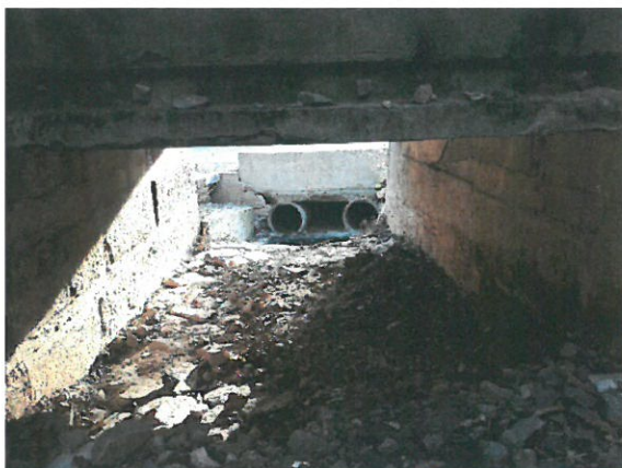
7. Vedere interior podeț.
