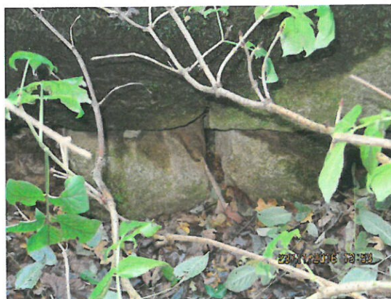
8. Colmatarea intradosului podețului
