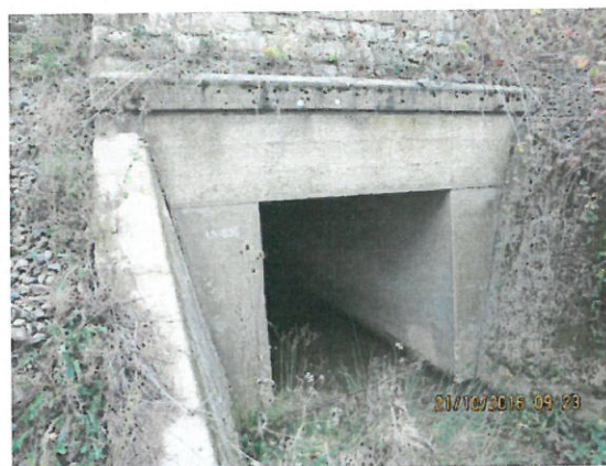
8. Vedere elevație aval
