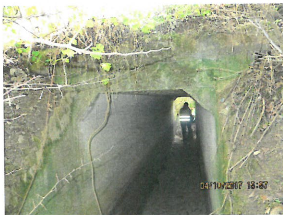
3. Vedere timpan amonte
