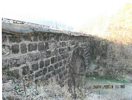
5. Racordare cu terasamentul amonte.
