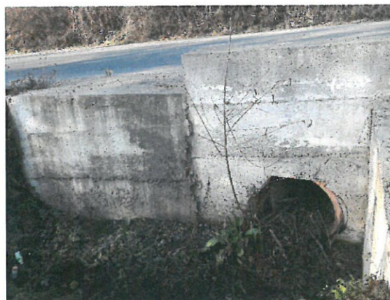
10. Vedere podeted de șosea în aval.
