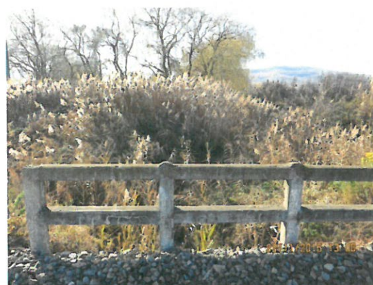
4. Vedere albie spre amonte
