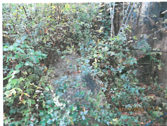
9. Vedere zid de sprijin acoperit de vegetație aval
