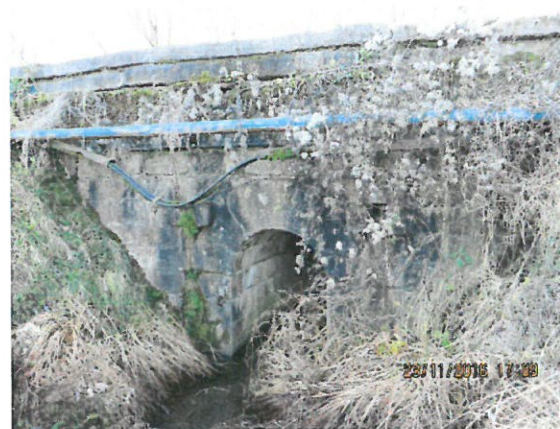
4.Vedere timpan amonte
