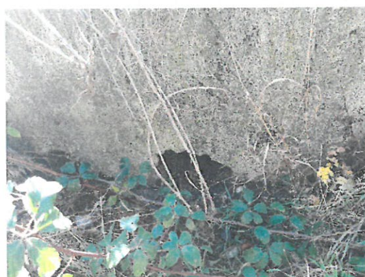
5.Vedere podeț amonte.
