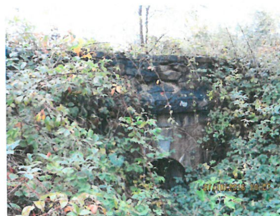
4. Vedere elevație amonte
