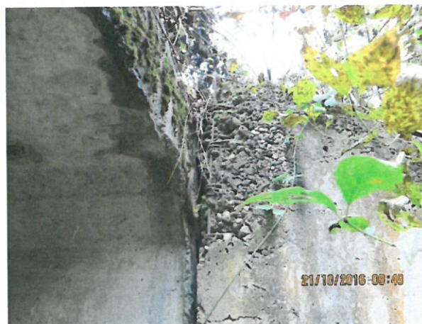
12. Detaliu timpan și aripă podeț din aval
