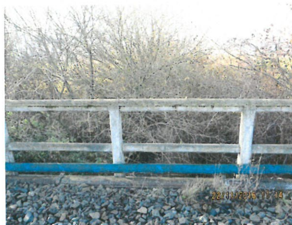
4. Vedere spre amonte
