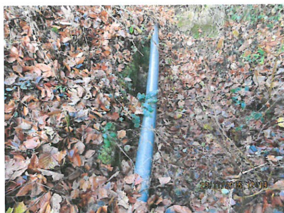
5. Vedere cameră de cădere amonte
