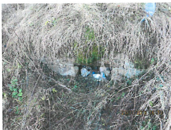
5. Vedere timpan amonte
