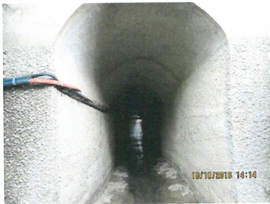
9. Vedere elevație aval
