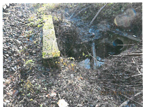
11. Acoperire cu vegetație a timpanului aval
