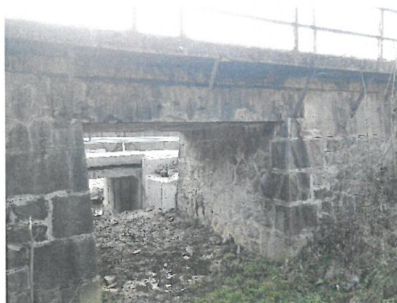
5. Vedere podeț amonte.
