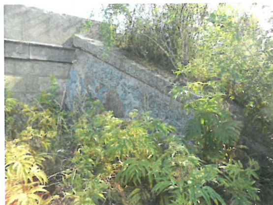
9. Vedere aripă aval
