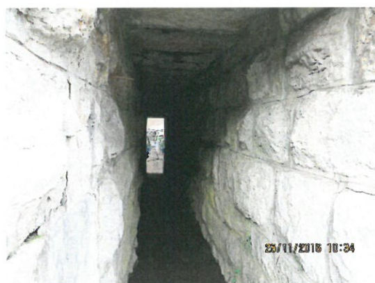
11. Vedere interior podeț de moloane.
