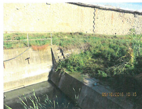
6. Vedere scară de acces amonte
