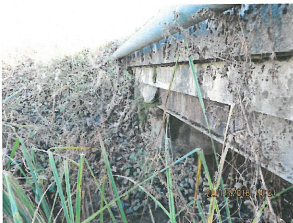
7. Vedere culee stânga din amonte
