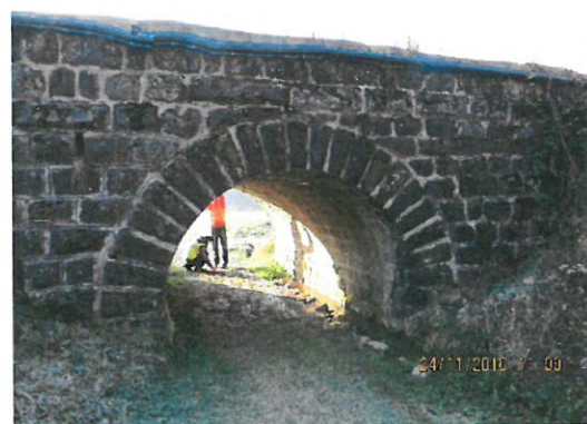
6. Vedere podeț amonte.
