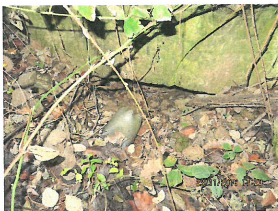
5. Vedere dală de piatră dinspre amonte
