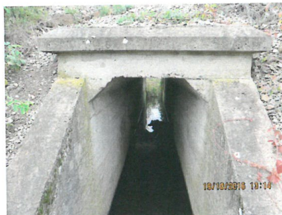
4. Vedere elevație amonte
