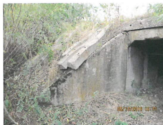
6. Vedere aripă amonte
