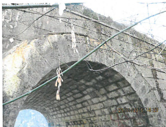
8. Vedere boltă dinspre amonte
