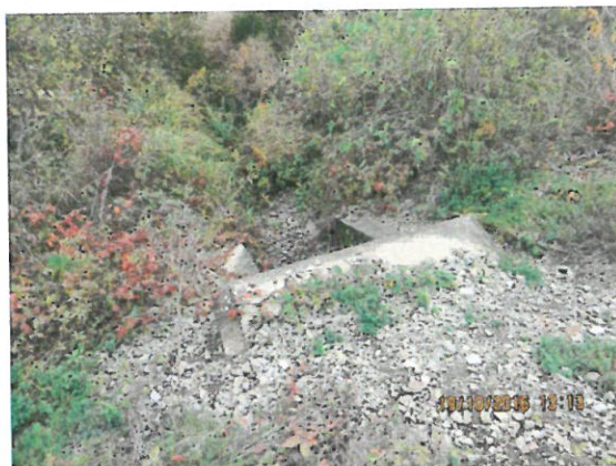
3. Vedere timpan amonte
