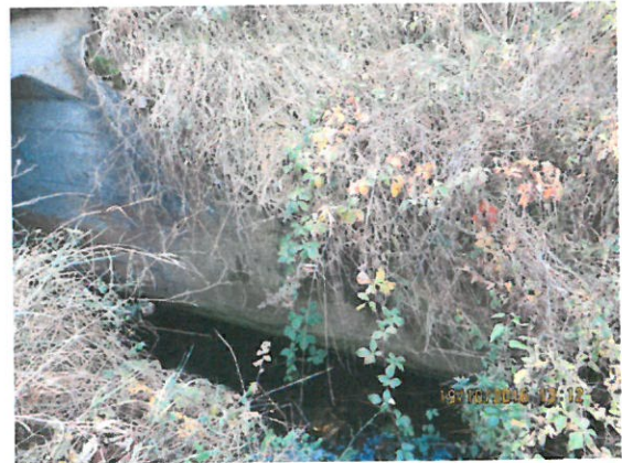
10. Vedere aripă prefabricată aval
