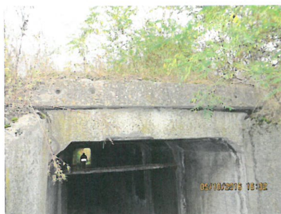
5. Vedere timpan amonte
