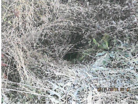
7. Vedere podeț aval.
