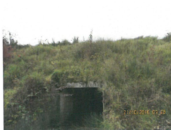
6. Vedere timpan amonte
