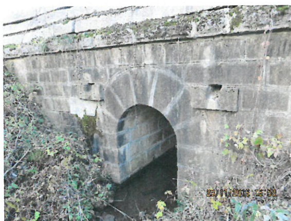
11.Vedere timpan aval
