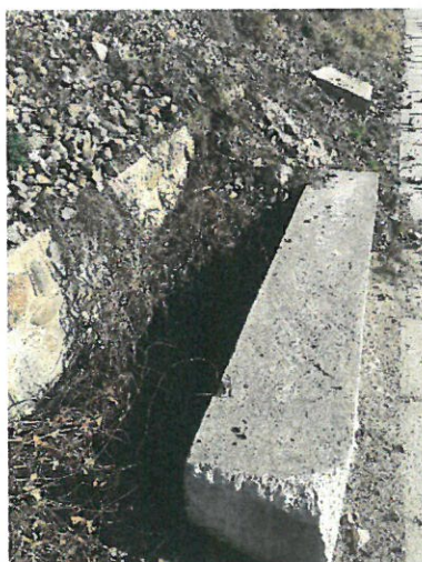
11. Vedere podeț aval.
