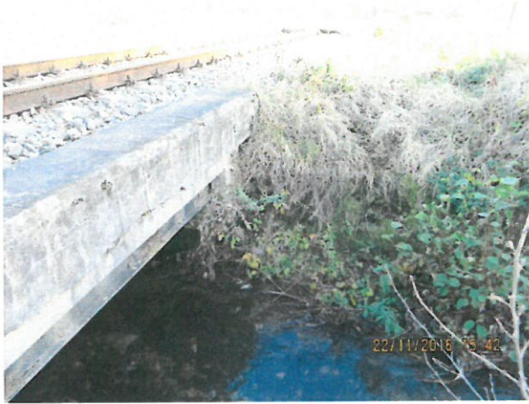
7. Racordare terasament la podeț, din amonte
