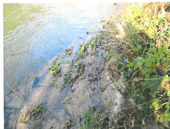
12. Pereu de piatră în zona emisarului
