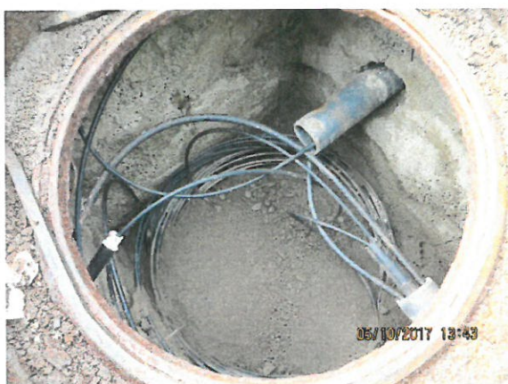
7. Pozare cabluri în cămin amonte
