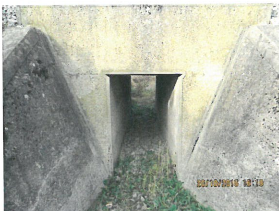
7. Vedere elevație aval
