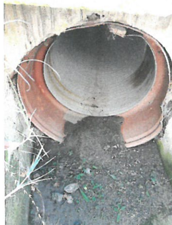
14. Vedere podeț de șosea în prelungire podețului C.F.
