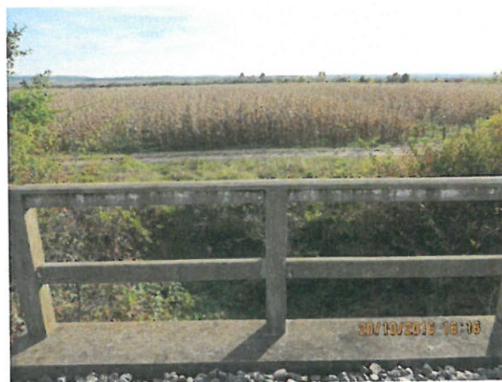
2. Vedere spre amonte
