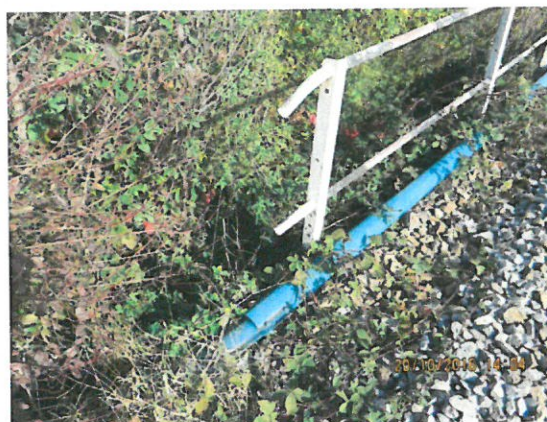
4. Vedere timpan, parapet metalic și cabluri amonte
