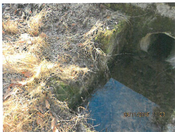
9. Vedere cameră de cădere amonte
