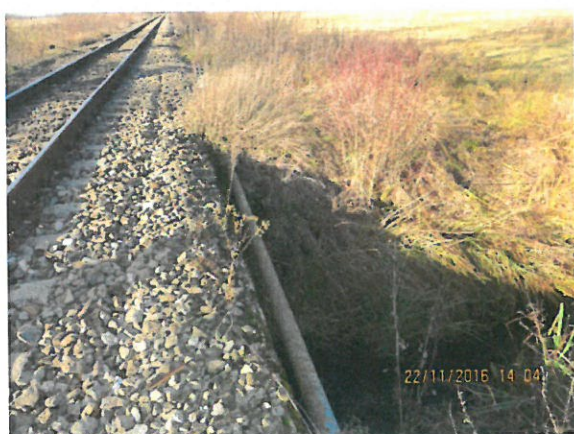
5. Vedere timpan amonte
