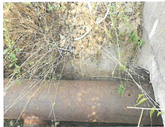
6. Vedere aripă amonte
