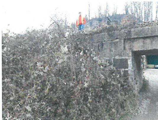
9. Vedere sfert de con aval culee Oradea..
