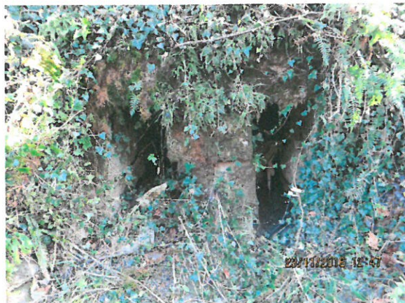
1. Vedere timpan aval
