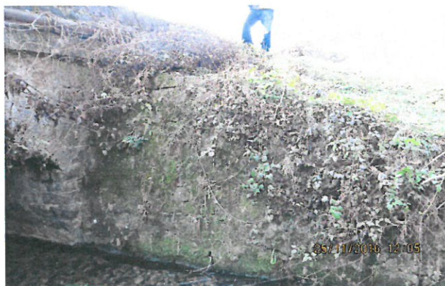
5.Vedere aripa amonte
