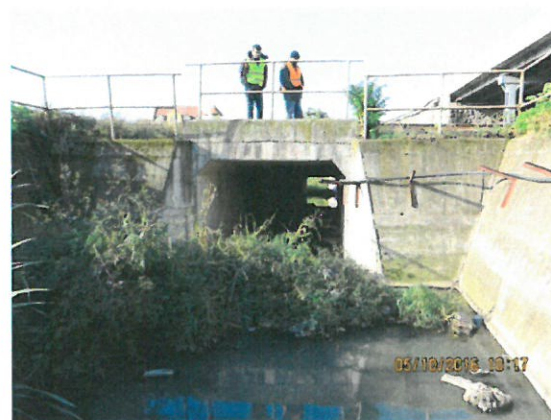
4. Vedere elevație amonte
