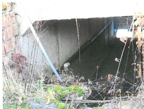
12. Vedere aripă din zidărie de cărămidă
