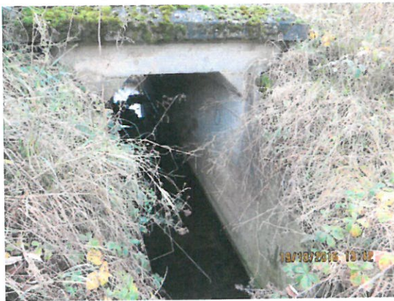
9. Vedere elevație aval
