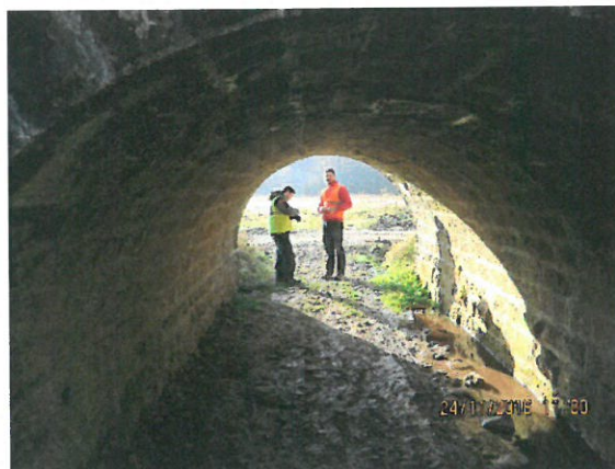
8. Vedere interior podeț.
