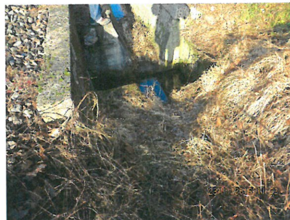
4. Colmatare cu vegetație șanțuri amonte
