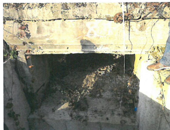
10. Vedere podeț aval.
