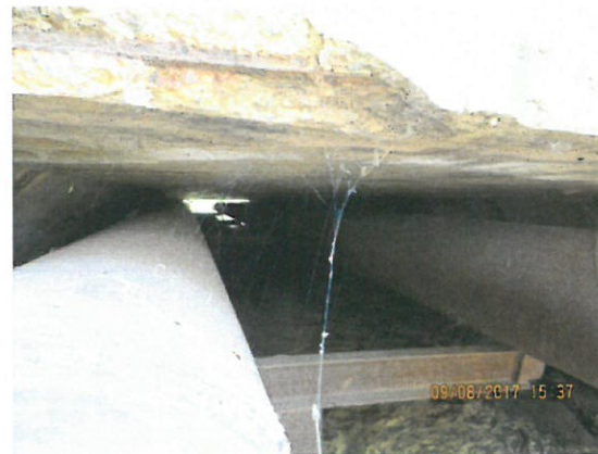
12. Vedere interior podeț dinspre aval
