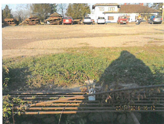
11. Vedere amonte dinspre cămin aval
