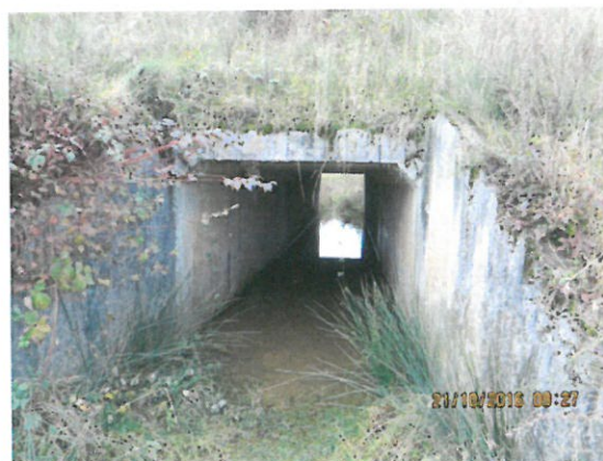
4. Vedere elevație amonte
