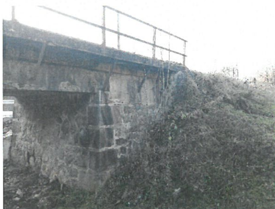
7. Racordarea cu terasamentul amonte, culee Oradea.
