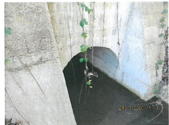
6. Vedere podeț amonte.
