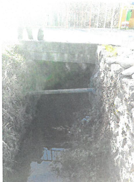
8. Vedere albie aval si podeț de șosea.
