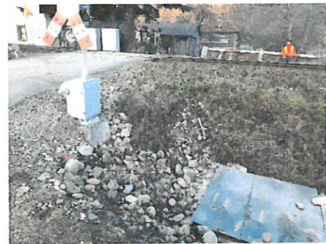
8. Vedere trecere de nivel din aval.
