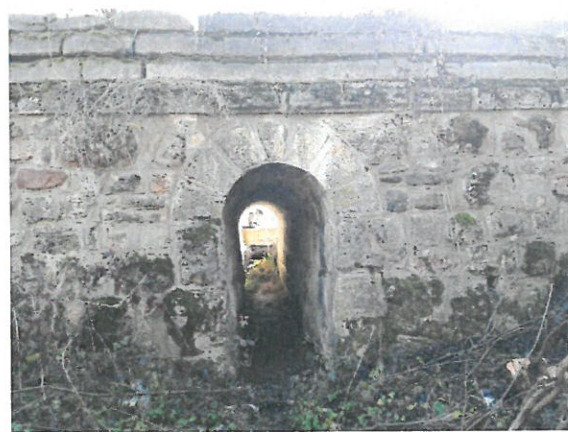
5. Vedere podeț amonte .
