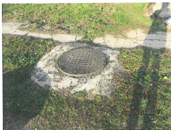
5. Vedere cămin amonte
