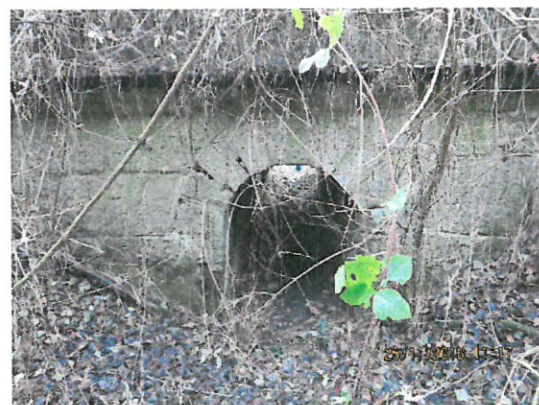
5. Vedere podet amonte.
