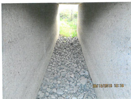
5. Vedere interior podet dinspre amonte
