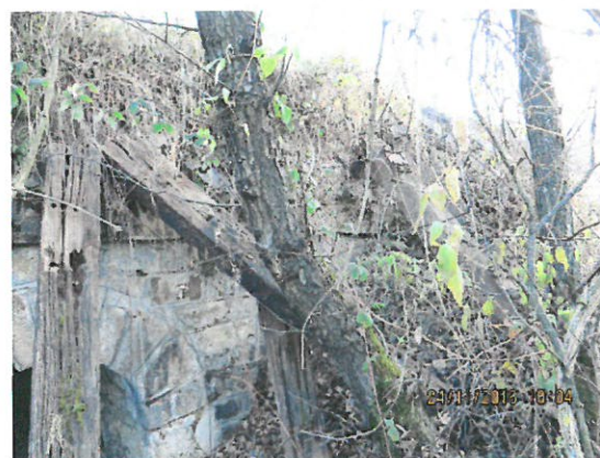
6. Vedere racordare cu terasamentul stânga aval
