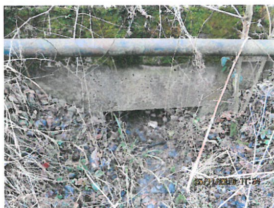
5. Vedere podet aval.
