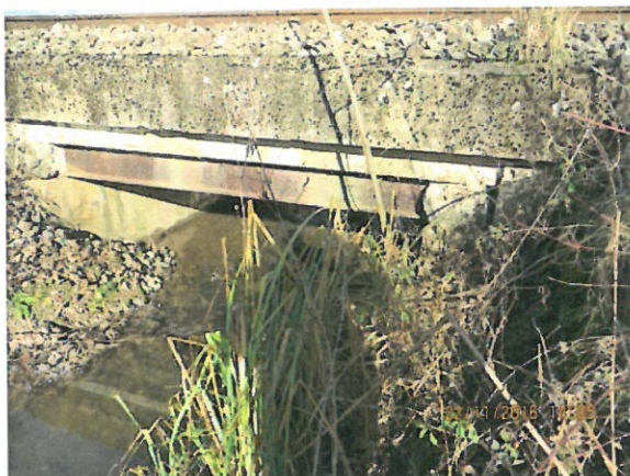
9. Vedere din aval spre podeț
