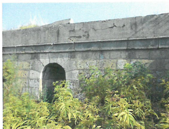
8. Vedere elevație aval
