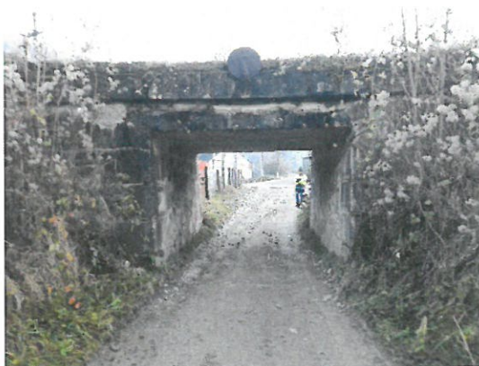
5. Vedere podet amonte.
