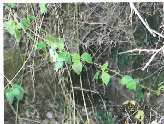
4. Vedere podet aval
