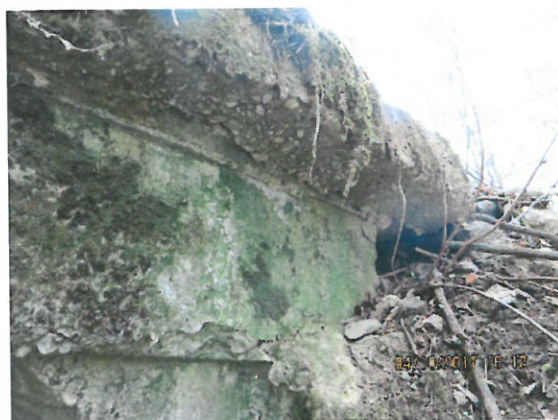
9. Vedere timpan aval
