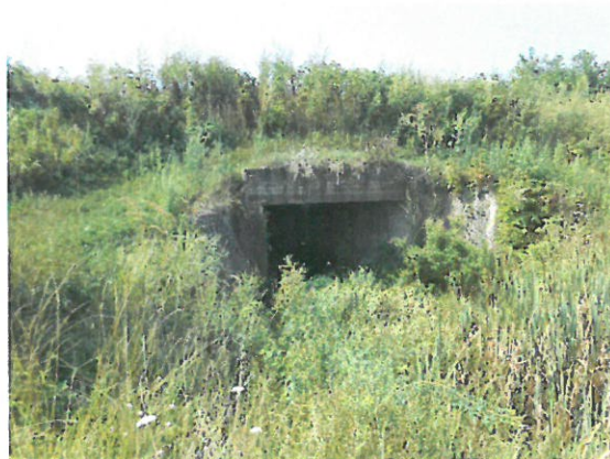
3. Vedere elevație aval
