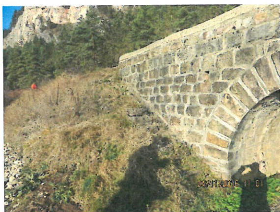
9. Racordare cu terasamentul aval.
