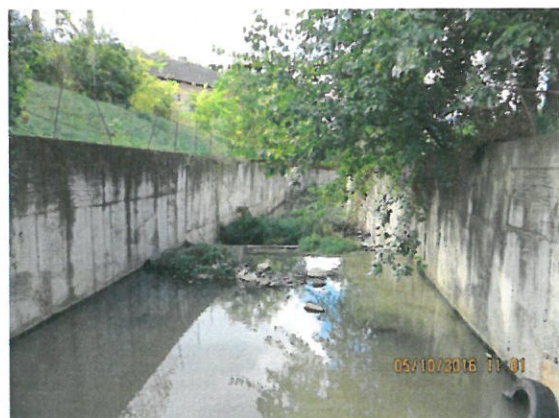
11. Vedere canal de scurgere aval
