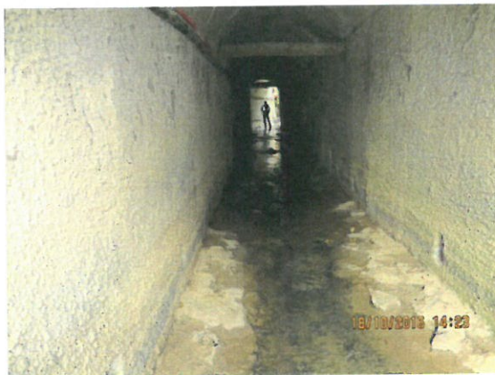
11. Vedere interior podeț dinspre aval
