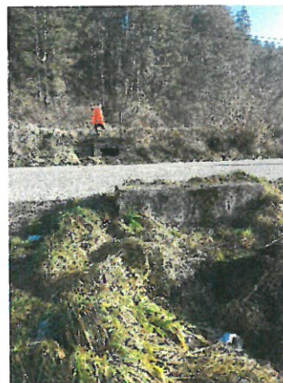
10. Vedere podeț șosea aval.
