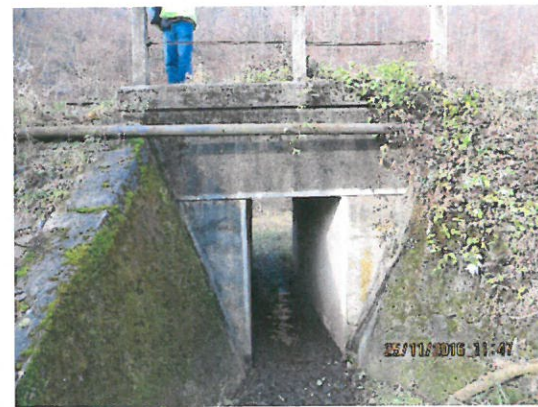
4. Vedere aripi și podeț aval.
