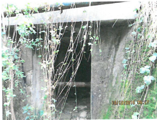
9. Vedere elevație aval
