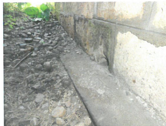
10. Vedere interior podeț dinspre aval
