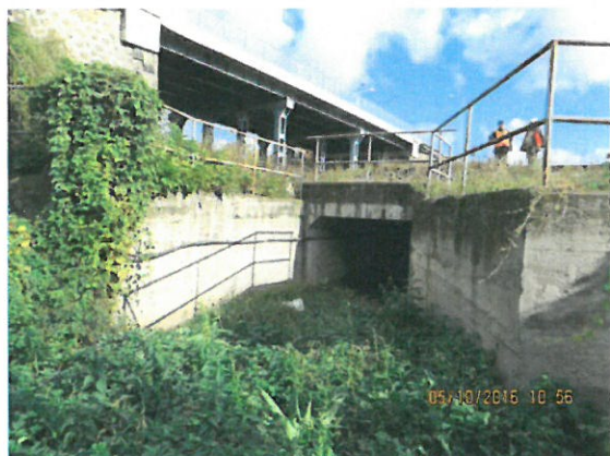
9. Vedere cabluri suspendate aval
