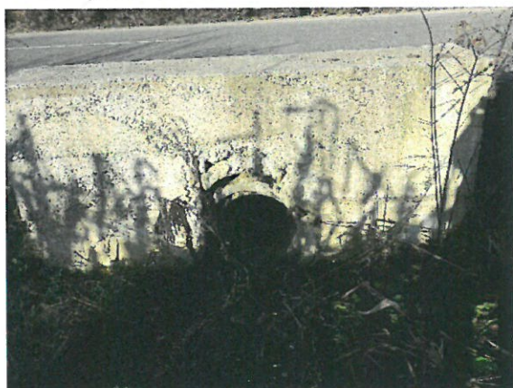
9. Vedere podeț de șosea în aval de drum .
