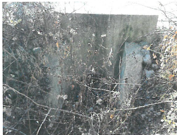
8. Vedere podeț de sosea.
