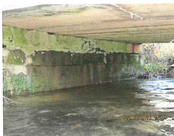
6. Detaliu intrados podet din amonte
