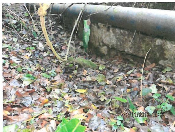
3. Vedere timpan amonte
