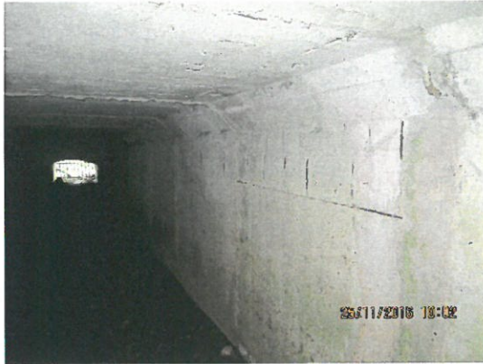
7. Vedere interior podeț prefabricat.
