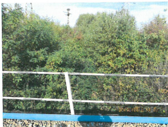
3. Vedere albie amonte
