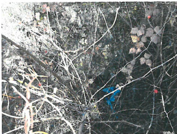
7. Vedere podeț aval.
