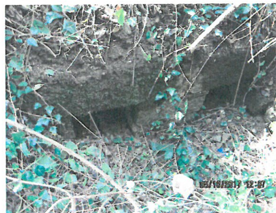
4. Vedere timpan amonte
