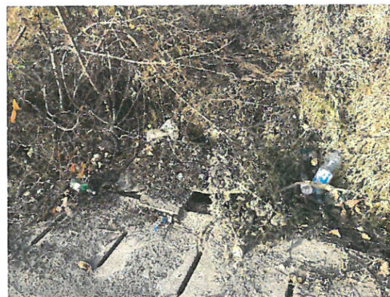
10. Vedere rigolă carosabilă.
