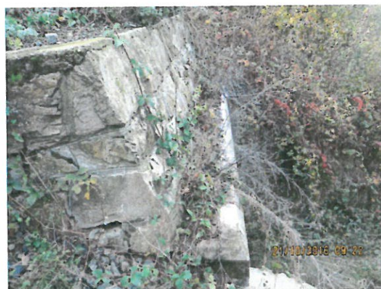
9. Vedere timpan aval
