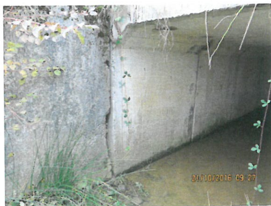
5. Vedere rost aripă stânga amonte
