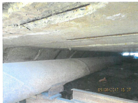
11. Vedere interior podeț dinspre aval
