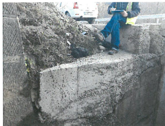
10. Vedere sfert de con aval culee Cluj.
