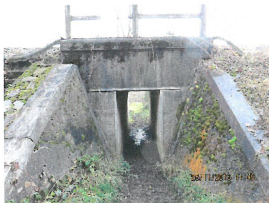
3. Vedere aripi și podeț amonte.
