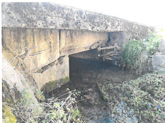
5. Vedere podeț amonte.
