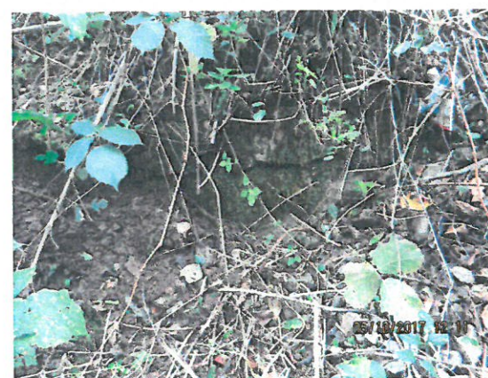
6. Vedere timpan aval
