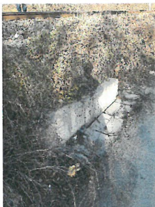
9. Vedere podet aval .
