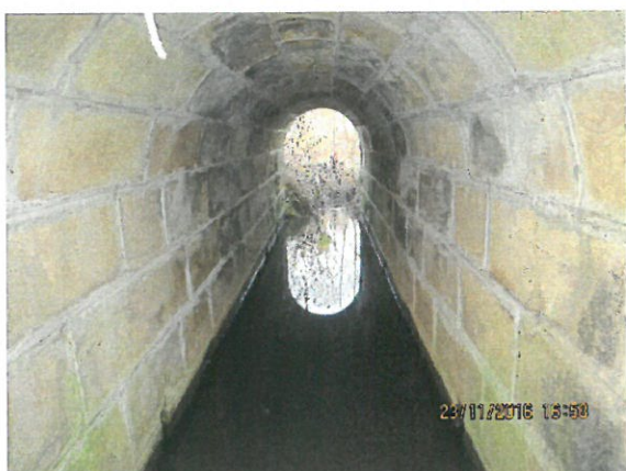
7.Vedere intrados dinspre aval
