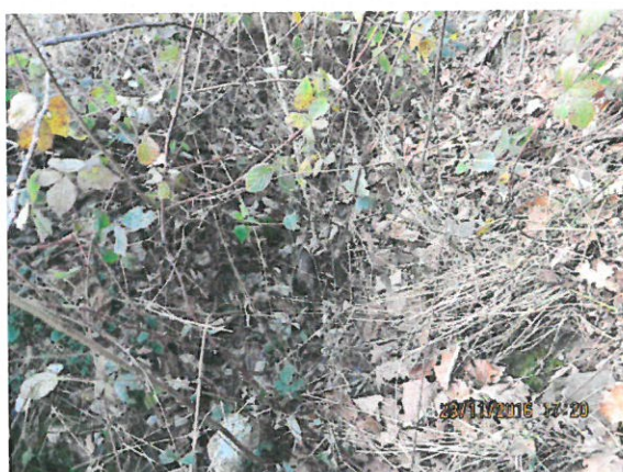
11. Vedere șanț amonte
