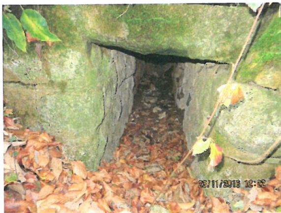
9. Colmatare a intradosului podețului în amonte
