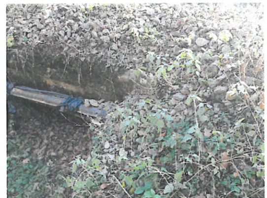
6. Racordarea cu terasamentul amonte, culee Oradea.
