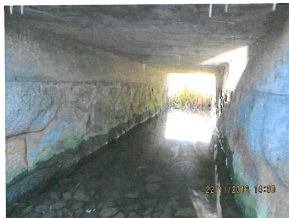
10. Vedere interior podeț din amonte
