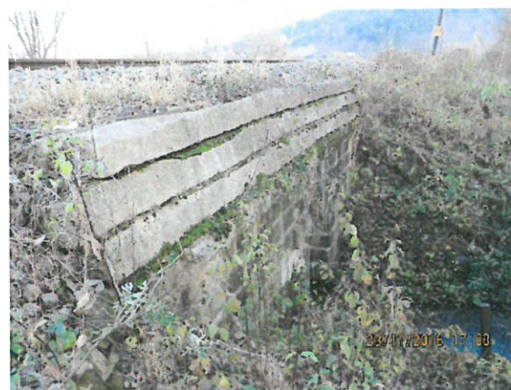
10. Vedere supraînălțare timpan aval cu traverse
