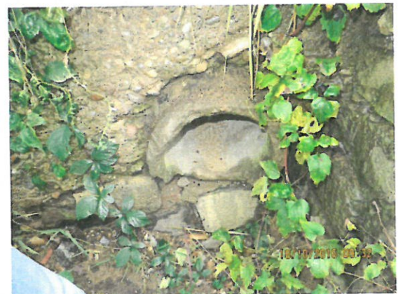
6. Vedere conductă sub drumul din amonte
