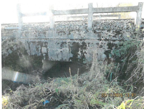
7. Vedere spre podeț din aval
