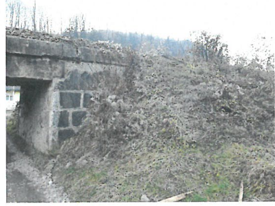
8. Vedere sfert de con aval culee Cluj.
