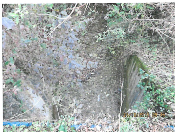
11. Vedere din aval spre podeț
