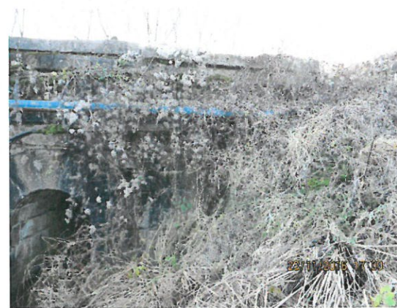
6. Vedere sfert de con colmatat dreapta amonte
