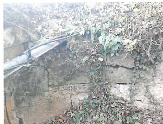
6. Racordarea cu terasamentul amonte, culee Oradea.
