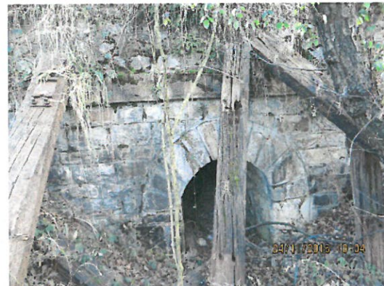
4.Vedere timpan aval
