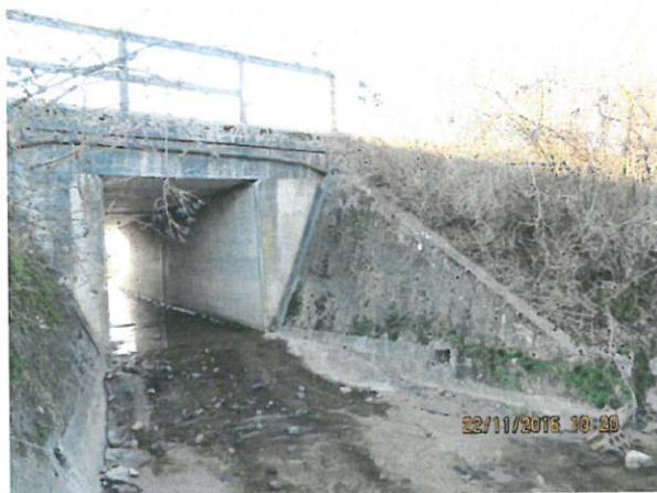
7. Vedere din aval spre podeț
