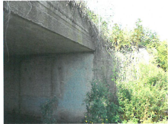
4. Vedere elevație aval
