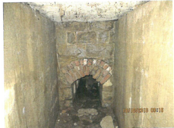
10. Vedere interior podeț dinspre aval
