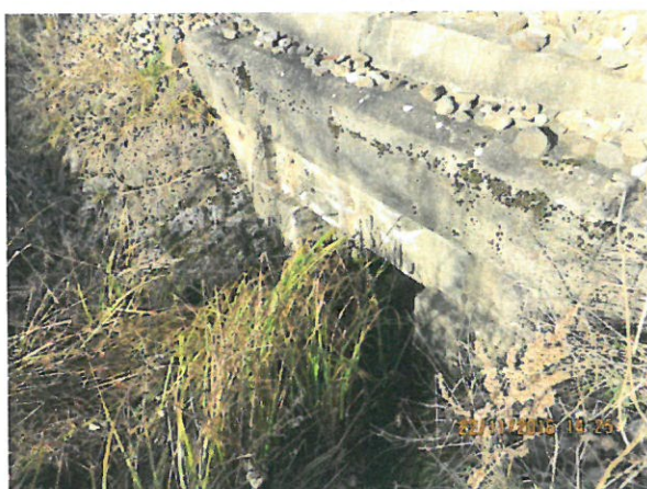
5. Vedere spre podeț din aval
