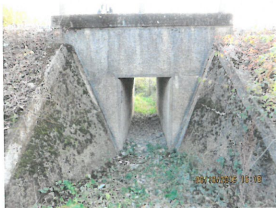
3. Vedere elevație amonte
