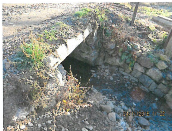
10. Vedere podeț șosea și albie aval.
