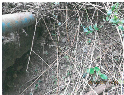
6. Racordarea cu terasamentul amonte, culee Oradea.
