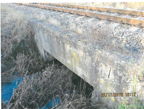
5. Vedere din amonte spre podeț
