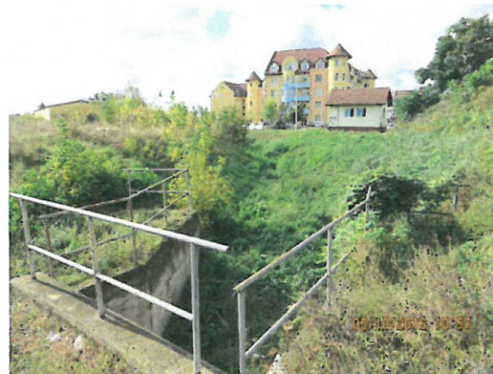
10. Vedere timpan și parapet aval
