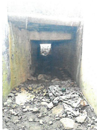
8. Vedere podeț de sosea în aval de podețul de CF.
