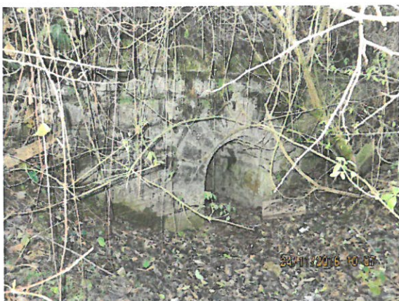
7. Vedere timpan amonte
