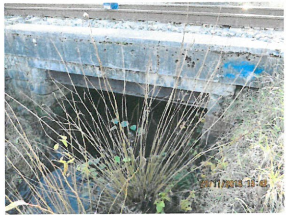
8. Vedere din aval spre podeț
