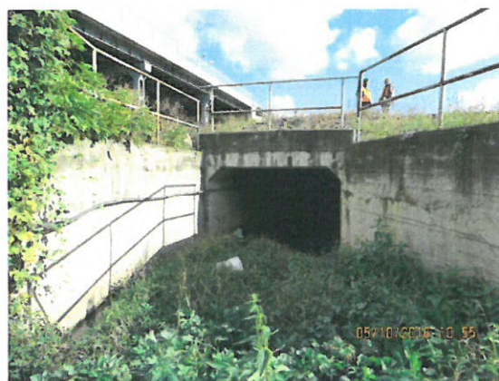
8. Vedere elevație aval
