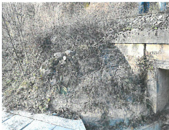
10. Vedere sfert de con aval culee Oradea.
