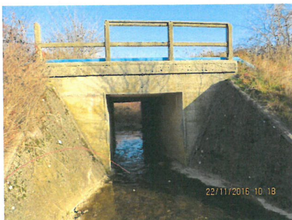
5. Vedere din amonte spre podet
