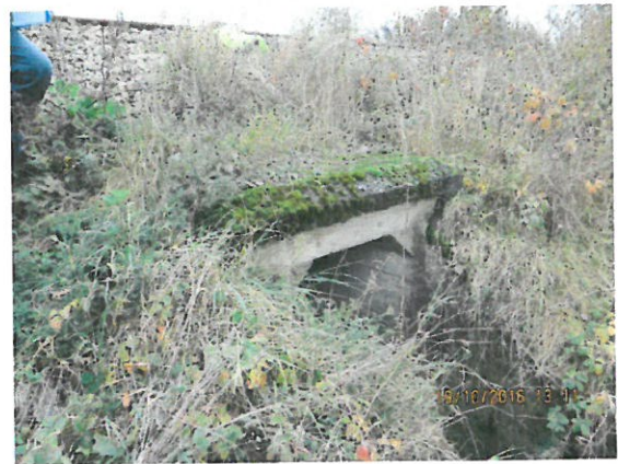
8. Vedere timpan aval
