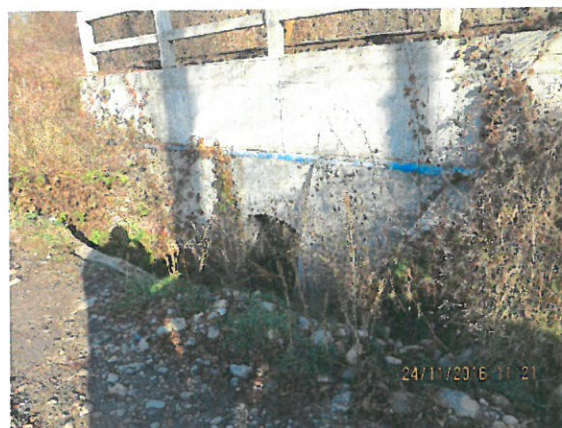
8. Vedere podeț aval.
