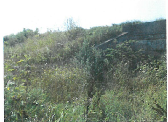
4. Vedere aripă amonte
