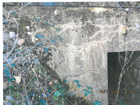
6. Vedere racordare amonte .
