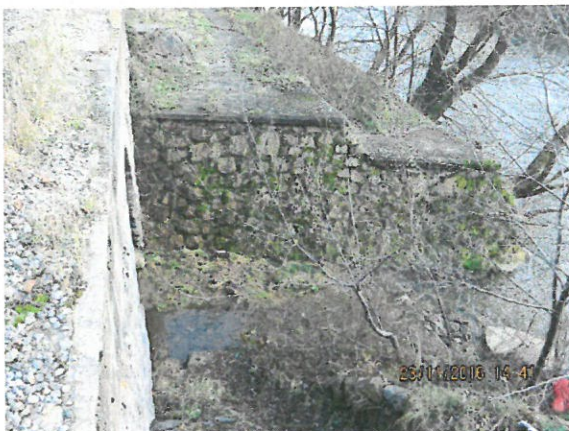
7. Vedere zid de sprijin stânga aval
