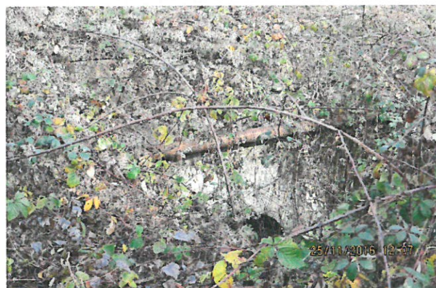
8.Vedere podeț aval, conductă.
