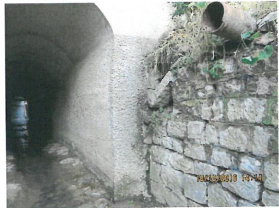
10. Vedere zid de sprijin aval
