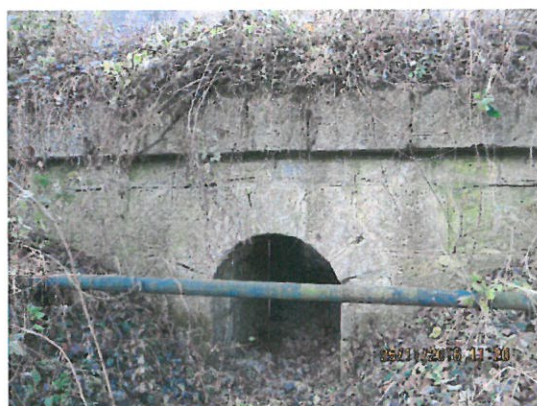
9. Vedere podeț aval.
