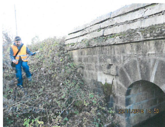
12. Vedere sfert de con colmatat dreapta aval
