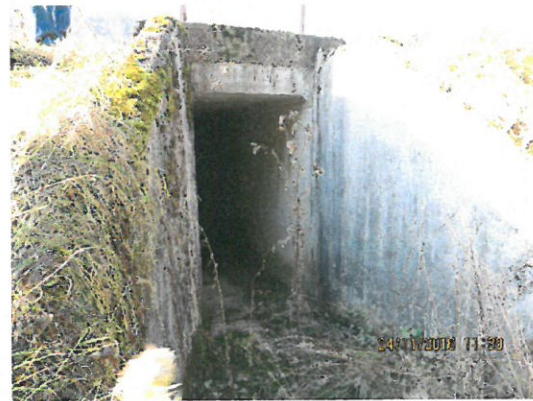
6. Vedere podeț amonte.
