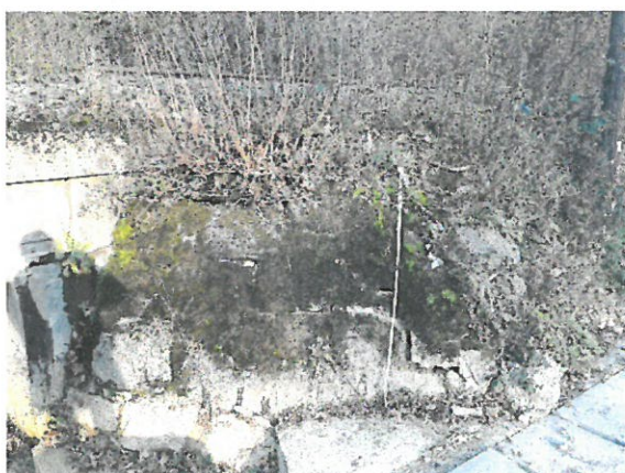
11. Vedere sfert de con aval culee Cluj.
