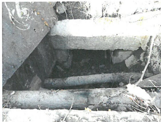
8. Vedere podeț aval.
