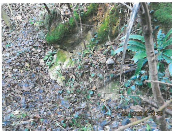
9. Vedere zid de sprijin din moloane de piatră dislocate
