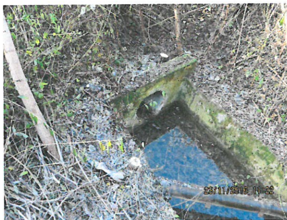
8. Vedere timpan podeț învecinat aval
