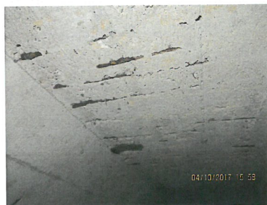
6. Vedere armături descoperite cadru prefabricat
