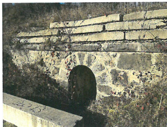
12. Vedere aval podeț.
