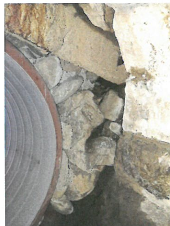
10. Vedere rost între podețe.
