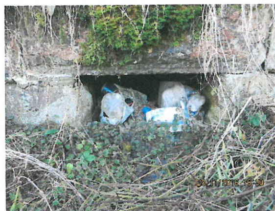
6. Colmatare cu deșeuri
