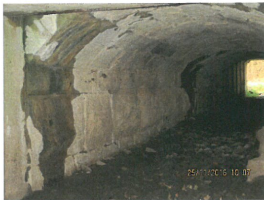
9. Vedere interior podeț din zidarie de piatră.
