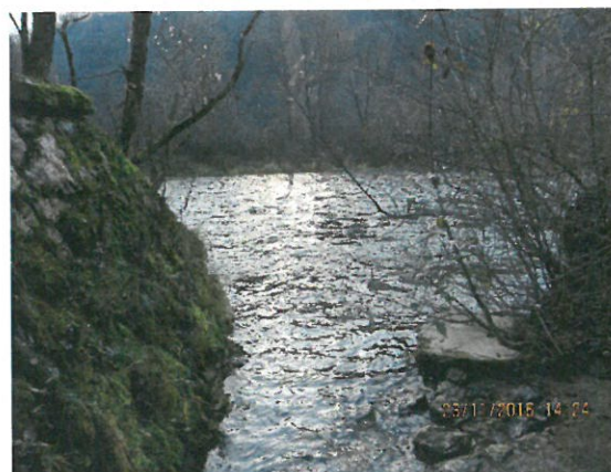
4. Vedere emisar aval
