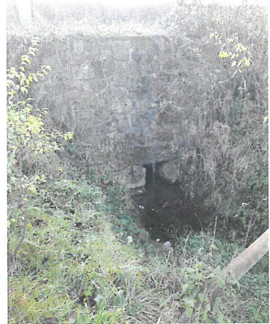
6. Vedere podeț amonte și racordarea cu terasamentul.
