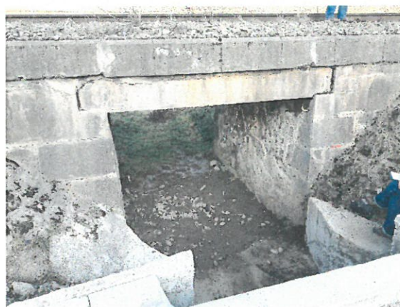
8. Vedere podeț aval.
