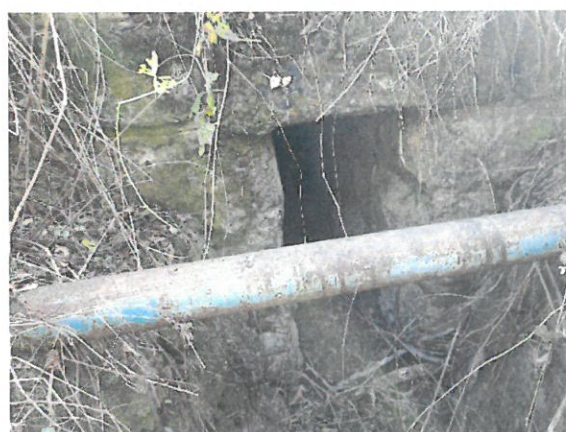
5. Vedere racordare cu terasamentul podeț amonte .
