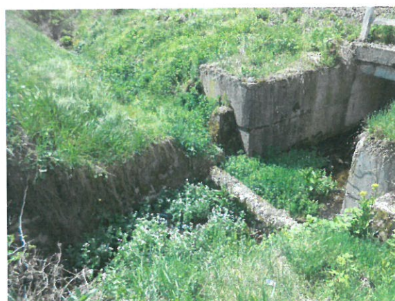
6. Vedere albie amonte, conducte
