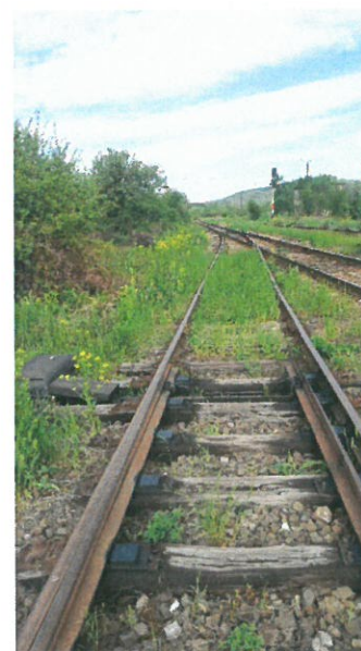
3. Șina și prinderea șinei de traverse, pe Firul 3
