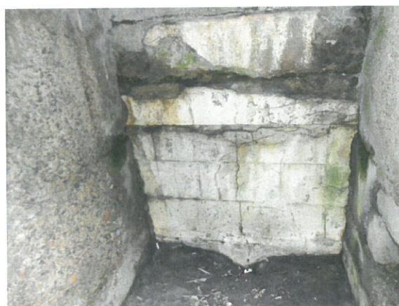
6. Vedere spre podetul dezafectat de pe DN1 (închis/zidit)
