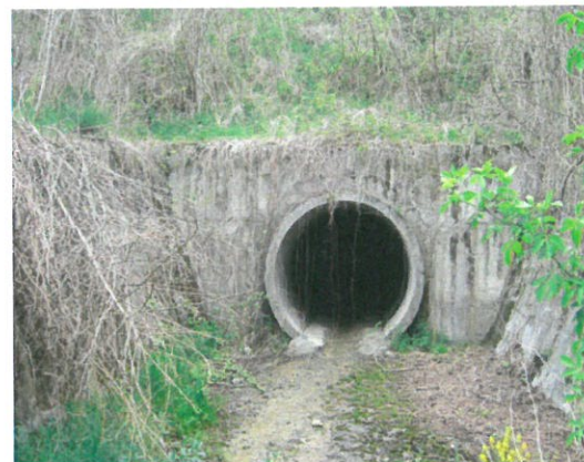
10. Vedere podeț tubular din aval
