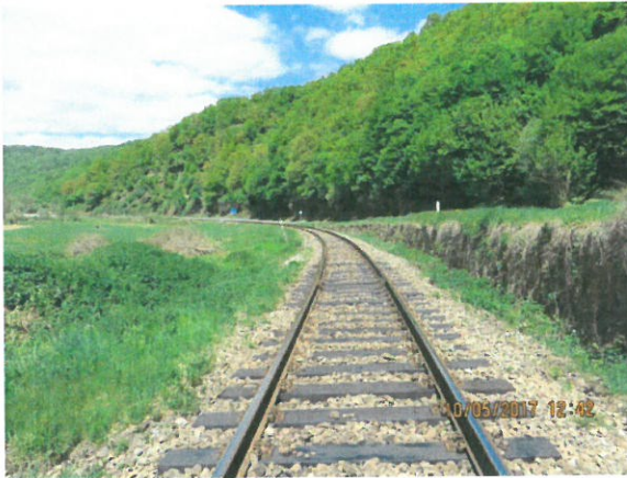
1. Șina și prinderea acesteia de traverse (vedere spre Oradea)
