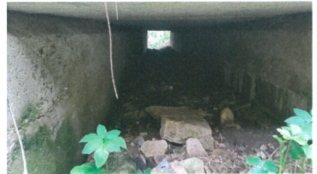
9.Vedere intrados podeț dinspre aval
