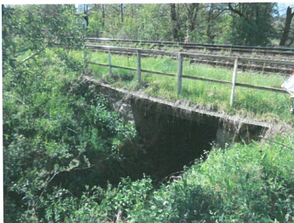
5. Vedere spre podet din amonte
