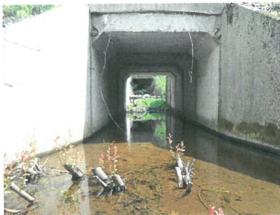
8. Vedere podeț interior – dinspre aval
