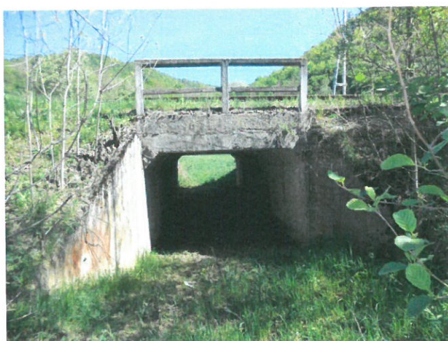
11. Vedere spre podeț din aval
