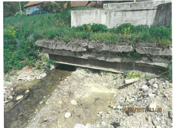
4. Vedere podet, din aval
