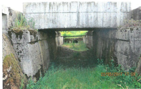
4.Vedere elevație amonte
