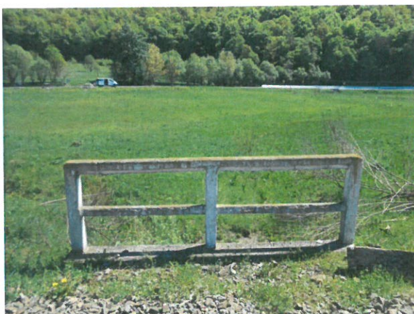
3. Vedere spre podețul de șosea din amonte
