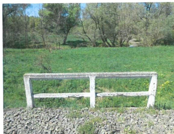
4. Vedere abie aval
