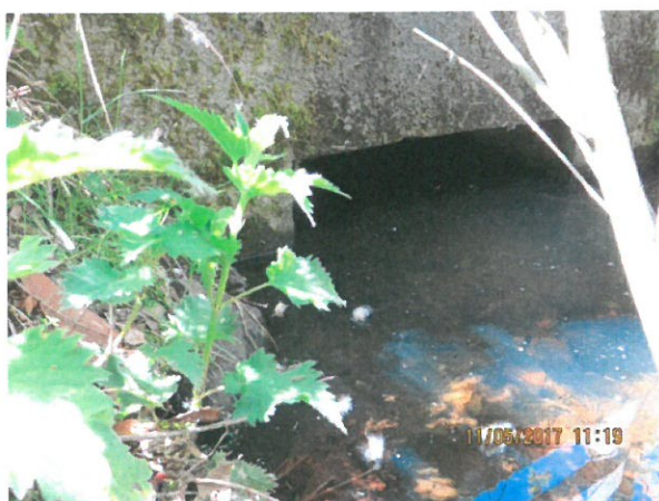
5. Vedere din amonte spre podeț
