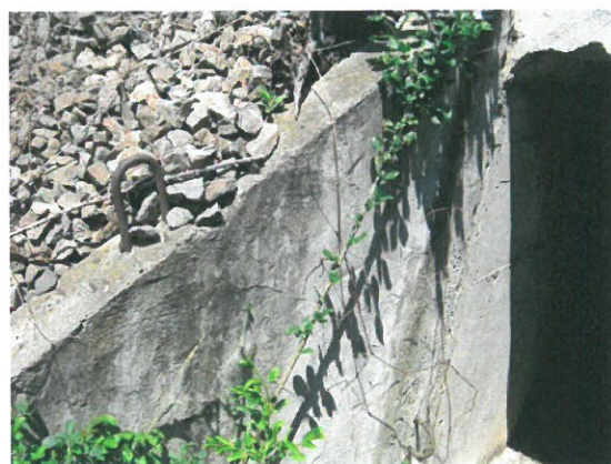
5.Vedere aripă aval
