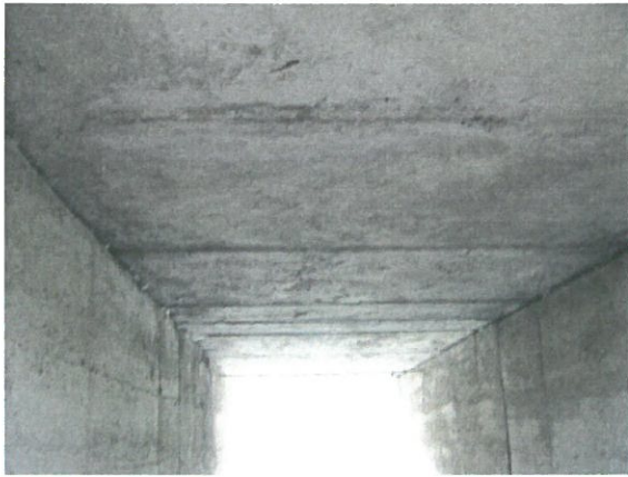
7. Vedere intrados dinspre aval
