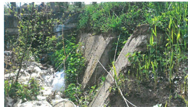
9. Vedere zid de sprijin stânga aval
