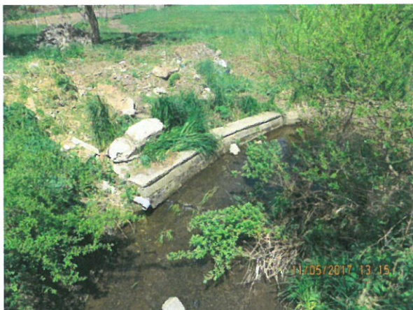
3. Vedere albie amonte
