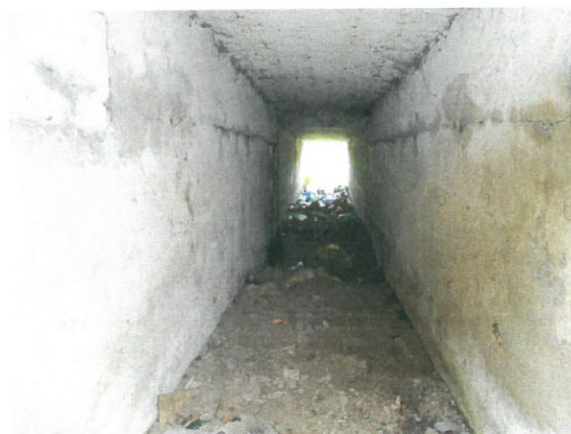
6. Vedere interior podet (dinspre amonte)
