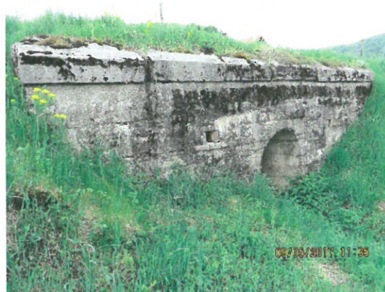
2. Vedere tronson podeț boltit
