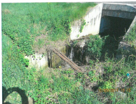
10. Vedere asupra camerei de cădere din amonte
