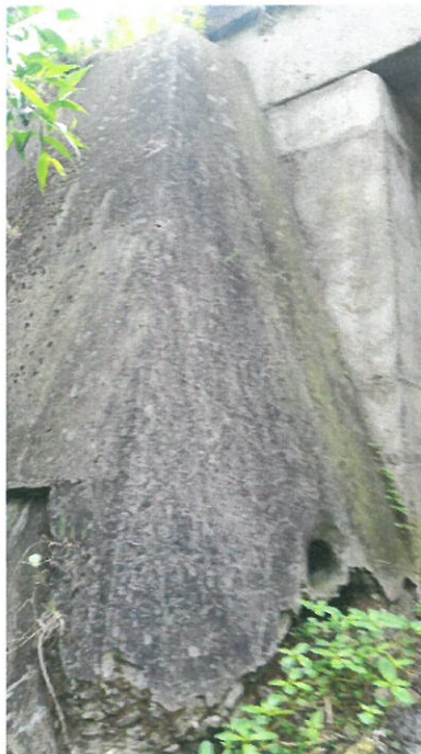
8.Vedere zid de sprijin dreapta aval
