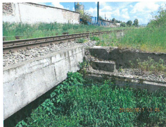
4.Vedere timpan și culee fir III amonte
