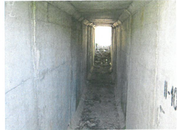
10. Vedere intrados podeț
