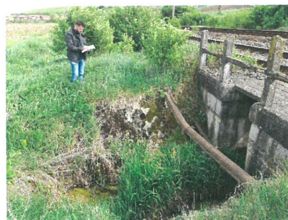
6. Zid de sprijin dreapta aval acoperit cu vegetație
