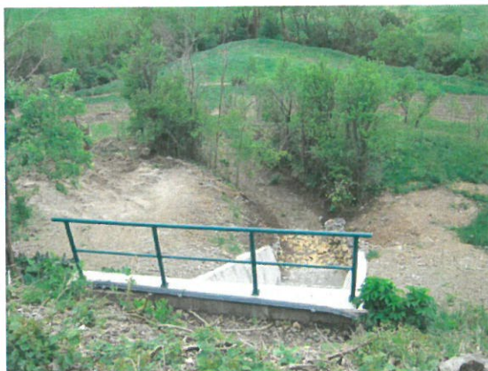
9. Vedere timpan aval
