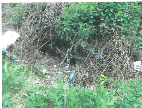
2. Vedere podet, din amonte
