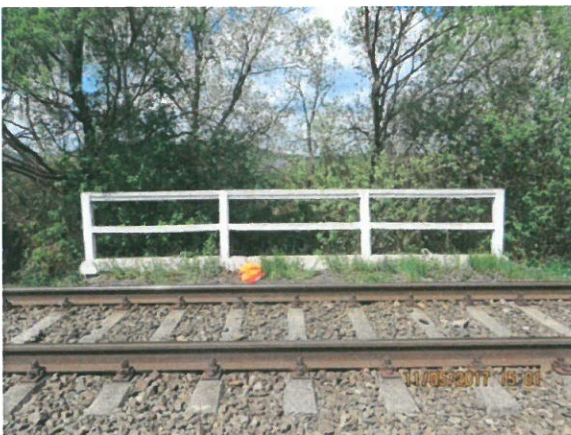
3. Vedere spre amonte
