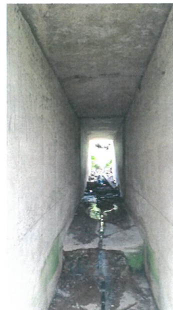
9.Degradări ale suprafeței betonului zidului de sprijin fir I, culee Baciu Triaj
