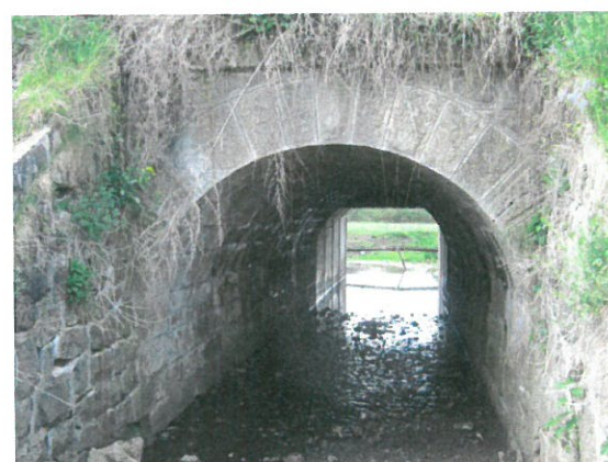
5.Vedere elevație amonte
