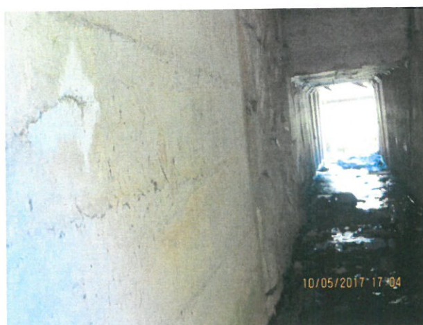
8. Interior podeț vedere vedere spre aval
