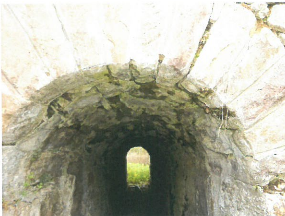
5. Vedere boltă (dinspre amonte)
