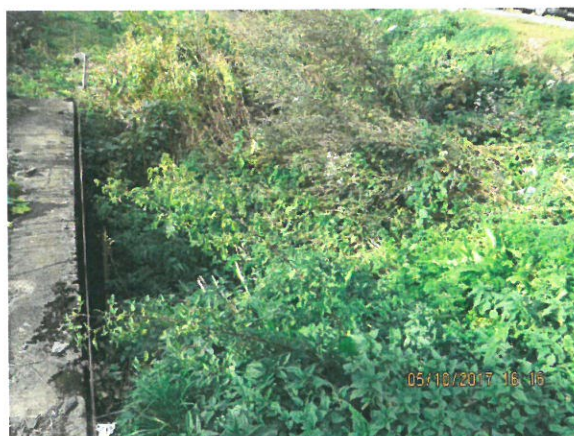
5. Vedere racordare cu terasamentul (dinspre amonte) – spre Oradea
