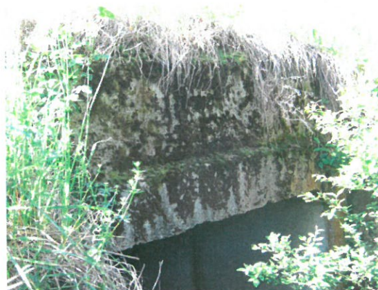
4. Vedere timpan amonte
