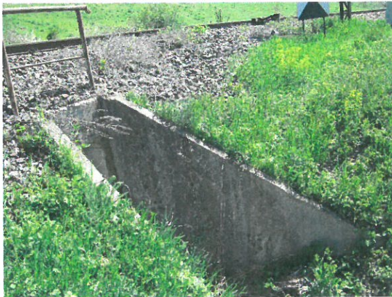
7. Vedere aripă stânga aval
