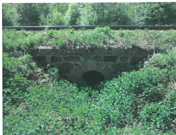
2. Vedere podet, din amonte
