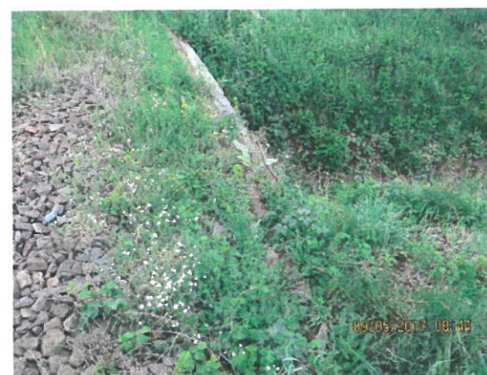
6. Vedere racordare cu terasamentul
