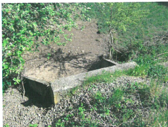
3. Vedere timpan amonte
