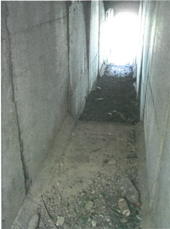
7. Vedere intrados dinspre amonte
