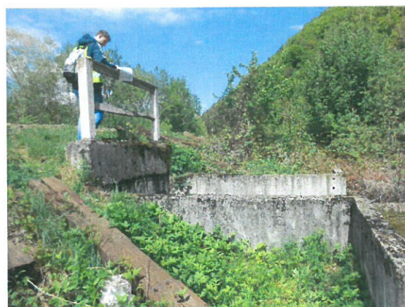
5. Vedere racordare cu terasamentul (dinspre amonte) – spre Oradea
