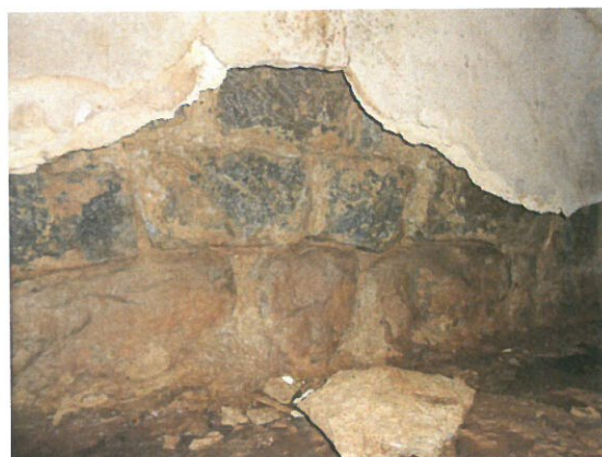
8. Vedere podeț amonte
