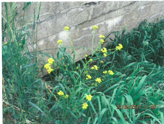
9. Vedere intrare în podeț obturată cu vegetație aval
