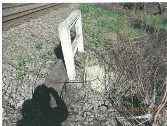
5. Vedere spre podet din amonte
