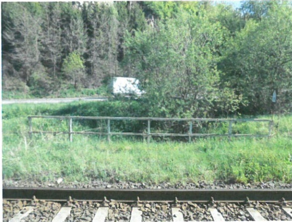
3. Vedere spre amonte
