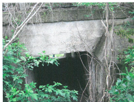
5. Vedere timpan amonte
