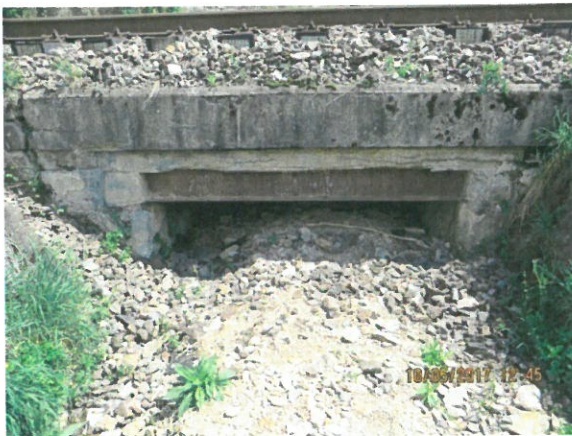
3. Vedere podet, din aval
