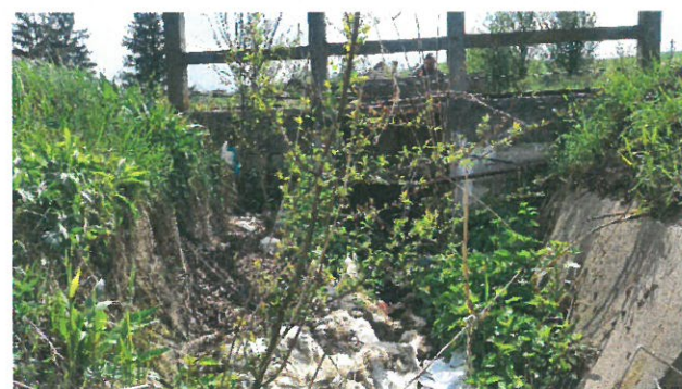
10. Colmatare albie aval
