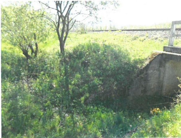
7. Aripă stânga din amonte
