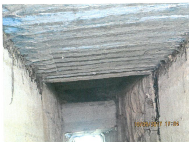
9. Intrados podeț spre aval
