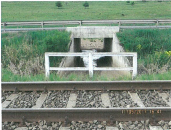
3. Vedere spre podețul de șosea din amonte
