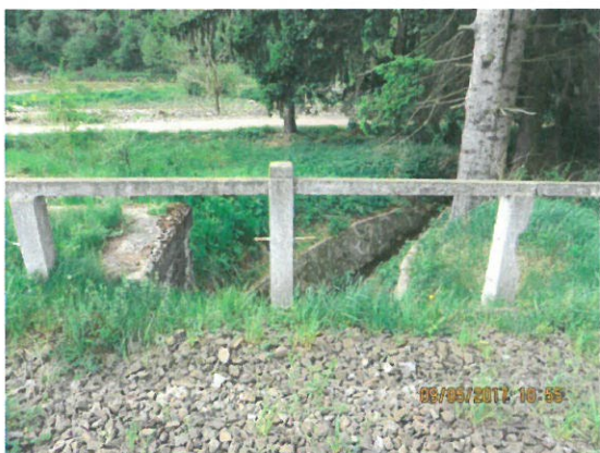
3. Vedere parapet din beton
