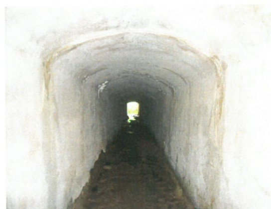
9. Vedere interior podeț
