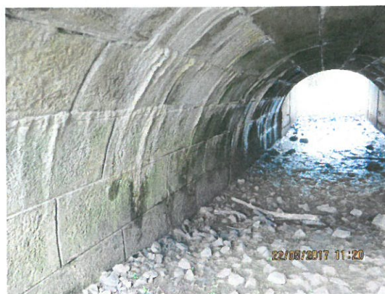
11. Vedere interior podeț boltit
