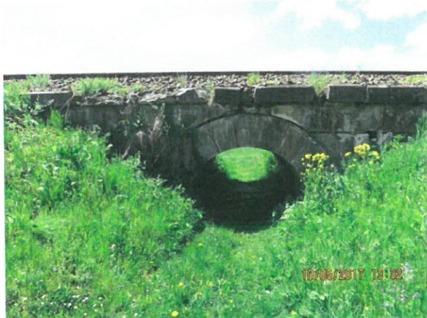
5. Vedere spre podet din amonte – tip B2
