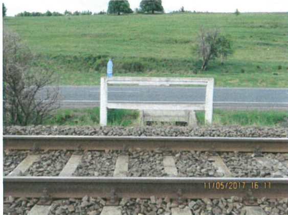
3. Vedere spre amonte
