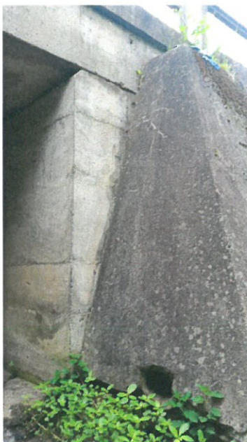
10.Vedere zid de sprijin stânga aval
