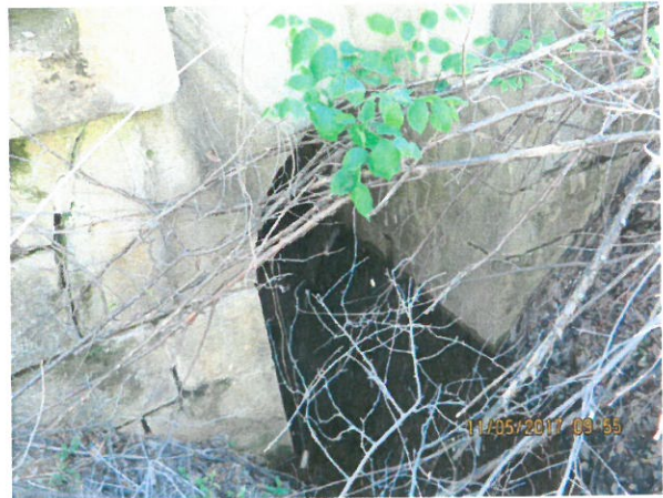
8. Vedere spre podeț din aval
