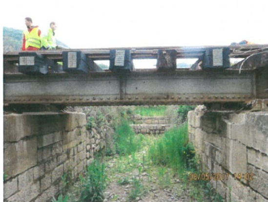
3. Vedere suprastructura GIPCS amonte
