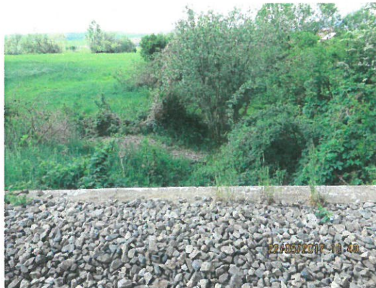
8.Vedere timpan aval
