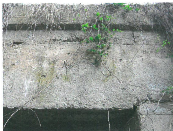
5.Vedere dală marginală amonte
