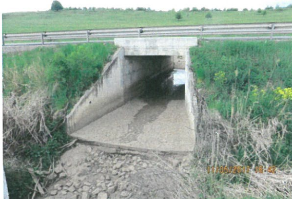
5. Vedere albie amonte
