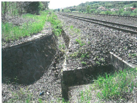
7. Colmatare șanț amonte
