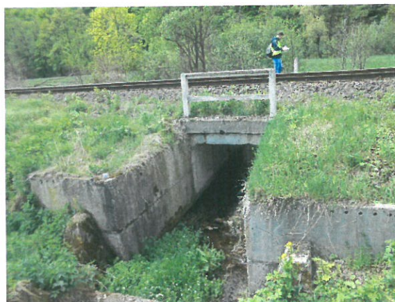
2. Vedere podet, din amonte
