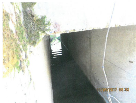
6. Interior podet dinspre amonte – cadru tip C1
