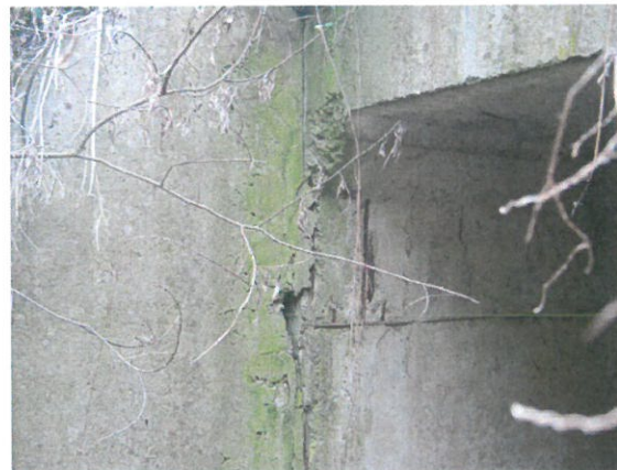
4.Rost aripă dreapta aval – cadru prefabricat
