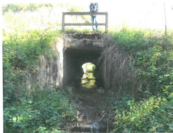
12. Vedere spre podeț din aval
