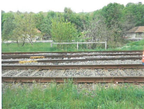
3. Vedere linii pe podet
