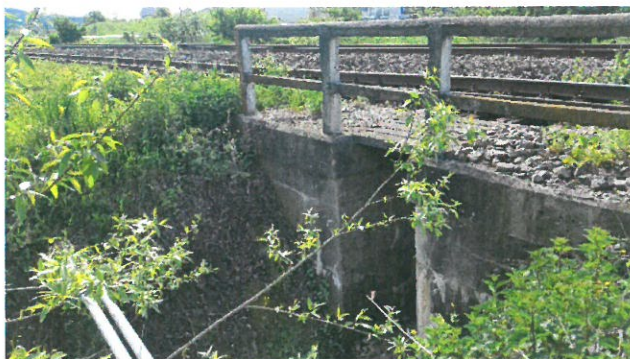
8. Vedere zid de sprijin dreapta aval
