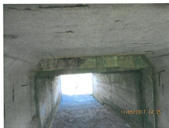
11. Vedere intrados între tronsoane
