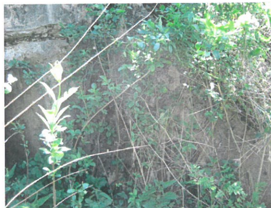
8. Aripa beton amonte
