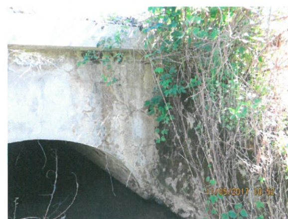
12. Detaliu timpan și aripă podeț din aval
