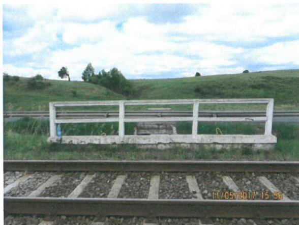
3. Vedere spre amonte
