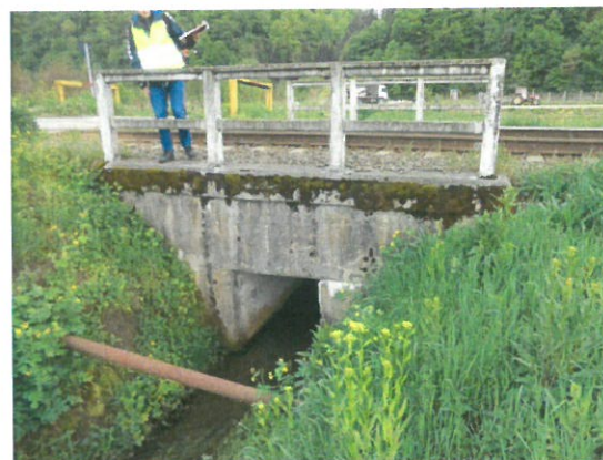
4. Vedere teava metalica
