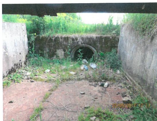
12. Vedere podeț tubular de drum din aval
