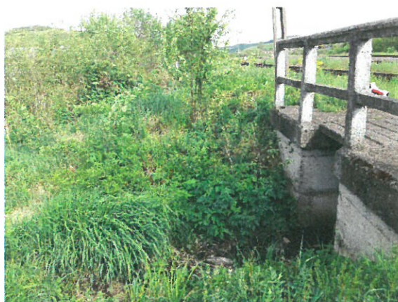
9. Vedere timpan și albie aval
