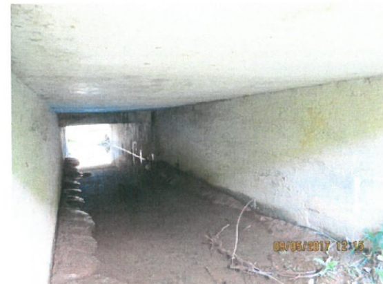
6. Vedere interior podet dinspre aval
