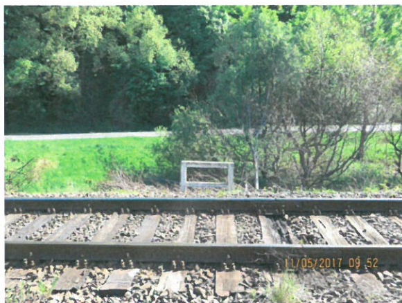
3. Vedere spre amonte
