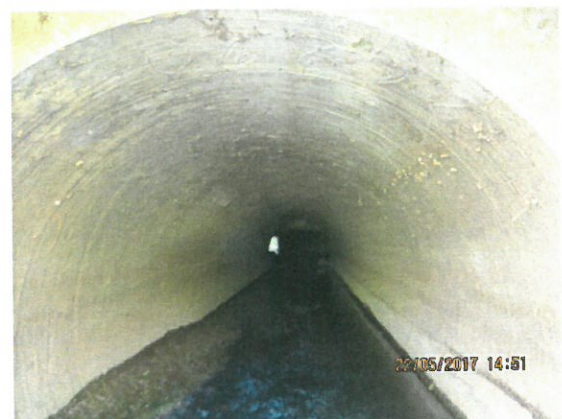
6. Vedere interior podet dinspre amonte
