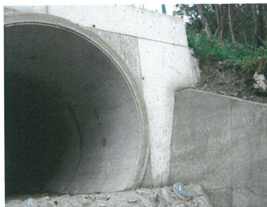
8. Vedere în tubul din beto armat a pereului și a rosturilor
