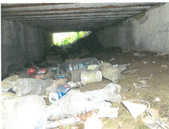
7. Vedere podeț interior – dinspre aval
