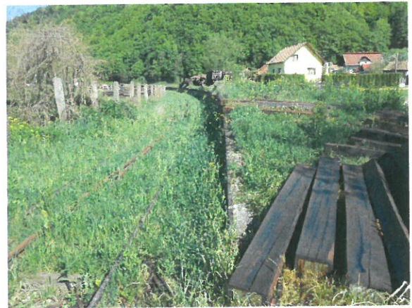
8. Vedere zid de sprijin platformă
