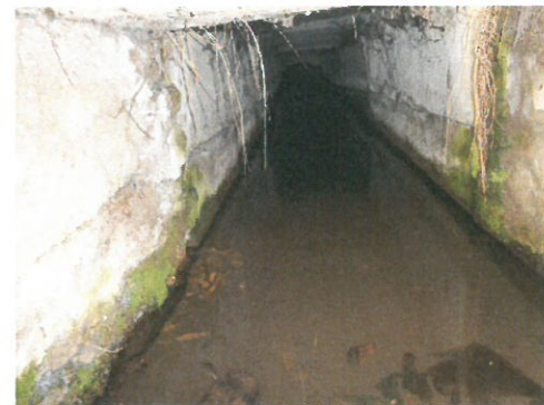
12. Vedere intrados între podețul de pe firul 40 și cel rutier
