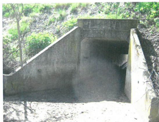
4. Vedere elevație amonte
