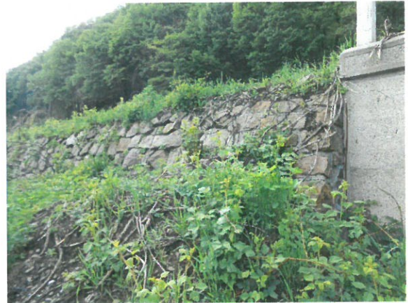
10. Vedere racordare cu terasamentul (dinspre aval) – spre Oradea
