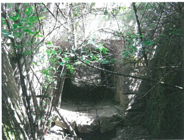
5. Vedere podet amonte
