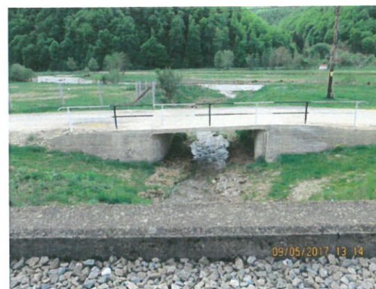
4. Vedere albie aval și podet de drum
