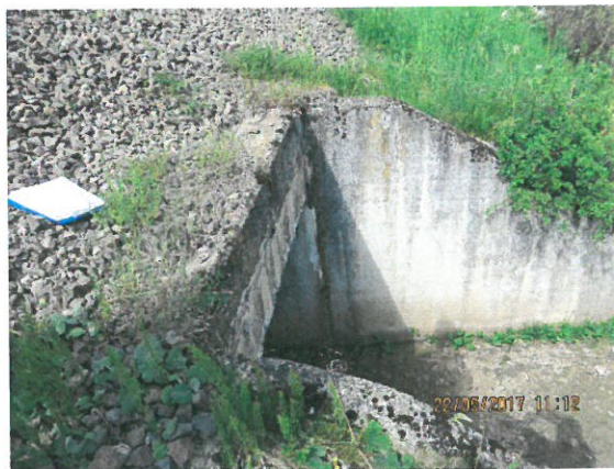
5. Vedere timpan amonte
