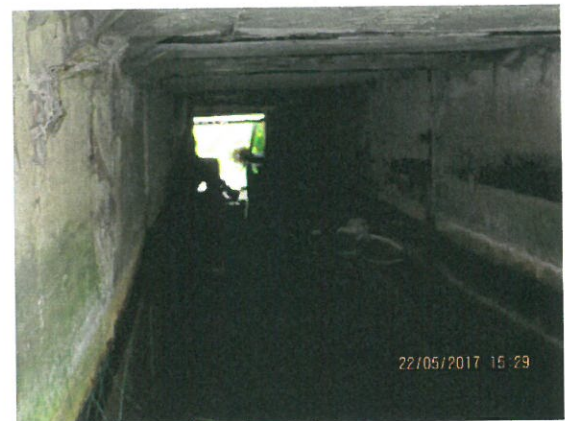
6. Vedere interior podeț dinspre amonte
