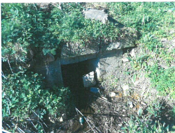
3. Vedere podet, din amonte
