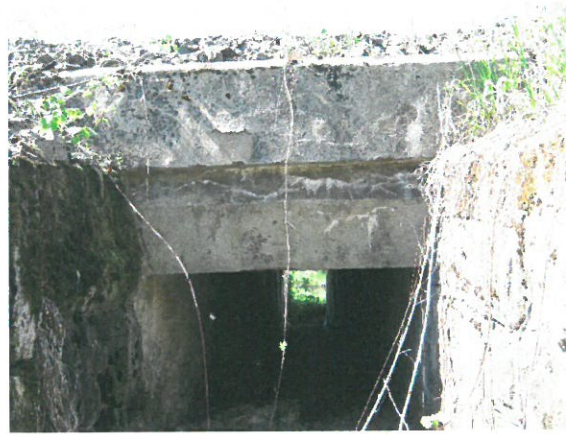
8. Faianțarea betonului timpanului amonte
