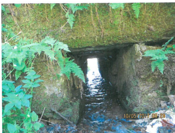
5. Vedere interior podet din amonte
