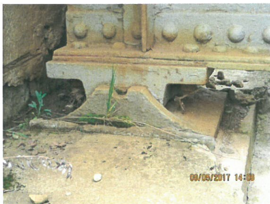
5. Vedere suprastructura GIPCS aval
