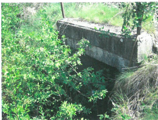
7.Vedere timpan aval
