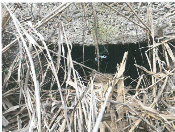
3. Vedere intrados podet
