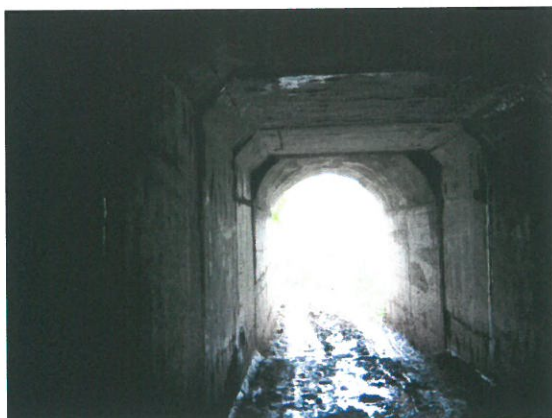
7. Vedere interior podeț
