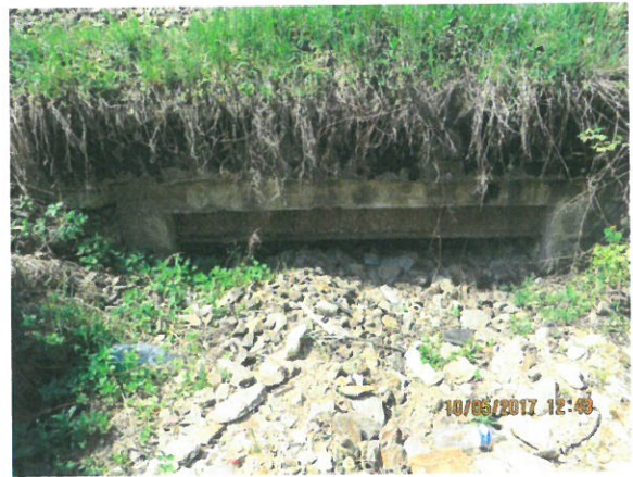
2. Vedere podet, din amonte
