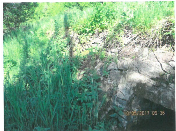
8. Vedere racordare cu terasamentul (dinspre aval) – culeea Oradea
