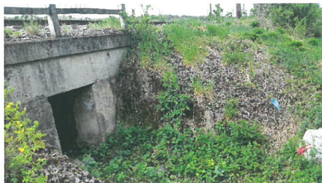
8.Vedere aripă stânga aval
