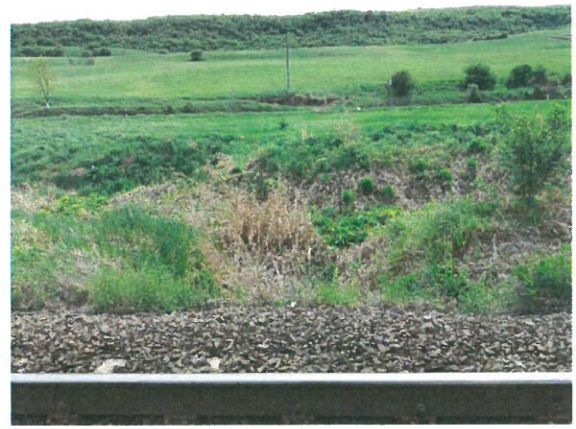
10. Vedere albie amonte
