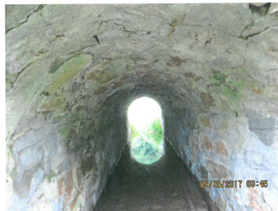
4. Vedere intrados podet
