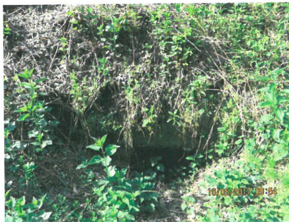
2. Vedere podet, din amonte
