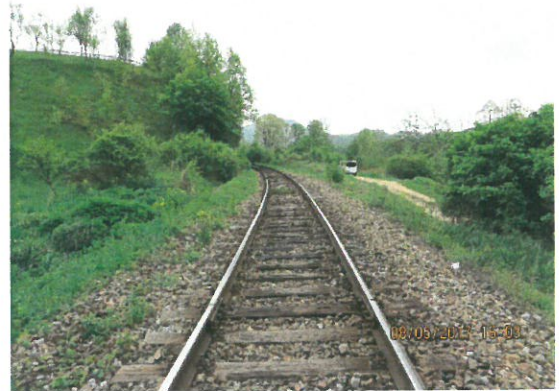
2. Calea pe pod și drumul din apropiere
