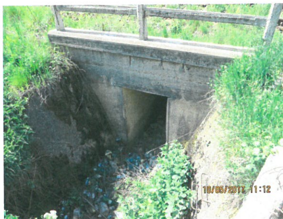
2. Vedere podet, din amonte
