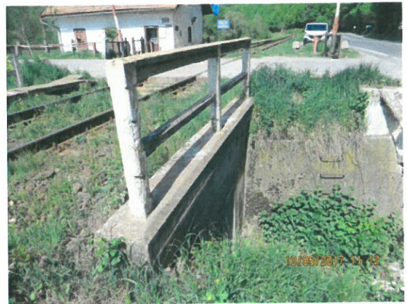
10. Vedere zid de sprijin amonte (Oradea); trepte din oțel beton
