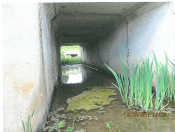
10. Vedere interior podeț dinspre aval
