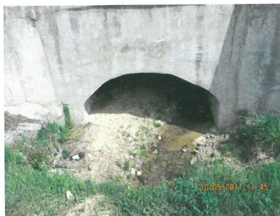
10. Vedere albie amonte
