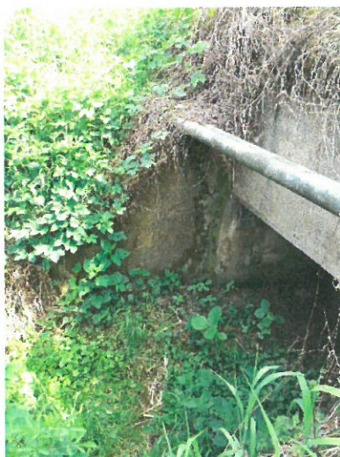
4. Vedere aripă dreapta aval
