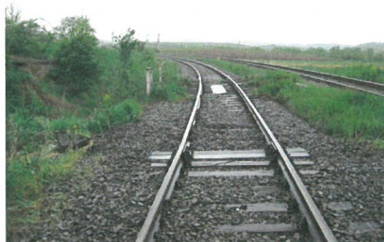
2. Șina și prinderea șinei de traverse, pe Firul 2
