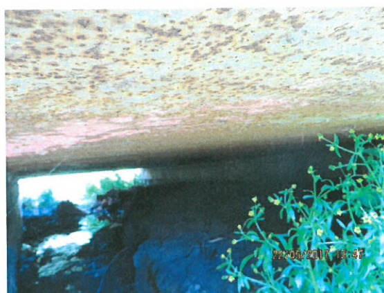
5. Vedere intrados podeț amonte
