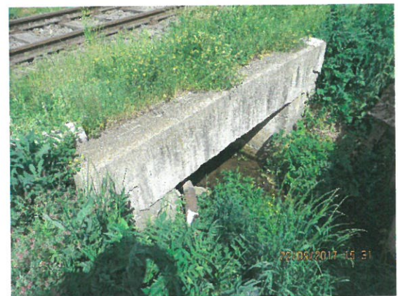
12. Vedere elevație podeț din aval
