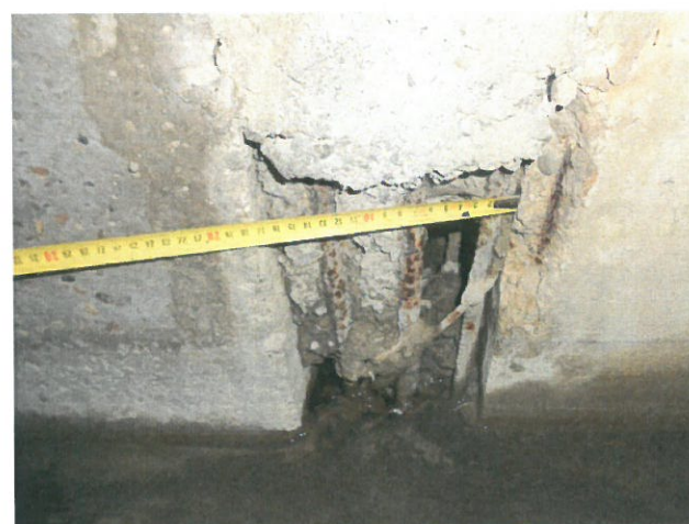
11. Detaliu rost completat între cadre
