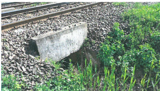
6. Vedere racordare cu terasamentul dreapta amonte
