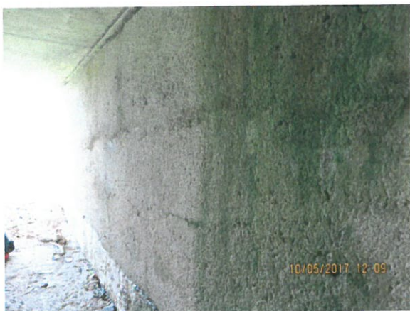
7. Vedere intrados dală, și elevație culee Oradea – degradări (prezența zonelor umede pe suprața betonului, segregarea betonului)
