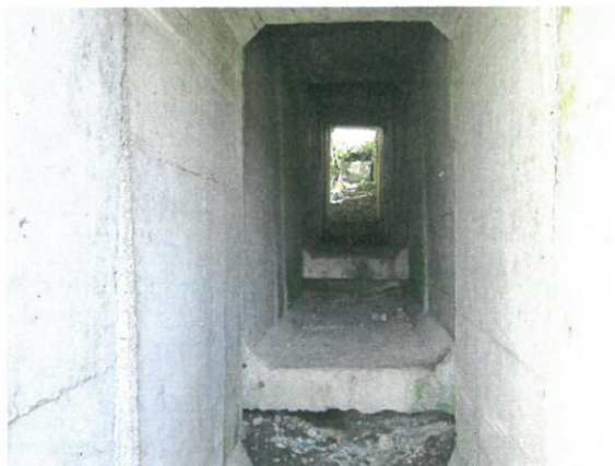
9. Vedere intrados dinspre aval
