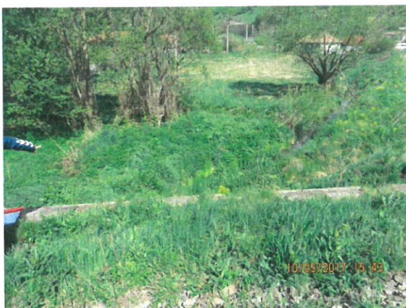
3. Vedere spre amonte
