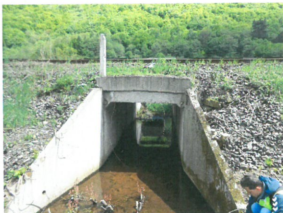
3. Vedere podet, din aval
