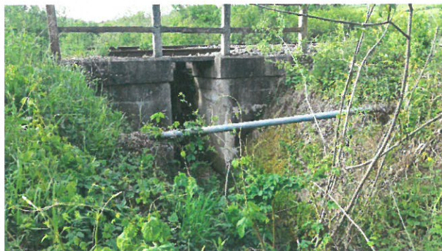
7. Vedere podeț aval
