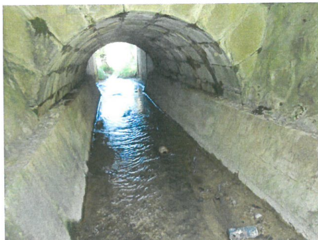
7. Boltă zidărie de piatră din amonte
