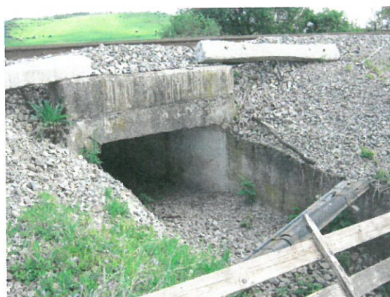
5. Vedere timpan amonte
