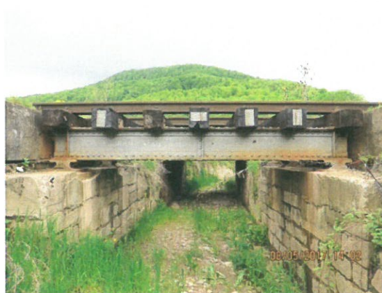
5. Vedere suprastructura GIPCS aval
