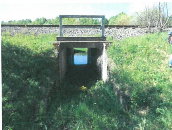
5. Vedere spre podet din amonte – cadru tip C2
