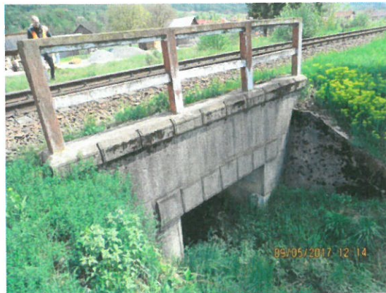
3. Vedere racordări aripi din zidărie în amonte
