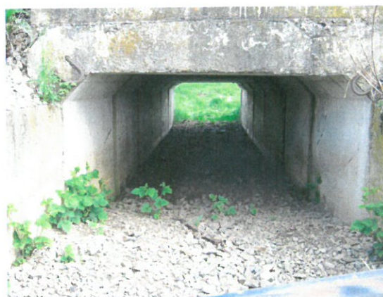
4.Vedere elevație amonte
