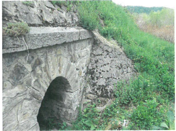
8. Vedere racordare cu terasamentul (dinspre aval) – culeea Cluj
