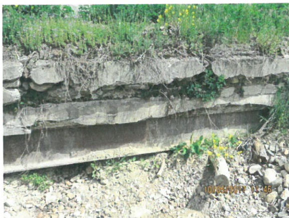
7. Vedere dală din aval – degradări (desprindere beton, prezența vegetației, crăpături) și colmatarea podețului
