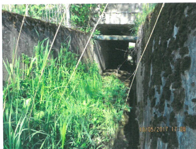
11. Vedere din aval spre podeț
