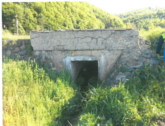
4. Vedere podet, din aval
