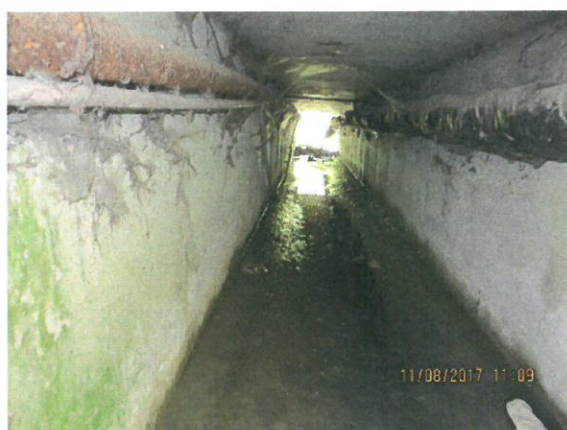
9. Vedere intrados dinspre aval
