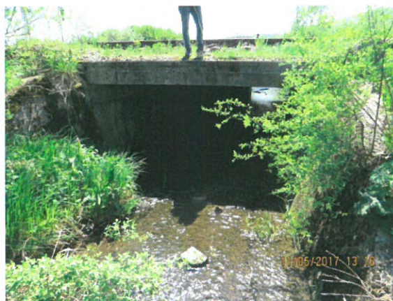
4. Vedere spre podet amonte
