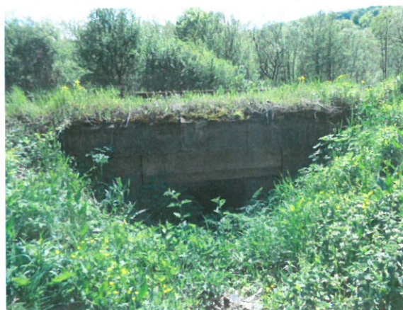
2. Vedere podet, din amonte
