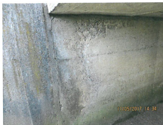
6. Vedere culee stânga dinspre amonte
