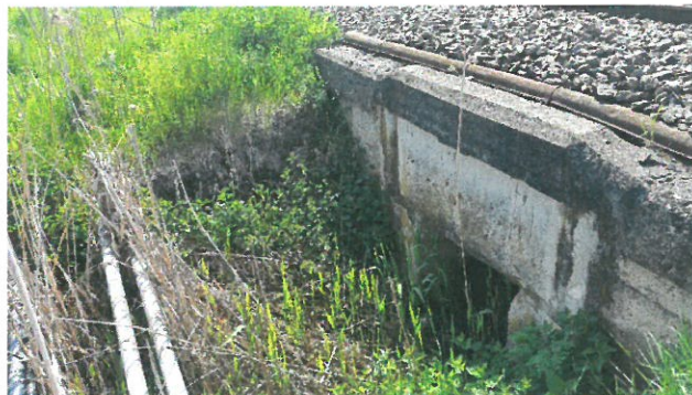
7. Vedere zid de sprijin dreapta aval
