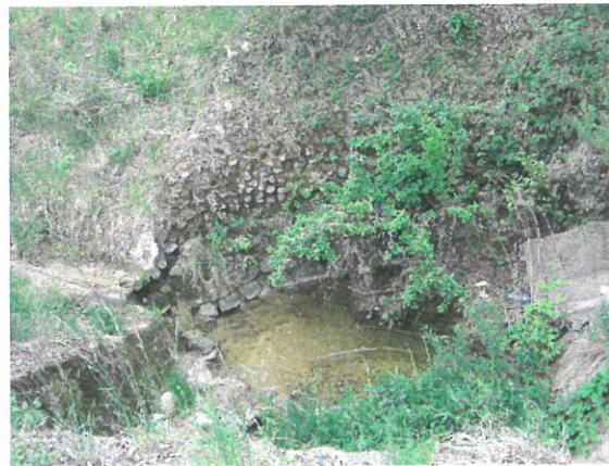
2.Vedere cameră de cădere amonte
