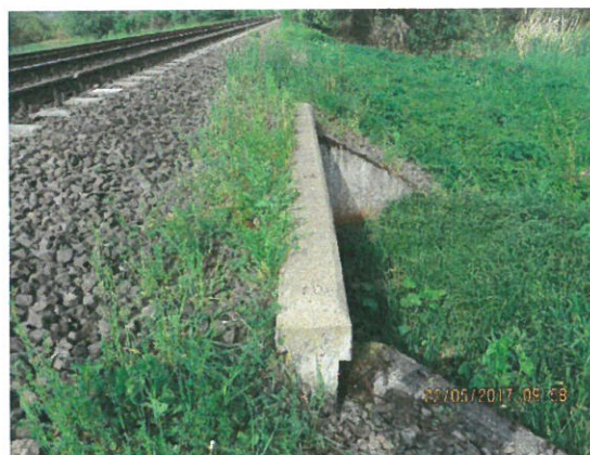
4.Vedere timpan amonte
