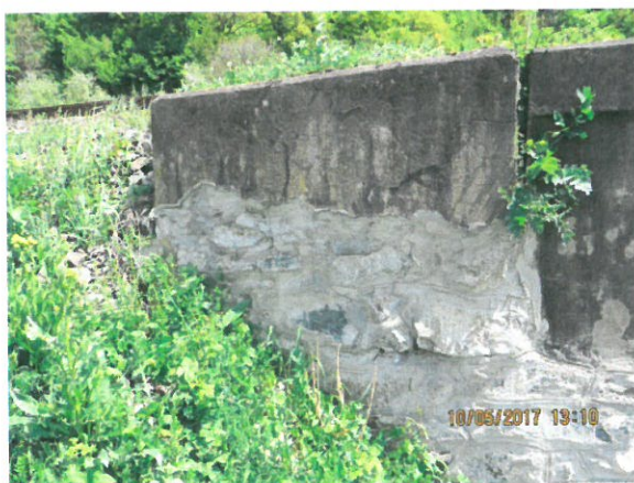
11. Vedere zid întors culee Oradea, din aval
