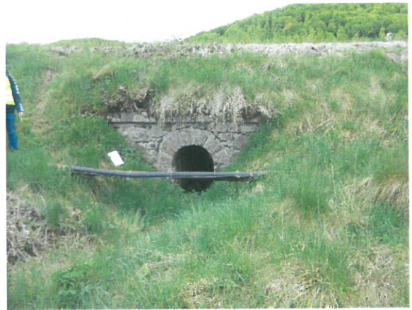
2. Vedere podet, din amonte
