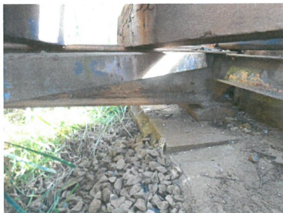
9. Vedere de jos a tablierului metalic
