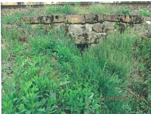
3. Vedere podet, din aval
