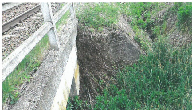
7. Vedere cameră de cădere și șant dinspre culeea Cluj
