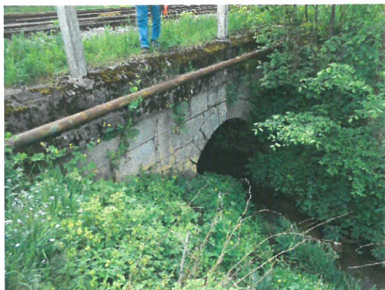
1. Vedere podet boltit
