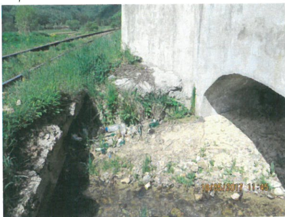
7. Vedere dală din aval – degradări (desprindere beton, prezența vegetației, crăpături) și colmatarea podețului
