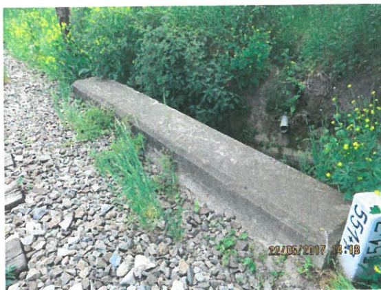
7. Vedere timpan aval
