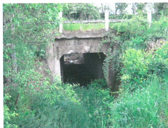
5. Vedere aval podeț
