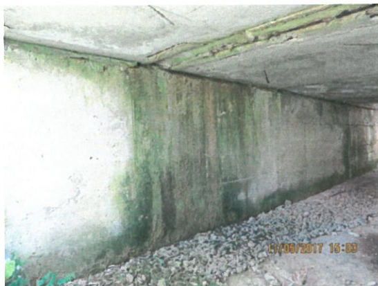
7. Vedere culee stânga din amonte
