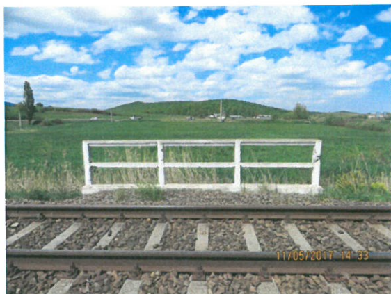
3. Vedere spre amonte
