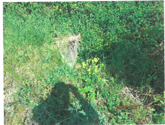
8. Vedere timpan aval
