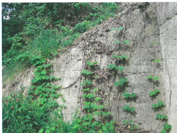
3.Vedere aripă stânga amonte
