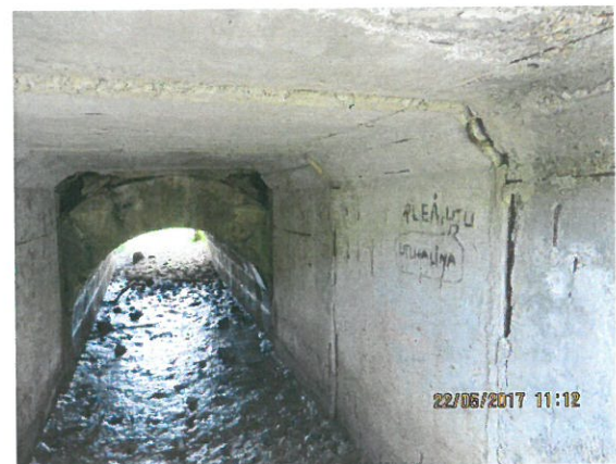
6.Vedere interior podeț dinspre amonte
