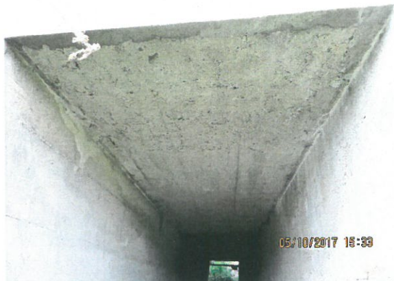
7. Vedere interior podeț (dinspre aval) - degradări (armătură la vedere, crăpături, segregări beton dală, etc.)
