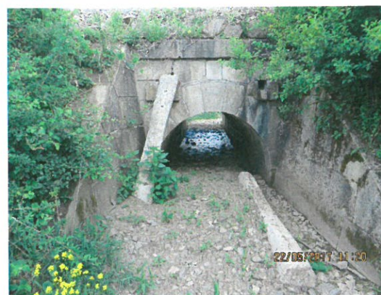
10. Vedere elevație aval
