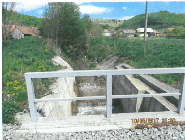
3. Vedere spre amonte
