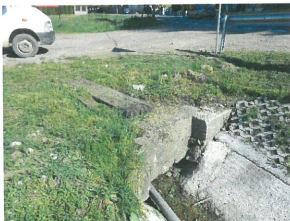
5. Vedere racordare rigolă drum la traseul podetului
