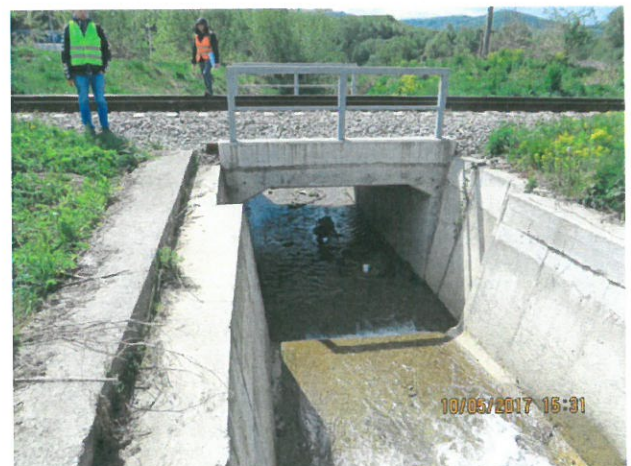
6. Vedere spre podeț din amonte – cadru tip C3
