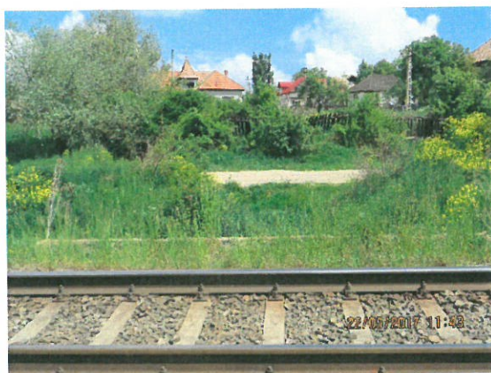
3. Vedere albie amonte
