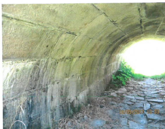
6. Interior podet dinspre amonte
