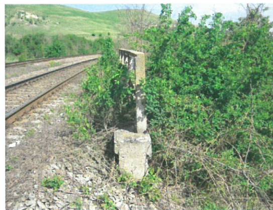
6. Vedere timpan și parapet aval
