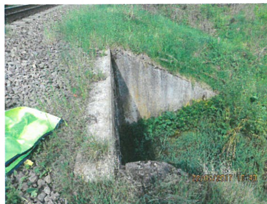
4. Vedere timpan amonte
