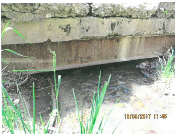
5. Grindă metalică marginală, vedere din amonte
