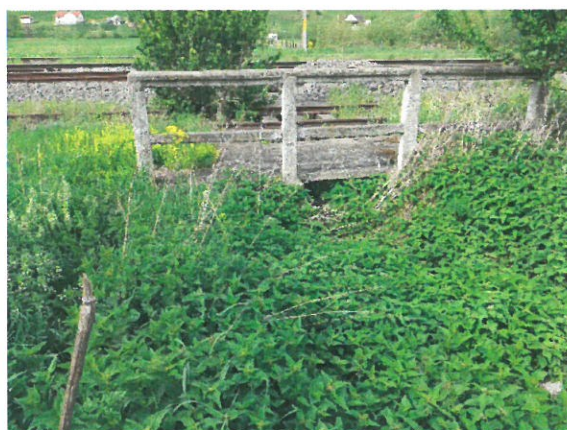
11. Vedere timpan amonte
