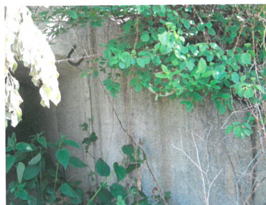
12. Vedere elevație aval
