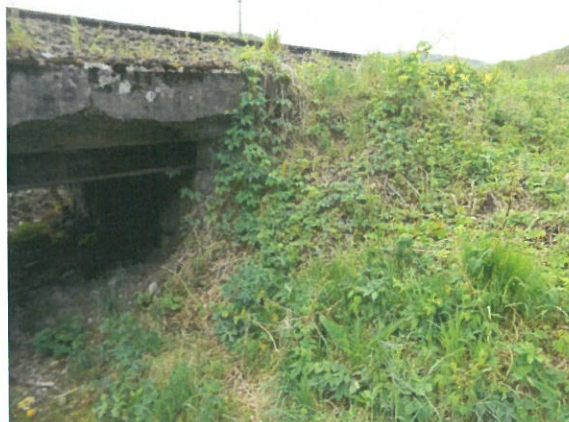
4. Vedere racordare cu terasamentul (dinspre amonte) – spre Oradea
