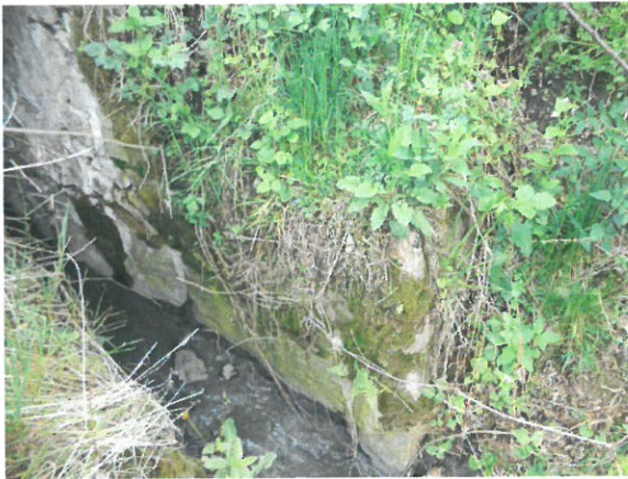
9. Vedere zid albie culeea Cluj (dinspre aval)
