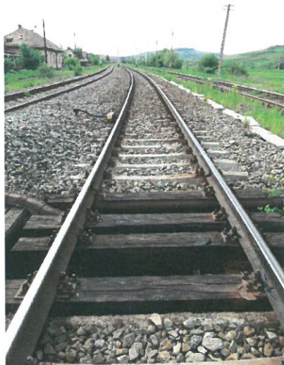
2. Șina și prinderea șinei de traverse, pe Firul II
