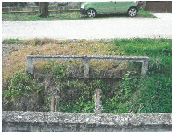
2. Vedere cameră de cădere amonte
