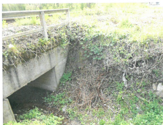
6. Vedere racordare cu terasamentul (dinspre amonte) – spre Oradea
