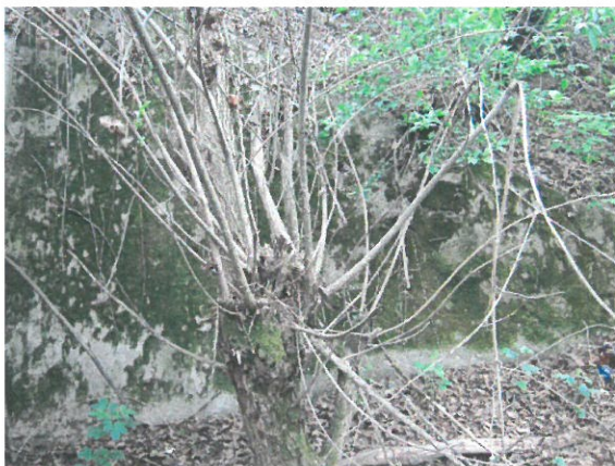
11. Copac în zona dintre aripile aval
