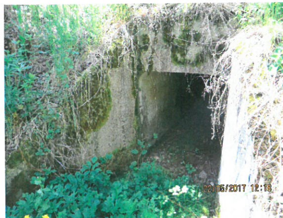
4. Vedere elevație amonte
