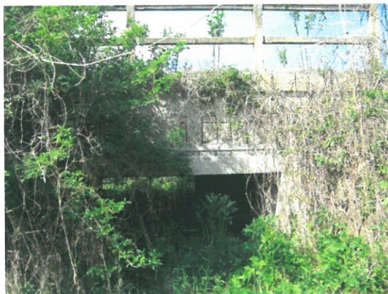
7. Vedere timpan aval
