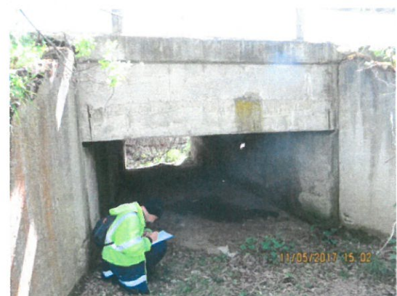
5. Vedere dală marginală amonte
