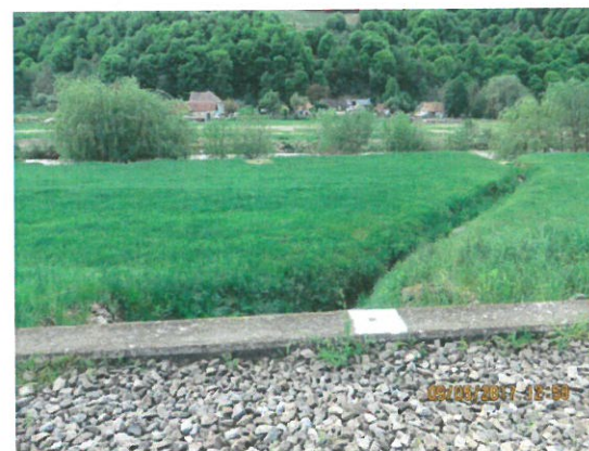
4. Vedere albie aval și podet de drum
