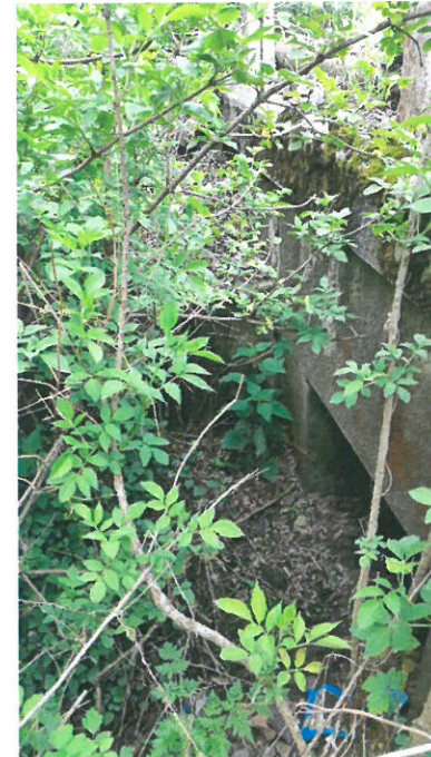
3.Vedere timpan amonte
