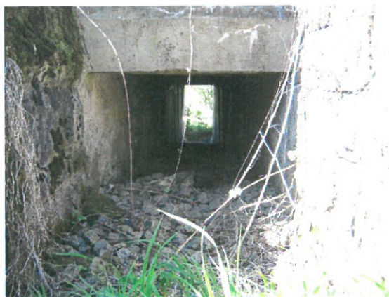
9. Colmatare cu piatră spartă
