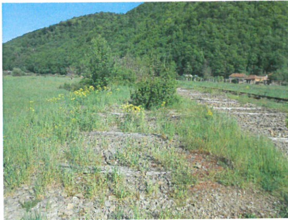
9. Vedere linii dezafectate
