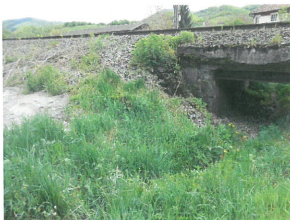
5. Vedere racordare cu terasamentul (dinspre amonte) – spre Cluj
