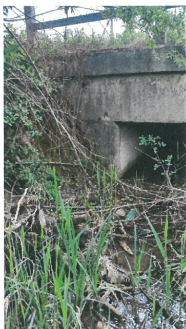
10. Vedere aripă dreapta aval
