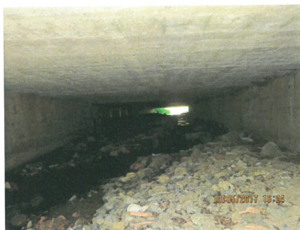
12. Vedere interior podeț dinspre aval
