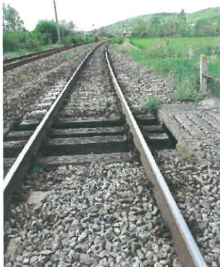
1. Șina și prinderea șinei de traverse, pe Firul I
