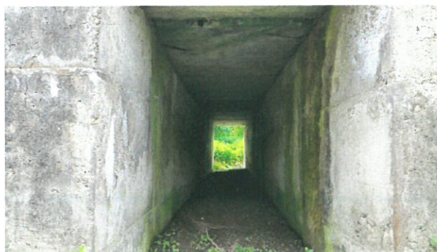
10.Vedere intrados dinspre aval
