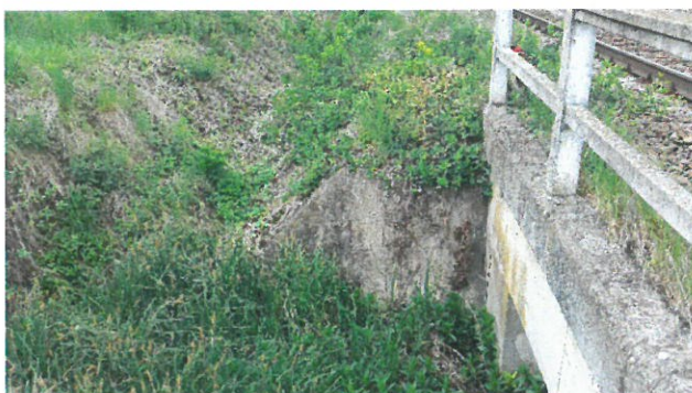
8. Vedere cameră de cădere și șant dinspre culeea Oradea
