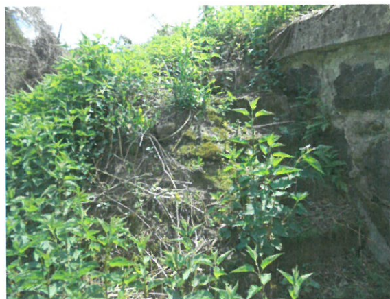
4. Vedere racordare cu terasamentul și scară (dinspre amonte) – culeea Cluj
