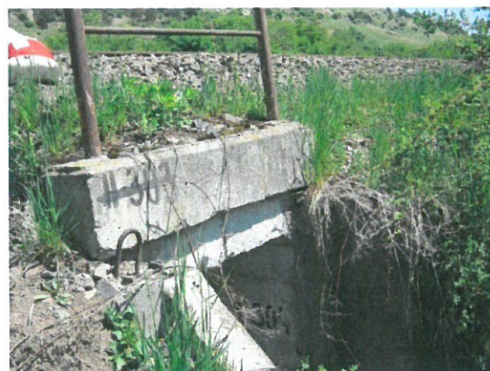
5. Vedere timpan aval, Firul 2
