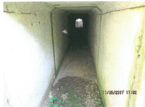
6.Vedere interior podețul dinspre amonte
