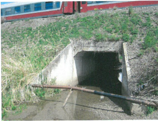
9.Vedere aripă aval
