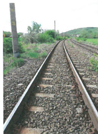
2. Șina și prinderea șinei de traverse, pe Firul II
