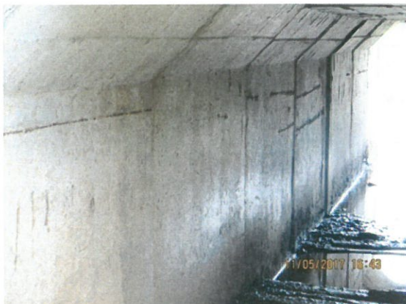
9. Vedere laterala stângă interior podeț
