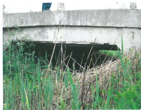
6. Vedere timpan amonte
