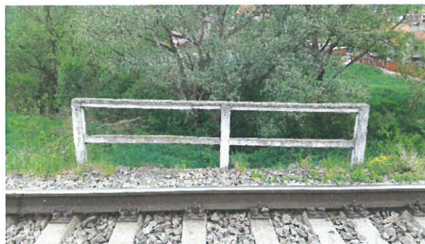
12. Vedere parapet din vecinătatea firului I
