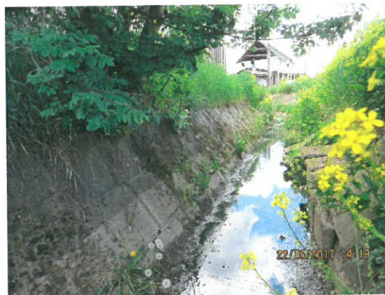
10. Vedere albie pereiată aval
