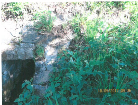
9. Vedere racordare cu terasamentul (dinspre aval) – culeea Cluj
