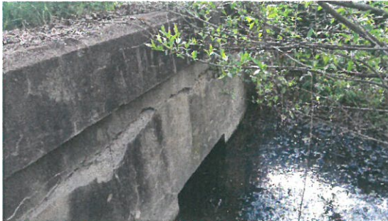
6.Vedere timpan amonte
