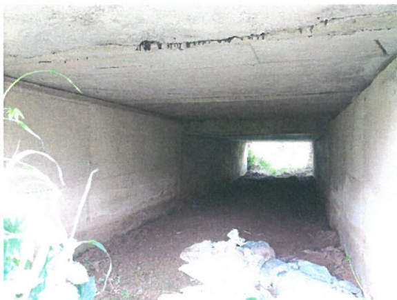
9. Colmatare intrados podeț cu saci cu deșeuri
