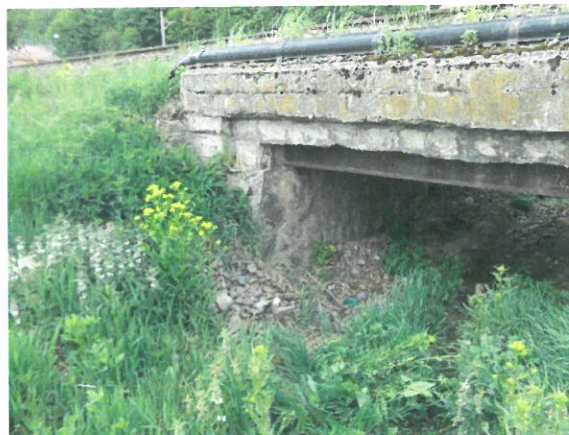
8. Vedere racordare cu terasamentul (dinspre aval) – spre Oradea
