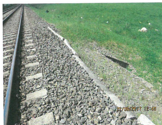
6. Vedere fir I cu traverse care susțin prismul de piatră spartă amonte
