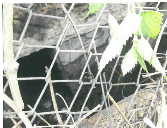
6. Vedere culee Oradea, din amonte
