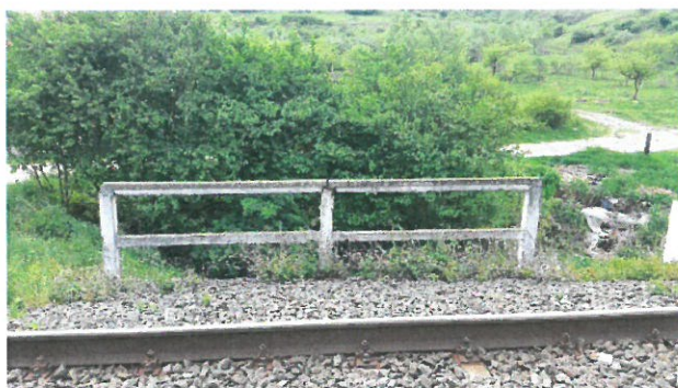
11.Vedere parapet din vecinătatea firului II
