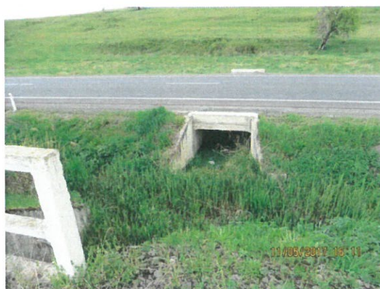
5. Vedere spre podeț de șosea – albie amonte
