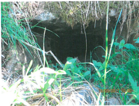
9. Vedere interior podeț din aval
