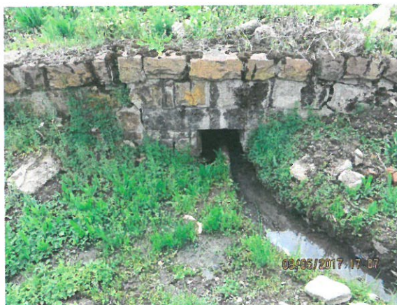
2. Vedere podet, din amonte
