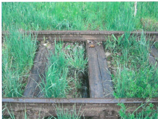
3. Vedere transversă in dreptul podețului deschis
