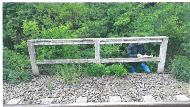
10.Vedere parapet din vecinătatea firului I
