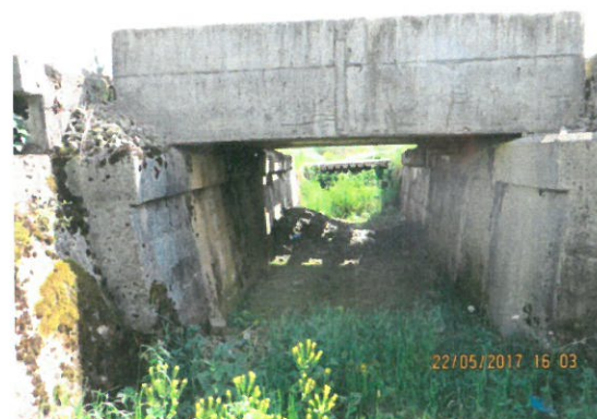
4.Vedere elevație amonte
