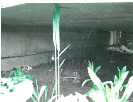
7.Vedere interioară podeț
