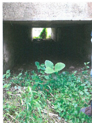
6. Vedere intrados dinspre aval
