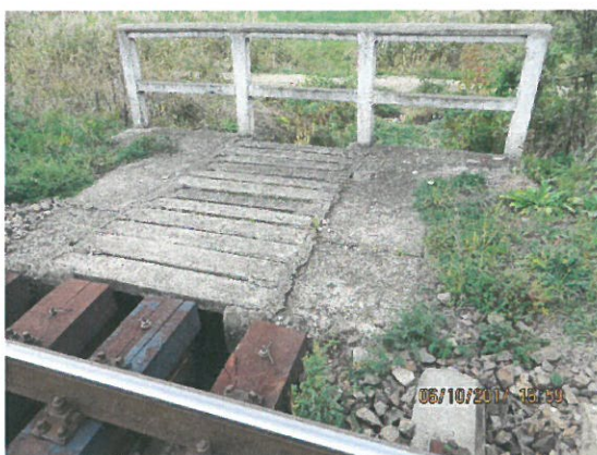
7. Trotuar de serviciu și parapet în vecinătatea Firului
