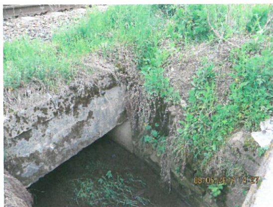
3. Vedere racordare cu terasamentul
