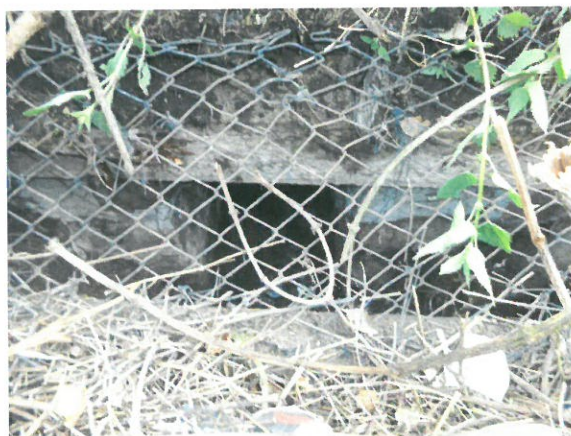
4. Vedere dală și culei, din amonte
