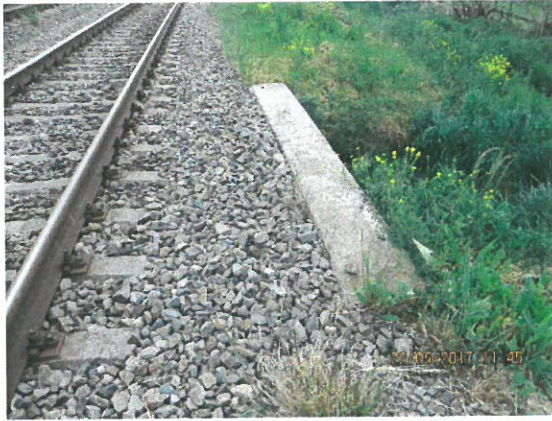
7.Vedere timpan aval
