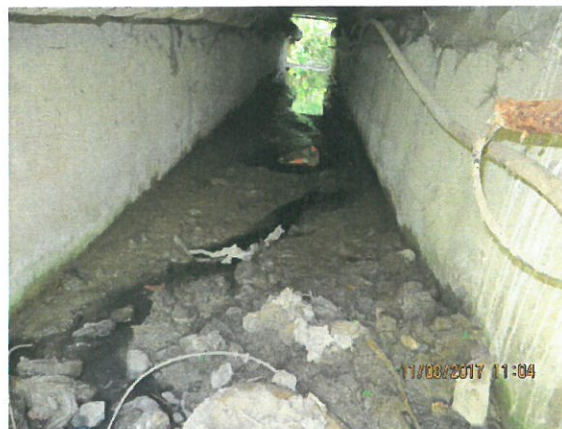
8. Vedere albie intrados podeț dinspre amonte
