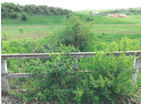
11. Vedere parapet din vecinătatea firului I
