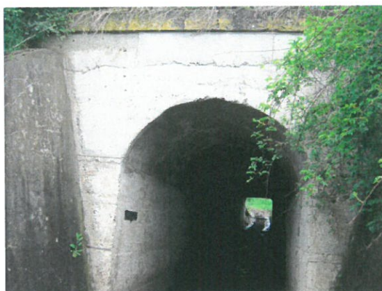
5. Vedere podeț din aval
