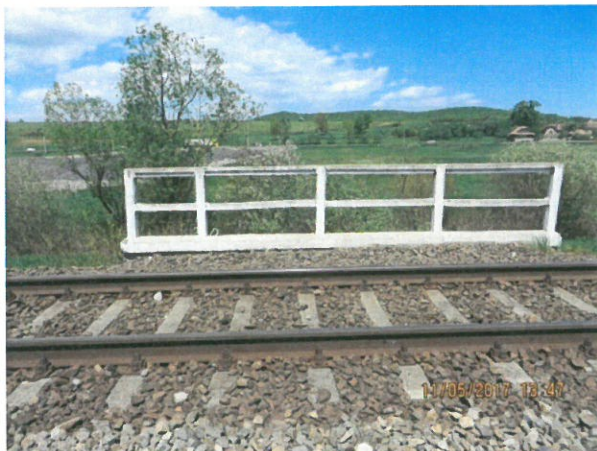
3. Vedere spre amonte
