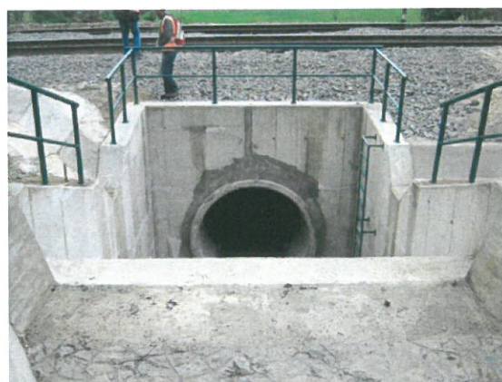
5. Vedere cameră de cădere amonte
