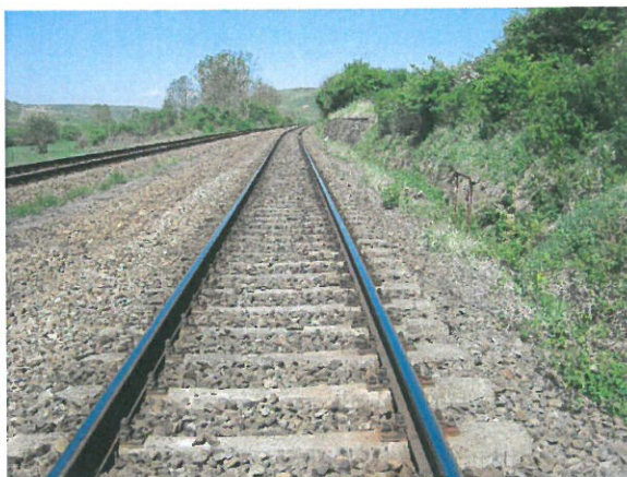
1. Șina și prinderea șinei de traverse, pe Firul I
