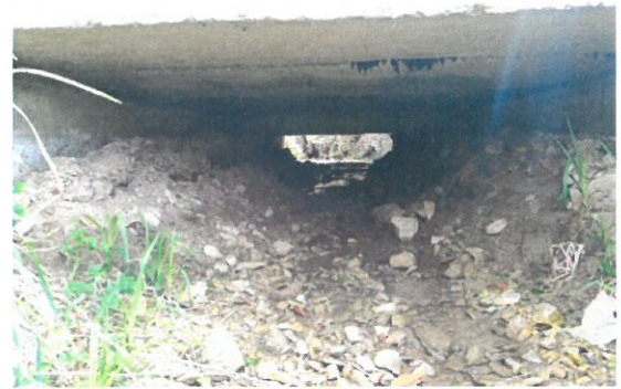
10. Vedere intrados dinspre aval
