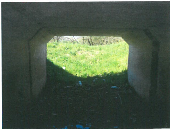
9. Vedere spre capăt aval podeț
