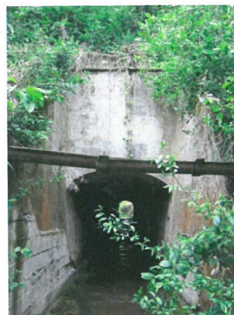
4. Vedere podet din aval
