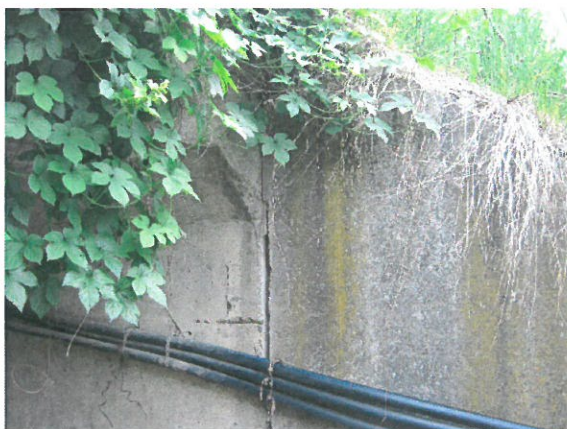
7. Rost cadru prefabricat – aripă dreapta amonte
