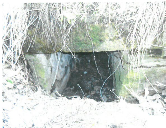
2. Vedere podet, din amonte
