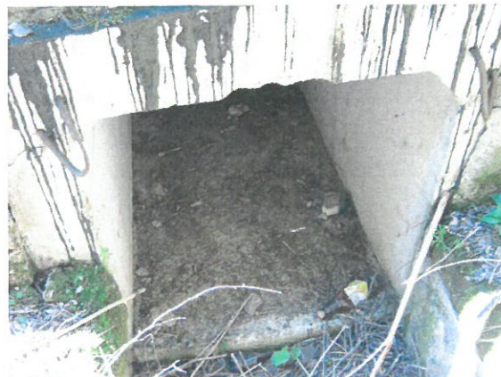
8.Vedere cadru prefabricat amonte
