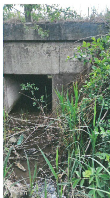
11. Vedere aripă stânga aval
