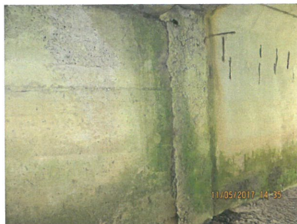
9. Detaliu rost între culee și cadrele tip C2
