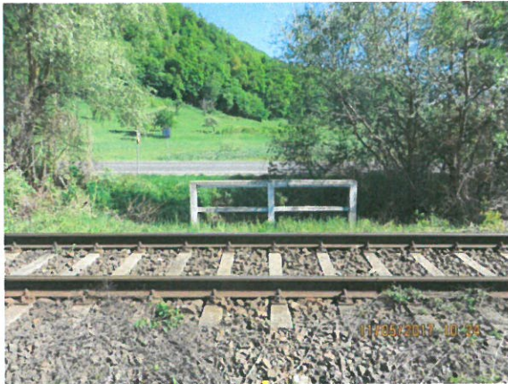
3. Vedere spre amonte
