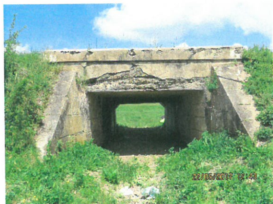
11. Vedere elevație aval
