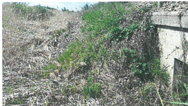
7. Vedere aripă stânga amonte
