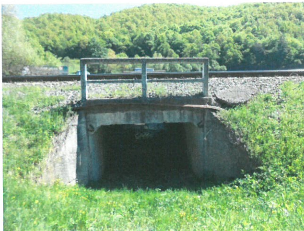
11. Vedere spre podeț din aval
