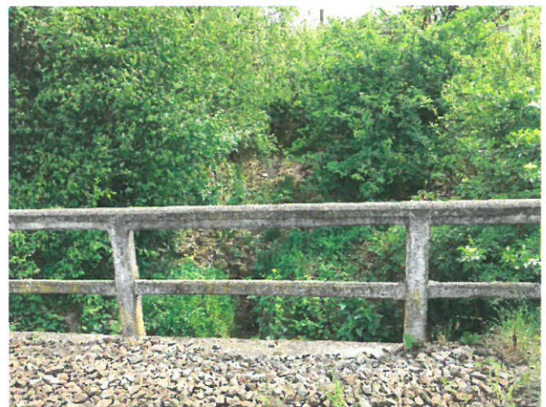
12. Vedere parapet din vecinătatea firului II
