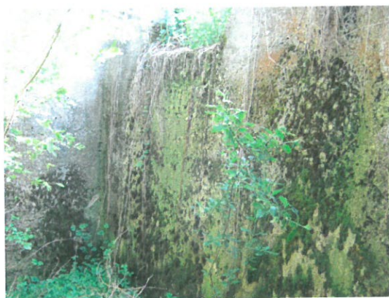
5. Vedere cameră de cădere amonte
