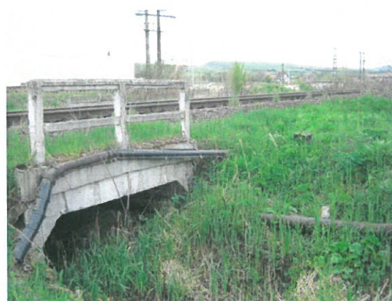
5.Vedere timpan și parapet aval
