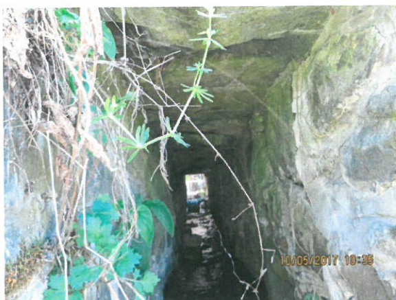
7. Vedere interior podeț din aval
