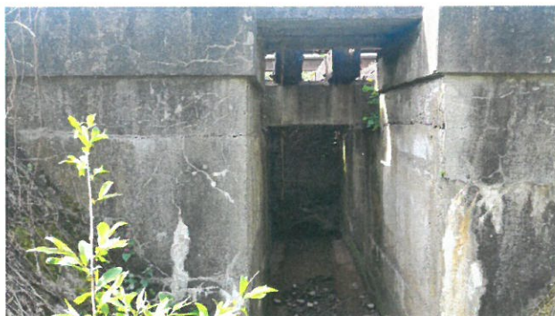
10. Vedere intrados podeț dinspre aval
