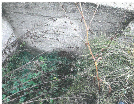
2.Vedere timpan amonte
