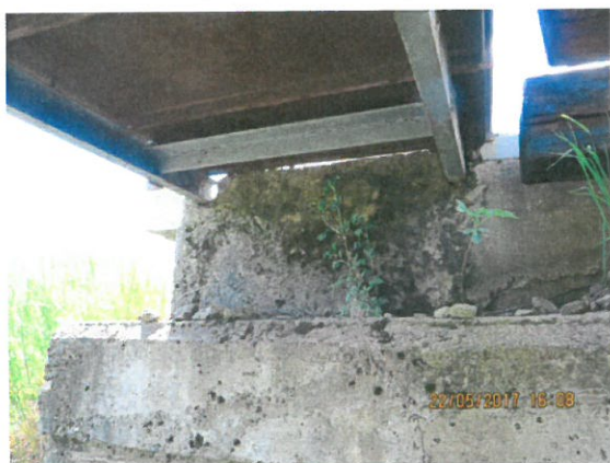
11.Vedere culee degradată din aval
