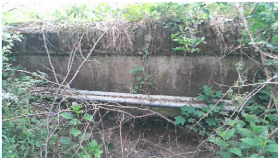
8.Vedere timpan aval
