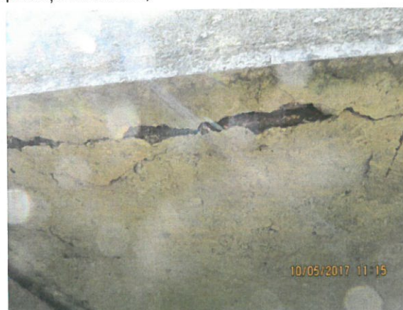
4. Vedere dală exterior (dinspre amonte) – degradări (segregări beton, armatură descoperită, crăpături pe suprafața betonului)
