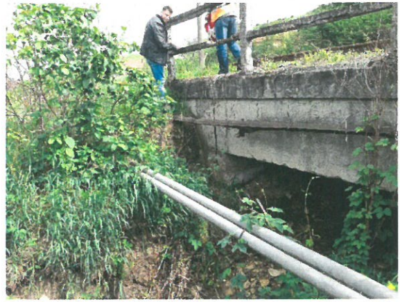
8. Vedere aripă dreapta aval
