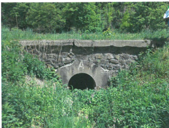
3. Vedere podet, din aval
