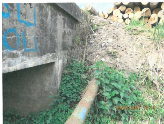
5. Vedere racordări sferturi de con aval
