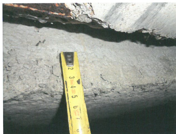
10. Armătură corodată, cadrele tip C3 nejoantive
