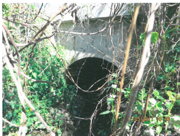
11. Vedere din aval spre podeț
