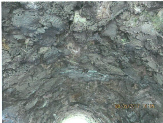
3. Vedere intrados podet
