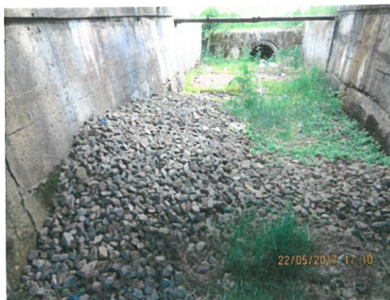
8. Vedere interior podeț colmatat cu piatră spartă
