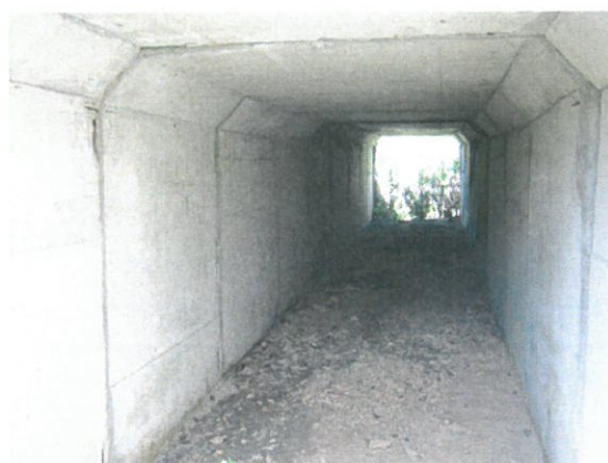
5. Vedere interior podeț
