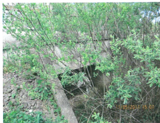
12. Vedere din aval spre podeț
