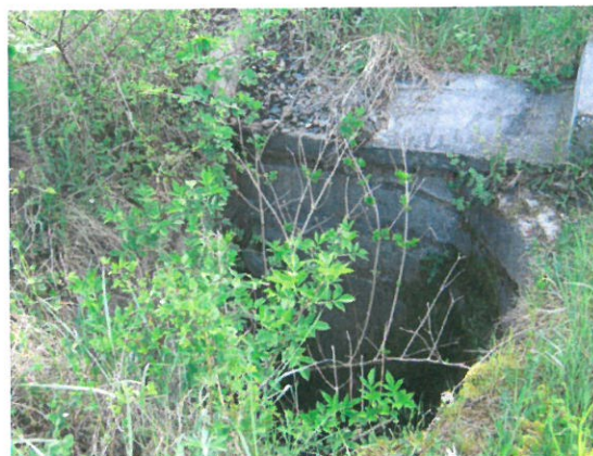
4.Vedere puț colector amonte
