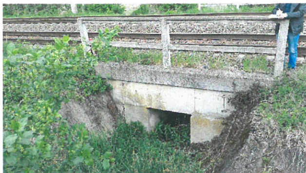
6. Vedere timpan amonte
