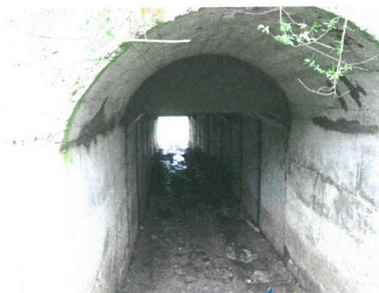
8. Vedere interior podeț
