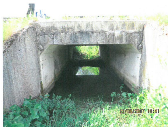
5. Vedere elevație amonte
