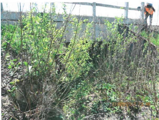
5. Vedere spre podet din amonte
