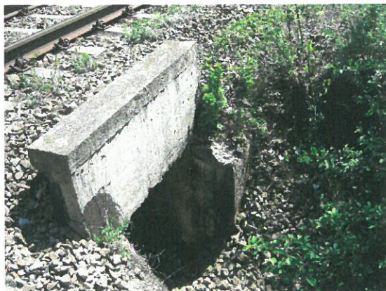
7.Vedere timpan aval
