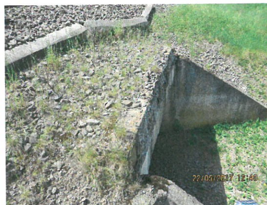
4. Vedere timpan amonte
