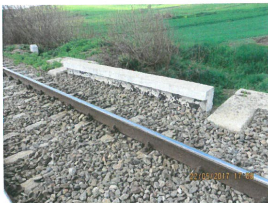
3.Vedere timpan amonte
