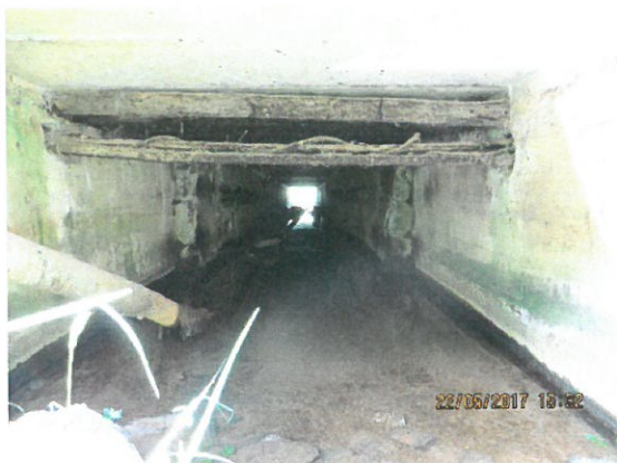
11. Vedere cabluri din interiorul podețului dinspre aval
