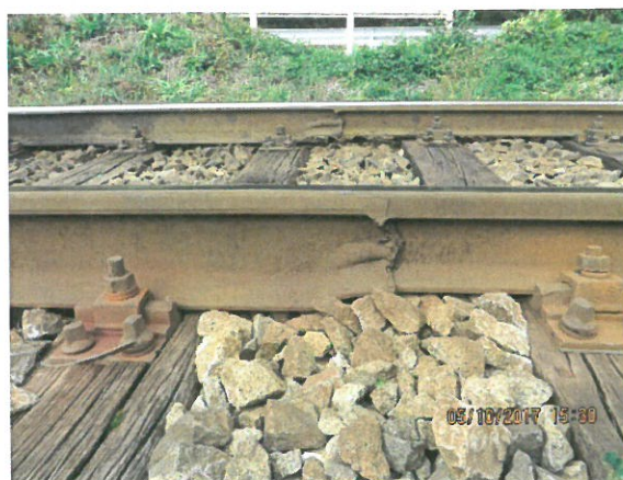
10. Vedere conexiune șine (tip 65 si tip 49) pe zona podețului
