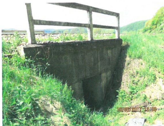
2. Vedere podet, din amonte
