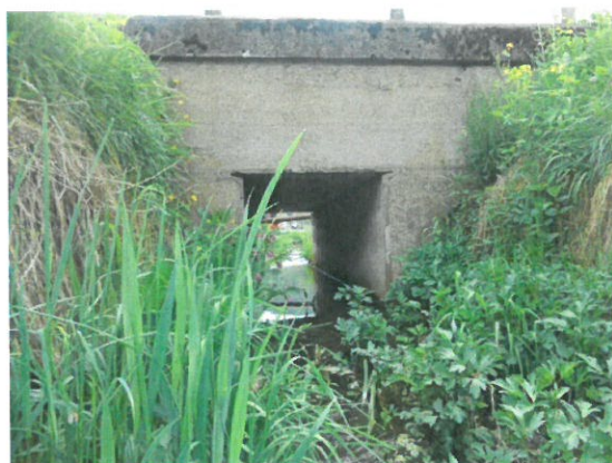
5. Vedere aval podet
