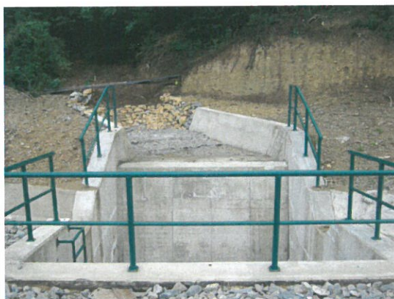
3. Vedere timpan amonte
