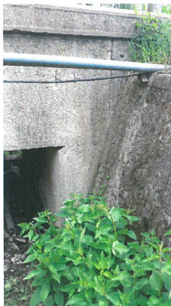
5.Vedere zid de sprijin dreapta amonte
