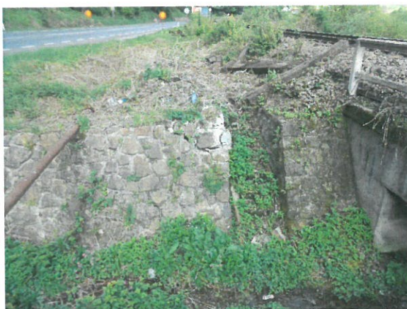
5. Vedere racordare cu terasamentul (dinspre amonte), scara – spre Cluj
