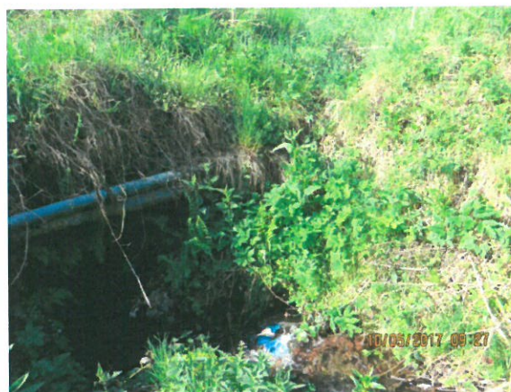
4. Vedere racordare cu terasamentul (dinspre amonte) – culeea Oradea
