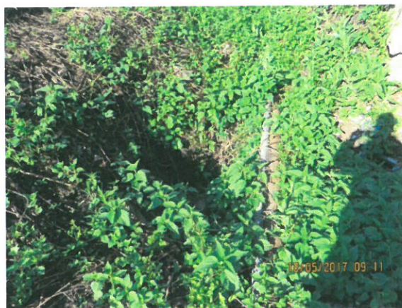
4. Vedere racordare cu terasamentul (dinspre amonte) – culeea Oradea; prezența a două conducte
