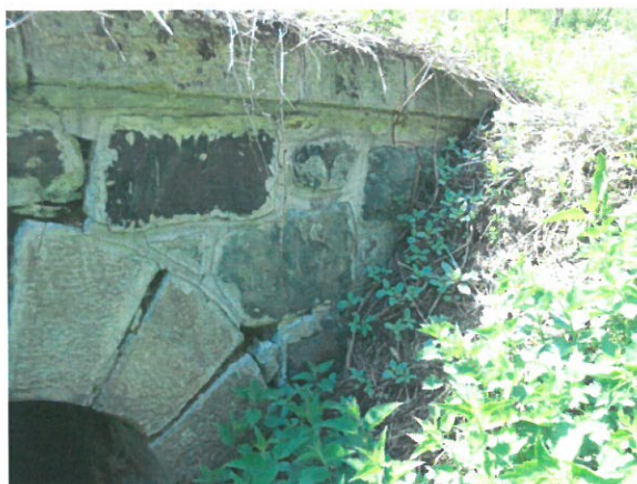
5. Vedere racordare cu terasamentul, timpan și boltă (dinspre amonte) – culeea Oradea
