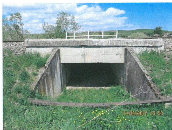
11. Vedere din aval spre podeț
