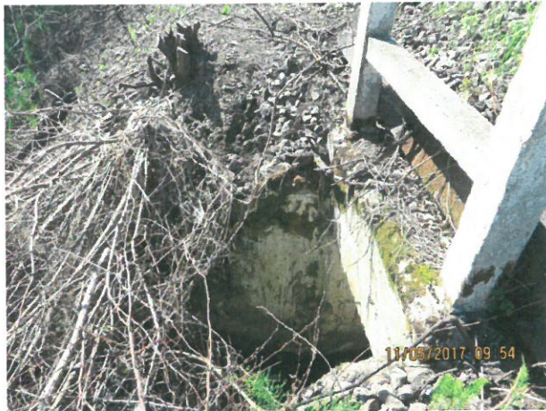
7. Detaliu timpan și aripă stânga din amonte
