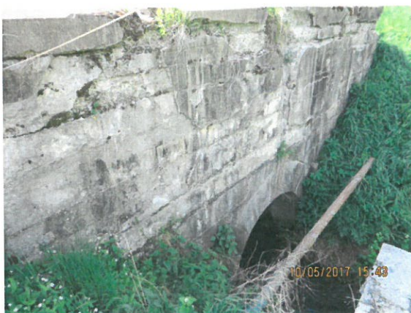
5. Vedere din amonte spre podeț tip B2
