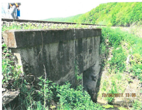
2.Vedere podet, din amonte
