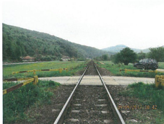
2. Calea pe pod și vedere cu trecerea la nivel
