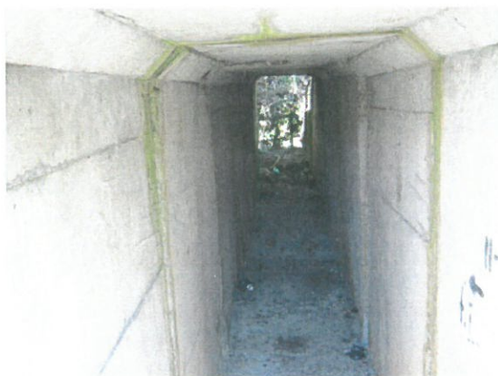
3.Vedere interioară podeț
