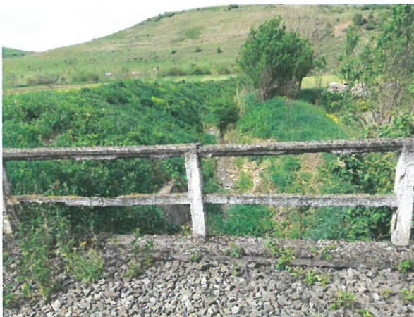
11. Vedere parapet din vecinătatea firului I
