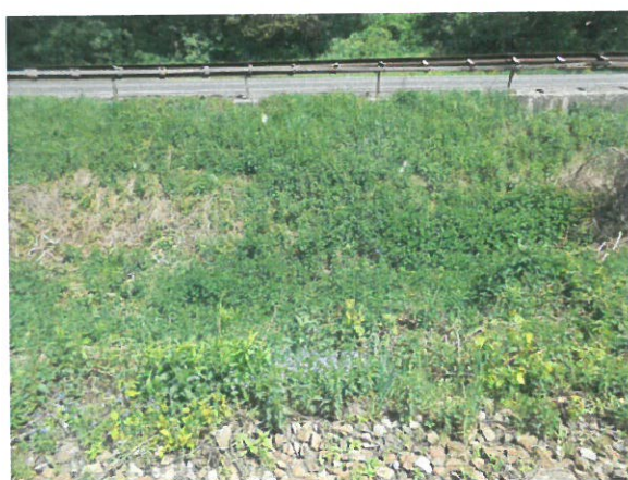
11. Vedere albie amonte
