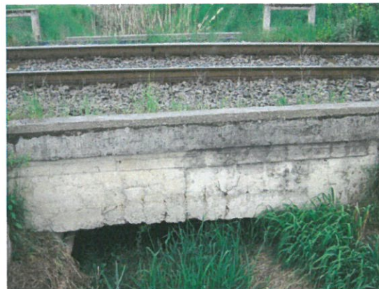
4. Vedere tablier fir I, dală de beton
