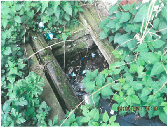
7. Vedere racordare amonte – detaliu colmatare
