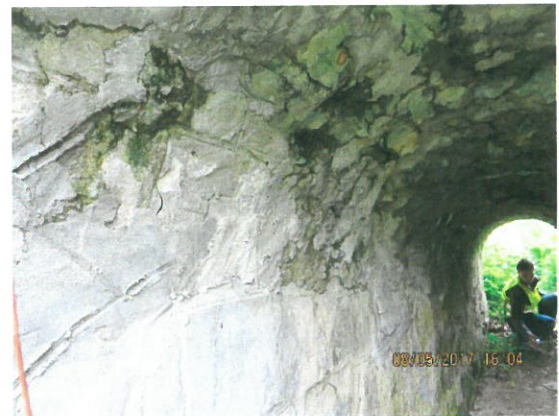
4. Vedere intrados podet
