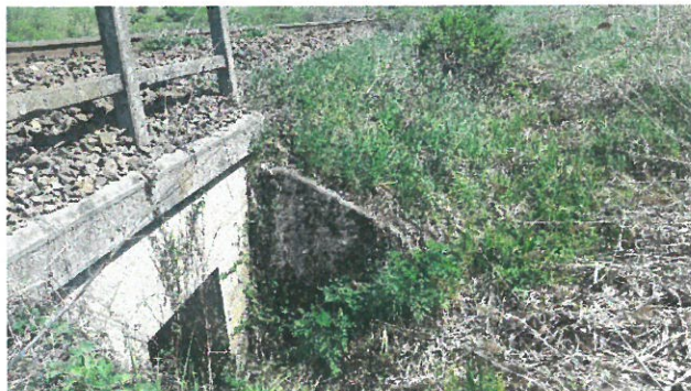
6. Vedere aripă dreapta amonte
