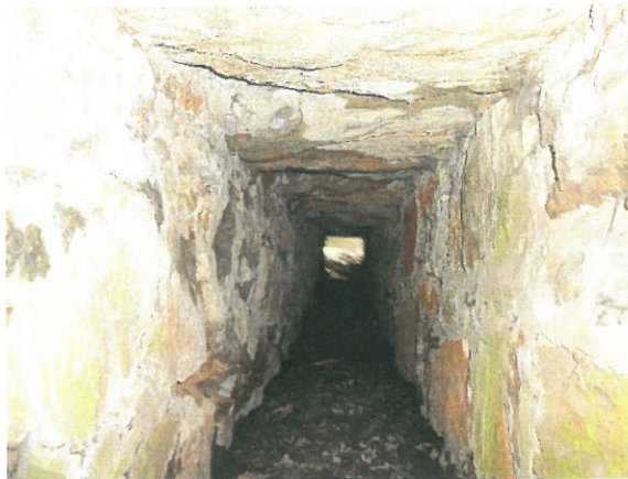
8. Vedere interior podeț (dinspre aval)
