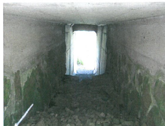
4. Vedere interior podet amonte, Firul 1
