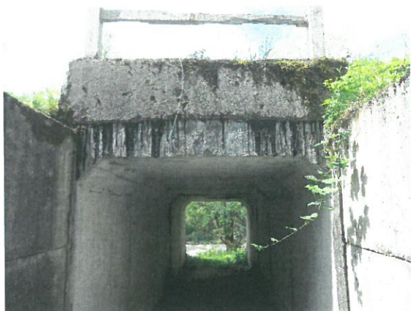
7. Vedere podeț interior – dinspre amonte
