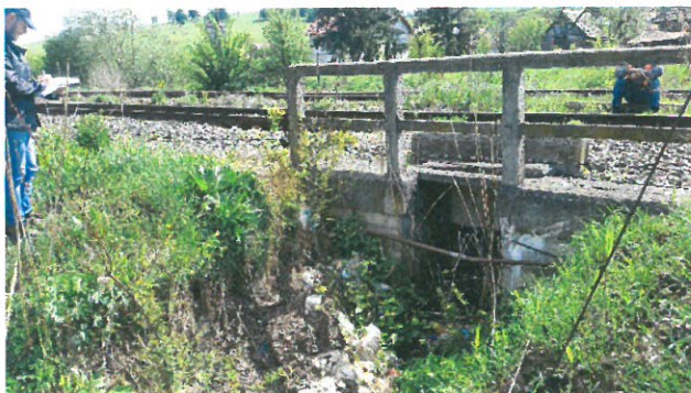
8. Vedere zid de sprijin dreapta aval
