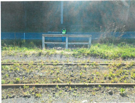
3. Vedere spre amonte
