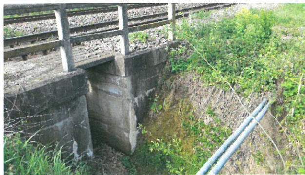
9. Vedere zid de sprijin stânga aval
