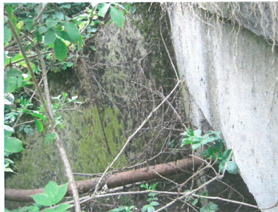
4. Vedere aripă dreapta aval
