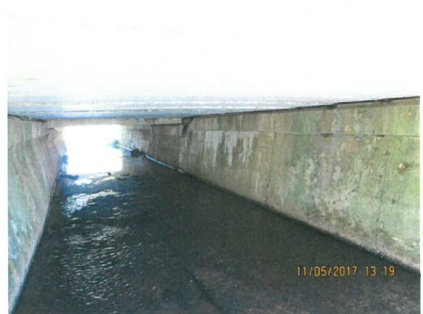
10. Vedere interior podeț dinspre aval
