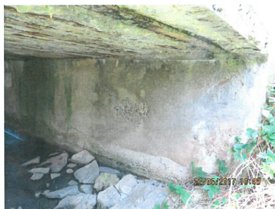
11. Vedere interior podeț dalat degradat și colmatat aval
