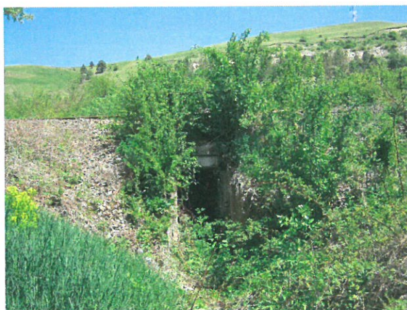
5. Colmatare cu vegetație aval
