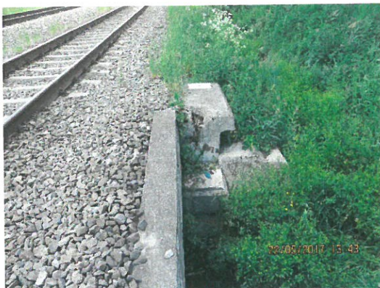
7. Vedere timpan aval
