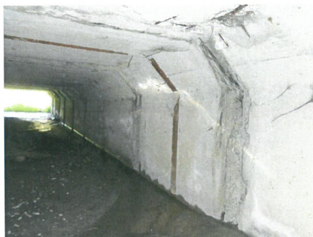
9. Detaliu rosturi între cadrele tip C3
