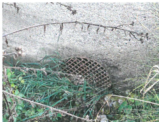
4.Vedere grătar amonte
