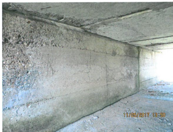
8. Intrados podeț spre culee stânga din amonte
