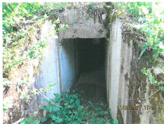
5. Vedere elevație amonte
