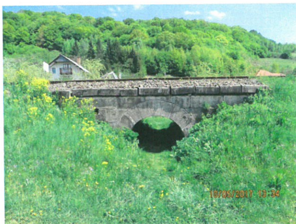
9. Vedere spre podeț din aval
