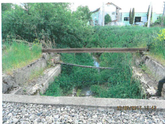
3.Vedere albă acoperită de vegetație amonte
