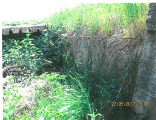
10. Vedere zid de sprijin si albie aval acoperită de vegetație mare
