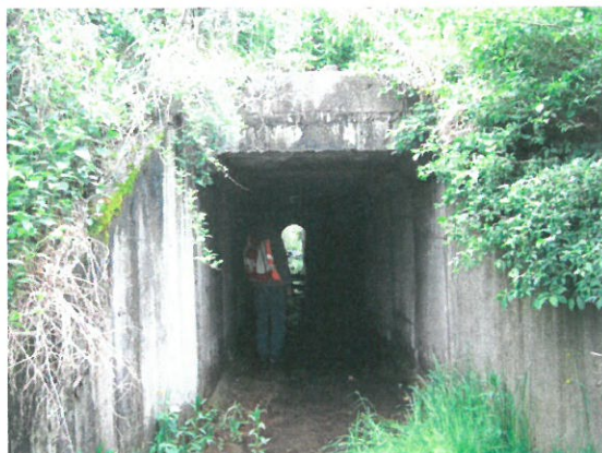
7. Vedere podeț aval
