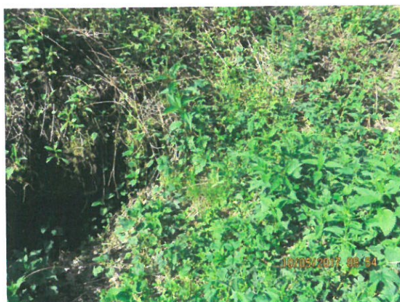
5. Vedere racordare cu terasamentul (dinspre amonte) – culeea Oradea
