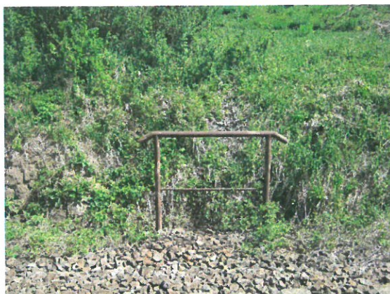
3. Vedere albie amonte
