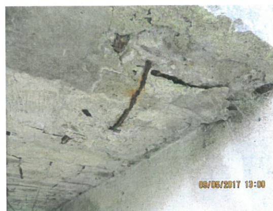
6. Vedere degradări intrados dală beton
