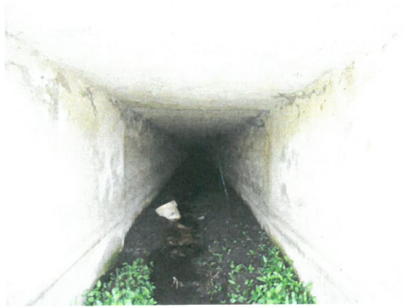
8. Vedere interior podeț dinspre aval - degradări (carbonatări, segregări, etc)
