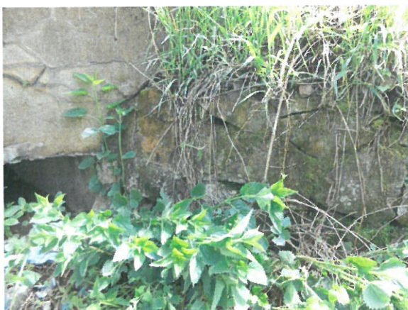
9. Vedere racordare cu terasamentul (dinspre aval) – spre Cluj
