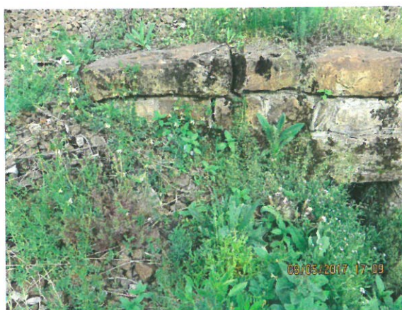
10. Vedere racordare cu terasamentul (dinspre aval) – spre Oradea
