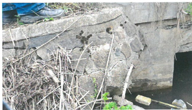
11. Sfert de con degradat
