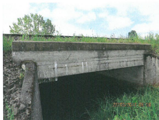
5. Vedere elevație amonte
