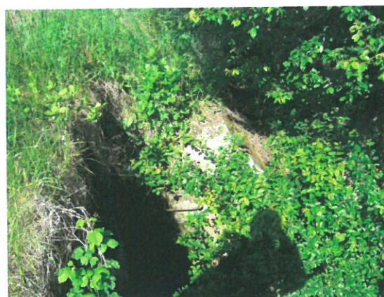
6. Vedere aripă și scară amonte
