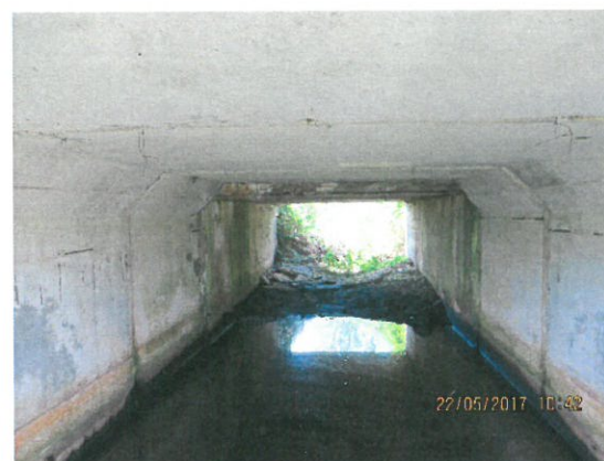
6. Vedere interior podeț dinspre amonte
