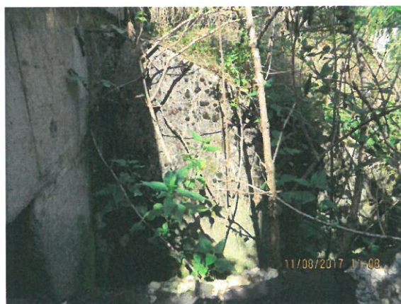
5. Vedere aripă stânga aval
