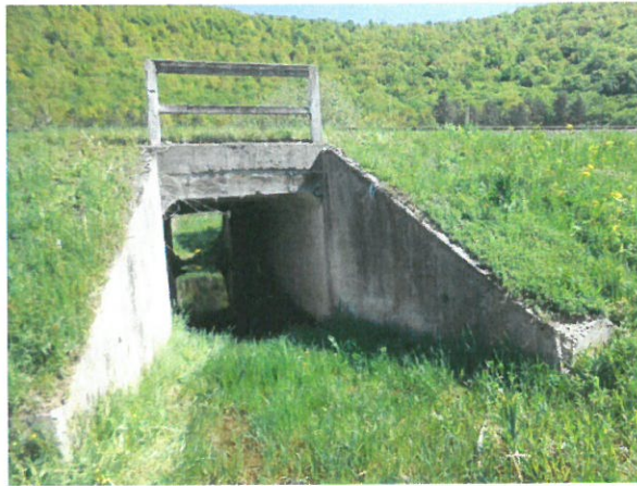
9. Vedere spre podeț dinspre aval
