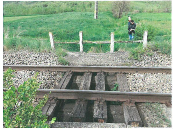
8. Vedere suprastructură podeț
