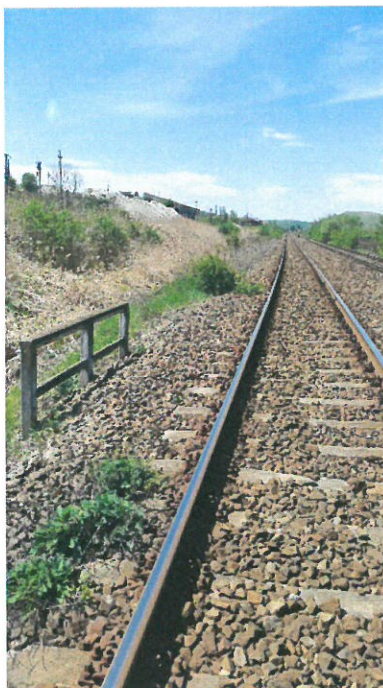
2. Șina și prinderea șinei de traverse, pe Firul II
