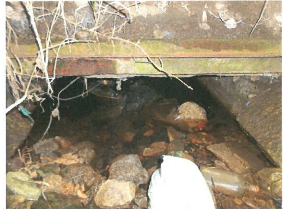
10. Vedere intrados podeț dalat de pe liniile 35 și 36
