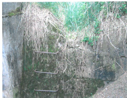
8.Vedere scară acces amonte
