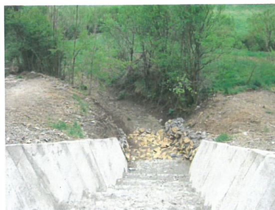
11. Vedere scara aval
