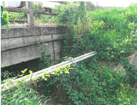
9. Vedere zid de sprijin stânga aval
