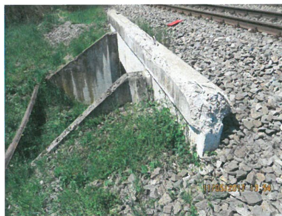
12. Detaliu timpan și aripi podeț din aval
