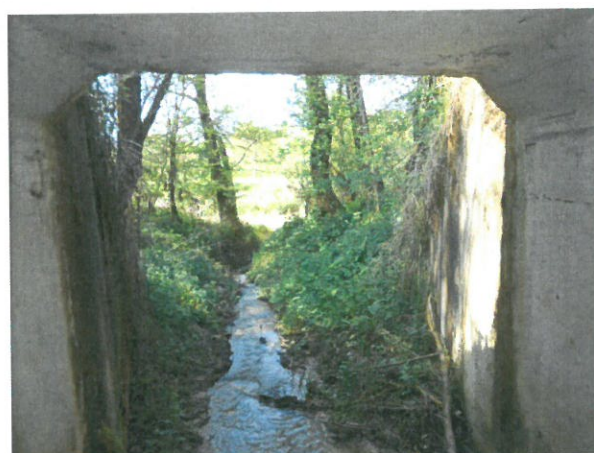
10. Vedere spre aval – ieșire podeț
