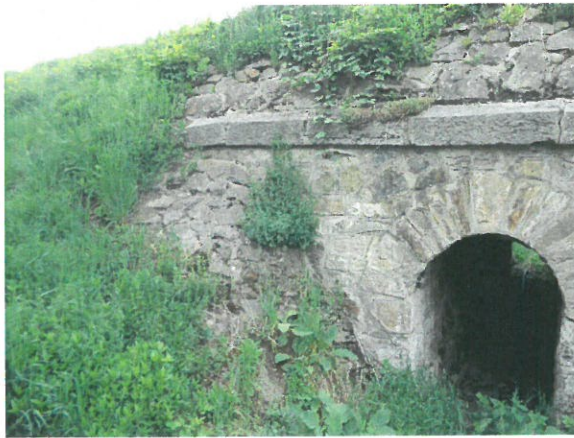
7. Vedere racordare cu terasamentul (dinspre aval) – culeea Oradea
