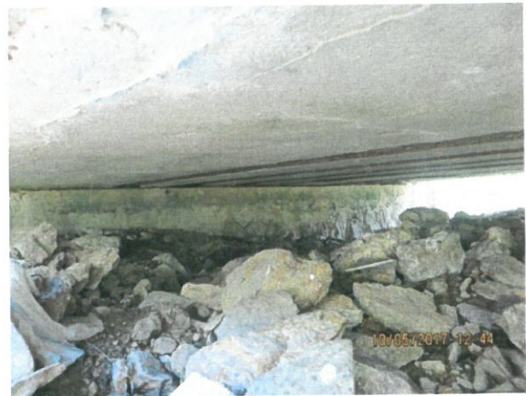
8. Colmatare podeț; degradări intrados (carbonatări, faianțări)
