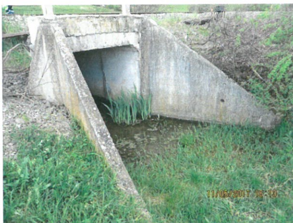
7. Vedere interior podeț dinspre amonte – cadru tip C2
