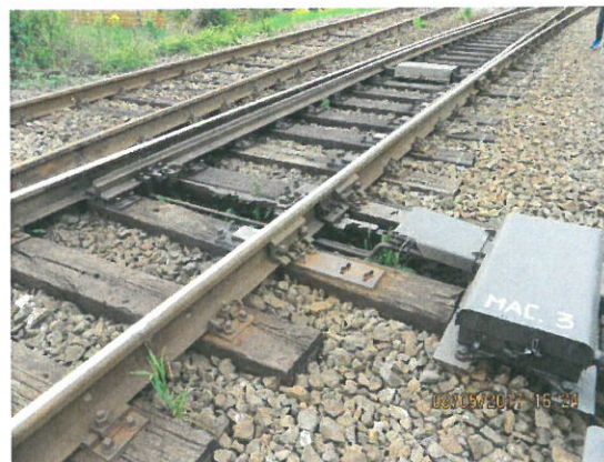
2. Vedere linii cf pe podet
