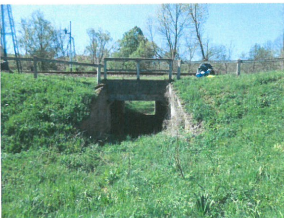
5. Vedere spre podet din amonte – cadru tip C3
