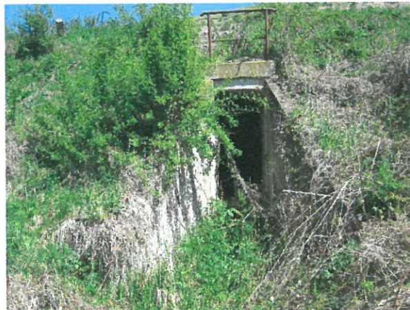
6. Vedere elevație aval
