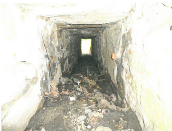
7. Vedere interior podeț (dinspre amonte)
