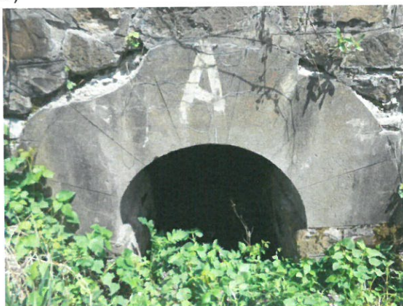
7. Vedere racordare cu terasamentul (dinspre aval) – culeea Oradea – degradări (crăpături beton coronament, bucăți de beton desprinse din boltă, etc.)
