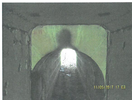
11.Vedere rost podețe
