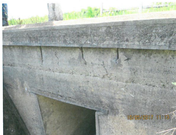
4. Vedere dală exterior (dinspre amonte) – degradări (segregări beton, armatură descoperită, crăpături pe suprafața betonului)
