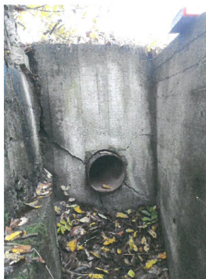
6. Vedere timpan aval
