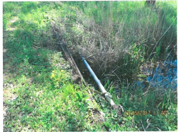
8. Detaliu capăt podeț aval
