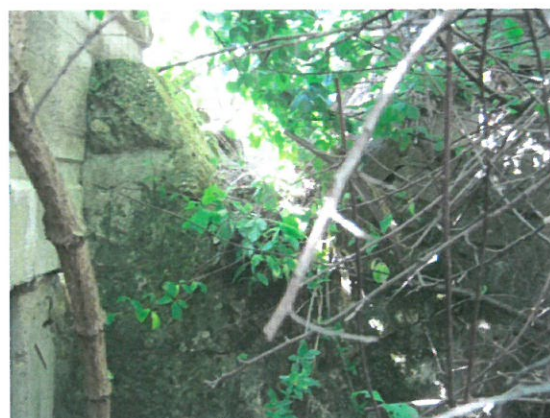
5.Vedere aripi din zidărie de piatră
