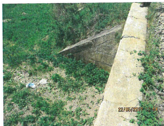
10. Vedere timpan aval
