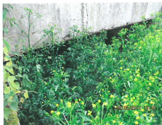
6. Vedere dală din aval
