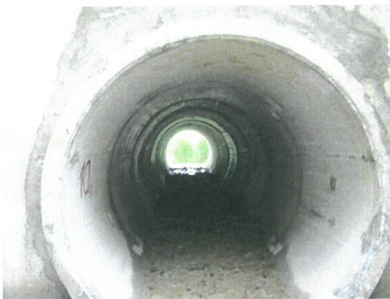
7. Vedere tub din beto armat
