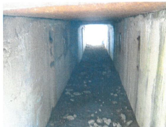
10.Colmatare podeț cu material aluvionar
