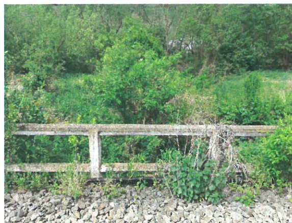
12. Vedere parapet din vecinătatea firului II
