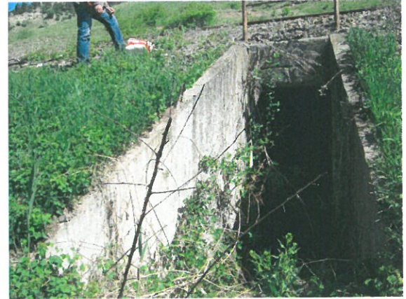
8. Vedere aripă dreapta aval
