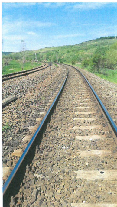
1.Șina și prinderea șinei de traverse, pe Firul I
