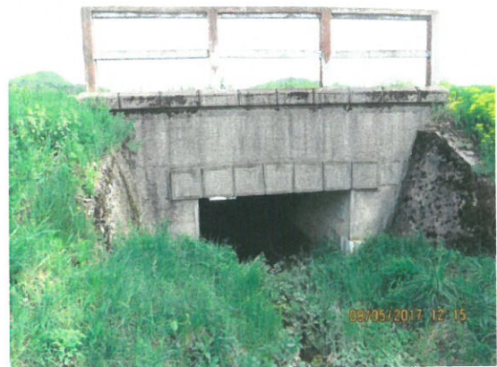
2. Vedere podet amonte
