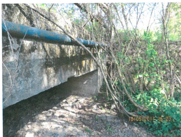
9. Vedere spre podeț din aval
