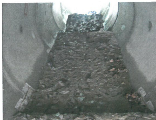
8. Vedere în tubul din beto armat a pereului și a rosturilor
