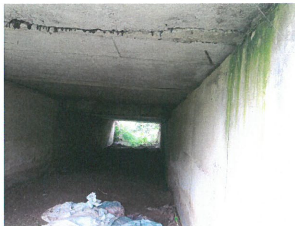
10. Vedere intrados dinspre amonte
