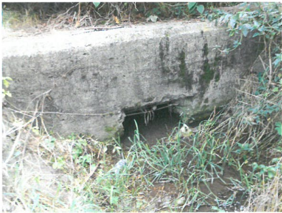
3. Vedere timpan amonte
