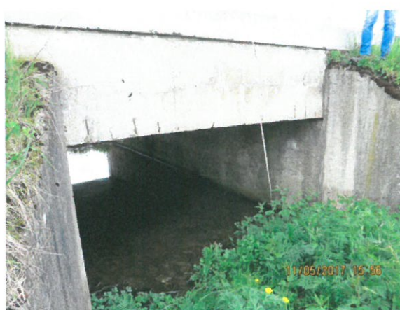
6. Vedere din amonte spre podeț CF – tip dală D3
