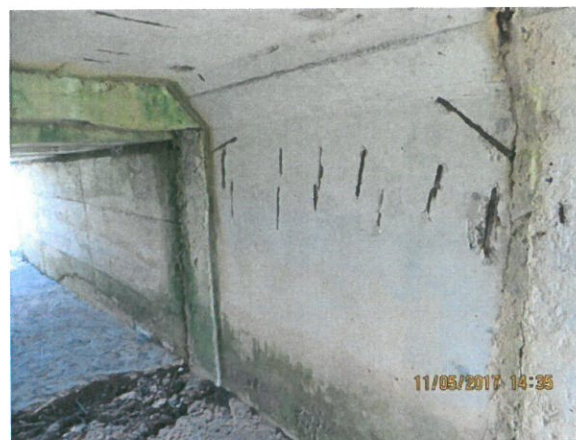
10. Armătură dezvelită la cadrele tip C2
