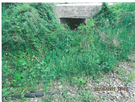
9. Vedere elevație aval
