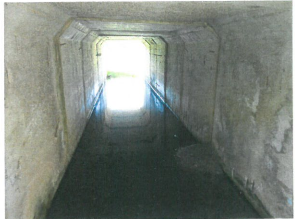
8. Vedere interior podeț dinspre amonte
