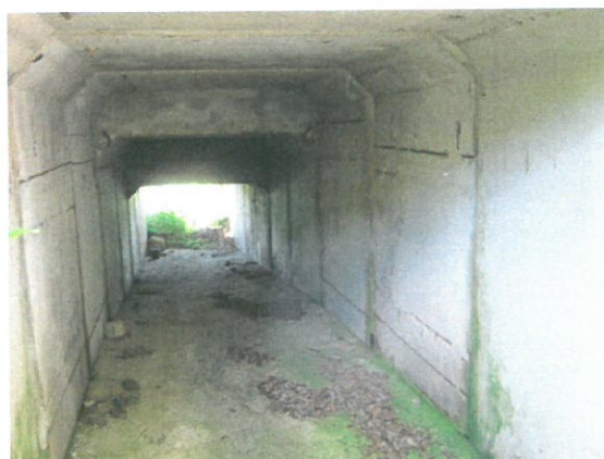
9. Vedere interior podeț dinspre amonte
