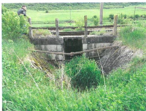
5. Colmatare albie aval
