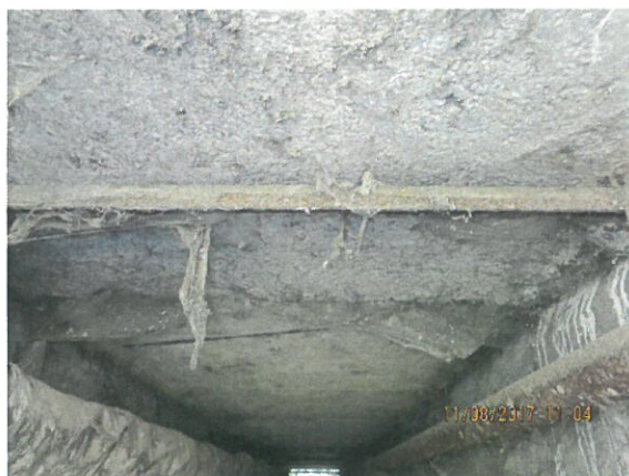
7. Vedere intrados dale dinspre amonte
