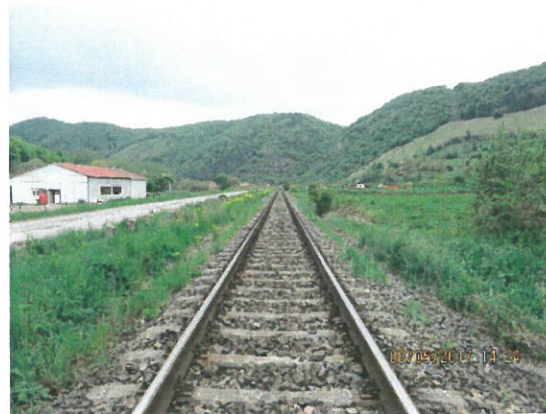
2. Vedere linii cf pe podet
