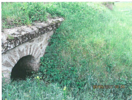
1. Vedere podet boltit
