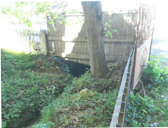
3. Vedere podet, din amonte
