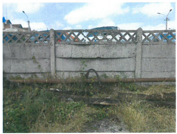
4. Vedere gard aval ce delimitează zona CFR
