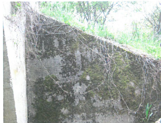
4.Vedere aripă dreapta amonte
