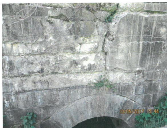
6. Detaliu timpan crăpat la cheia bolții din amonte
