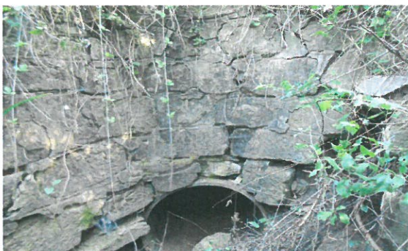
6. Vedere podeț tubular amonte
