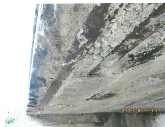
6. Degradări la intrados și armături la vedere
