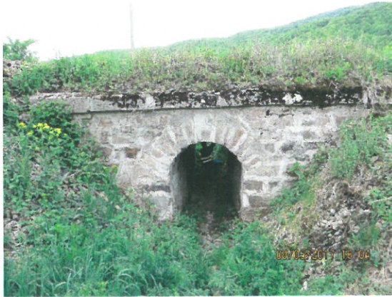
1. Vedere podet boltit
