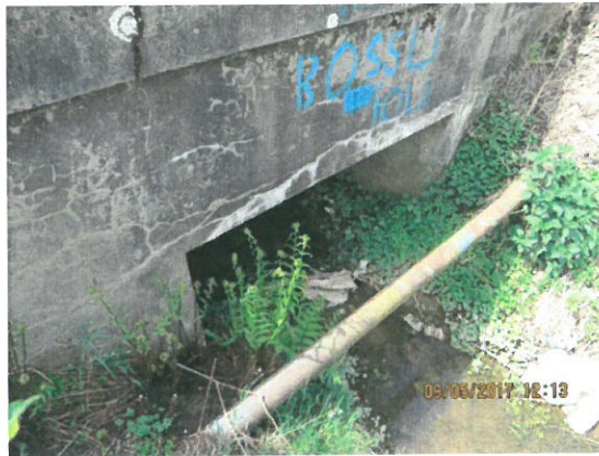
1. Vedere podet aval
