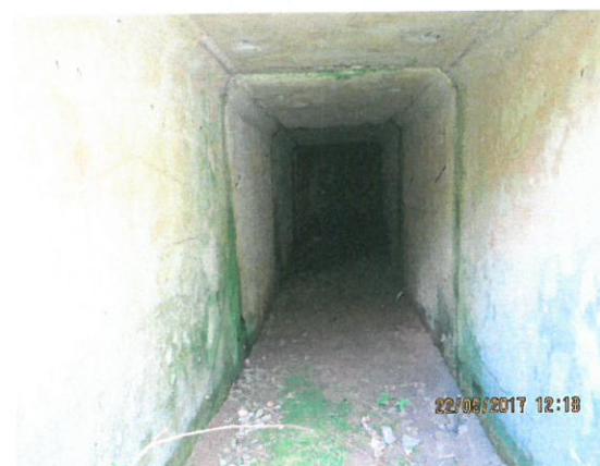
6. Vedere interior podeț dinspre amonte
