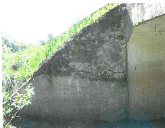
6. Aripă stânga din amonte
