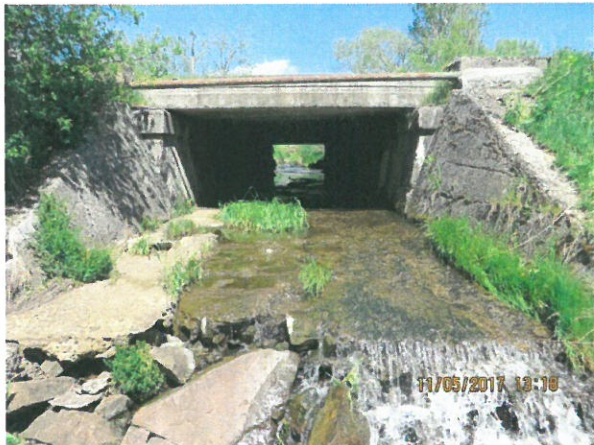
7. Vedere spre podeț din aval
