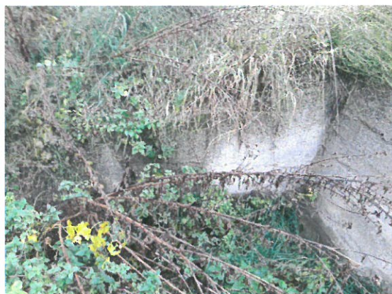
3.Vedere aripă stânga amonte
