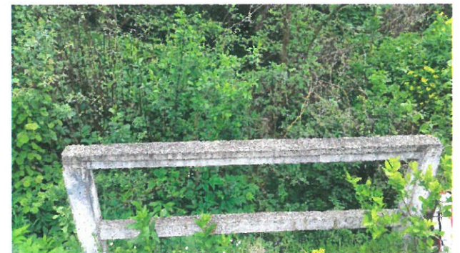
11. Vedere parapet din vecinătatea firului II
