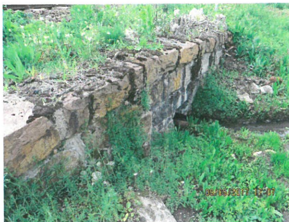
4. Vedere racordare cu terasamentul (dinspre amonte) – spre Oradea
