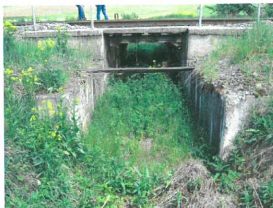
10. Vedere elevație aval
