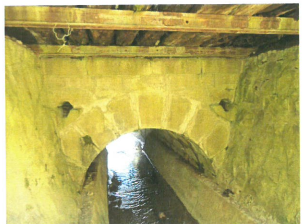
6. Interior podet din amonte
