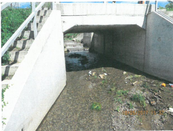
7. Vedere spre podeț din aval
