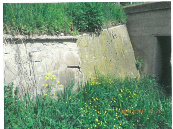
12. Vedere aripă și zid de sprijin aval (Oradea)
