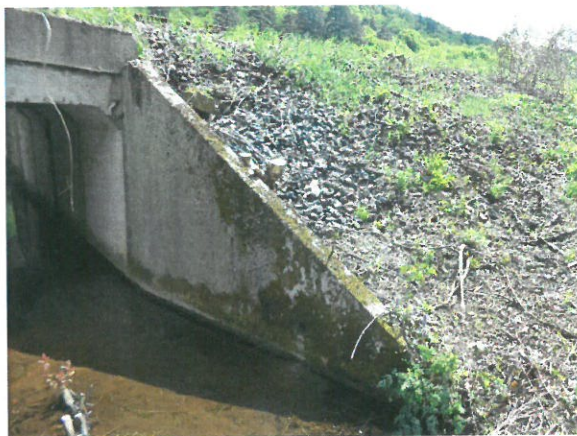
9. Vedere racordare cu terasamentul (dinspre aval) – spre Cluj
