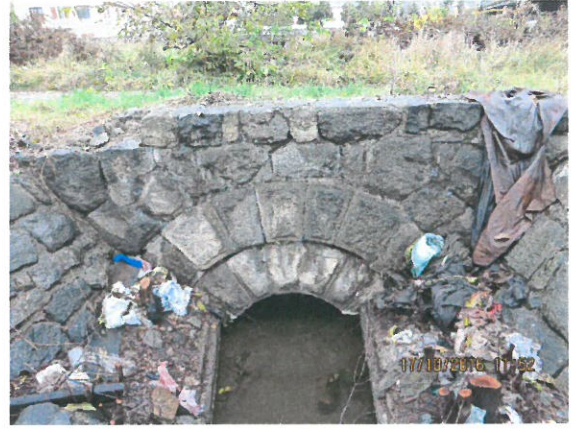
8. Vedere timpan amonte podeț boltit
