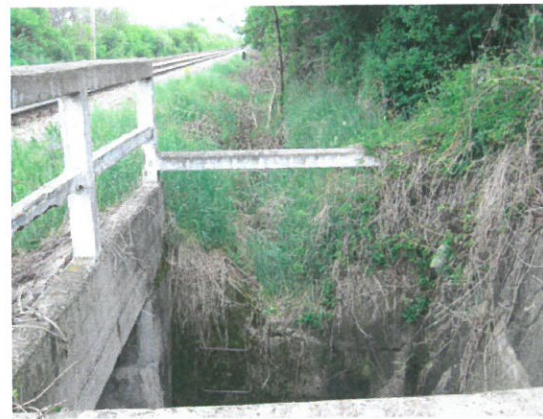
6. Vedere cameră de cădere și podeț amonte
