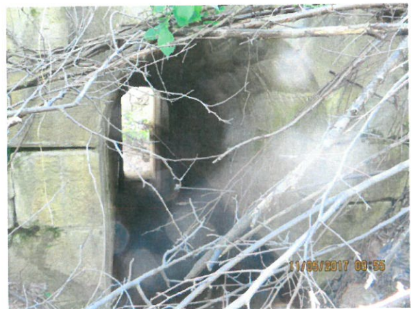
10. Interior podeț din aval
