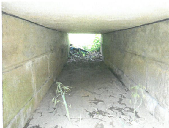
10. Vedere interior podeț din aval - pereu
