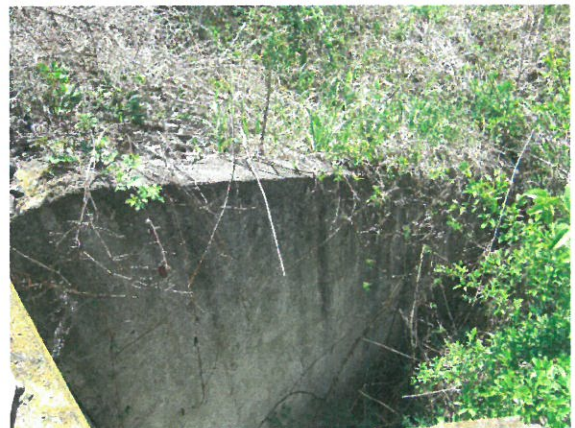
10. Acoperire cu vegetație a aripii prefabricate stânga aval
