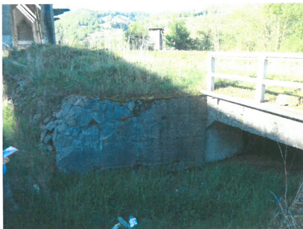
7. Aripă stânga dinspre amonte
