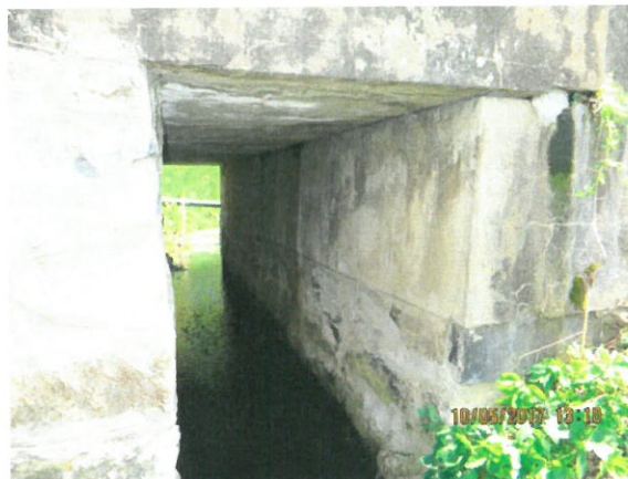
4.Vedere intrados dală, si elevație culee Cluj
