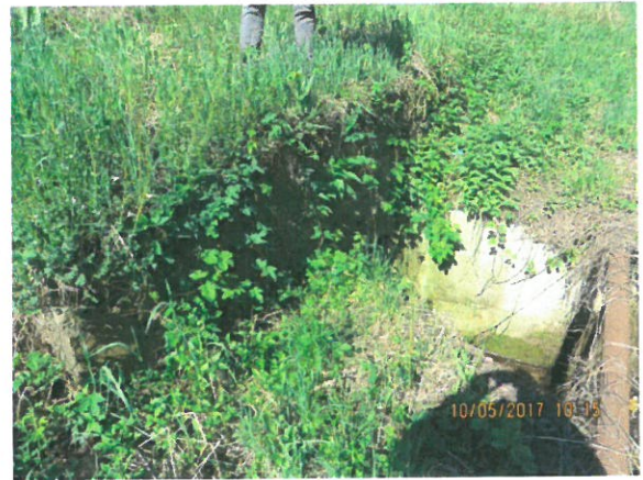
2. Vedere podet, din amonte
