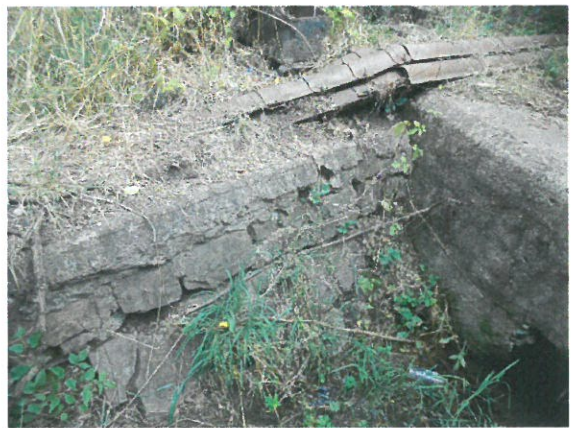
5. Vedere zid de sprijin albie amonte
