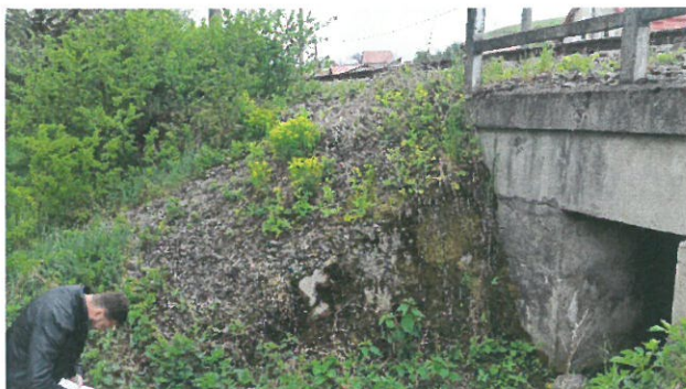
7.Vedere aripă dreapta aval
