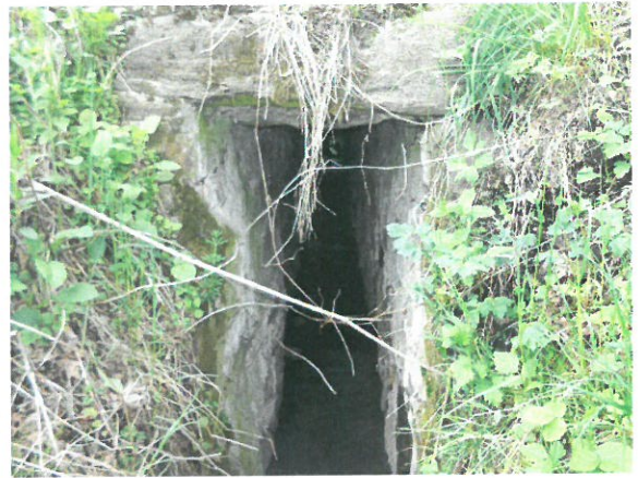
8. Vedere interior podeț (dinspre aval)
