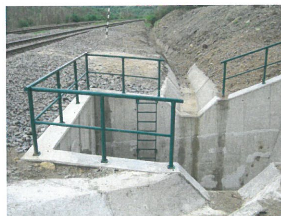
6. Vedere cameră de cădere amonte
