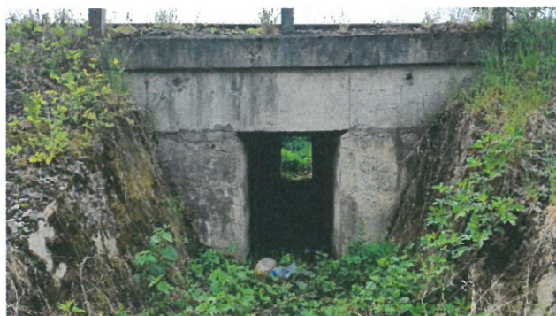
9.Vedere timpan aval
