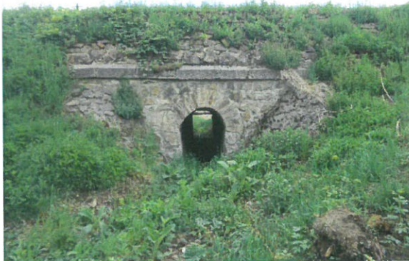
3. Vedere podet, din aval
