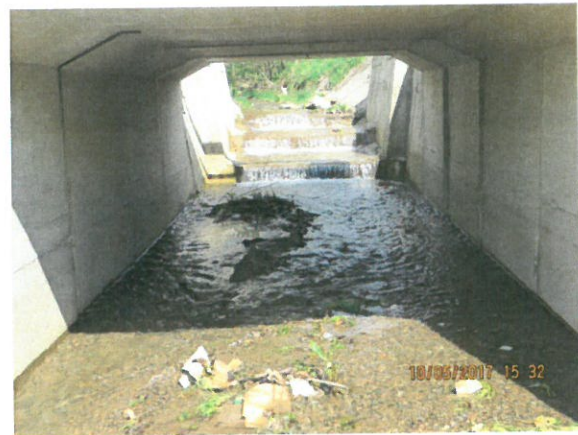
10. Interior podeț din aval
