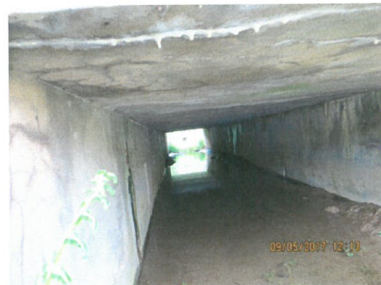
4. Vedere interior podet dinspre amonte
