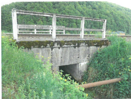
1. Vedere podet dala beton armat
