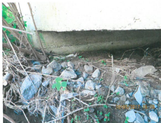
6. Vedere spre podeț - amonte stânga
