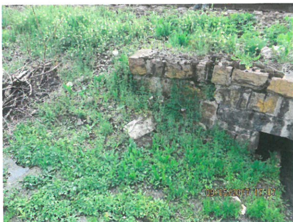
5. Vedere racordare cu terasamentul (dinspre amonte) – spre Cluj
