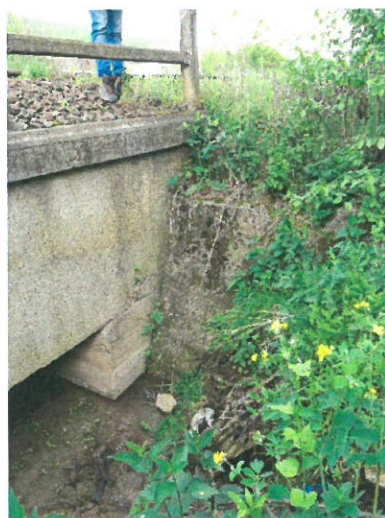
4. Vedere zid de sprijin dreapta amonte
