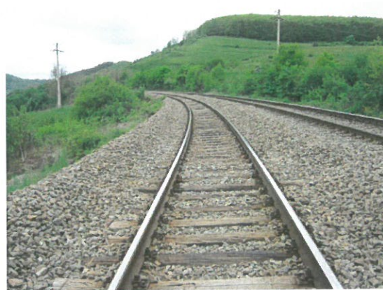
2. Șina și prinderea șinei de traverse, pe Firul 2
