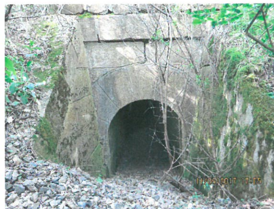
8.Vedere elevație aval
