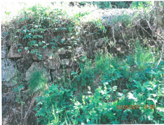
7. Vedere racordare cu terasamentul (dinspre aval) – culeea Cluj
