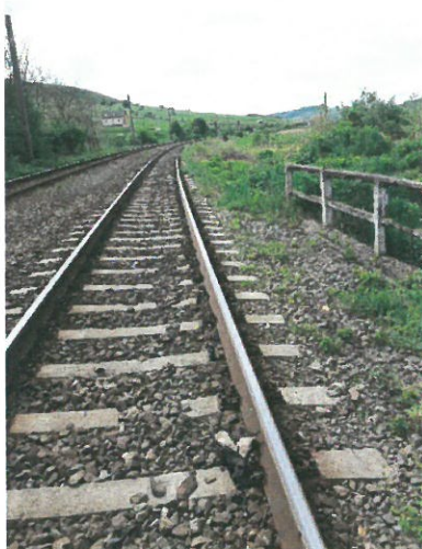
1. Șina și prinderea șinei de traverse, pe Firul I
