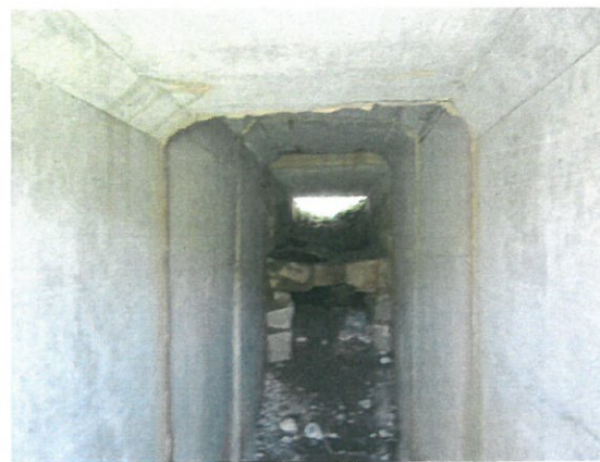
8. Colmatare cu material aluvionar
