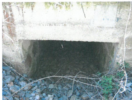
2. Vedere amonte podet, Firul 1
