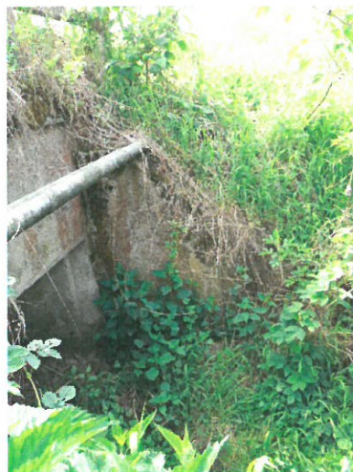
5. Vedere aripă stânga aval
