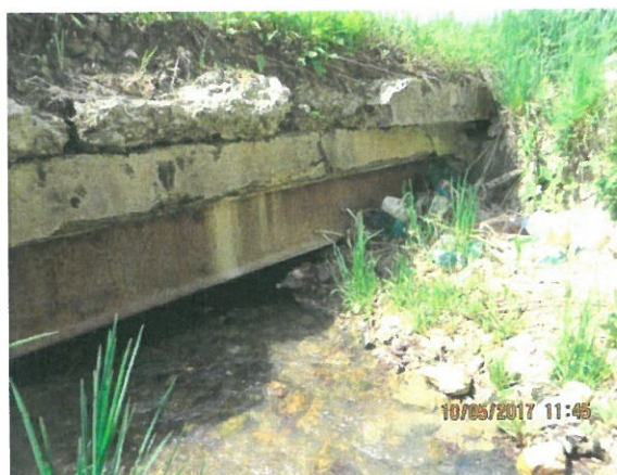
8. Vedere spre zid de sprijin amonte, si culee Cluj (1)
