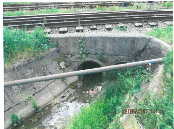
4. Vedere elevație amonte
