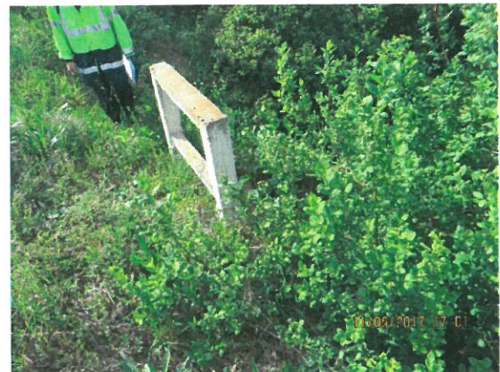
4.Vedere timpan amonte
