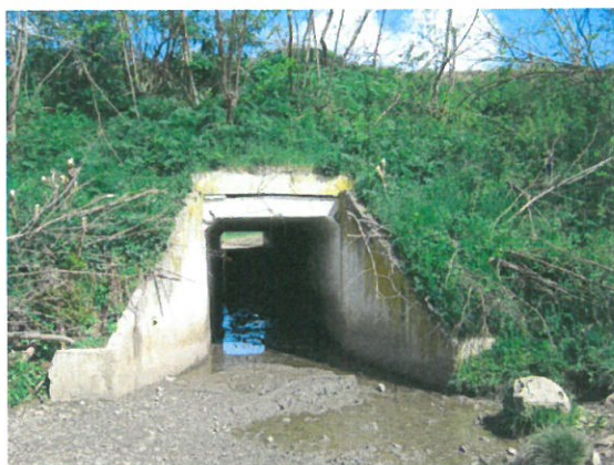
9. Vedere elevație aval
