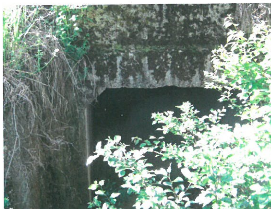
8. Vedere elevație amonte
