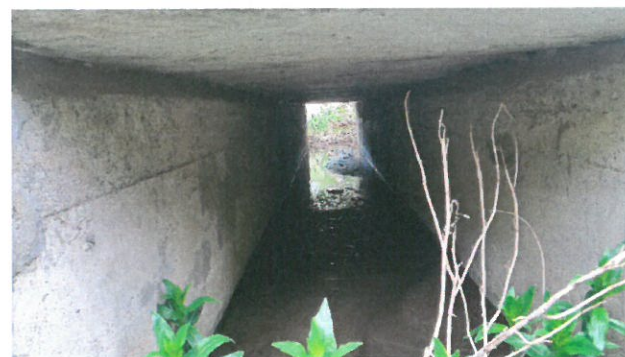
9. Vedere intrados podeț dinspre amonte
