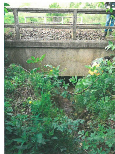
3. Vedere timpan amonte
