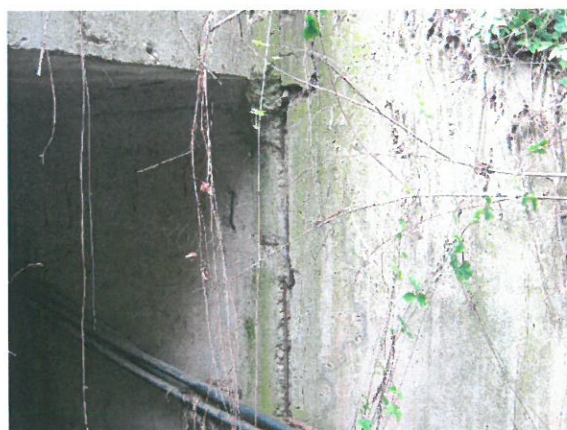
5.Rost cadru prefabricat – aripă stânga aval
