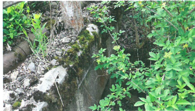
5.Pozare cablu în vecinătatea timpanului amonte
