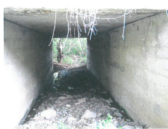
6. Vedere intrados podet dinspre amonte
