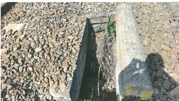
8. Vedere interspațiu între timpanele celor două suprastructuri
