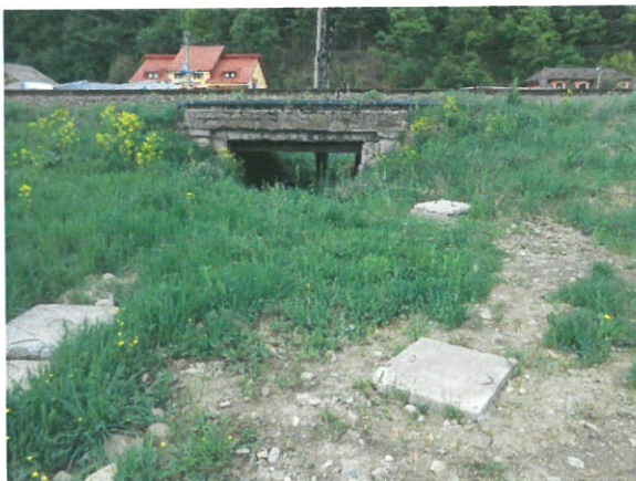
3. Vedere podet, din aval
