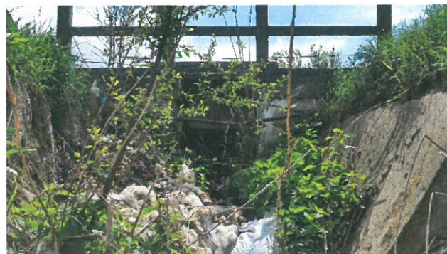
7. Vedere timpan aval
