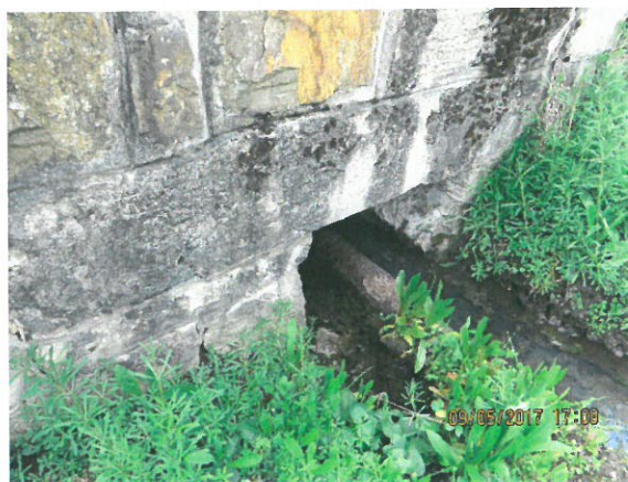
8. Vedere din amonte cu conducta ce traversează podețul prin interior
