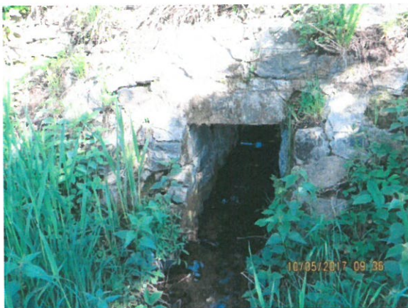
3. Vedere podet, din aval
