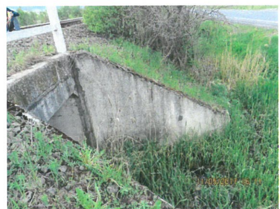
6. Vedere timpan amonte
