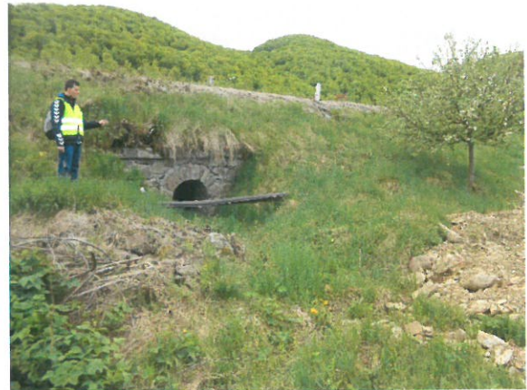
4. Vedere racordare cu terasamentul (dinspre amonte) – culeea Oradea
