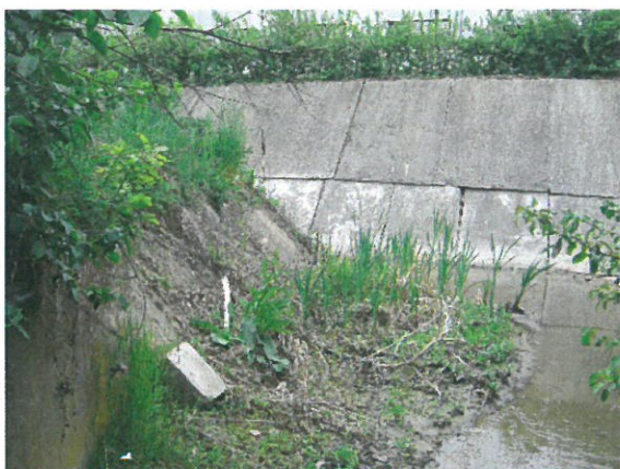
9. Vedere mal dreapta albie amonte
