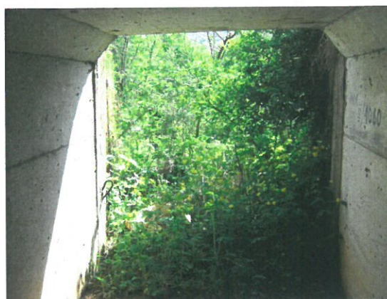
8.Vedere amonte din interiorul podețului
