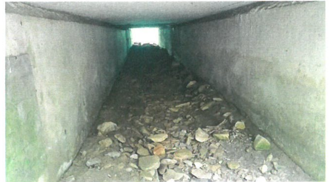
7.Vedere intrados podeț dinspre amonte
