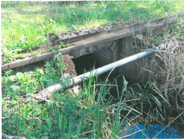
7. Vedere din aval spre podeț
