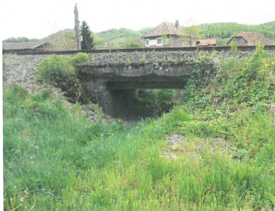
2. Vedere podet, din amonte
