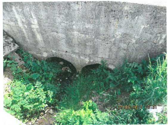
10. Vedere podeț tubular din aval
