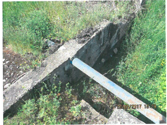
8. Vedere conductă în interiorul podețului
