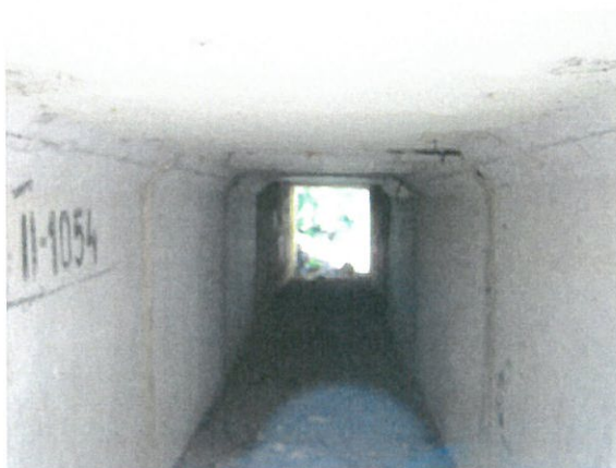
9.Vedere intrados cadre prefabricate
