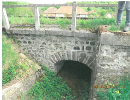
2. Vedere podet boltit aval
