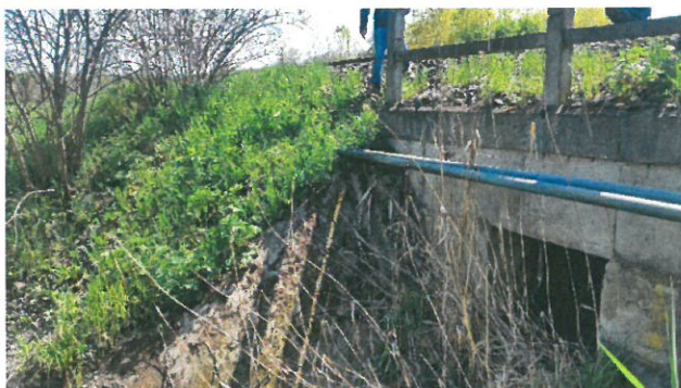
8. Vedere aripă dreapta aval
