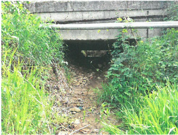
7. Vedere timpan aval
