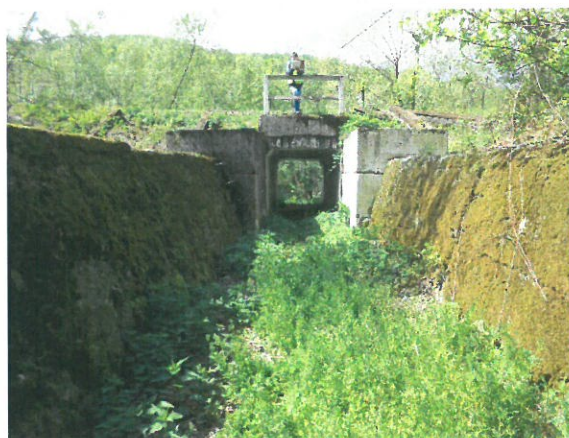
2. Vedere podet, din amonte
