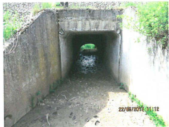
4.Vedere elevație amonte
