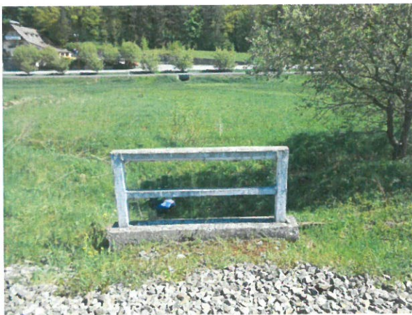
3. Vedere spre amonte
