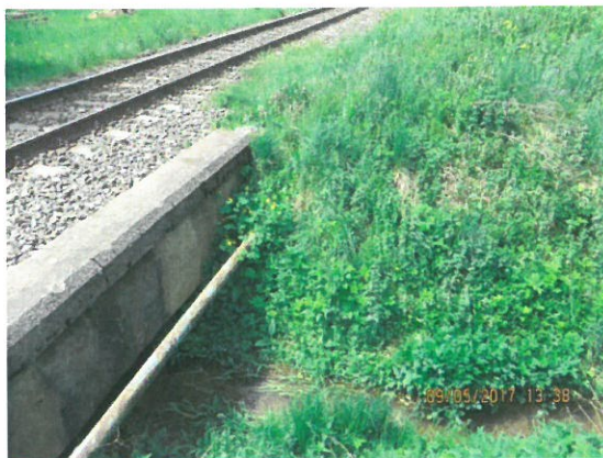
1. Vedere cale pe podeț
