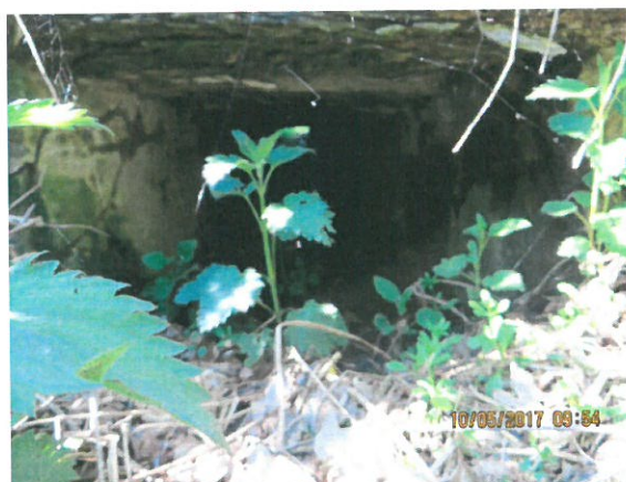
6. Vedere interior podet din amonte
