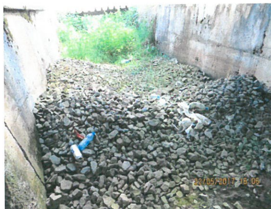
8.Vedere interior podeț colmatat cu piatră spartă
