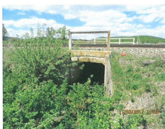
12. Vedere spre podeț din aval
