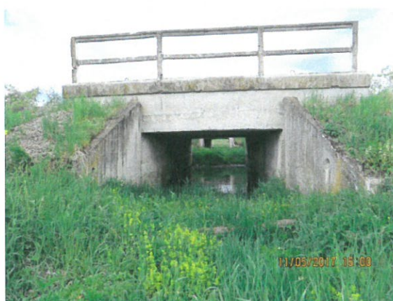
11. Vedere din aval spre podeț CF
