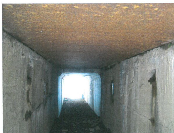
11.Vedere intrados suprastructură fir II
