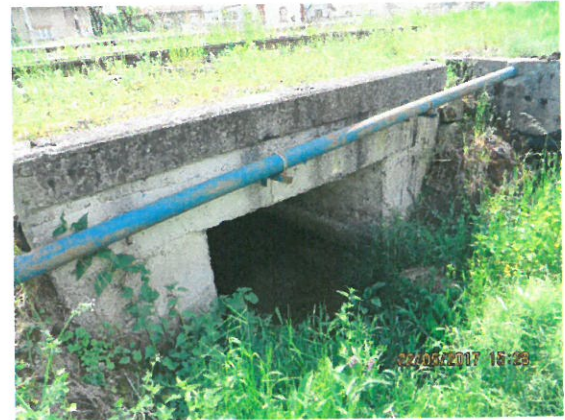
4. Vedere elevație amonte
