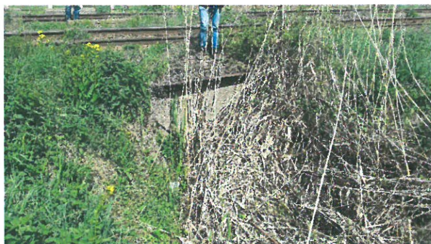
6. Vedere timpan amonte
