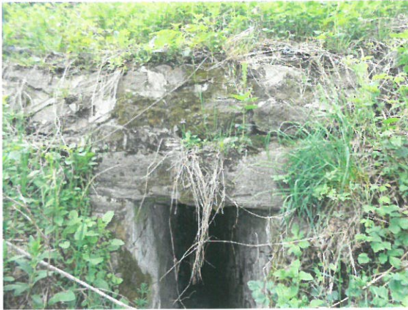
7. Vedere culei, dala marginală și timpan (dinspre aval)
