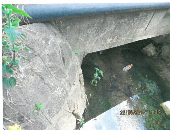
9. Vedere elevație aval
