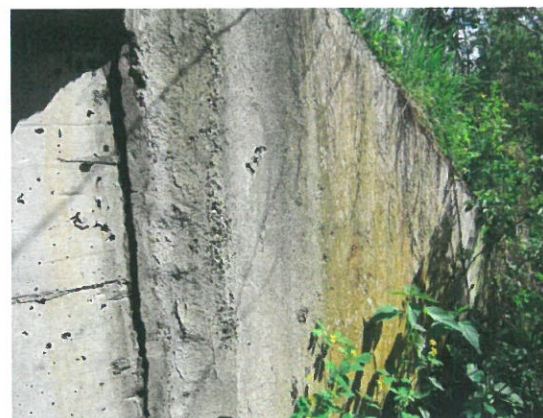
6. Vedere aripă prefabricată amonte
