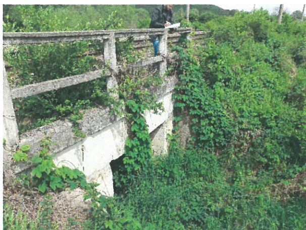
7. Vedere aripă dreapta amonte
