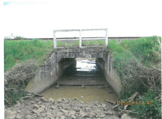
6. Vedere din amonte spre podețul CF
