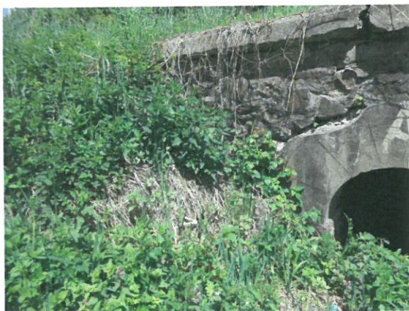
7. Vedere racordare cu terasamentul (dinspre aval) – culeea Oradea – degradări (crăpături beton coronament, bucăți de beton desprinse din boltă, etc.)
