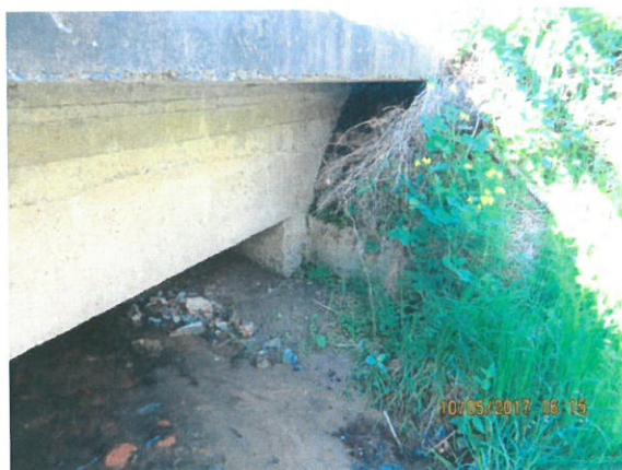
5. Vedere spre podeț tip dală D4 – amonte dreapta
