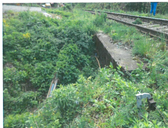
4. Vedere racordare cu terasamentul (dinspre amonte) – spre Cluj
