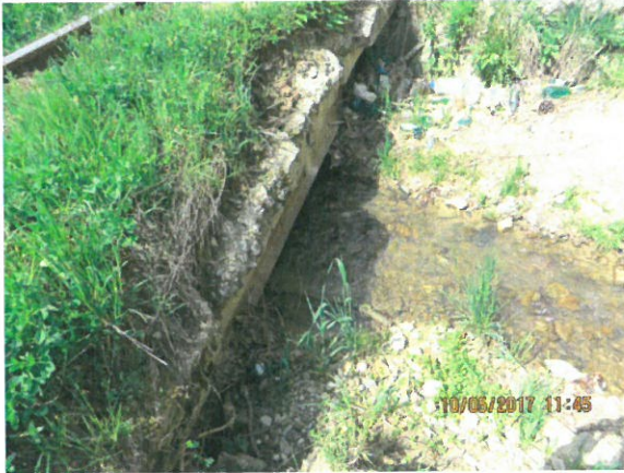
3. Vedere podet, din amonte
