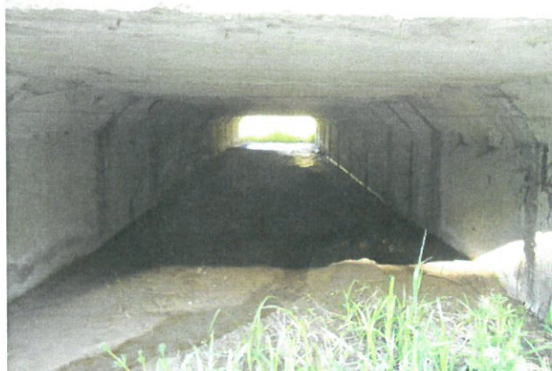
8. Vedere interior podeț dinspre amonte
