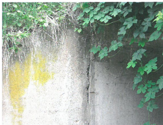
8. Rost aripă stânga amonte – cadru prefabricat
