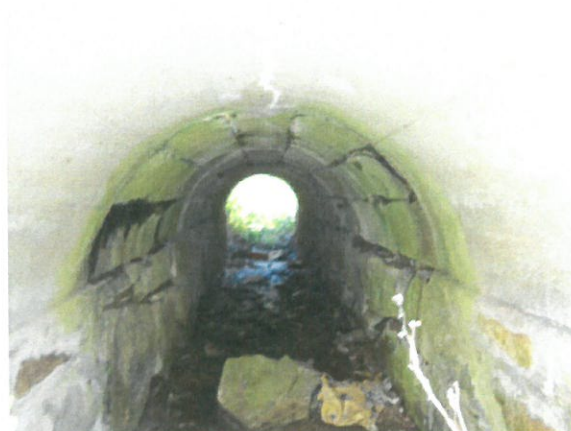
10. Vedere interior podeț dinspre aval- degradări (moloane sparte, carbonatări, infiltrații, colmatare, etc.)
