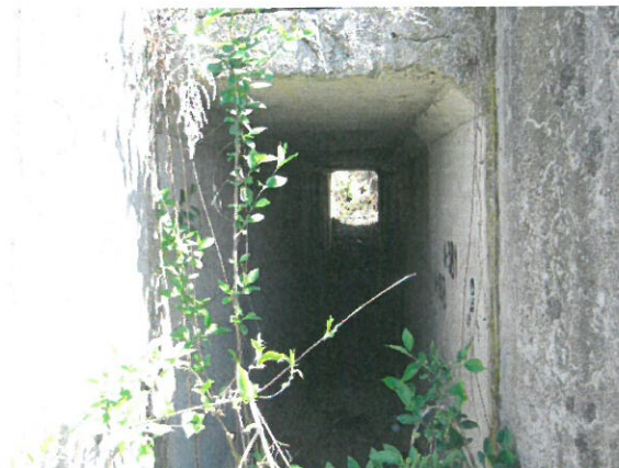
9. Faianțarea betonului aripii stângi aval
