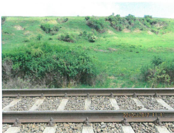
3.Vedere albie amonte
