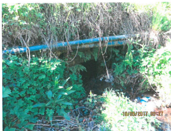
2. Vedere podet, din amonte
