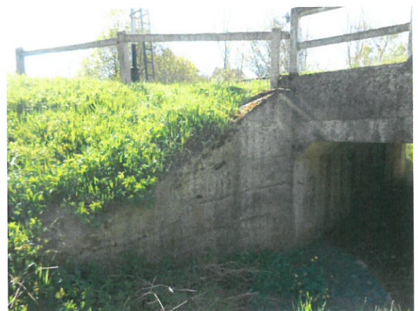
6. Aripă stânga din amonte
