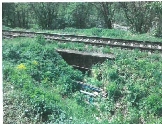
2. Vedere podet, din amonte
