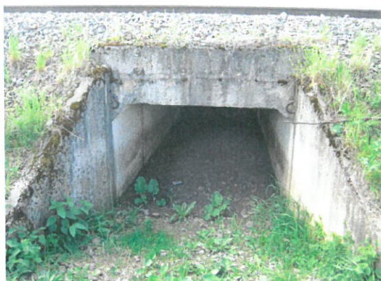
9. Vedere elevație aval
