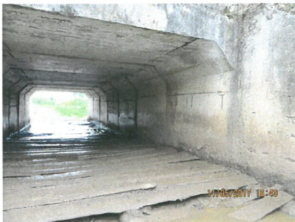
7. Vedere interior podeț - cadru tip C3
