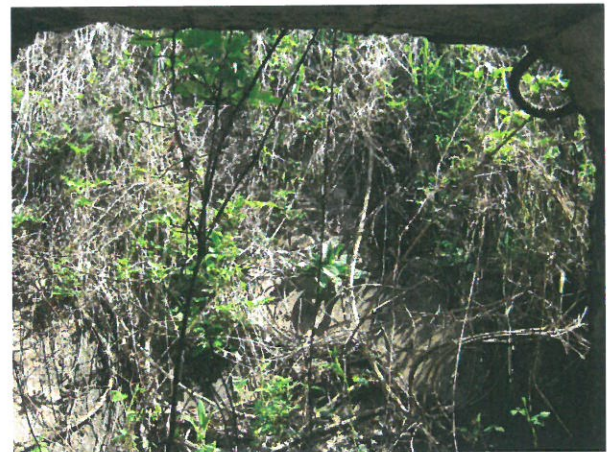
12. Vedere zid de sprijin amonte
