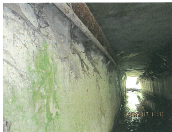
12. Vedere elevație culee Cluj
