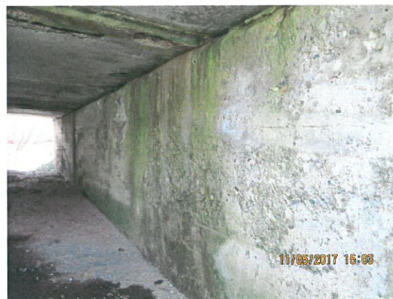
6. Vedere culee dreapta din amonte
