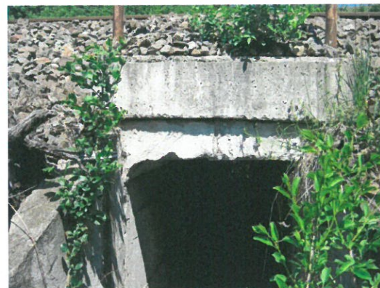
4.Vedere aval podeț
