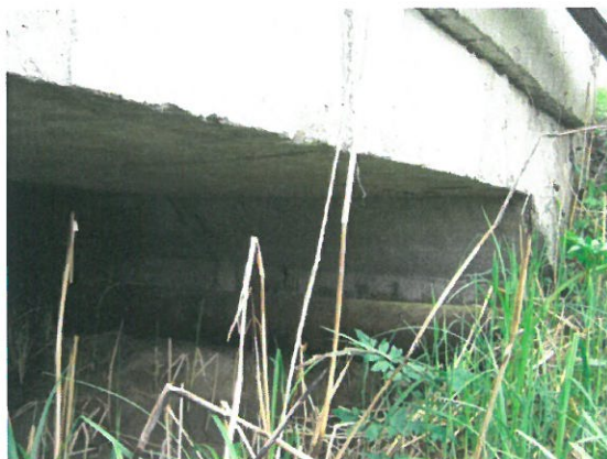
7. Vedere intrados podeț
