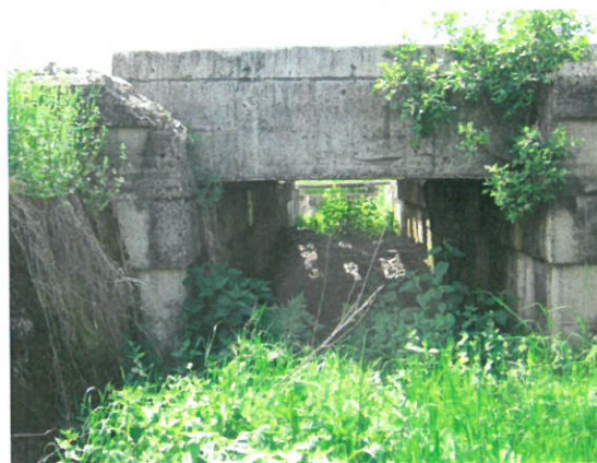
4.Vedere elevație amonte
