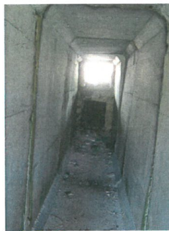
12. Vedere intrados podet din cadre prefabricate
