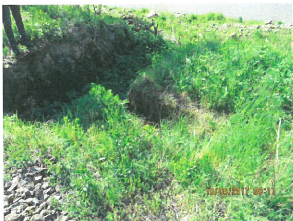
7. Vedere racordare terasament-albie (dinspre aval) – culeea Cluj;
