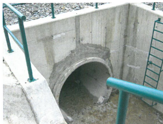
4. Vedere elevație amonte
