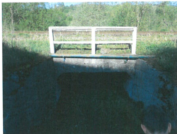
5. Vedere spre podeț din amonte – cadru tip C3
