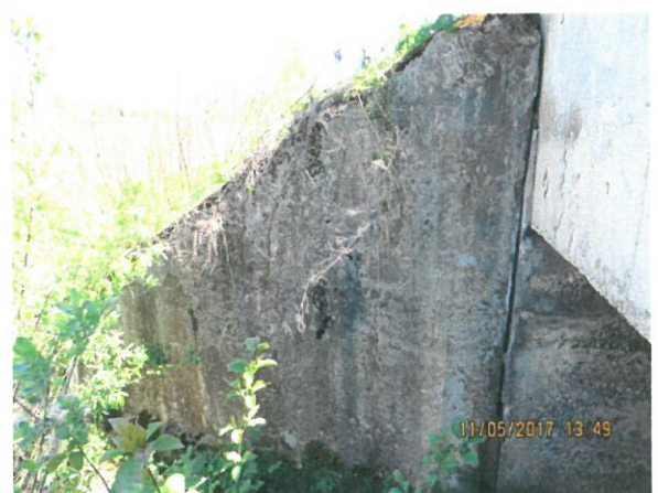
6. Aripă stânga dinspre amonte
