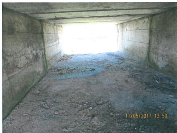
9. Interior podeț spre aval
