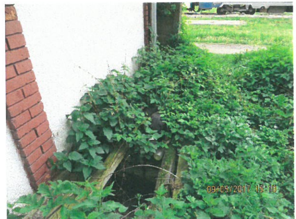
6. Vedere racordare amonte
