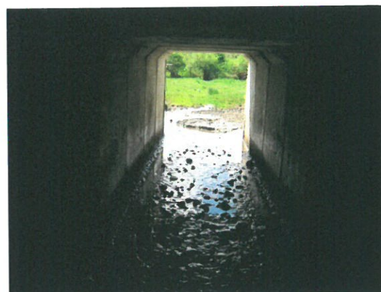
6. Vedere interior podet colmatat dinspre amonte
