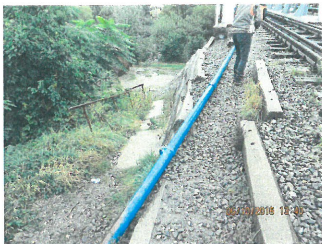
7. Pozare cabluri fir I. Culeea Oradea
