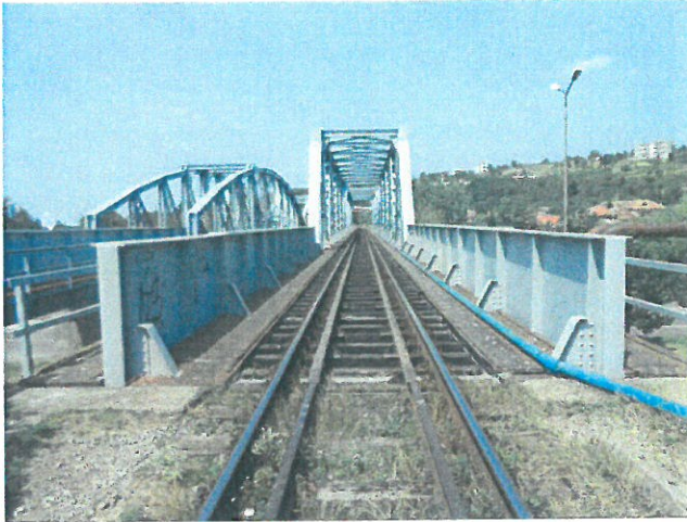
1. Calea și tipul traverselor pe Firul I. Contrașine.
