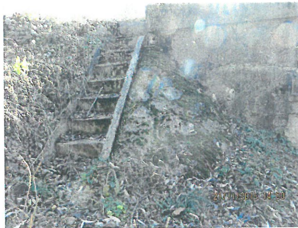
21. Sfert de con și scări de acces Culeea Cluj Napoca, Aval
