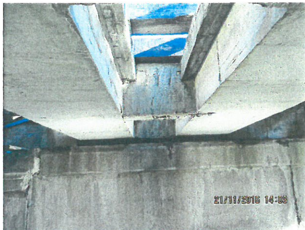
7.Vedere intrados tablier de beton, pe Firul II
