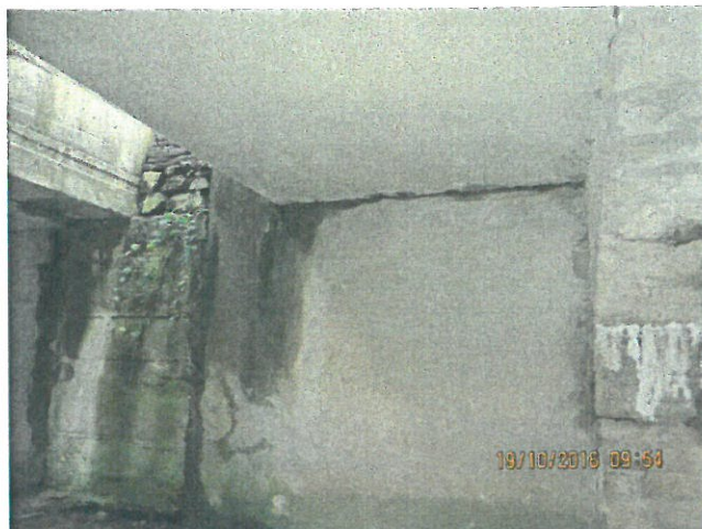
13. Vedere intrados dală. Infiltrații culee Oradea.
