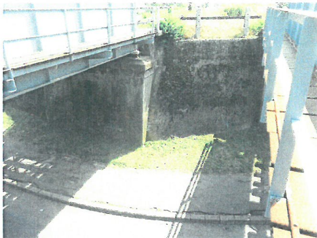
7. Vedere culee Cluj fir I.
