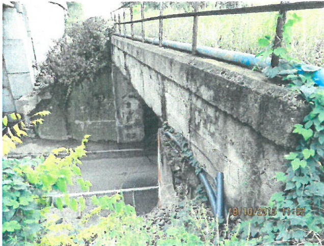
7. Parapet metallic și pozare conducte fir I. Vedere înspre culeea Cluj
