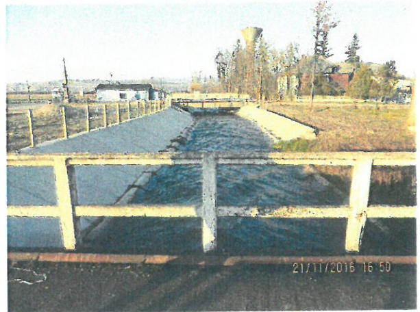
14. Vedere albie, Aval
