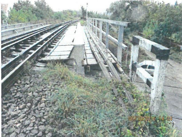
3. Calea și tipul traverselor pe firul II.
