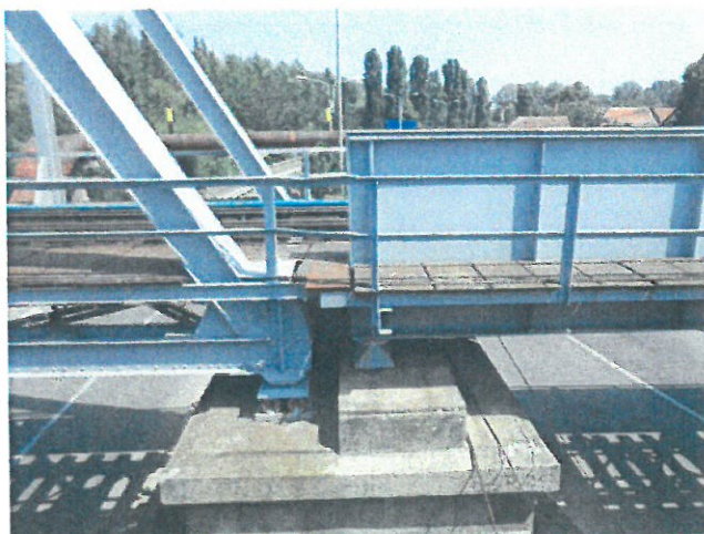
5. Vedere aparate reazem (mobil și fix) fir I pe pilă.
