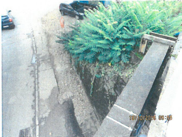
15. Vedere aripă culee Cluj (fir I)
