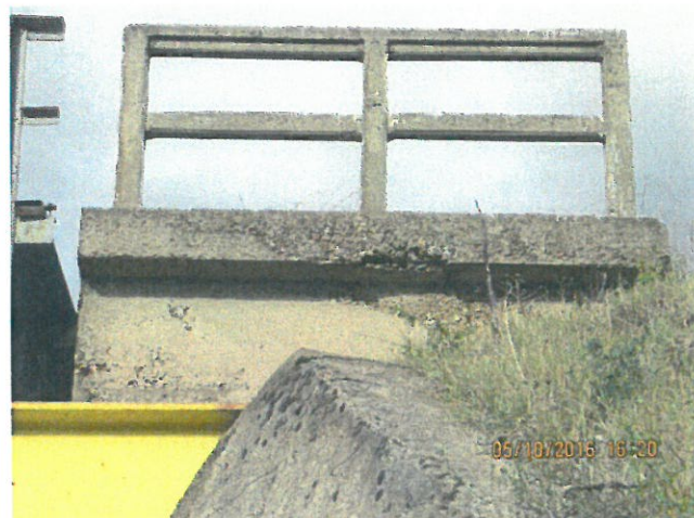
15. Detaliu parapet beton fir II. Culee Oradea
