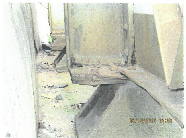
6. Vedere aparat reazem și bancheta culee Episcopia Bihor
