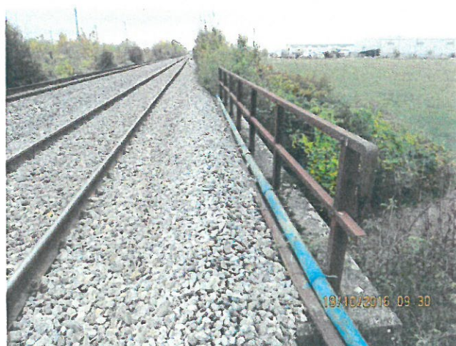
5. Conducte cabluri firul I
