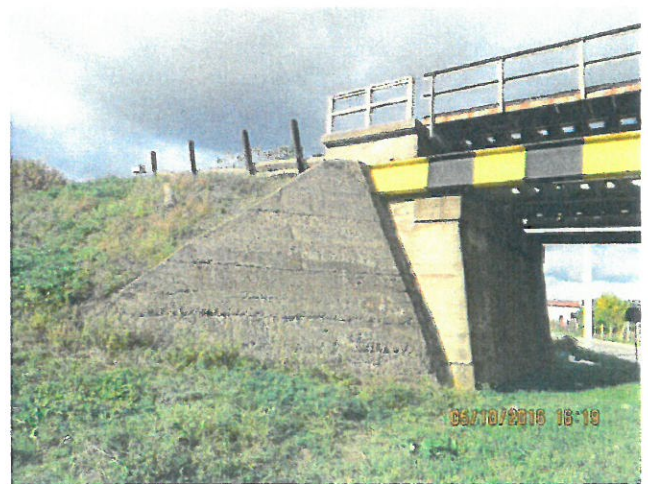
12. Vedere aripa culee Episcopia Bihor fir II.
