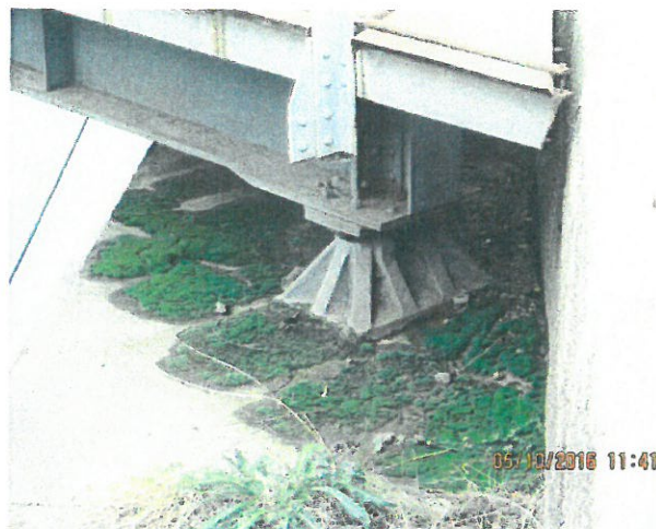
13. Detaliu aparat reazem si bancheta culee Episcopia Bihor fir II
