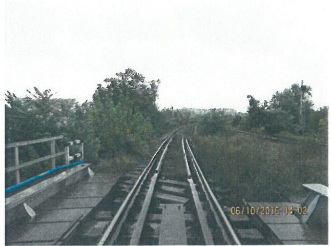
2. Calea și tipul traverselor pe firul I. Contrașine.
