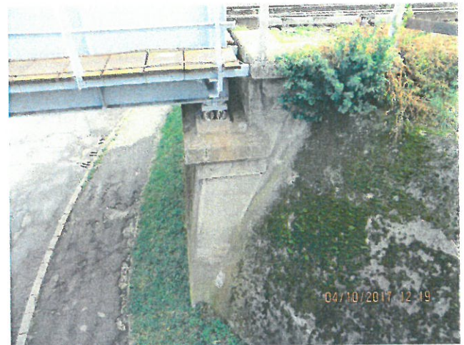
4. Vedere culee Cluj. Grinda principală și parapet fir I
