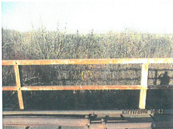
13.Vedere albie Amonte
