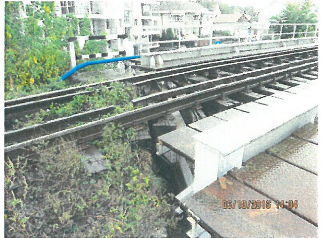
14. Zona rost culeea Cluj.
