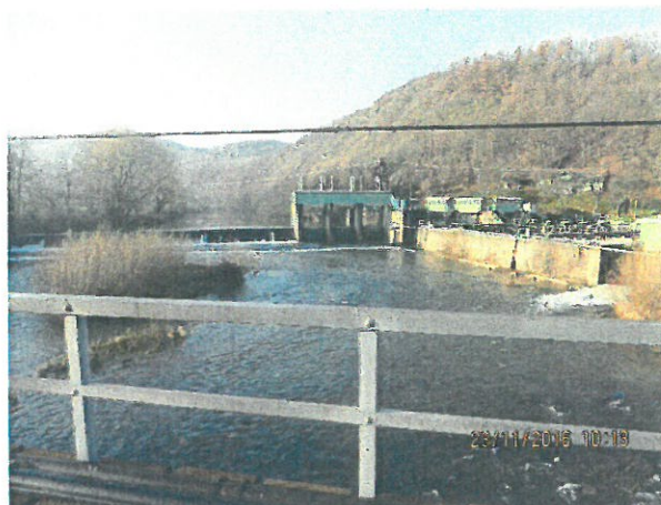
20.Vedere albie, Amonte
