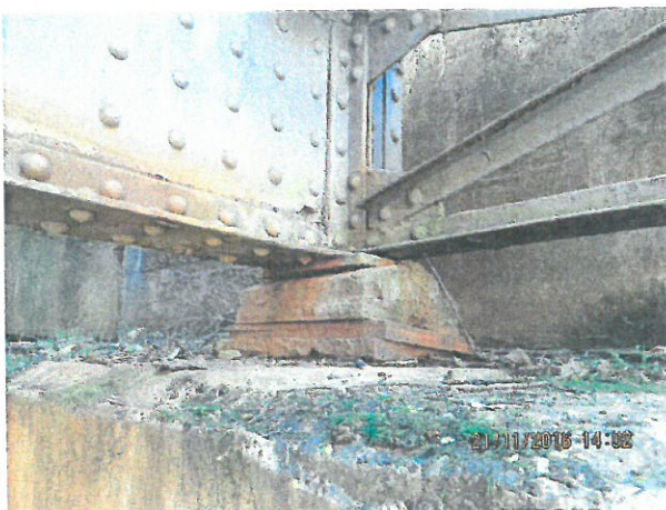
17.Aparat de reazem mobil Culeea Oradea, pe Firul I
