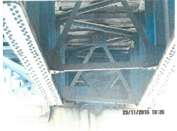
8. Vedere intrados tablier G.I.P.C.S.N. L=19.40m
