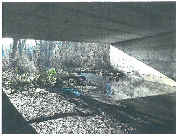
14.Vedere albie Aval
