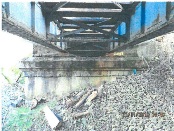
4.Vedere intrados tablier G.I.P.C.S. – nituit, pe Firul I
