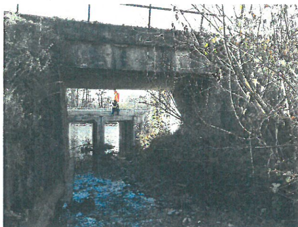
13.Vedere albie sub pod
