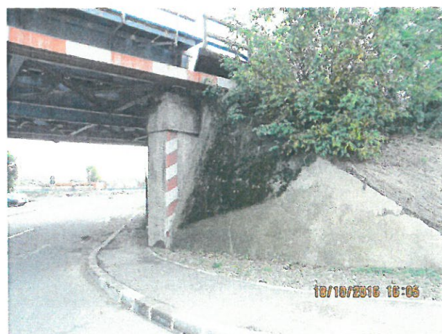
11. Vedere tablier fir I. Culeea Oradea
