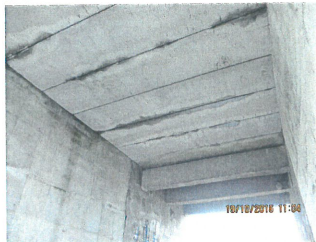
16. Vedere intrados tabliere, pe Firul II și firul III. Infiltrații în zona rosturilor grinzilor tablier fir II.
