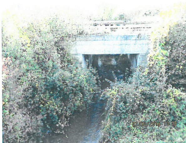
14.Vedere albie Amonte
