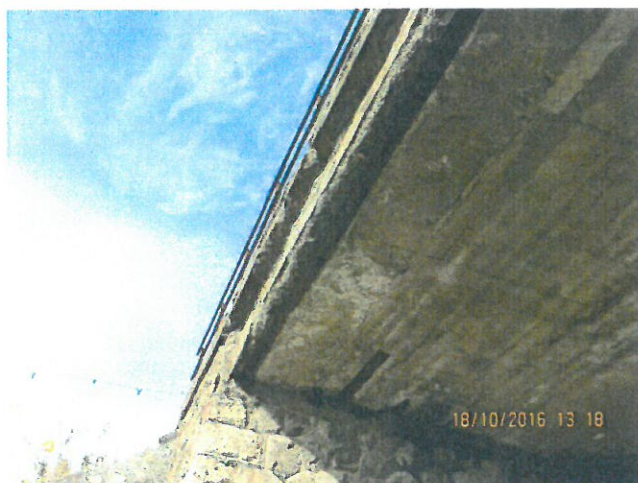
15. Vedere intrados tablier fir II. Culee Oradea
