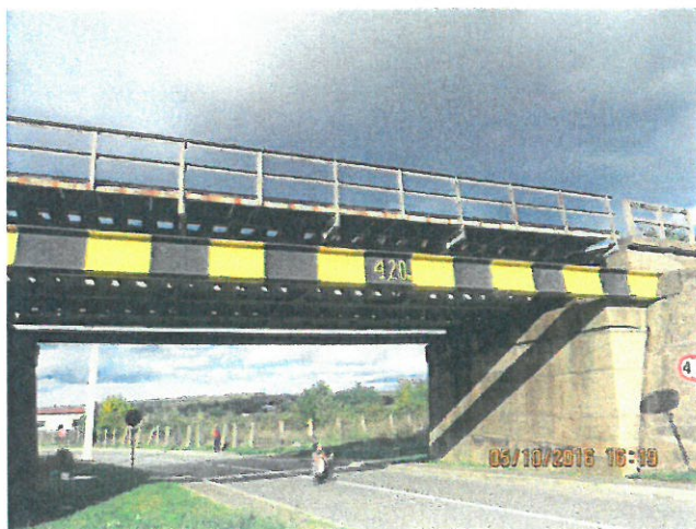
11. Vedere tablier fir II. Culee Oradea
