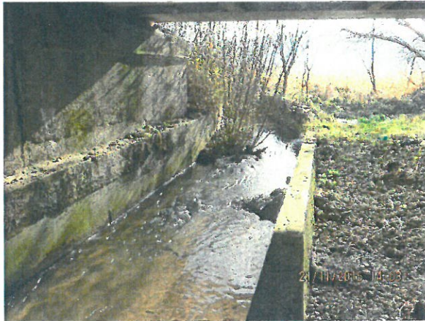
27.Vedere albie sub Pod
