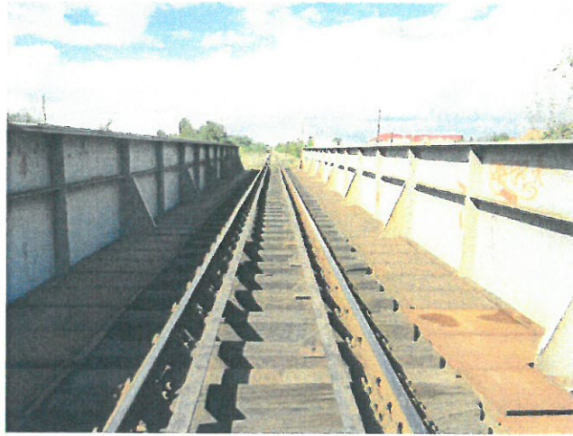
1. Calea și tipul traverselor pe firul I. Vedere spre Episcopia Bihor
