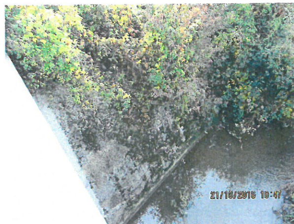
10. Aripă monolită de beton, culeea Cluj Napoca, Amonte
