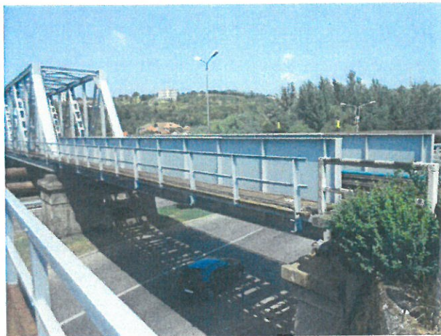
3. Tablier fir I. Grinda principală și parapet
