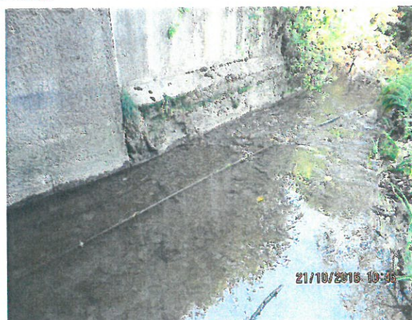
12. Vedere albie Aval
