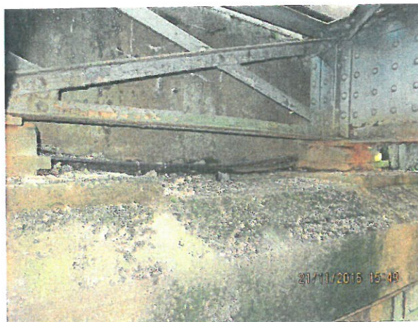
8. Aparat de reazem fix culee Cluj Napoca
