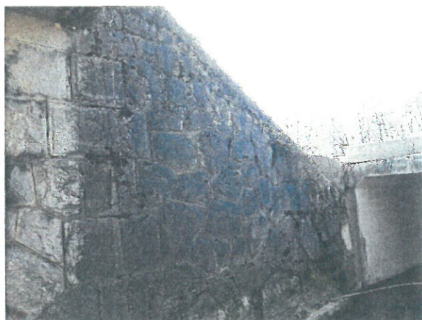
11. Aripă de beton culee Cluj Napoca, Aval
