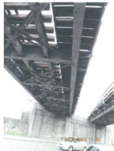
6. Vedere intrados tablier fir II
