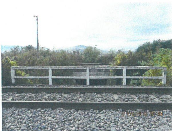
3.Trotuar și parapet, în Amonte
