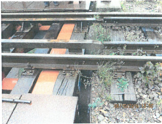
3. Sine, contrașine, traverse fir II
