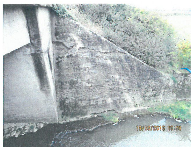
24. Vedere pod aval (firul I). Aripă culee Oradea
