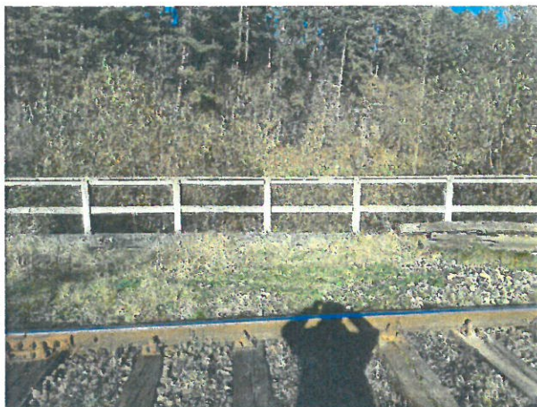
3.Parapet de beton, în Amonte
