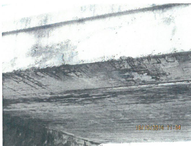
11. Vedere intrados tablier
