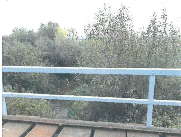
12. Vedere albie Amonte
