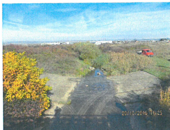
16. Vedere albie Aval
