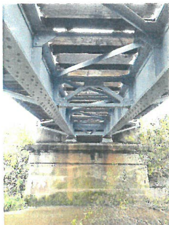
3.Vedere intrados tablier G.I.P.C.S. - nituit
