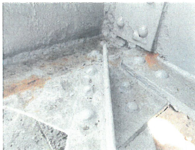
12. Detaliu îmbinare grindă, antretoază și contravântuiri
