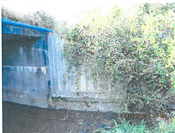
9. Aripă prefabricată de beton, culeea Oradea, Aval
