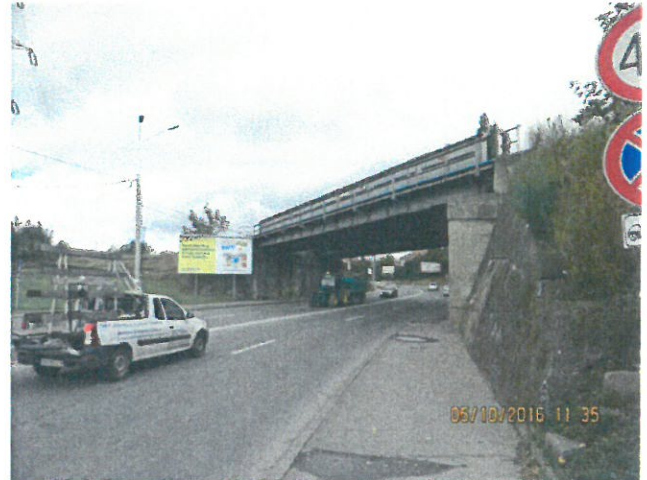
4. Vedere tablier fir II
