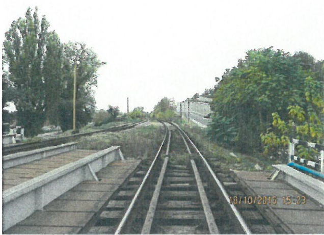
1. Calea și tipul traverselor pe firul I. Contrașine.
