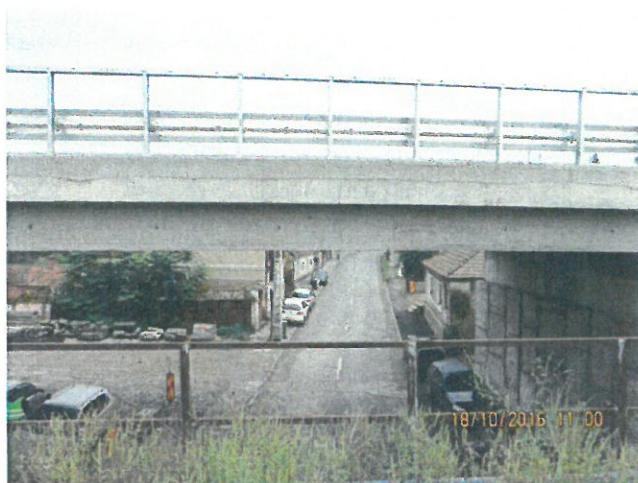
3. Parapet metalic fir I
