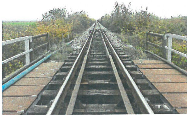
2. Calea, prinderea ei, tipul traverselor și contrașinelor pe Firul I
