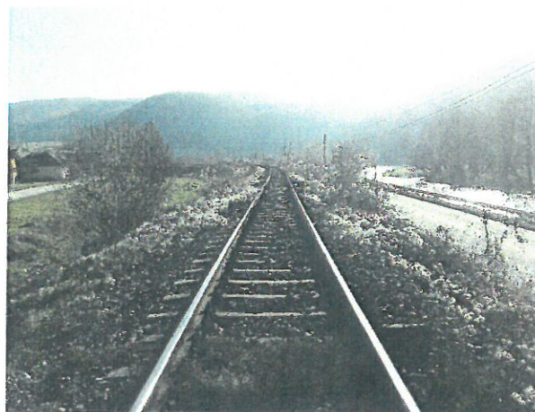
2.Calea și tipul traverselor pe Firul II
