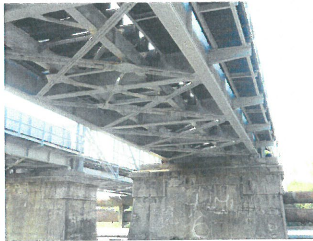
16. Vedere intrados tablier fir I.
