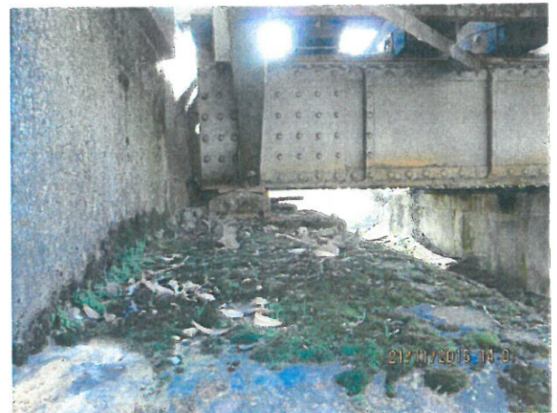
16.Aparat de reazem fix Culeea Cluj Napoca, pe Firul I
