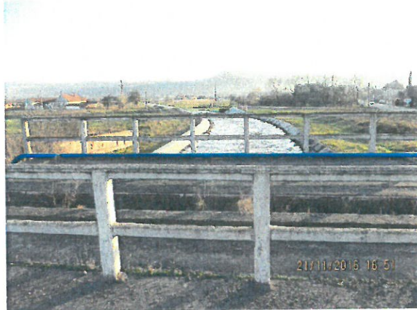
15. Vedere albie, Amonte
