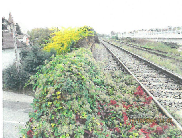
5. Calea și tipul traverselor pe firul II. Vedere spre Oradea
