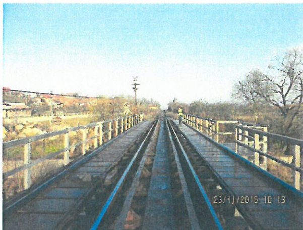
1. Calea, tipul traverselor și contrașinei pe Pod
