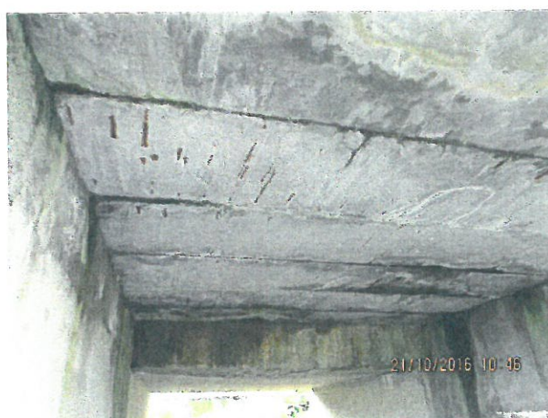
5.Vedere intrados tablier cu dale prefabricate de beton pe firul I
