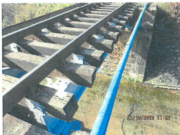
15. Vedere albie sub Pod
