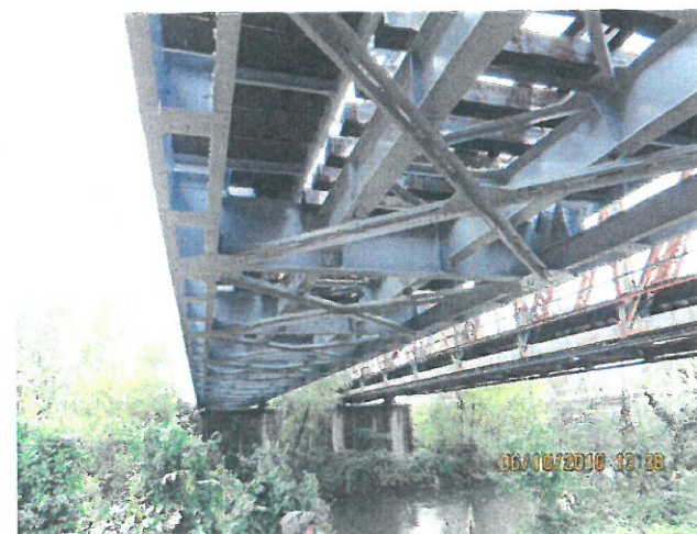
6. Vedere intrados tablier fir I.
