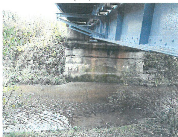
13. Vedere albie sub Pod
