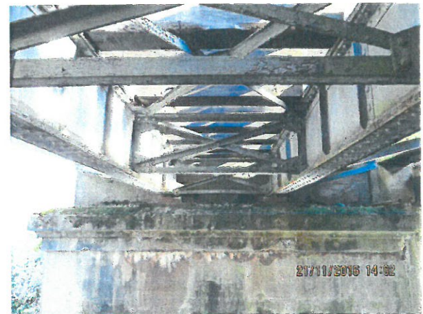
6. Vedere intrados tablier metalic G.I.P.C.S. - nituit, pe Firul I
