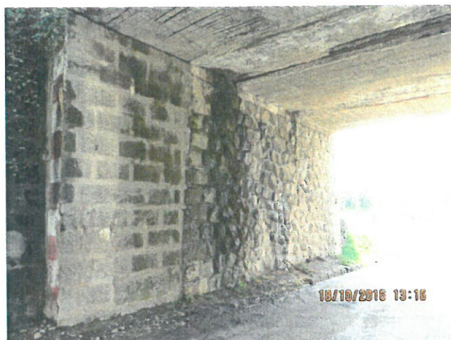
9. Vedere culee Cluj și intrados tablier (fir I și II)
