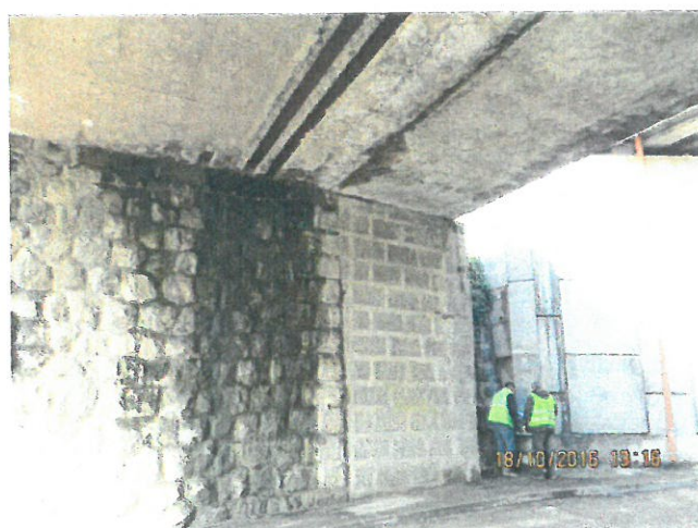
11. Vedere intrados tablier fir I culee Oradea. Degradări
