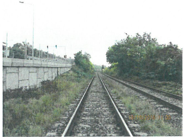
2. Calea și tipul traverselor pe firul I. Vedere spre Cluj
