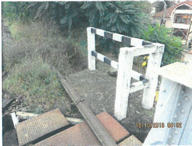
9. Vedere parapet beton fir I.
