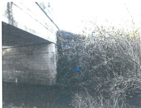
12. Aripă de beton Culee Oradea, în Amonte
