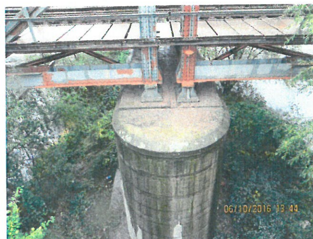
16. Vedere banchetă rezemare pile. Aparate de reazem
