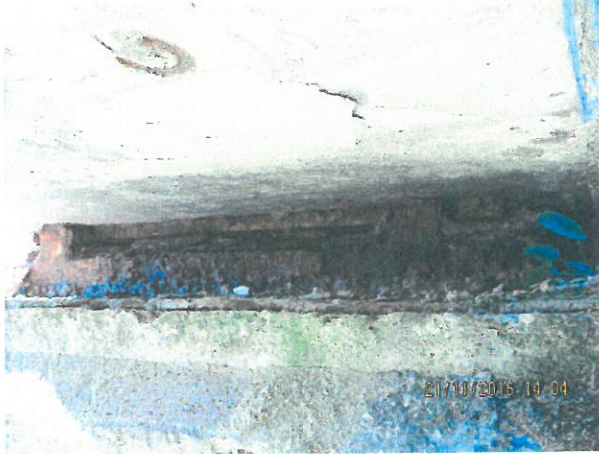
19. Aparat de reazem fix Culeea Oradea, pe Firul 3
