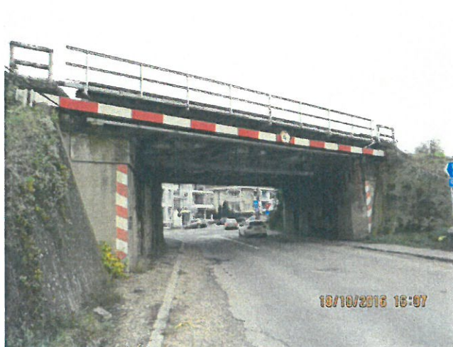
15. Vedere tablier fir II
