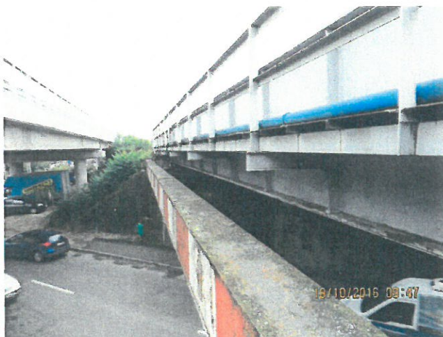
5. Parapet metalic și pozare conducte fir I. Aripă culee Cluj
