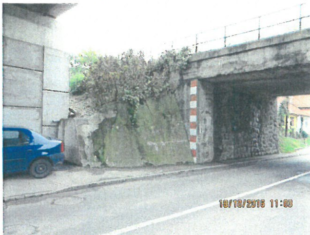
9. Vedere aripă și scară acces culeea Cluj. Fir I
