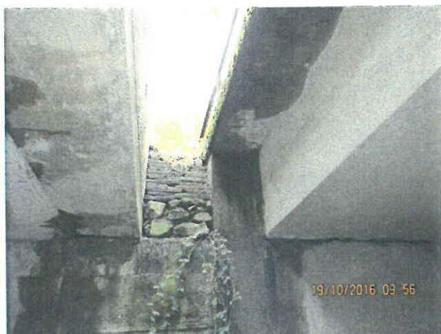
15. Spațiu între tablierul firul I și II și tablierul dezafectat
