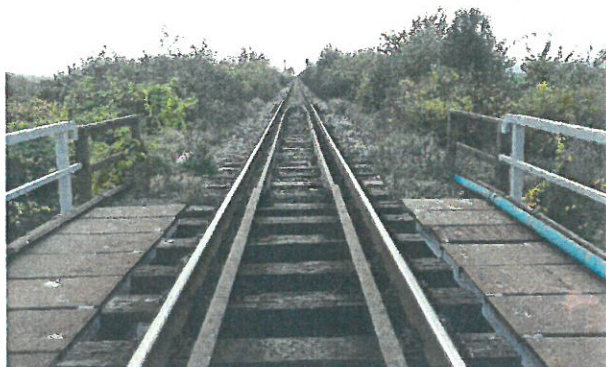
1. Calea, prinderea ei, tipul traverselor și contrașinelor pe Firul I
