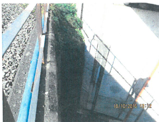
5. Parapet metalic și pozare conducte firul I.
