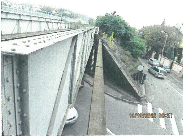
7. Vedere grindă metalică fir II. Aripa culee Cluj
