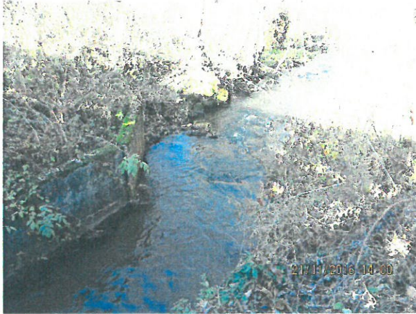
25.Vedere albie Aval
