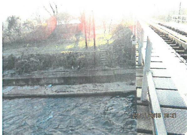
14. Aripă din zidărie de piatră și zid de sprijin în Aval, Culee Cluj Napoca
