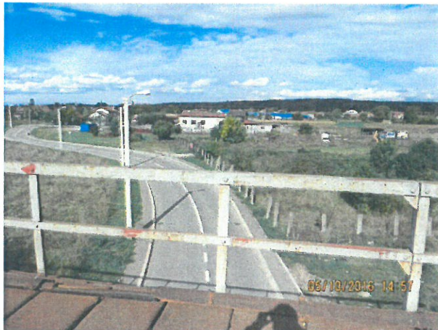
3. Vedere parapet metalic și trotuar fir I
