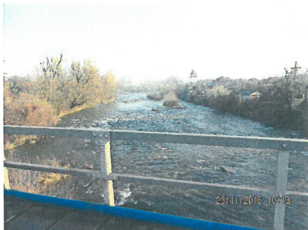
19.Vedere albie, Aval
