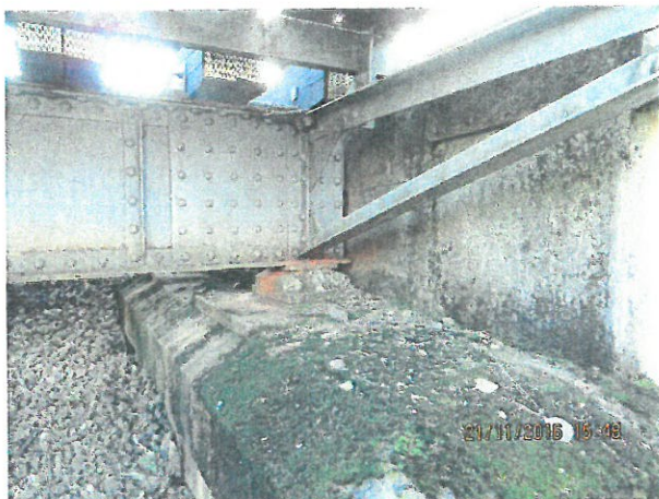
7. Aparat de reazem mobil culee Oradea
