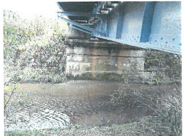
13. Vedere albie sub Pod
