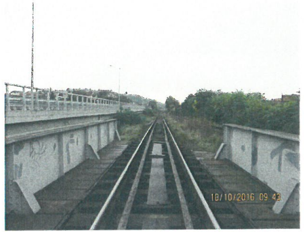
2. Calea și tipul traverselor pe firul I. Vedere spre Cluj
