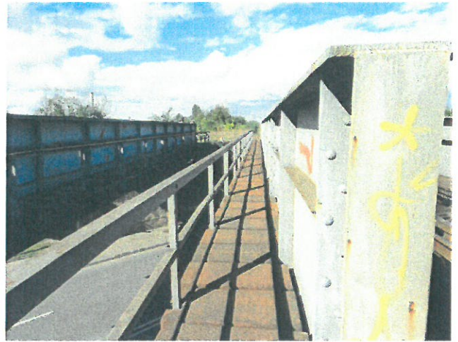
2. Parapet metalic și grindă metalică stânga firul I.
