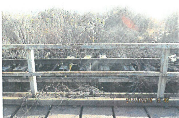
15.Vedere albie Aval
