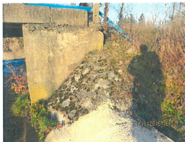
10.Sfert de con din piatră spartă, Culee Cluj Napoca, Amonte
