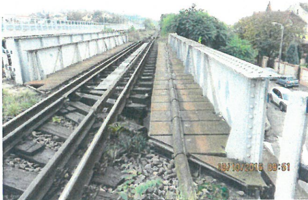
3. Calea și tipul traverselor pe firul II. Vedere spre Cluj
