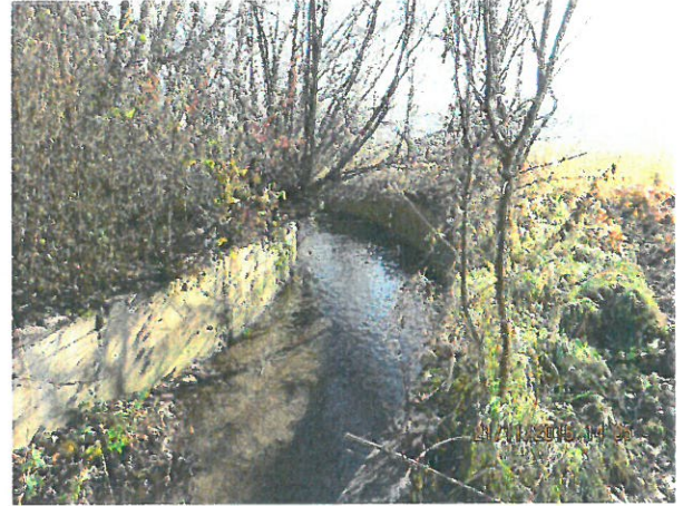
28.Vedere albie Amonte
