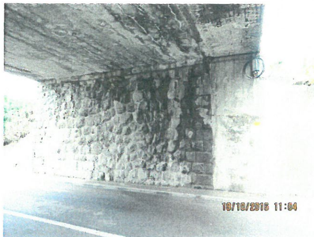
13. Vedere intrados tablier culeea Oradea
