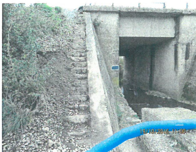
8.Vedere aval culeea Cluj
