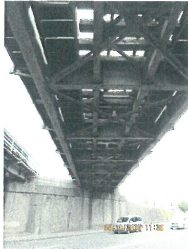
7. Vedere intrados tablier fir I
