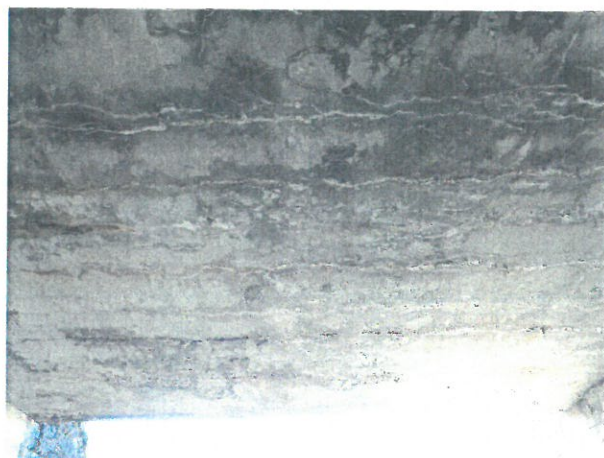
3.Vedere intrados dală de beton
