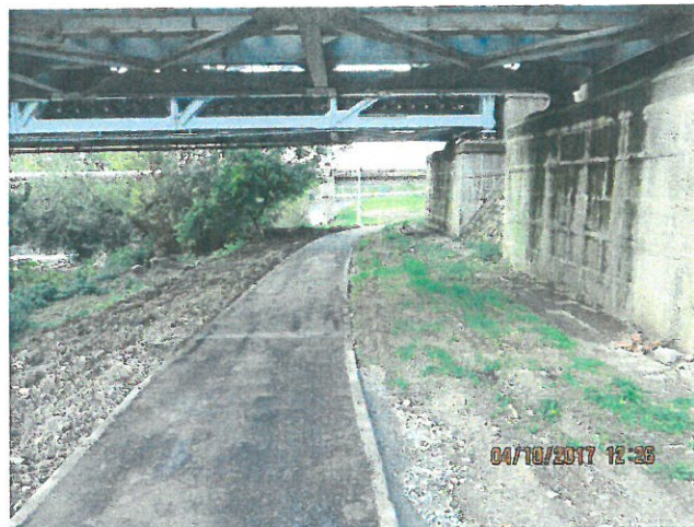
2. Vedere tablier fir I. Culeea Oradea.
