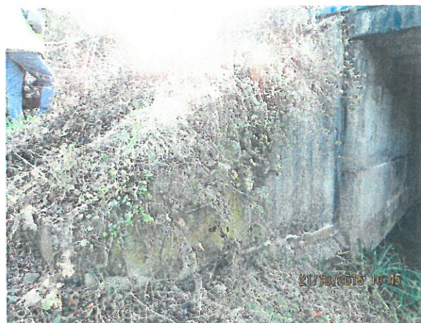
8. Aripă prefabricată de beton, culeea Cluj Napoca, Aval
