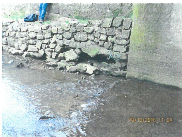
9.Vedere aripă culeea Cluj aval
