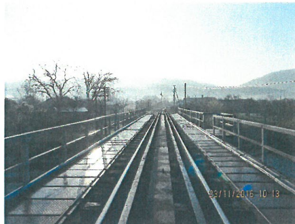
2. Calea, tipul traverselor și contrașinei pe Pod
