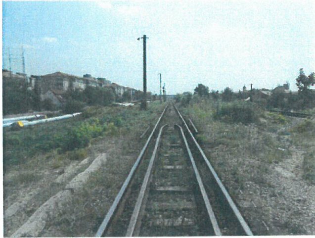
1. Calea și tipul traverselor pe Firul II. Contrașine.
