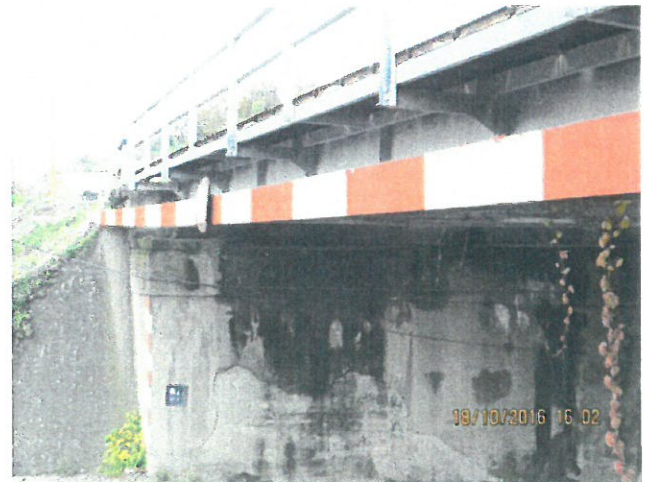
6. Vedere culee Cluj fir I
