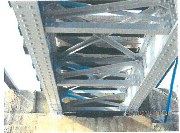
4. Vedere intrados tablier G.I.P.C.S. - nituit
