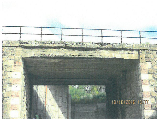
14. Vedere tablier fir II.
