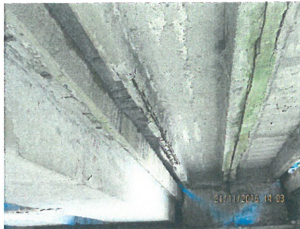
8.Vedere intrados trotuare de beton între Firele II și 3
