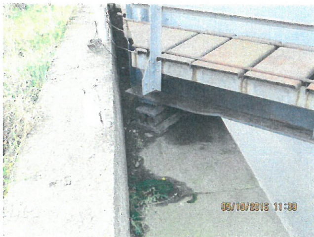
11. Vedere aparat reazem si bancheta culee Episcopia Bihor fir I
