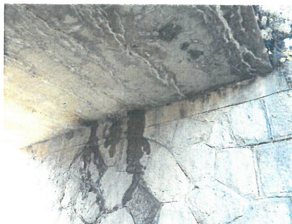
4. Vedere intrados dală de beton
