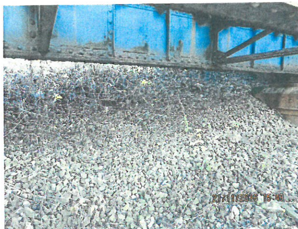
14.Vedere albie sub Pod
