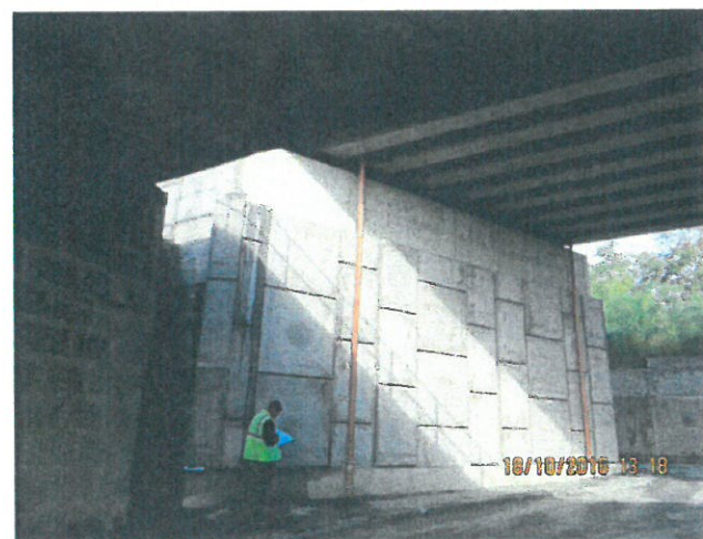
18. Vedere culee Oradea fir I și culee pod rutier.
