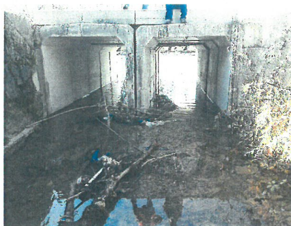
14.Vedere albie Aval
