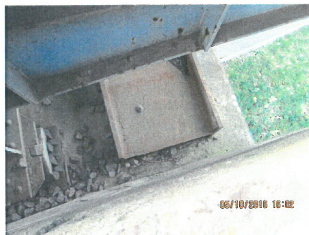
16. Vedere aparat reazem si bancheta culee Episcopia Bihor
