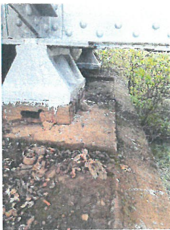
7. Aparat de reazem fix culee Oradea
