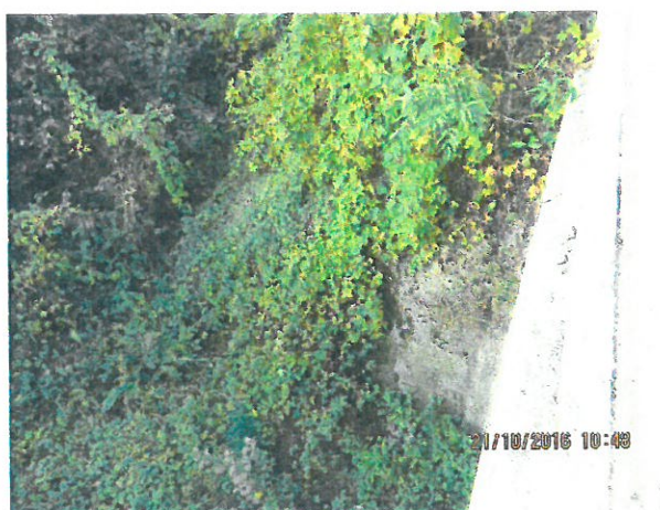
11. Aripă monolită de beton, culeea Oradea, Amonte
