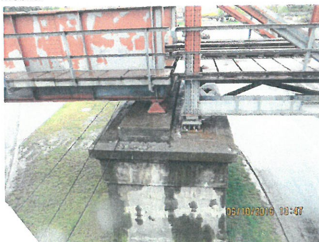
17. Vedere banchetă rezemare pile. Aparate de reazem.
