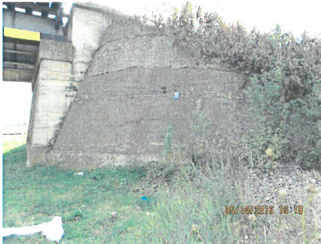
9. Vedere aripa culee Episcopia Bihor fir I
