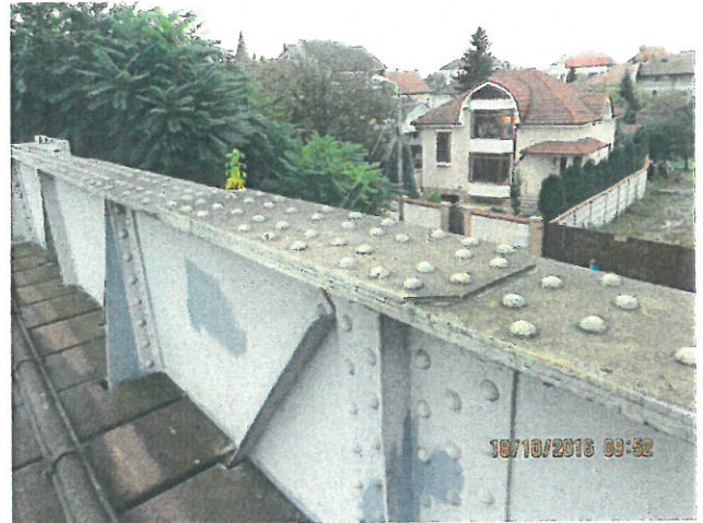
8. Vedere grindă metalică fir II.
