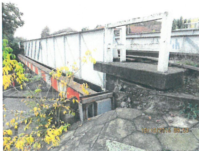
11. Vedere grindă metalică fir II
