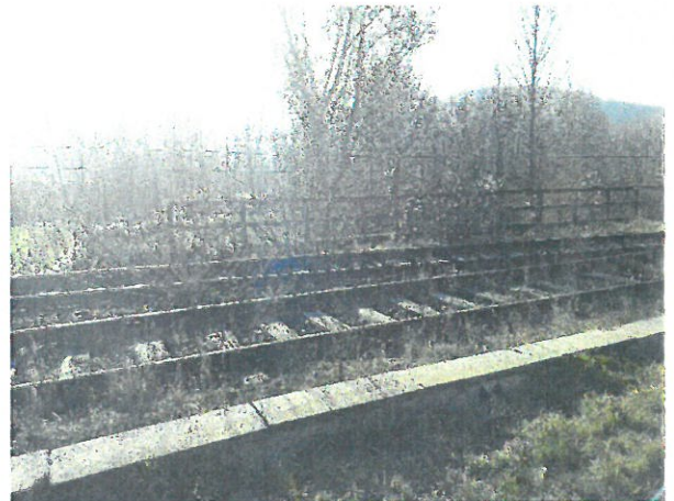
4.Parapet de beton, în Aval
