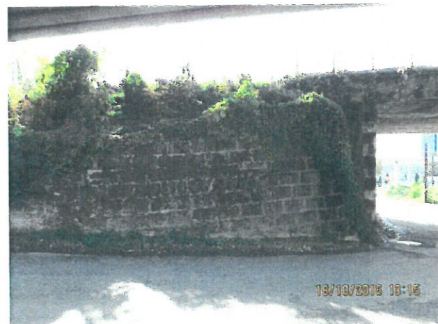
6. Vedere tablier fir I. Culee și aripa Cluj
