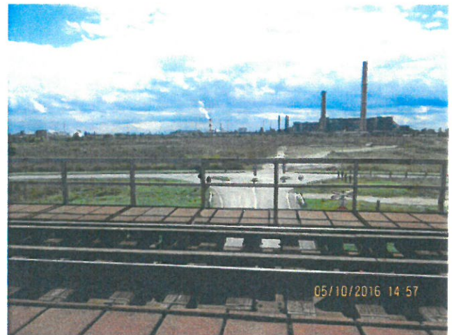
4. Vedere parapet metalic și trotuar fir II
