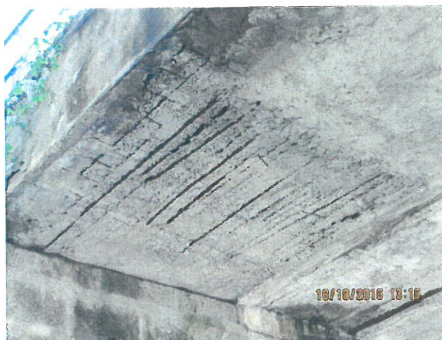
10. Vedere intrados tablier. Culee Cluj
