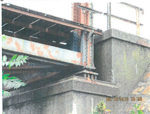
15. Vedere banchetă rezemare. Aparate de reazem mobile.
