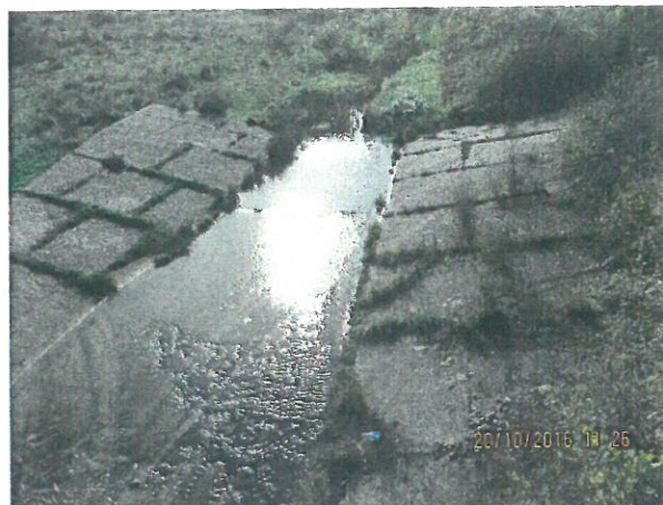
14. Vedere albie Amonte
