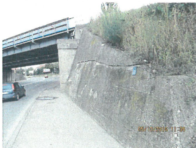
5. Vedere culee și aripa Cluj fir II
