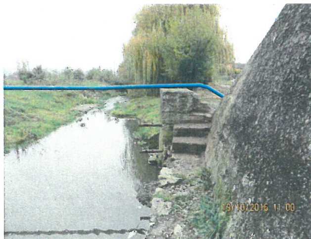
12. Vedere aripă culeea Cluj aval
