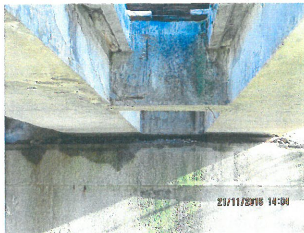
10. Vedere intrados tablier de beton, pe Firul 3
