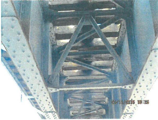
7.Vedere intrados tablier G.I.P.C.S.N. L=19.40m
