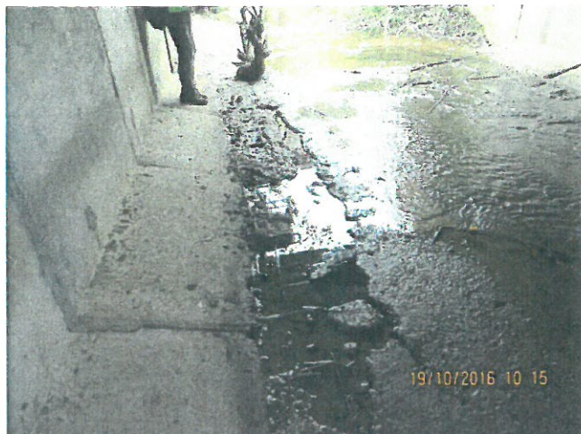
19. Vedere albie sub pod pe zona tablierului dezafectat.
