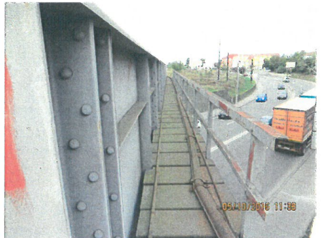
10. Vedere grinda metalica fir I. Parapet metalic si pozare conducte
