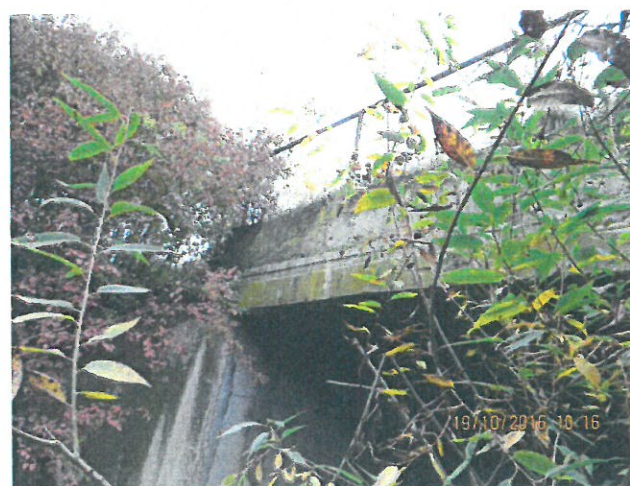
24. Vedere amonte. Culee Oradea
