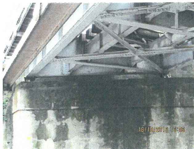
12. Vedere intrados tablier fir I. Culeea Cluj
