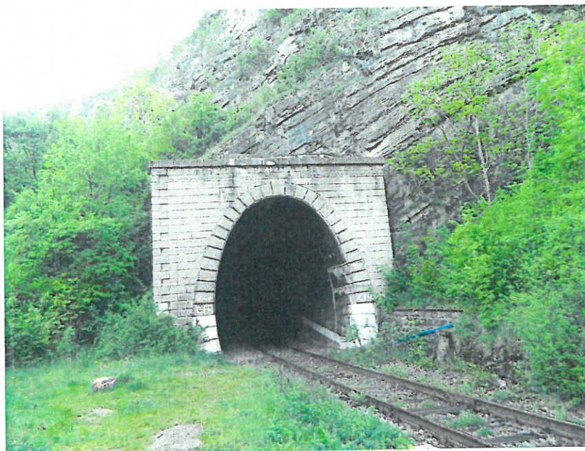
Portal Intrare tunel Șuncuiș
