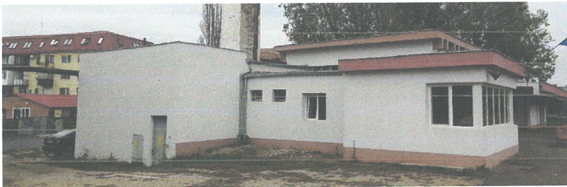
Pereți portanți din zidărie de cărămidă
