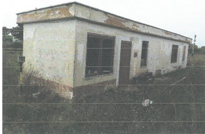
Pereți portanți din zidarie de cărămidă și acoperiș placă de beton tip terasă
