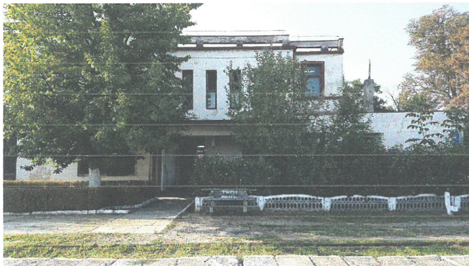
Clădirea de călători+CED +locuința de serviciu Oșorhei, din comuna Oșorhei, județul BIHOR
