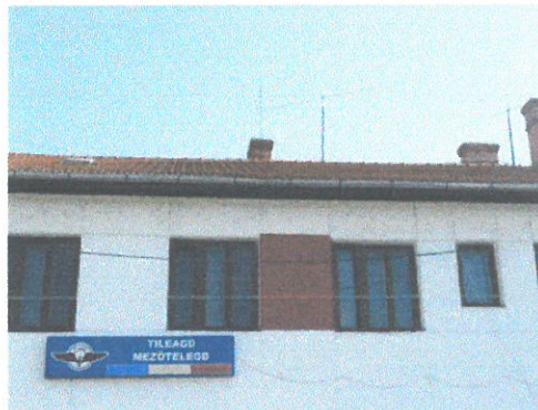
Acoperișul de tip șarpantă din lemn cu țiglă
