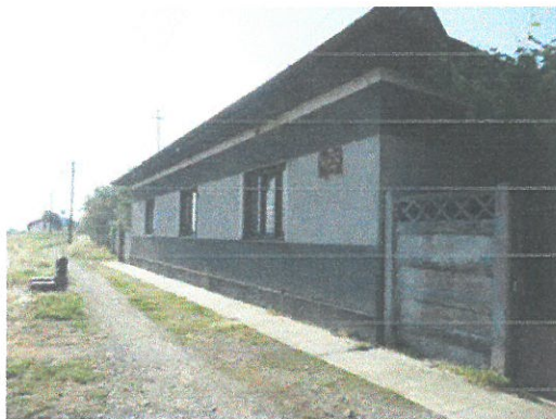
Pereți portanți din zidarie de cărămidă
