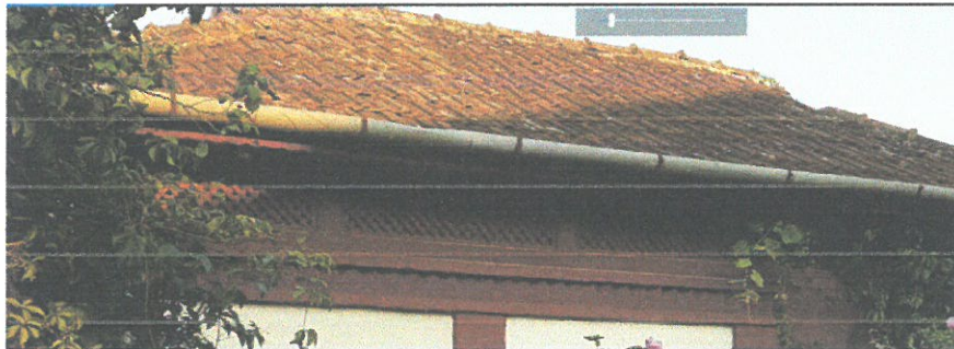
Acoperișul de tip șarpantă din lemn cu țiglă
