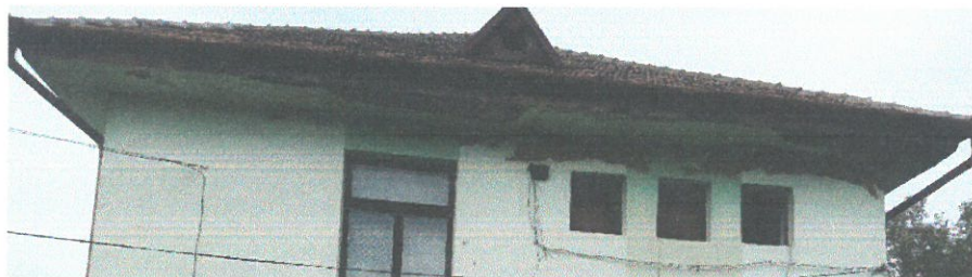
Acoperișul de tip șarpantă din lemn cu țiglă din ceramică
