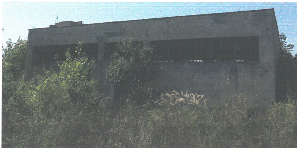
Pereți portanți din zidarie de cărămidă
