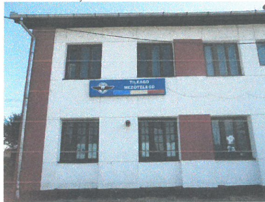
Pereți portanți din zidarie de cărămidă
