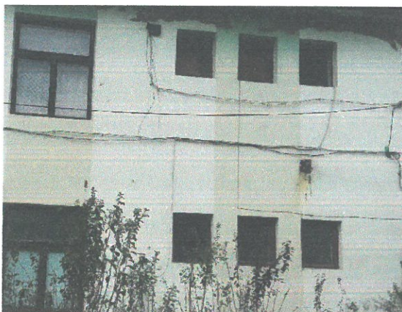
Pereți portanți din zidărie de cărămidă
