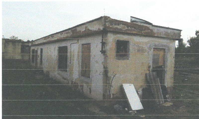
Tâmplăria exterioară – uși și ferestre din lemn/metal
