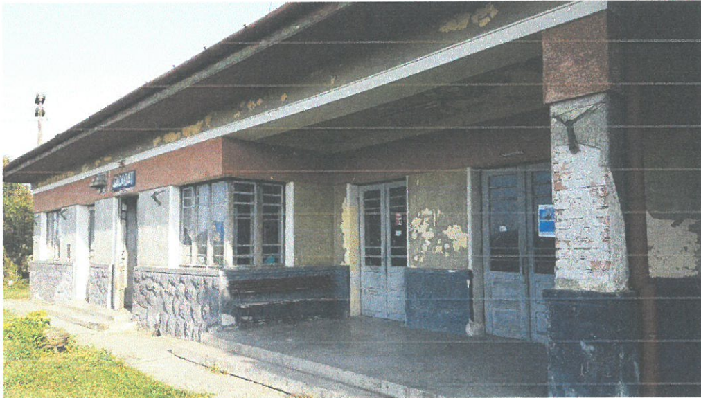
HALTA SĂCĂDAT-CLĂDIRE CĂLĂTORI+LOCUINȚĂ
