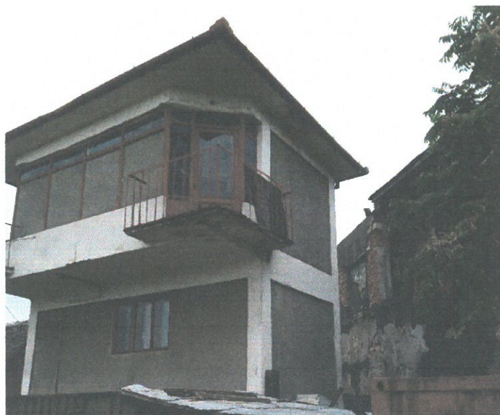
Acoperișul plac de beton tip șarpantă
