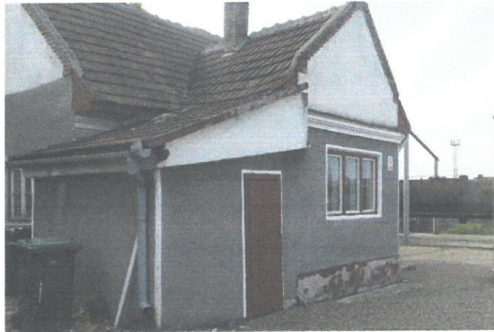
Pereți portanți din zidarie de cărămidă
