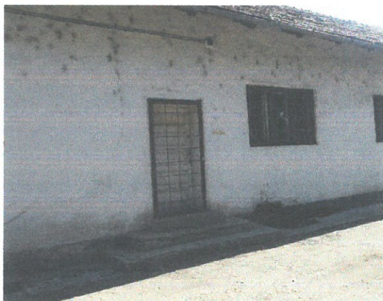
Desprinderi ale tencuielii exterioare
