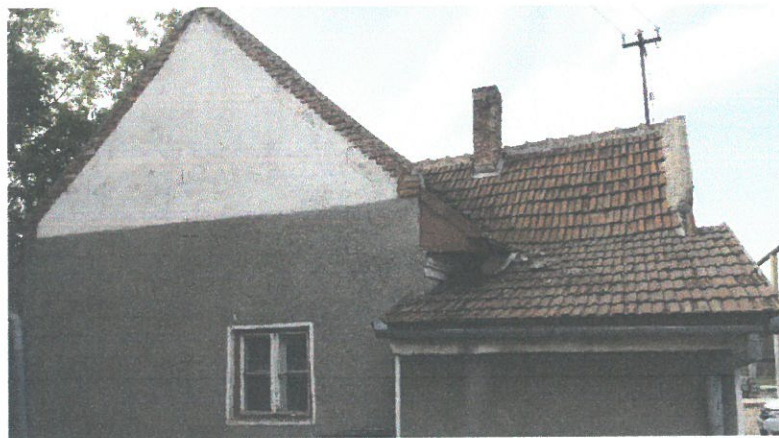
Acoperișul de tip șarpantă din astereala cu țiglă veche
