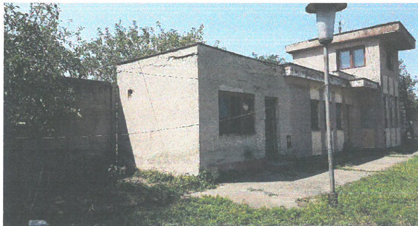
Pereți portanți din zidarie de cărămidă
