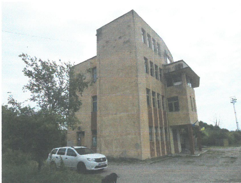
Stația Oradea Est – Clădire Cabina Turn CED+CAM
