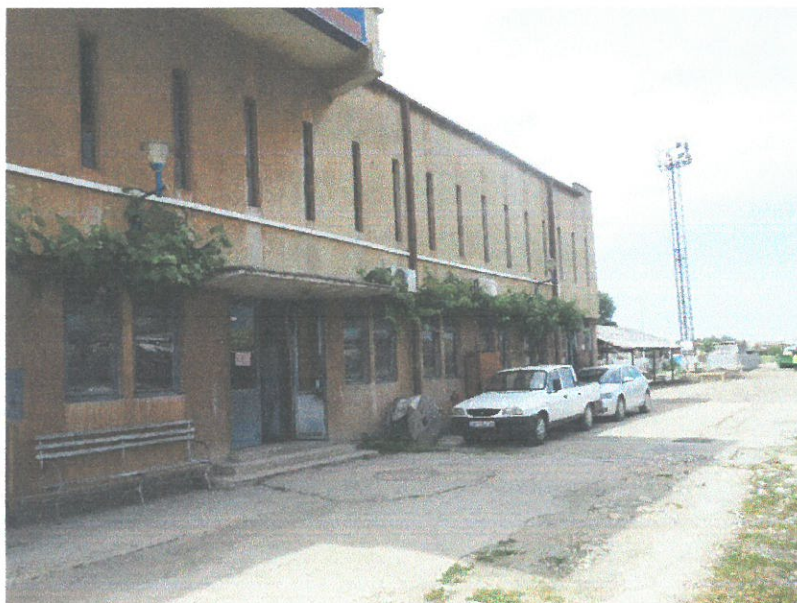
Pereți portanți din zidarie de cărămidă
