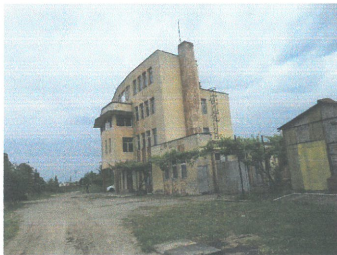
Acoperișul placă de beton de tip terasă
