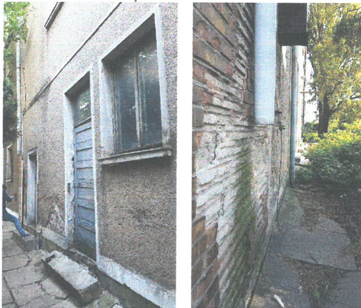
Pereți portanți din zidarie de cărămidă
