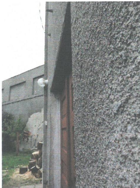
Pereți portanți din zidarie de cărămidă
