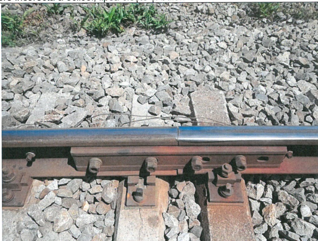
Prindere incorectă a eclisei, elemente lipsă ale prinderii
