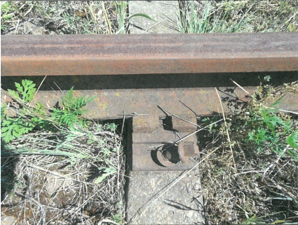
Lipsă clește și bulon în prindere, tirfon forfecat
