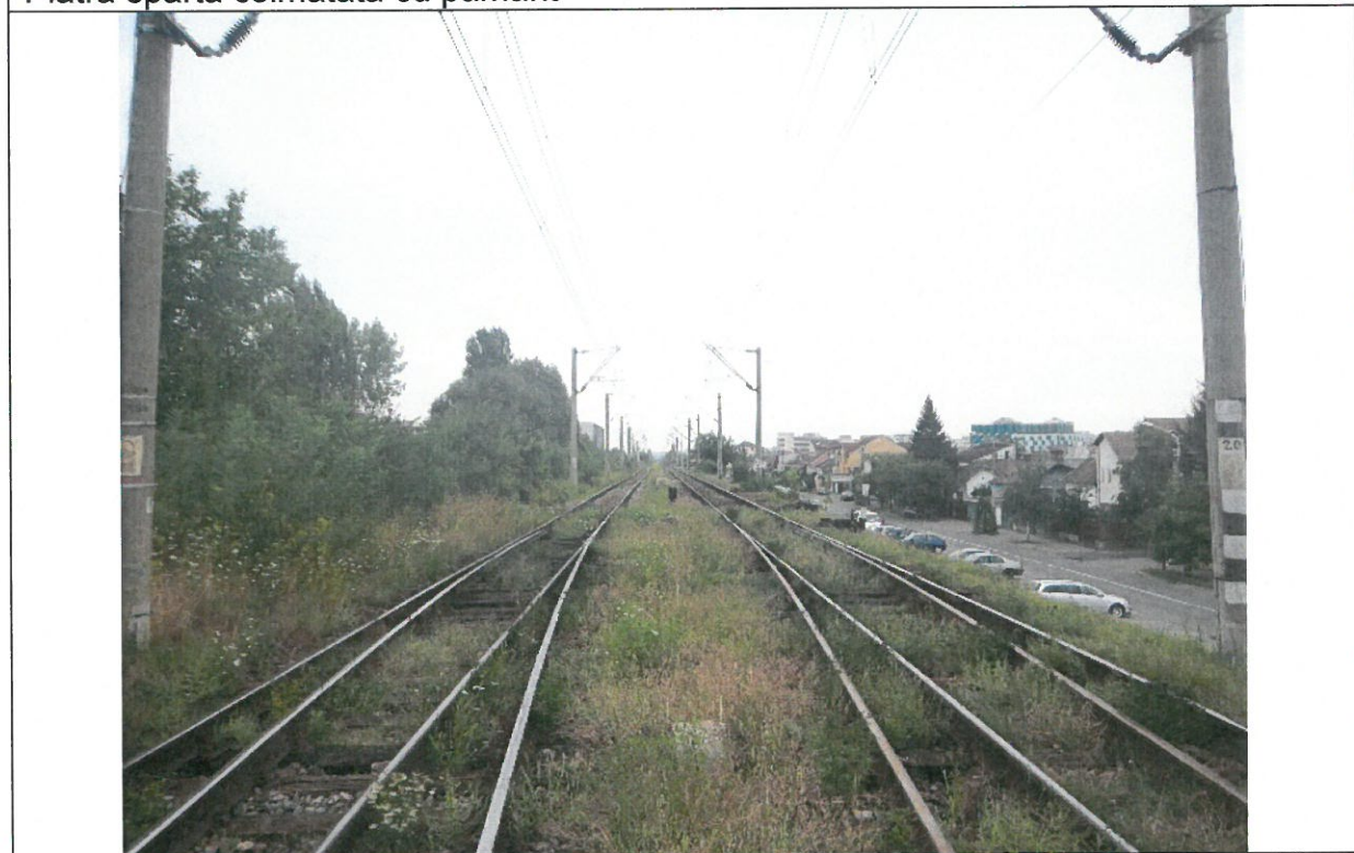
Piatră spartă colmatată cu pământ și vegetație
