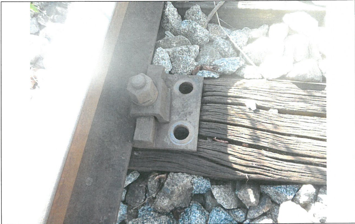
Elemente ale prinderii lipsă
