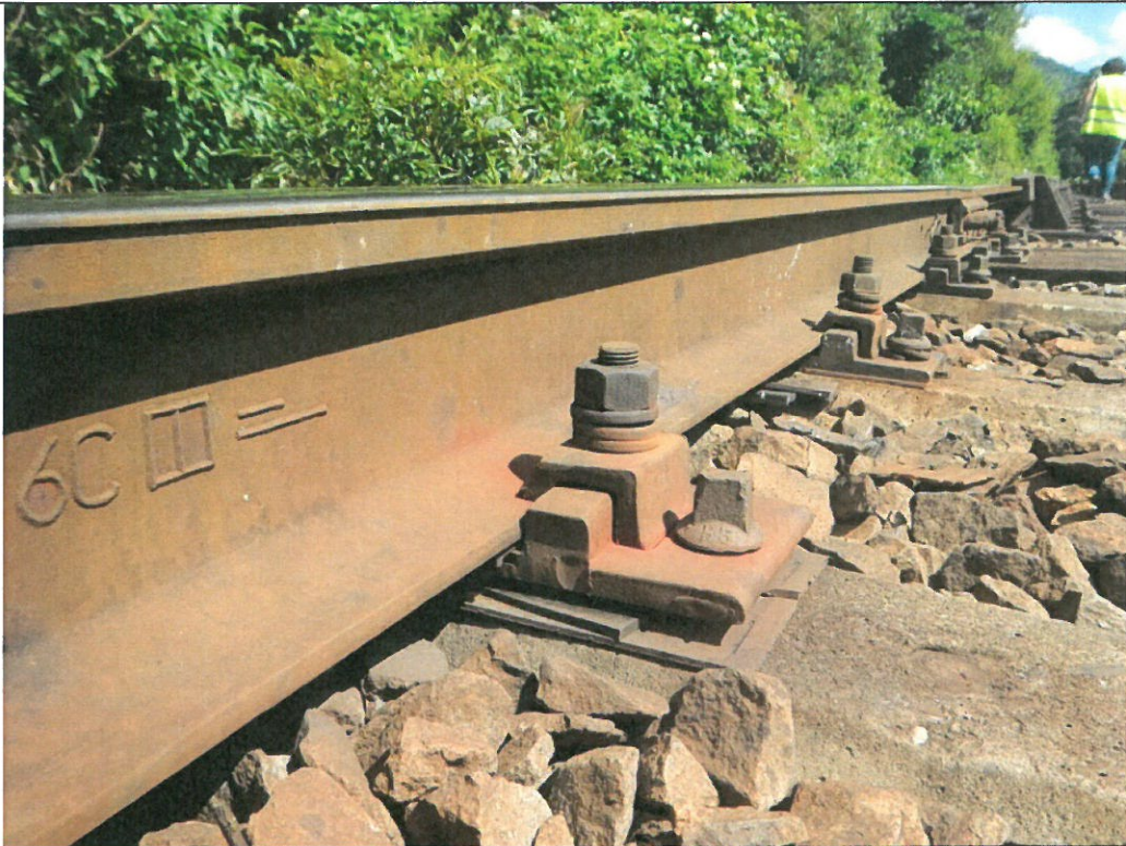
Tirfon fără inel resort, placă de polietilenă deplasată
