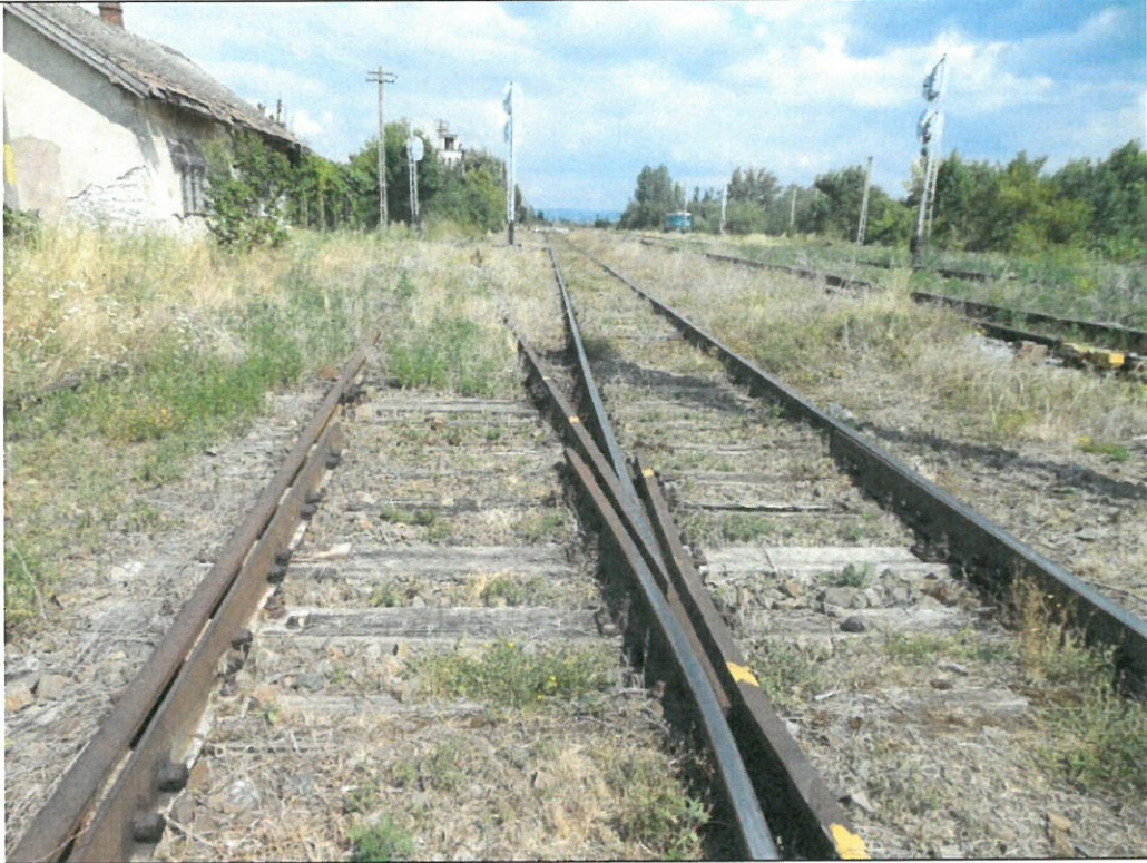
Piatră spartă colmatată cu pământ și vegetație
