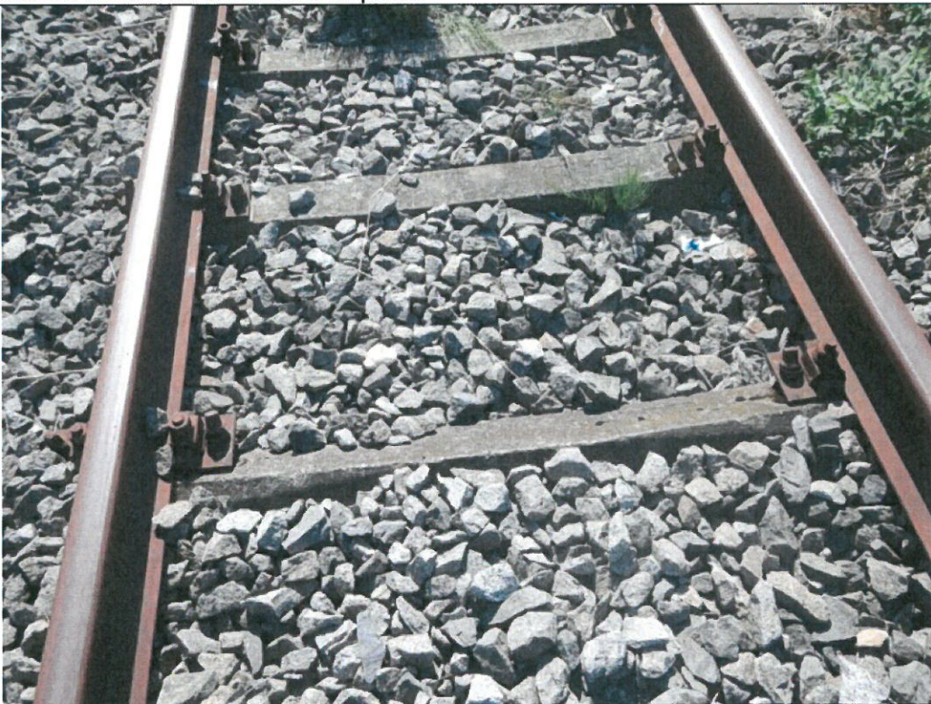
Traversă de beton rotită în cale
