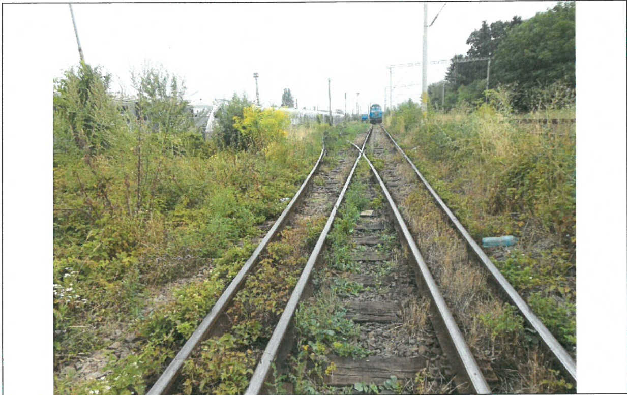
Piatră spartă colmatată cu pământ și vegetație abundentă
