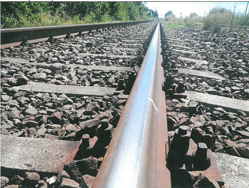
Uzuri accentuate la nivelul suprafeței de rulare
