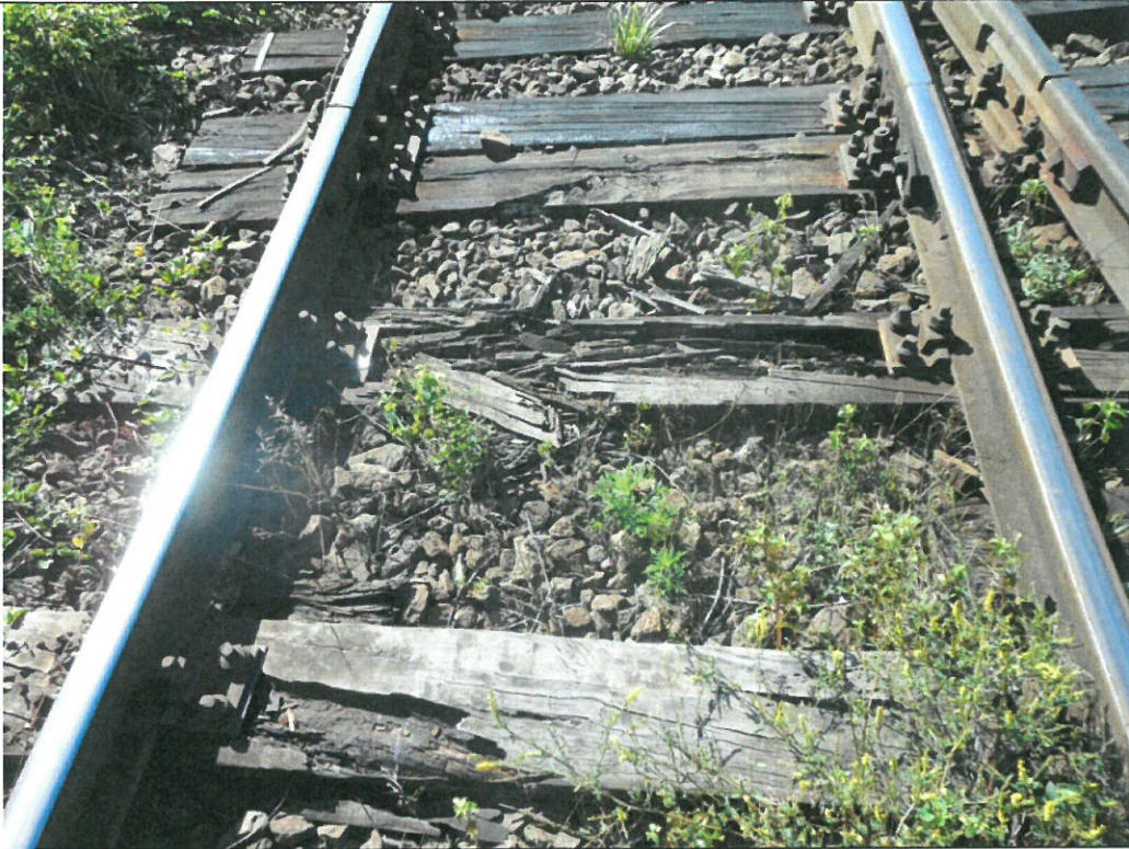
Traverse de lemn crăpate pe toată lungimea și putrezite
