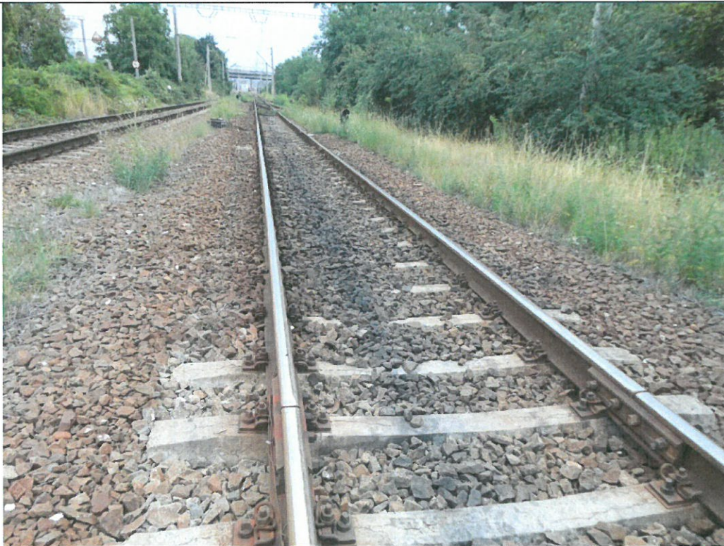
Traverse de beton consecutive fisurate longitudinal și „oarbe”
