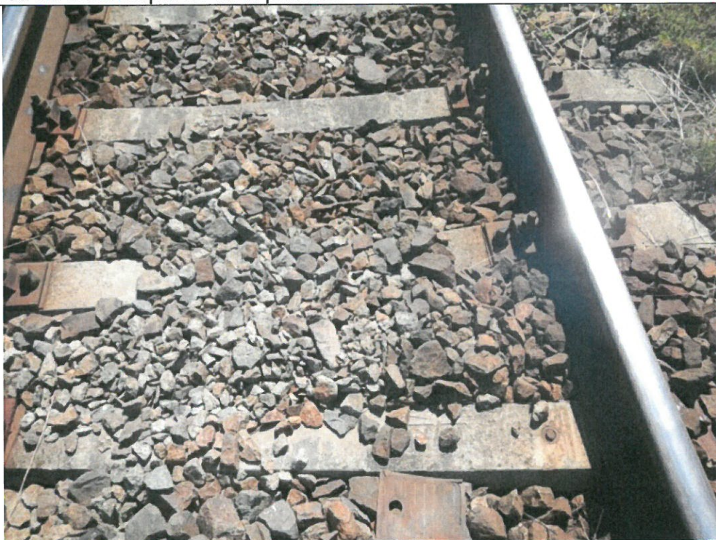
Traversă rotită în cale, prindere lipsă
