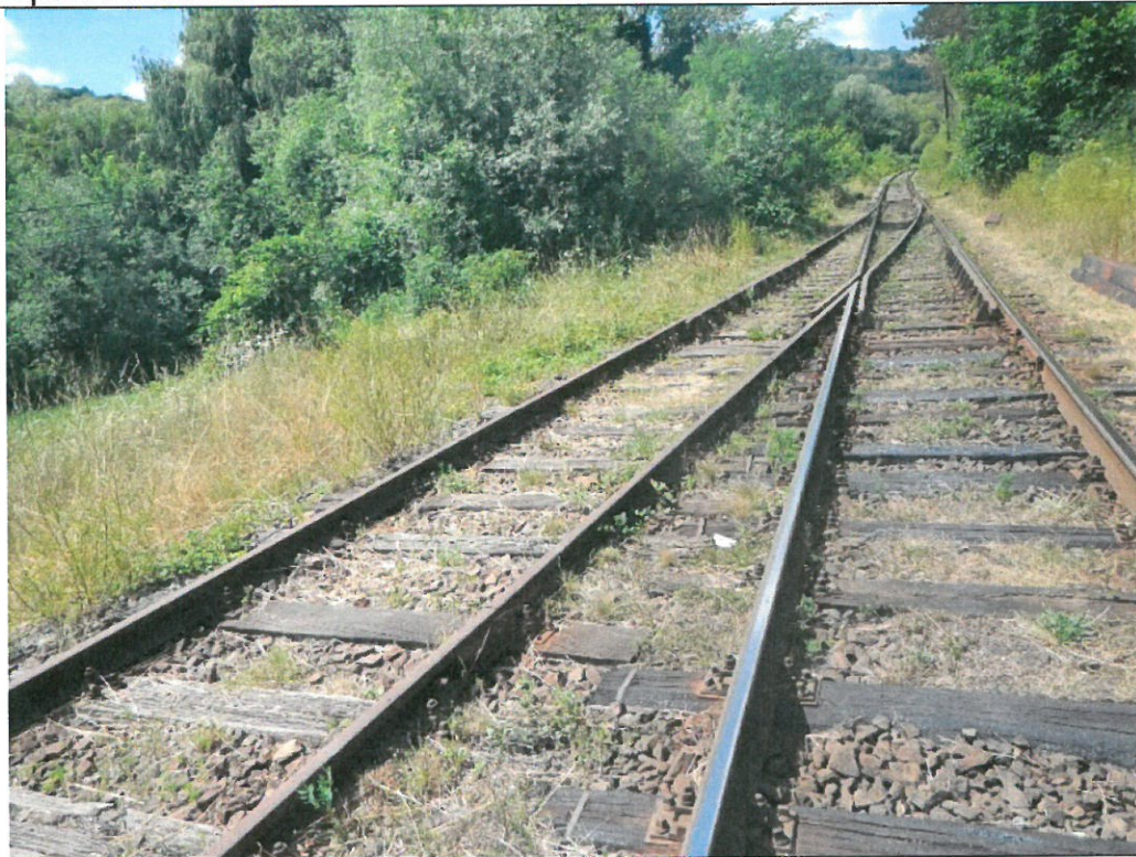
Piatră spartă colmatată cu pământ și vegetație
