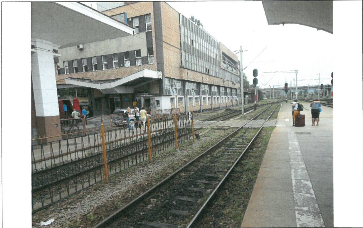
Piatră spartă colmatată cu pământ
