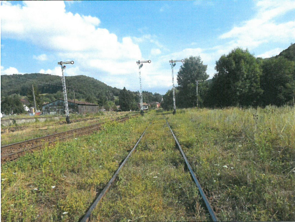
Piatră spartă colmatată cu pământ și vegetație abundentă
