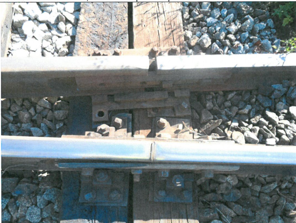
Rost de dilatație cu deschidere incorectă, prindere incorectă a eclisei, lipsă elemente de prindere
