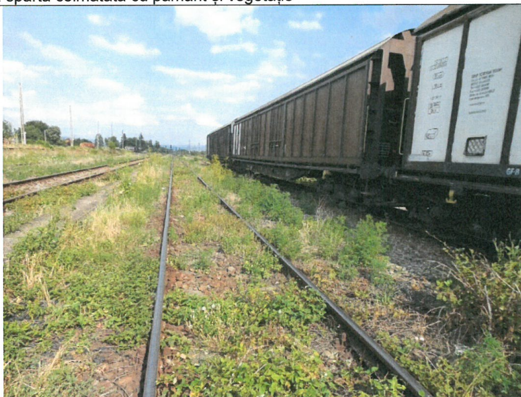
Piatră spartă colmatată cu pământ și vegetație
