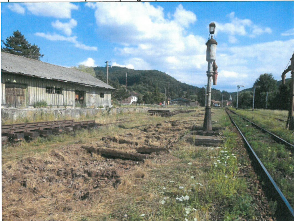
Piatră spartă colmatată cu pământ și vegetație
