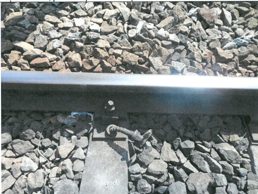
Tirfon ieșit din diblu și forfecat
