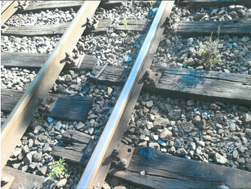
Traverse de lemn consecutive pe zona aparatelor de cale, crăpate pe toată lungimea
