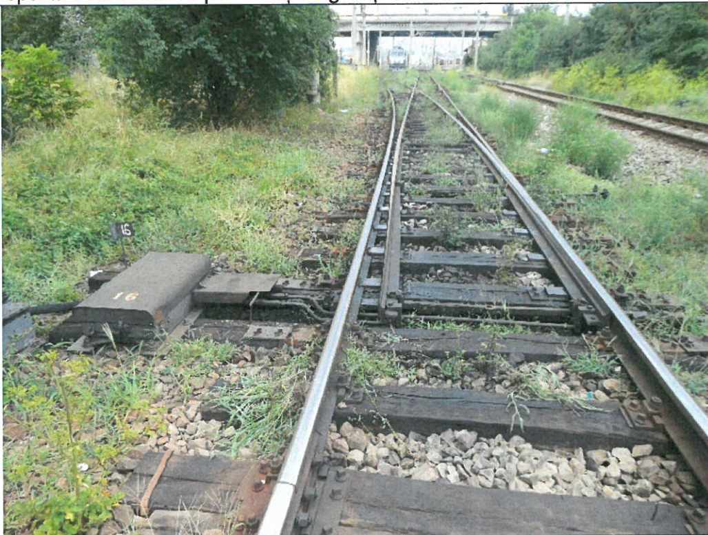
Piatră spartă colmatată cu pământ și vegetație
