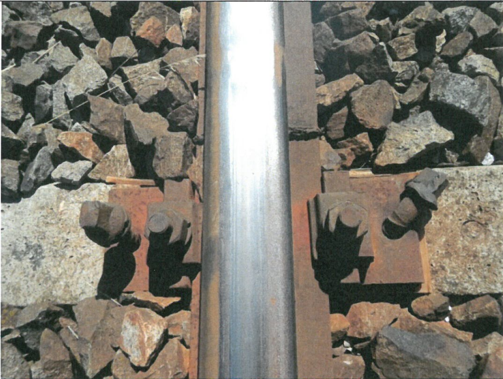
Tirfoane ieșite din dibluri, tirfon forfecat
