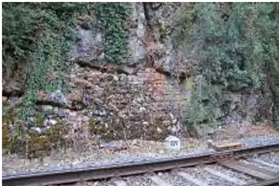
Zid de sprijin existent în Defileul Crișului Repede
