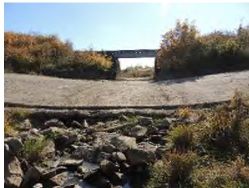
Presiune asupra corpurilor de apă de suprafață – prag betonat în zona podului CF
