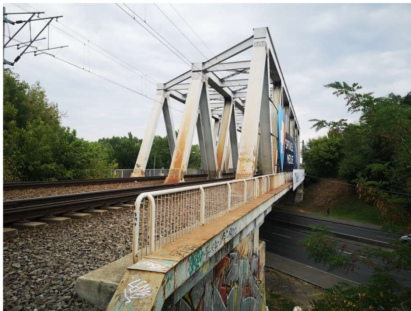
Pasaj inferior km 7+083, LINIA 800 (Pasaj Miorița) - Grinzi cu zăbrele cale jos, cuvă de beton
