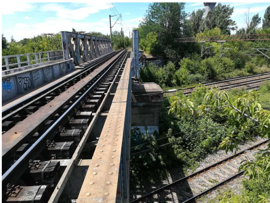
Pod km 1+542 (linia 301M); km 4+000 (linia 300) – Grinzi cu zăbrele cale jos+ grinzi cu inimă plină cale jos
