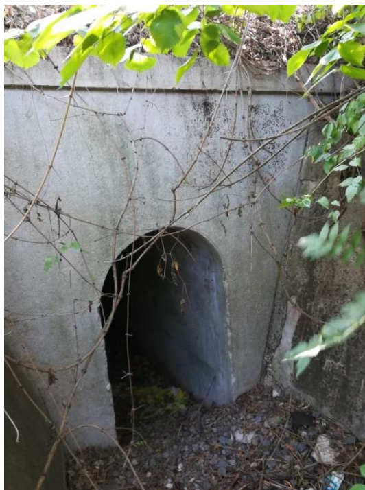
Podeț km 10+529 (linia 700); km 3+937 (linia 301K) – Boltă din beton armat
