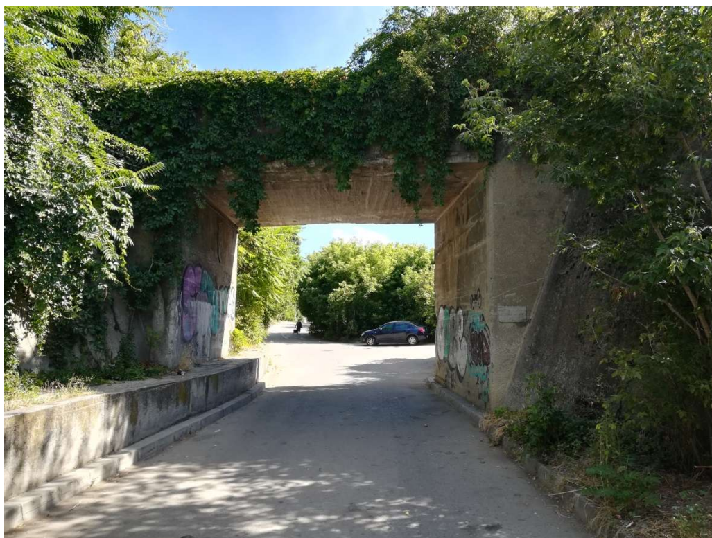
Pasaj inferior km 0+682 (linia 301G) - Dală din beton armat
