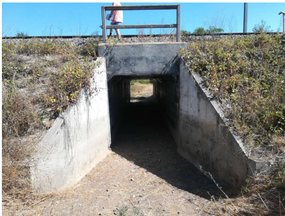
Podeț km 21+349 (linia 800) – Podeț prefabricat C2
