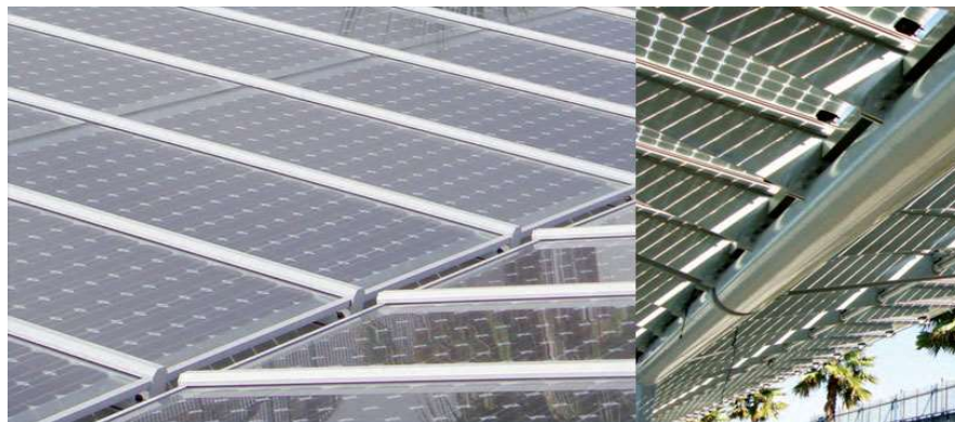
Foto 5.2. Acoperișuri fotovoltaice de copertină (exemple orientative)
