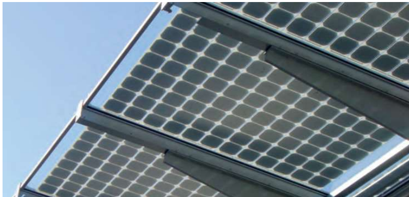
Foto 5.1. Acoperiș fotovoltaic de copertină (exemplu orientativ)
