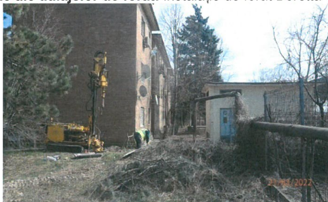
Foto nr.1 – instalație de forat
