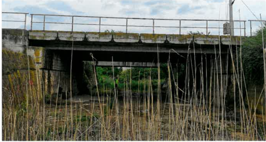
Pod km 101+466 – Grinzi metalice înglobate în beton
