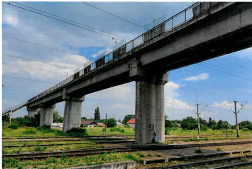
Pasarelă pietonală km 161+300 – Grinzi prefabricate din beton precomprimat
