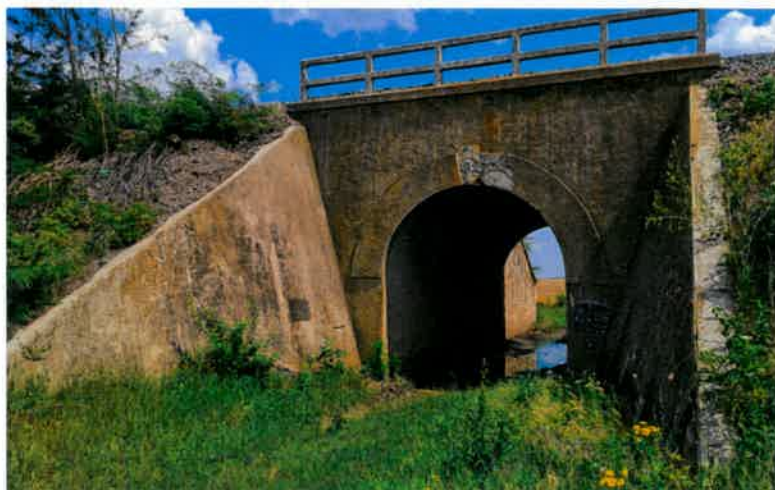
Podeț km 146+113 – Podeț boltit din beton armat
