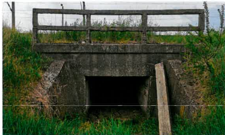
Podeț km 71+117 – Dală monolită din beton armat
