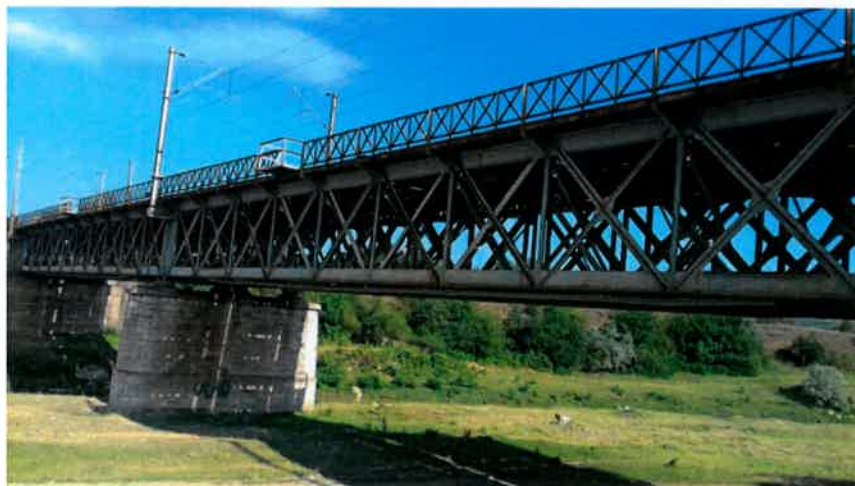
Pod km 74+541 –Grinzi cu zăbrele cale sus
