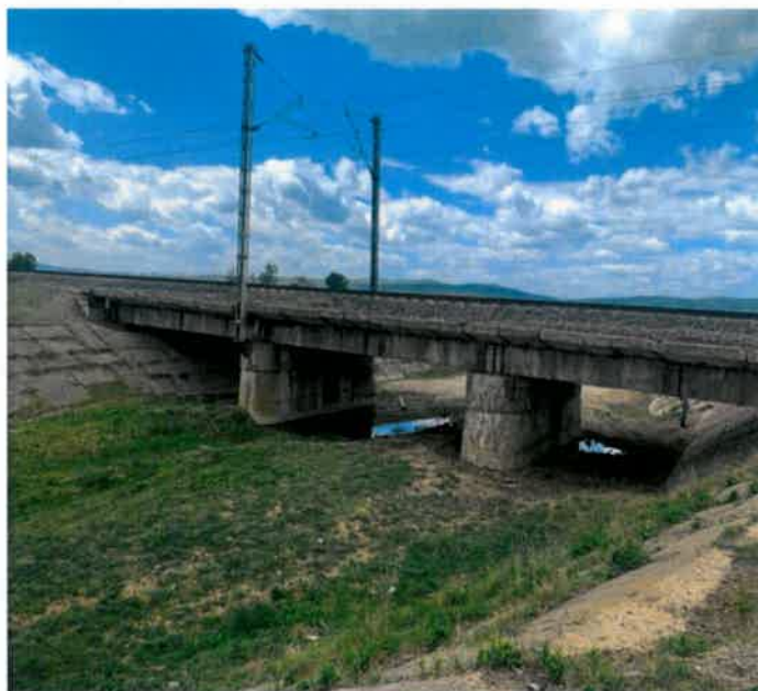
Pod km 87+938 - Grinzi de beton armat precomprimat (fâșii cu goluri)
