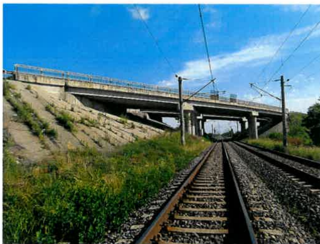
Pasaj superior 193+126 – Grinzi prefabricate din beton precomprimat
