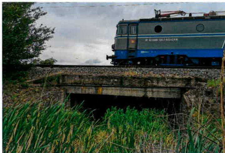
Pod km 108+686 - Dală din beton armat
