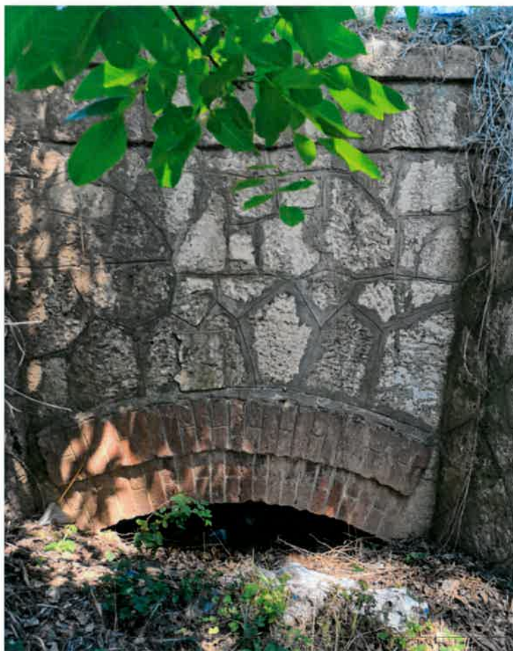
Podeț km 130+214 – Podeț boltit din zidărie de piatră brută
