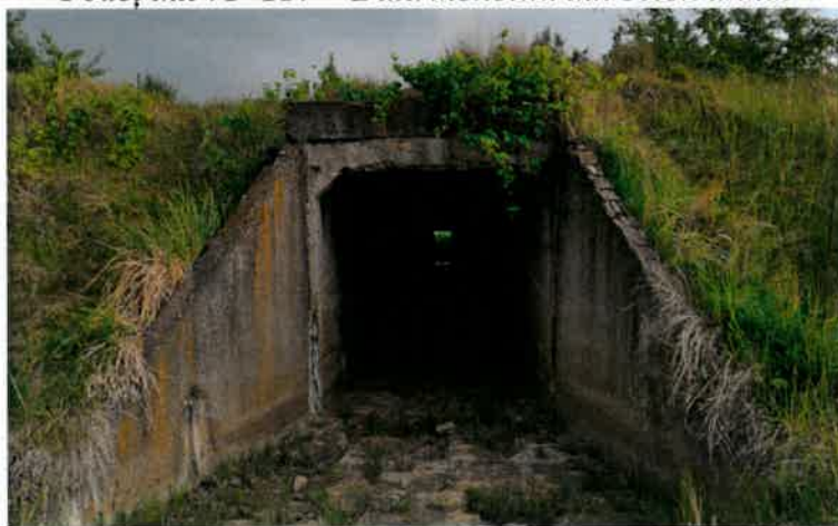
Podeț km 71+117 – Dală monolită din beton armat
