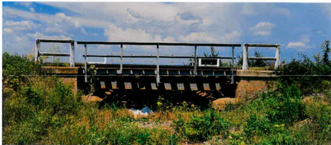
Pod km 136+323 - Grinzi inimă plină cale sus
