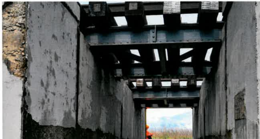
Podet km 187+707 – Grinzi cu inimă plină cale sus, nituit, cu prinderea șinelor direct pe traverse din lemn
