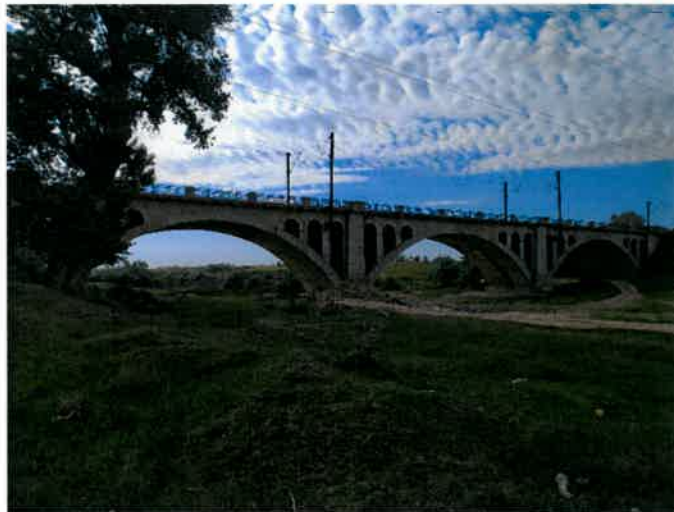
Pod km 181+241 - Boltă din beton armat.
