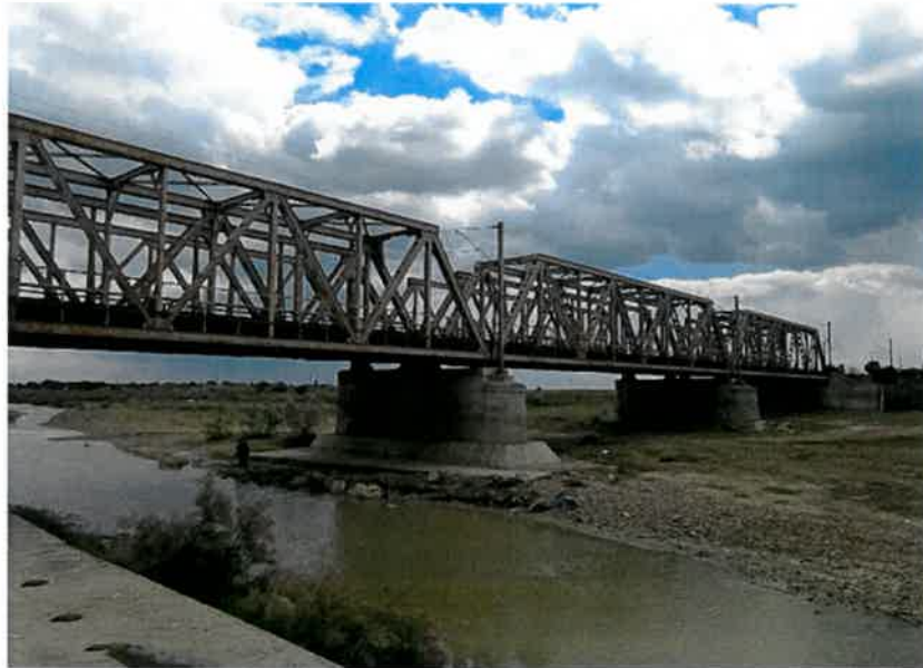
Pod km 159+273- Grinzi cu zăbrele cale jos
