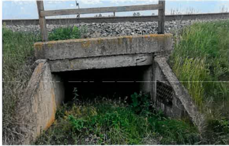
Podeț km 143+540 – Dale prefabricate din beton armat
