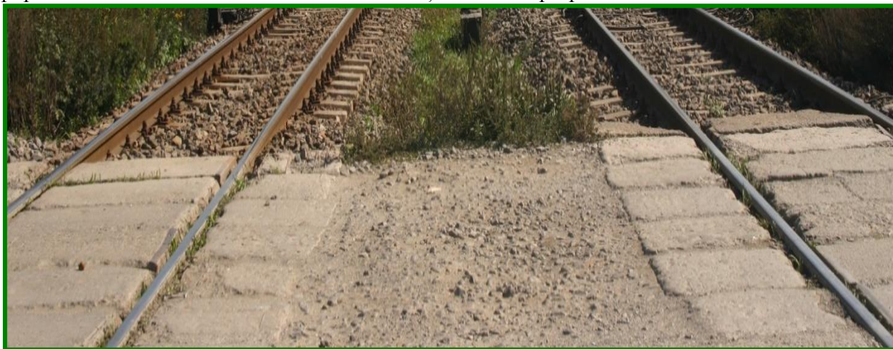
Figura 2. Exemplu de trecere la nivel
