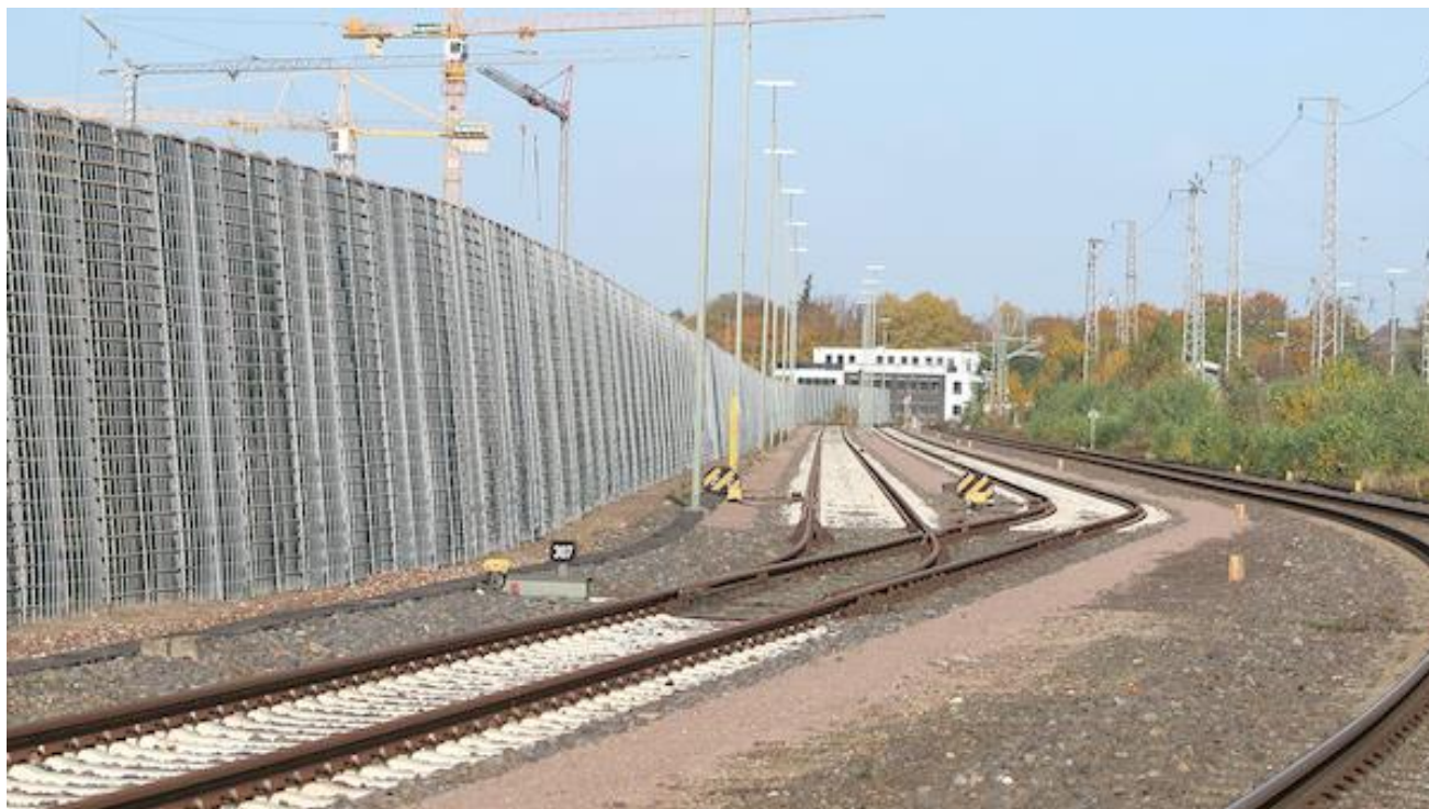
Foto exemplu panouri fonoabsorbant (structura din oțel, apoi aplicare ecologizare)
