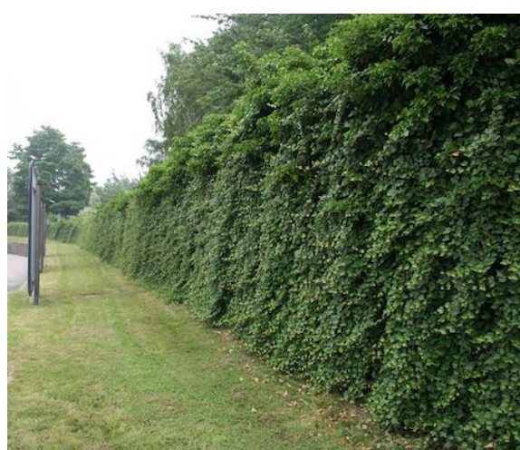
Foto exemplu panouri fonoabsorbant (structura din oțel, apoi aplicare ecologizare)
