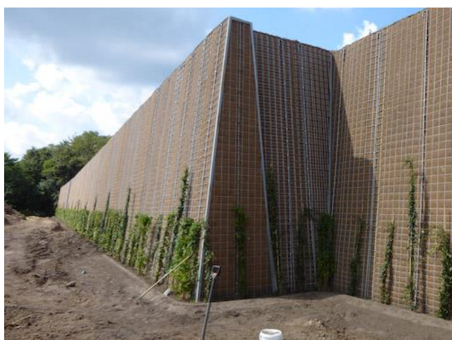
Foto exemplu panouri fonoabsorbant (structura din oțel, apoi aplicare ecologizare)
