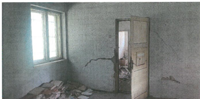
Fotografia nr. 2.2.9.1. Clădire călători Văratec
