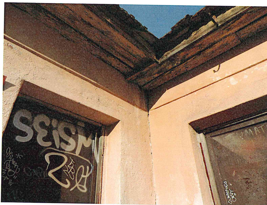
3. Fisură verticală între pereti, posibil rost
