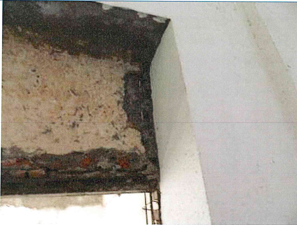
10. Degradare tencuială, infiltrații
