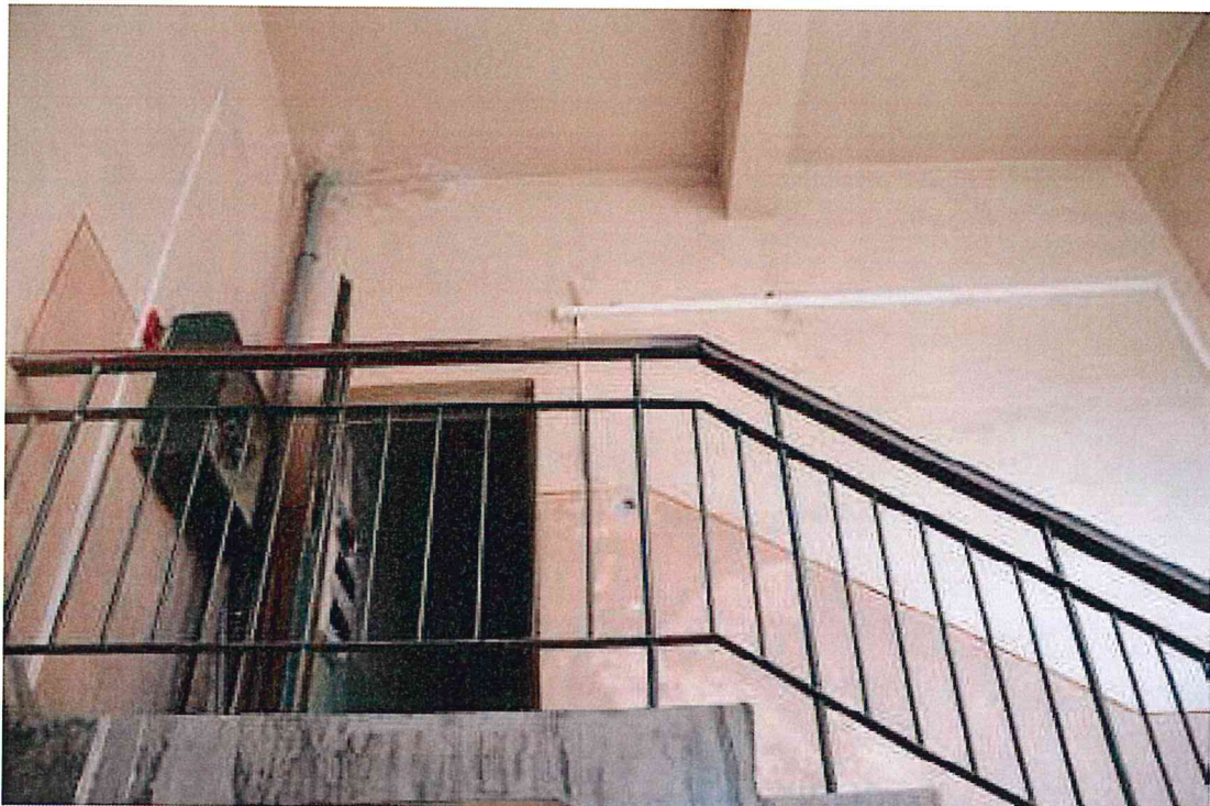
20. Tencuială degradată, infiltrații
