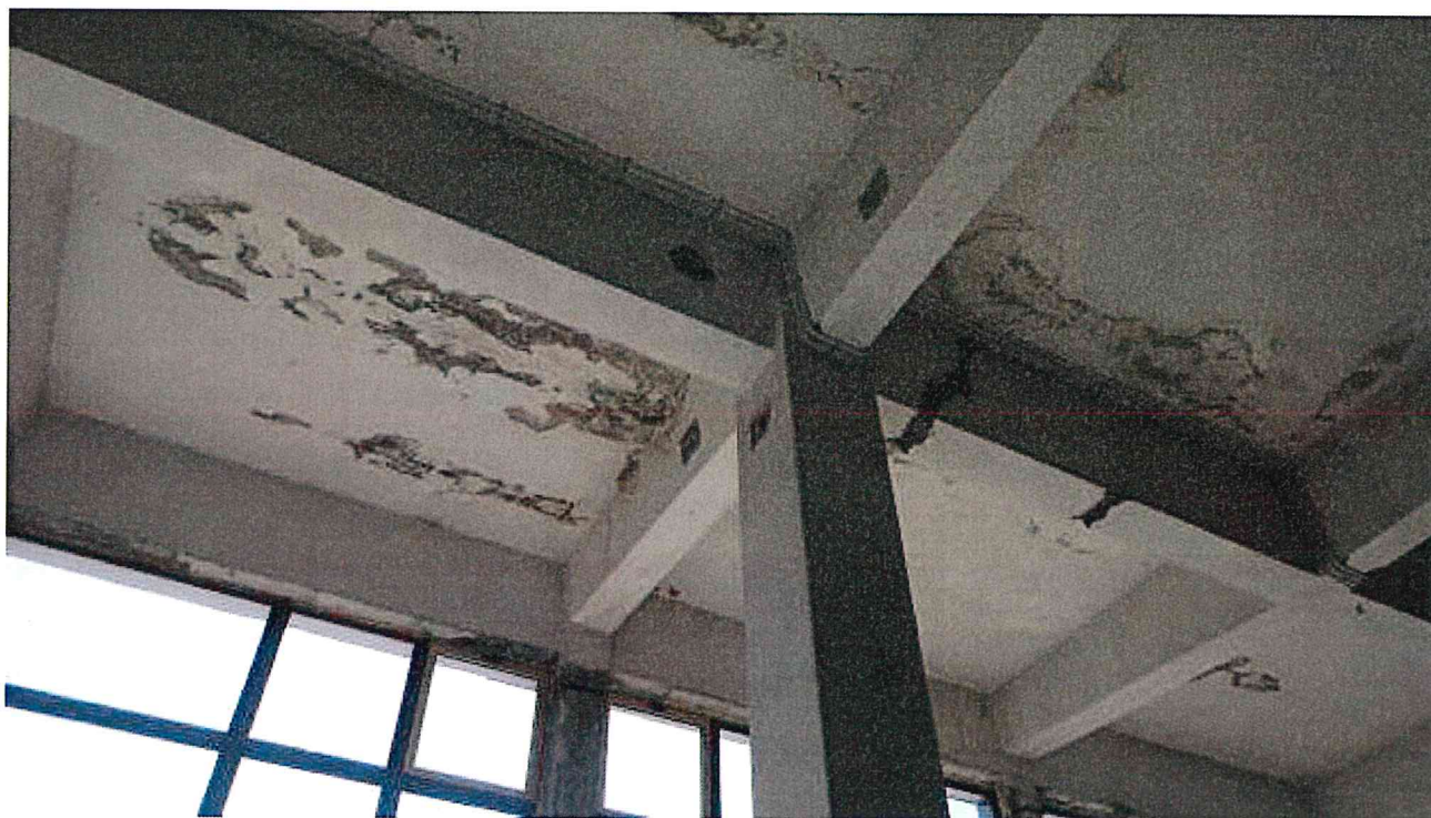
11. Fisură înclinată pe grindă
