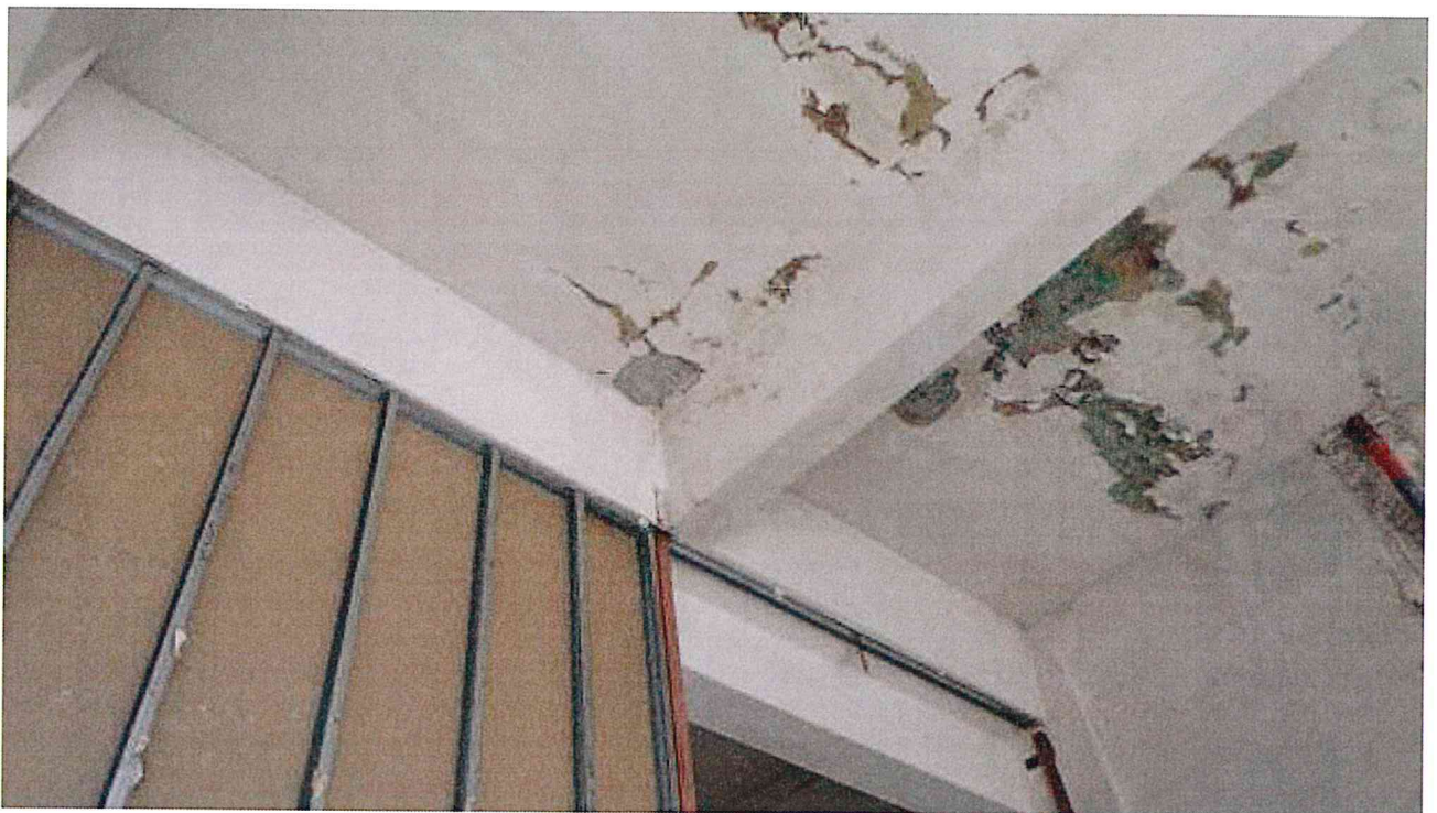
10. Degradare tencuială, infiltrații
