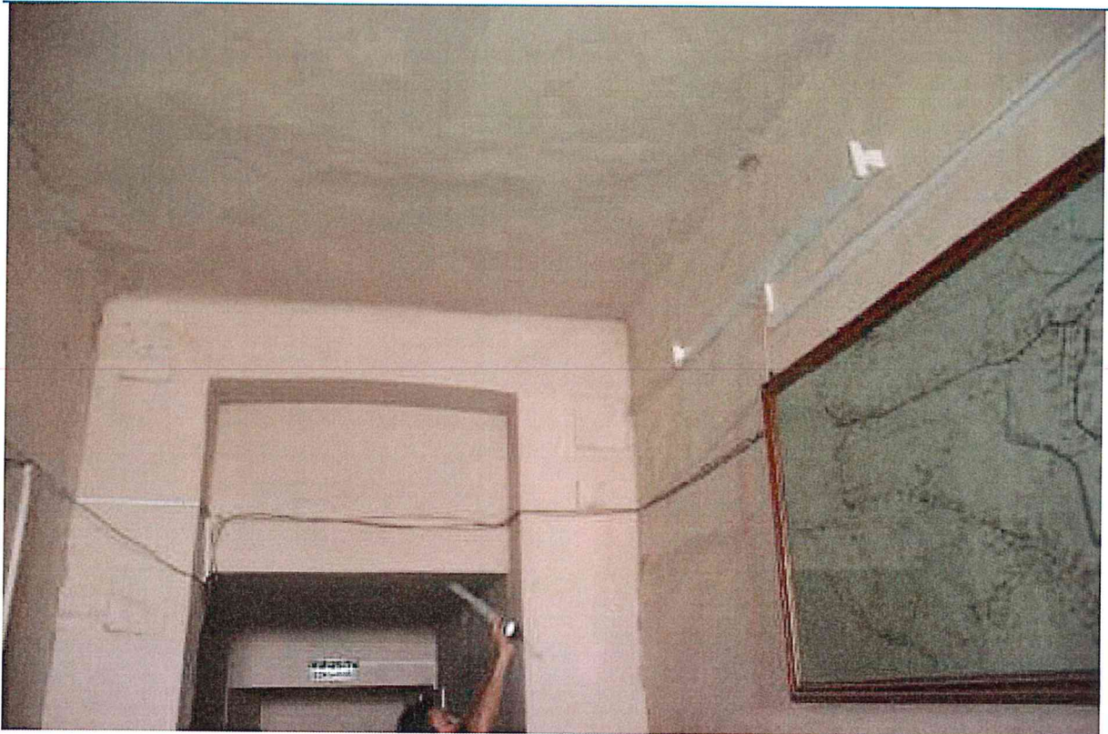
20. Tencuială degradată, infiltrații
