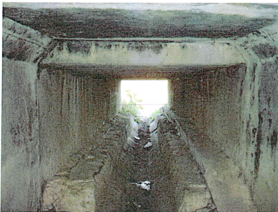
FOTO 5. Canal beton interior podeț dalat tronson I
