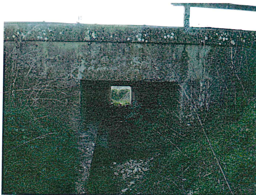
FOTO 1. Vedere stânga podeț dalat tronson I
