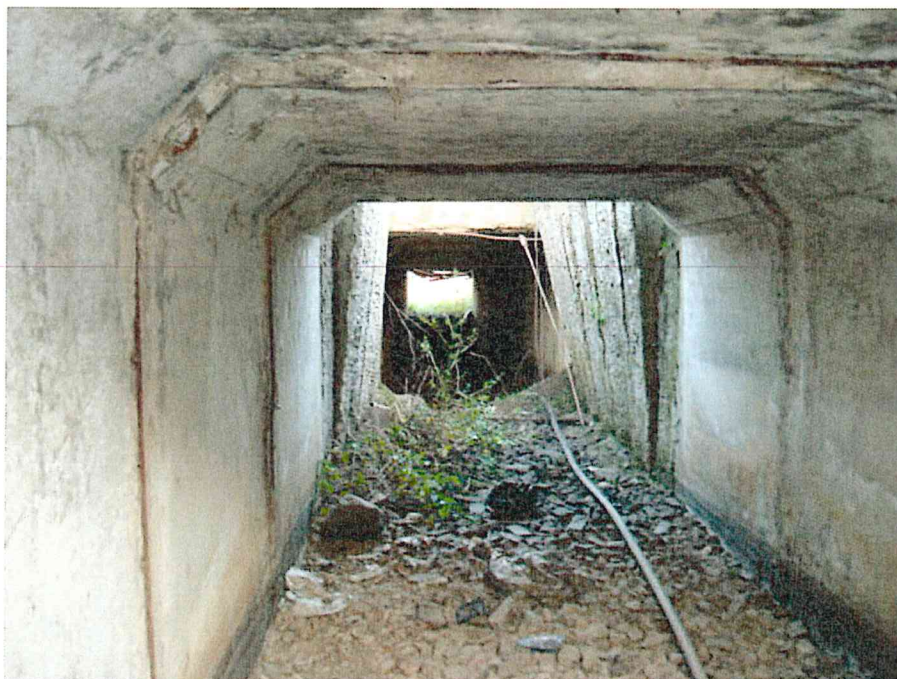
FOTO 6. Vedere podeș cadru drum și pereu colmatat
