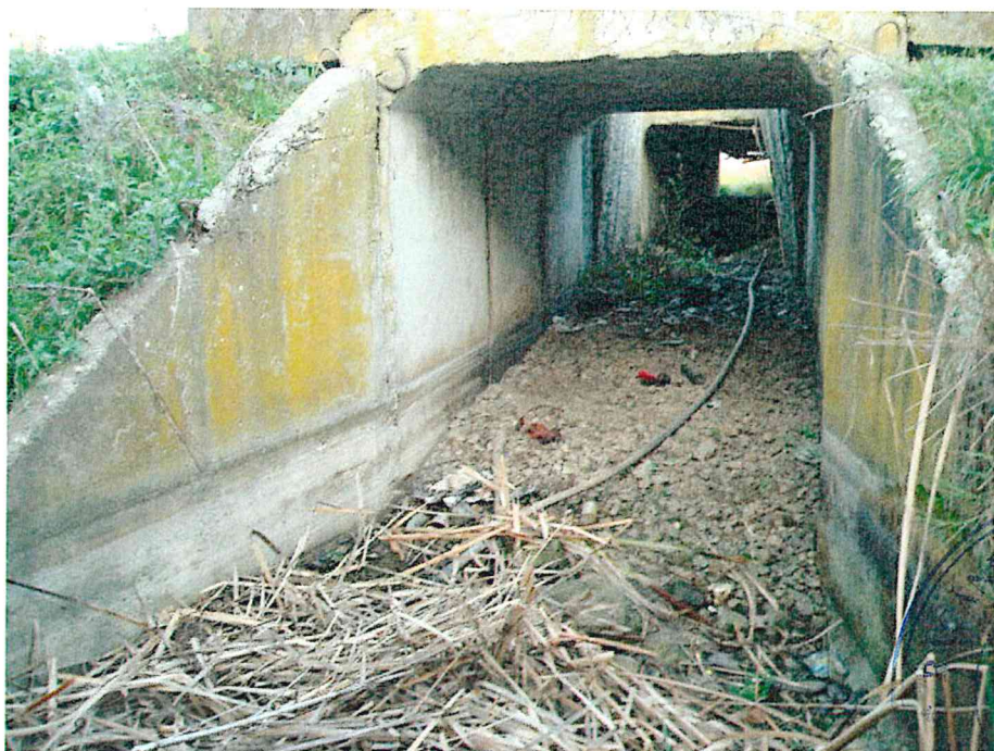
FOTO 9. Vedere amonte podeț drum
