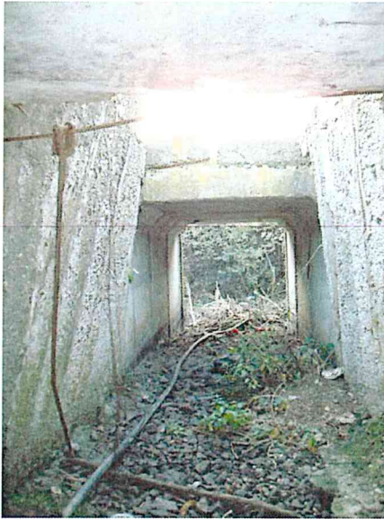
FOTO 3. Vedere sprijinire verticală
