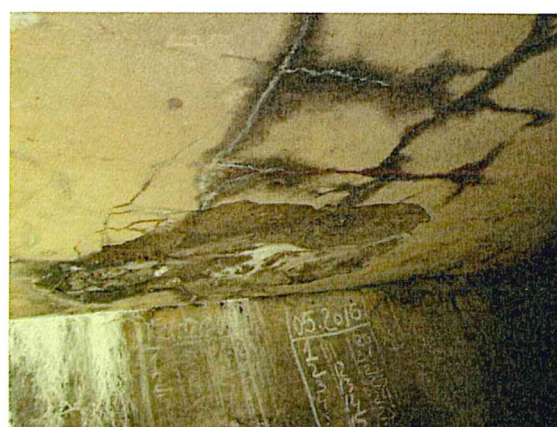
FOTO 2 și 3. Degradări ale betonului de față văzută la intradosul dalelor
