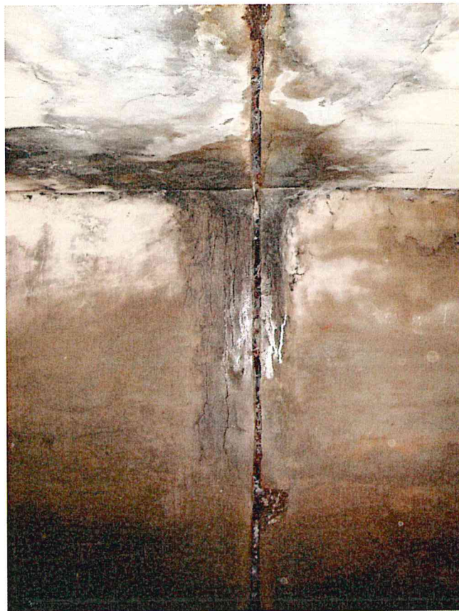
FOTO 10. Infiltrații active și calcifieri la rosturile dintre dale și culee.
