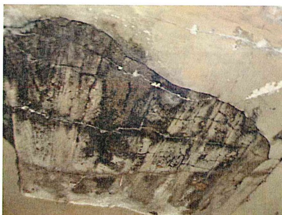
FOTO 2 și 3. Degradări ale betonului de față văzută la intradosul dalelor
