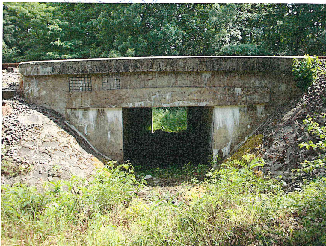
FOTO 1. Suprastructură și infrastructură podeț
