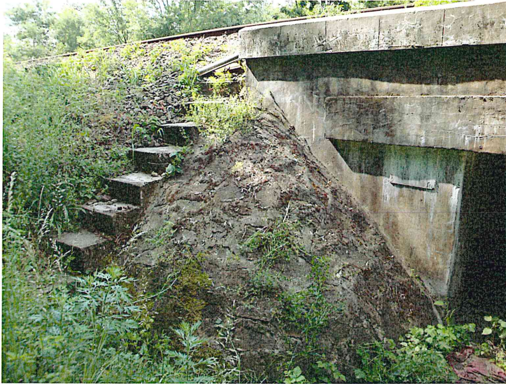
FOTO 7. Sfert de con și scări de acces pe terasament, funcționale.
