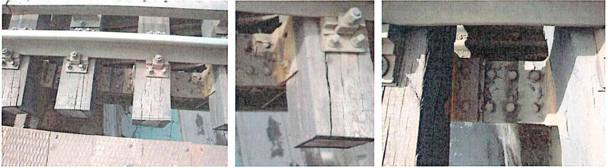
FOTO 3. Defecte ale căii pe pod
