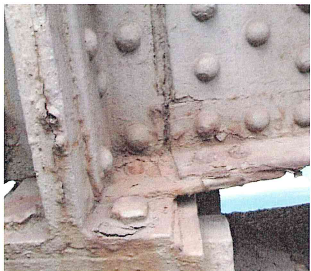
FOTO 5. Defecte ale structurii metalice
