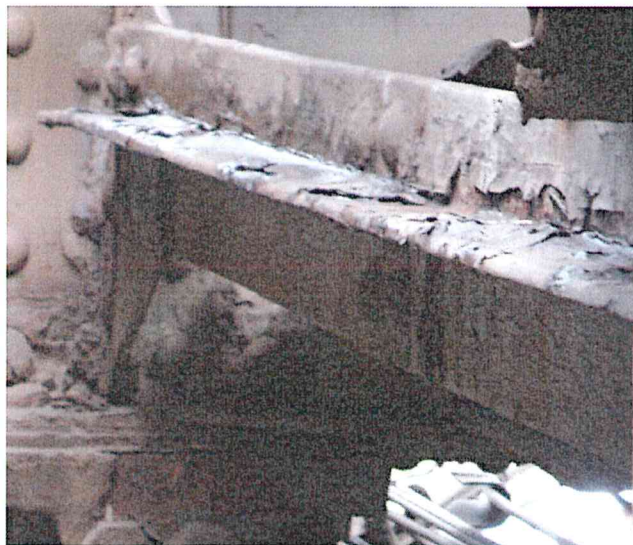
FOTO 5. Defecte ale structurii metalice
