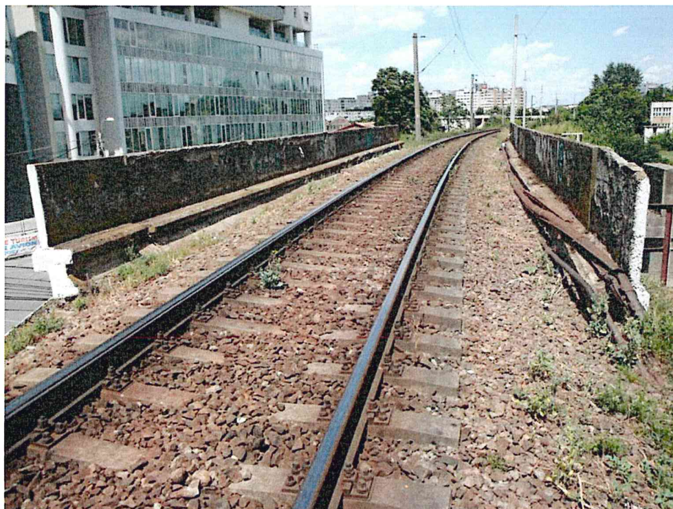
FOTO 2. Calea pe pod. Rețele de cabluri
