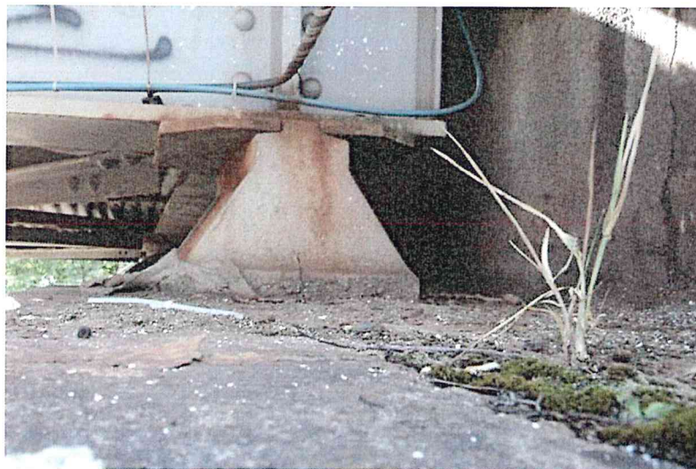
FOTO 14 Defecte ale aparatelor de reazem
