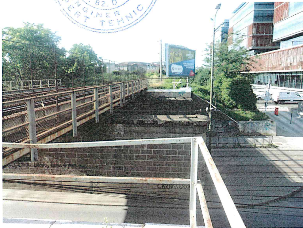
FOTO 1. Vedere spre Timișoara Est. Infrastructuri de cale triplă și suprastructuri de cale dublă
