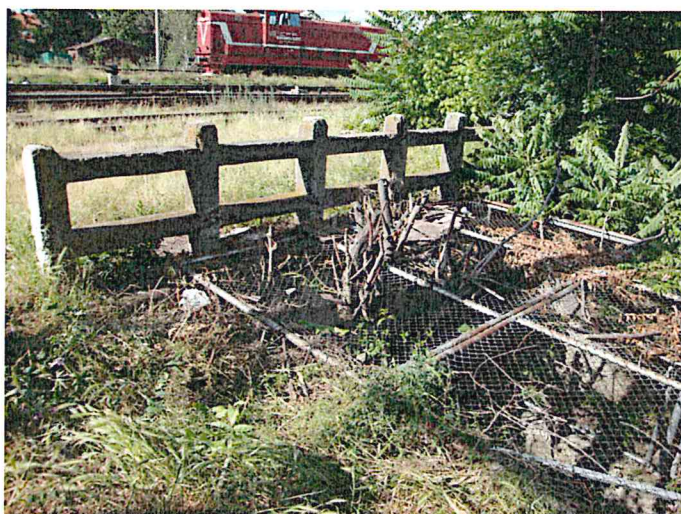
FOTO 10. Ieşire dezafectată podeţ
