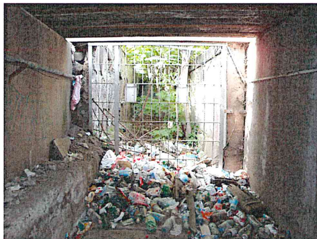
FOTO 8. ieșire înfundată podeț colmatată cu gunoai
