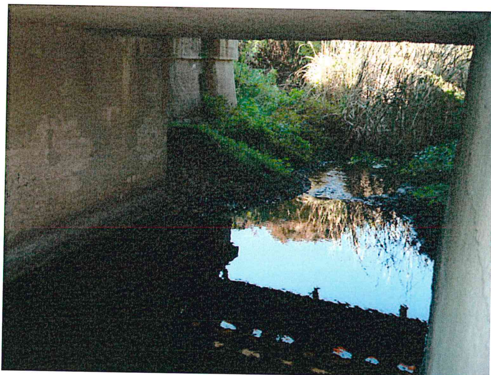
FOTO 9. Aspectul albiei sub pod
