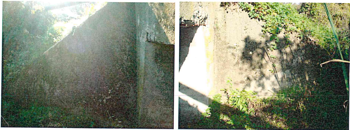
FOTO 3. Aspectul racordărilor podețului dalat cu terasamentul
