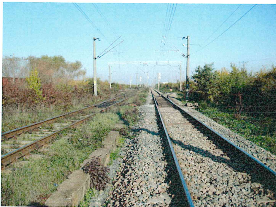
a) Vedere spre Arad
