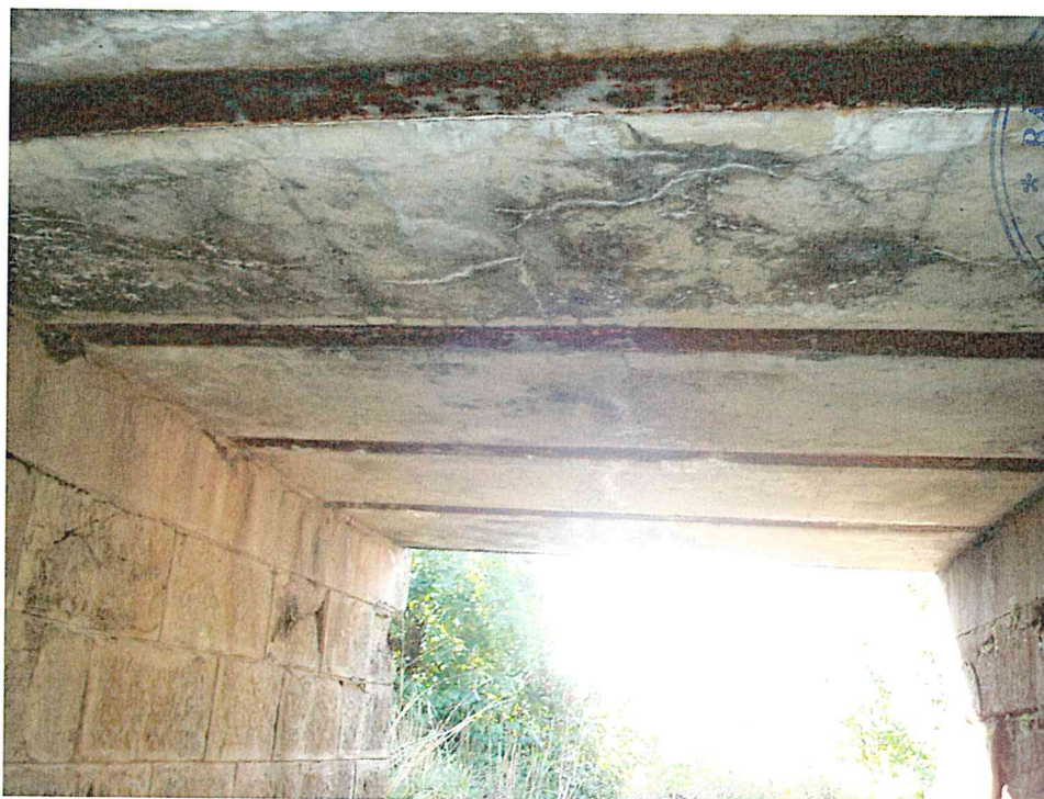
FOTO 2. Intrados podet cu profile I ruginite
