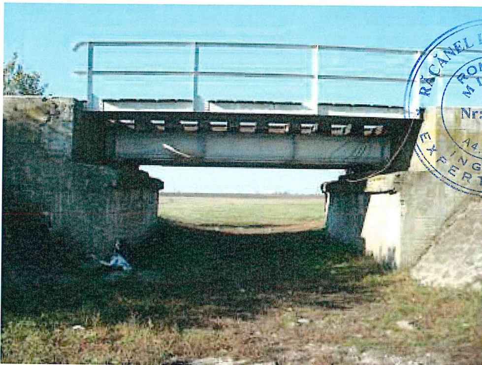
FOTO 12. Vedere stânga pod
