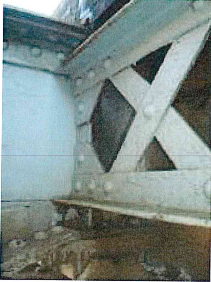
FOTO 10. Platbande degradate
