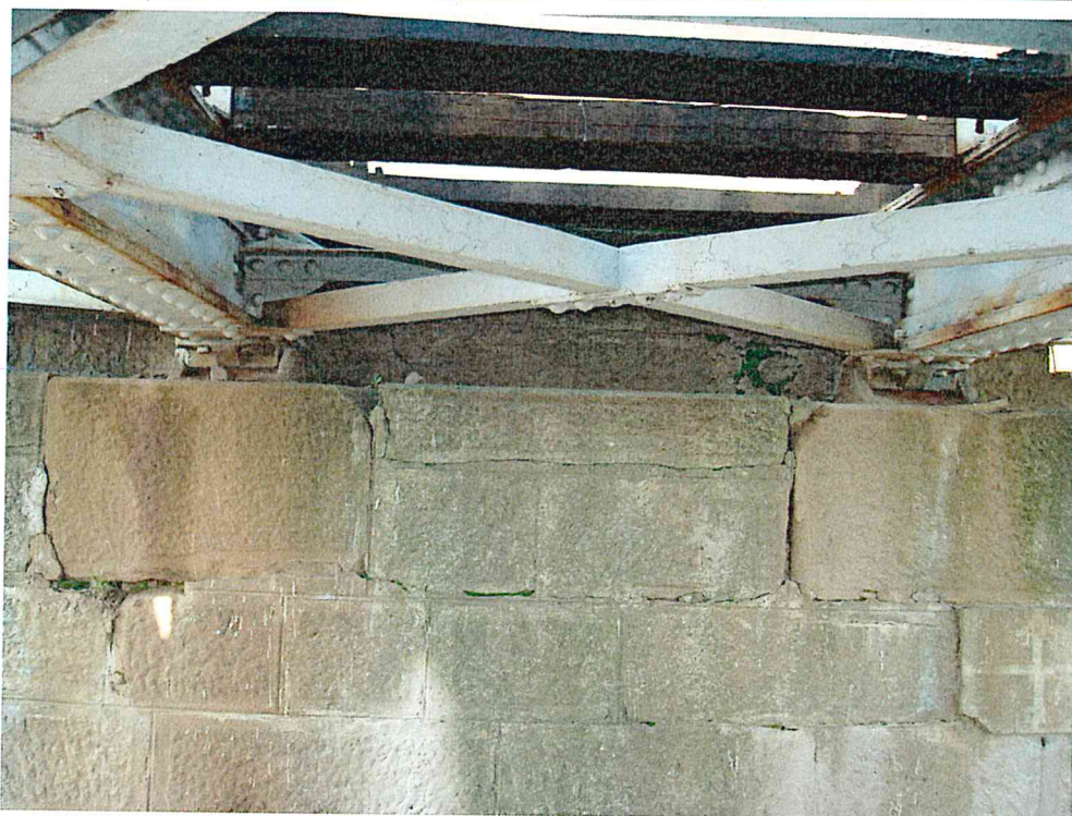
FOTO 4. Banchetă cuzineți cu moloane dislocate
