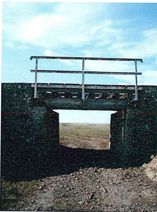
FOTO 2. Vedere stânga podeț
