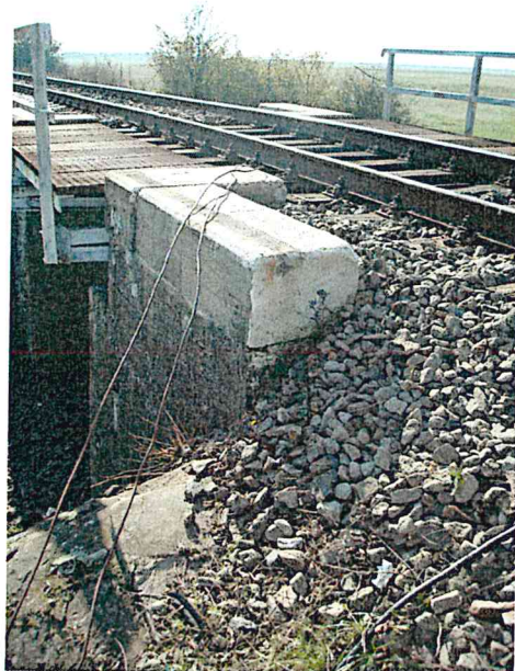
FOTO 8. Zid întors și sfert de con
