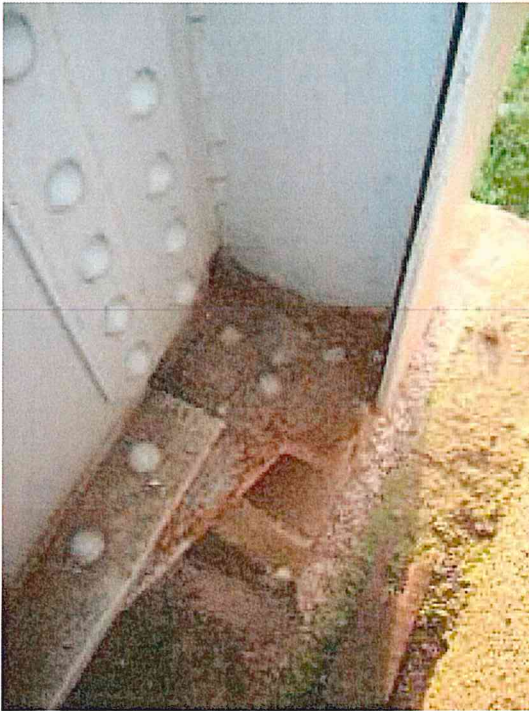
FOTO 11. Zona de rezemare
