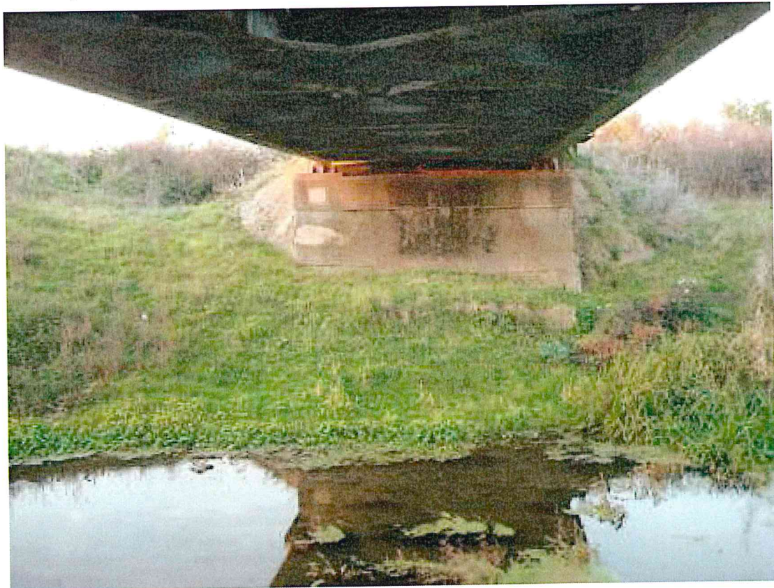
FOTO 10. Elevație culee și albie sub pod
