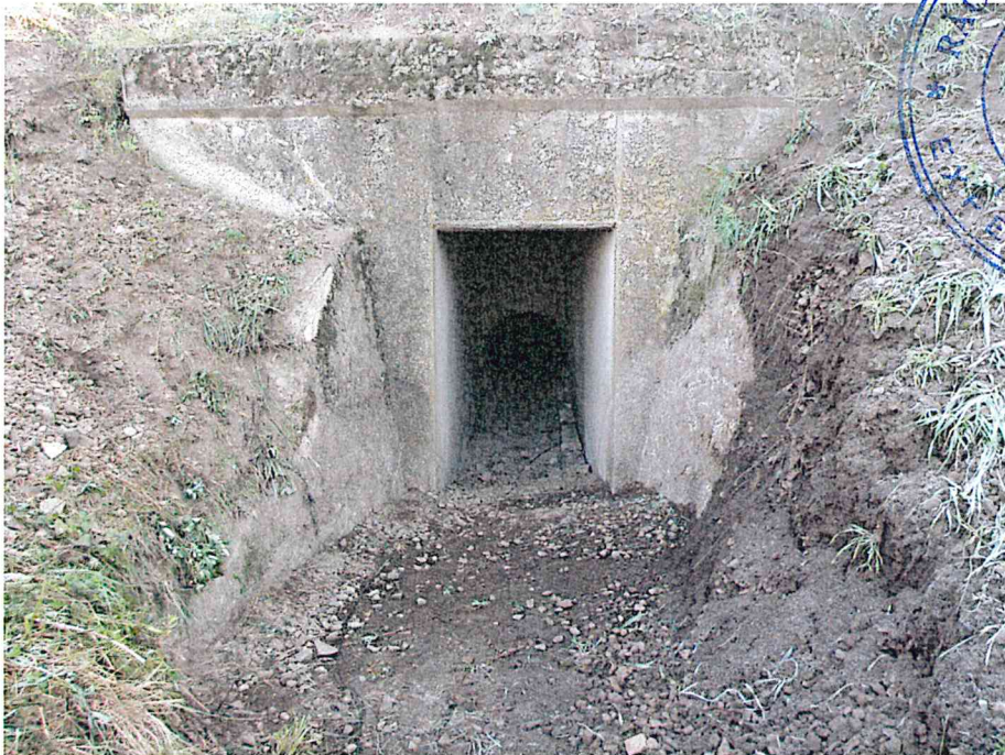
FOTO 6. Vedere ieșire stânga tronson dalat monolit IV
