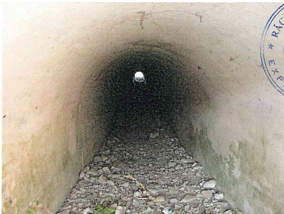
FOTO 2. Tronson I boltă cărămidă cămășuită
