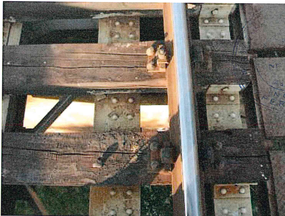
FOTO 8. Traverse degradate
