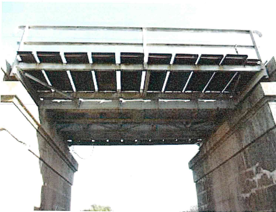
FOTO 7. Vedere intrados pod
