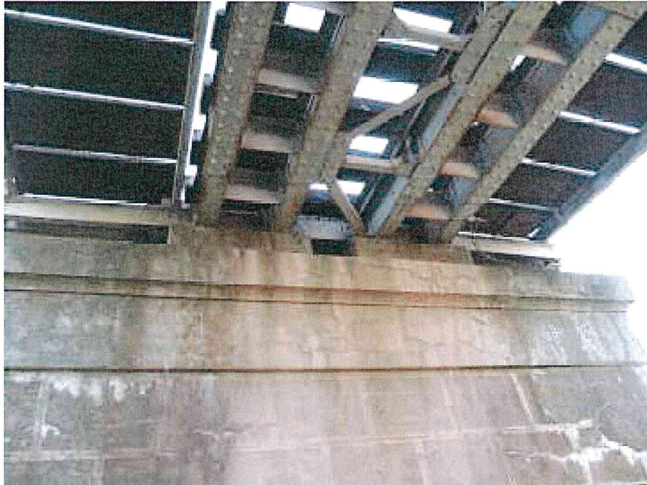
FOTO 4. Intrados tablier și rezemare pe culee
