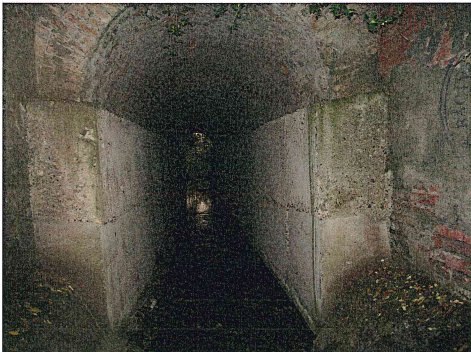
FOTO 2. Interior aval podeț boltit
