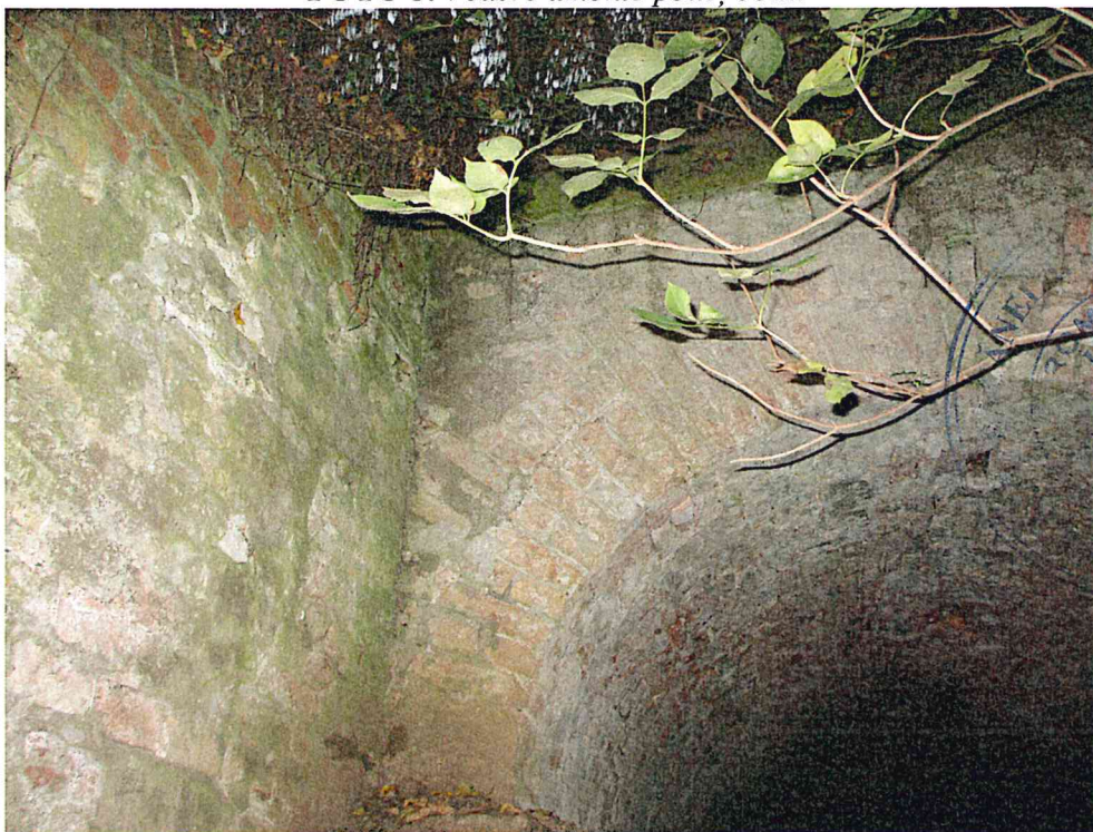
FOTO 6. Aripi și boltă cărămidă amonte
