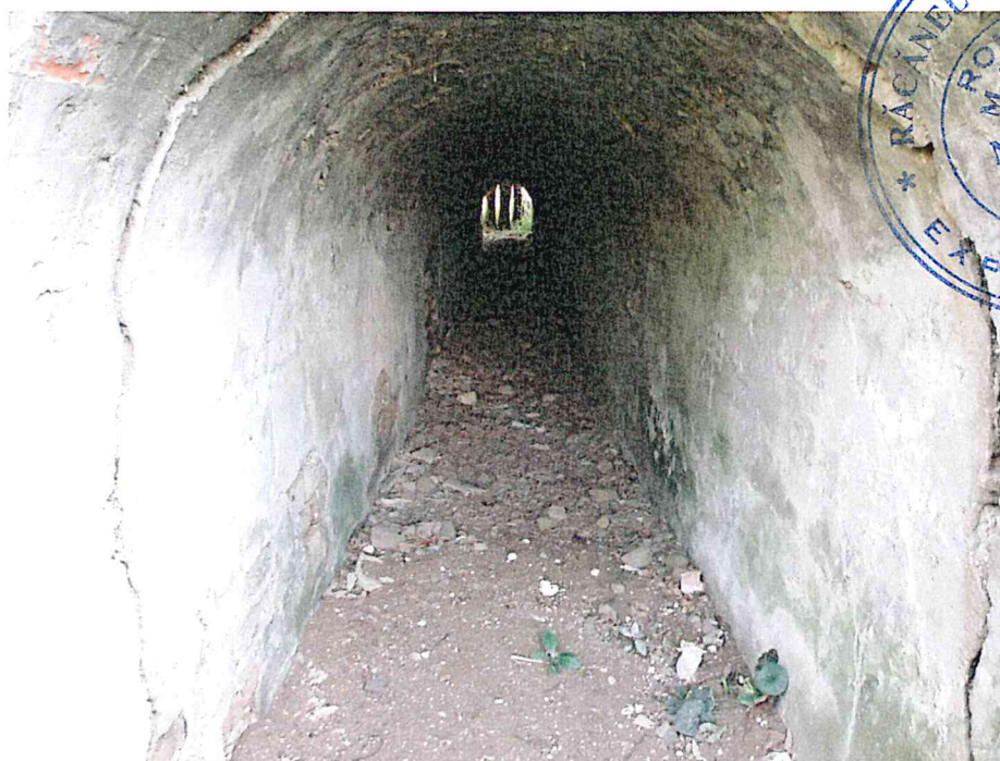
FOTO 2. Interior podeț boltit
