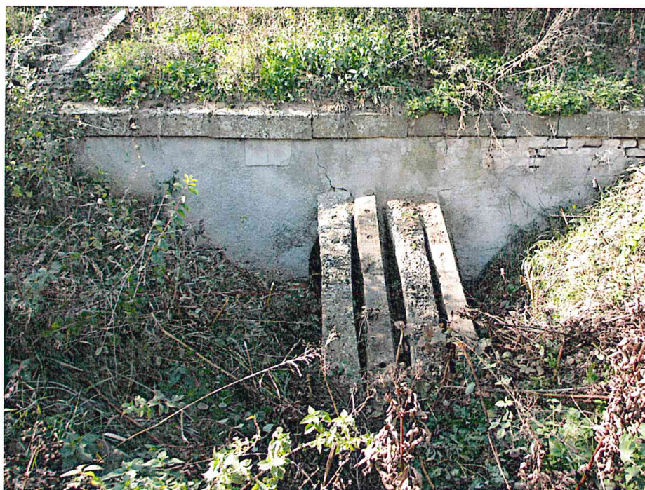
FOTO 4. Timpan aval și sprijinire cu traverse beton
