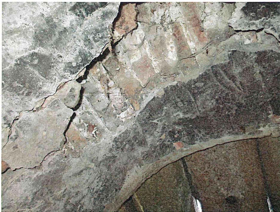
FOTO 5. Intrados boltă aval
