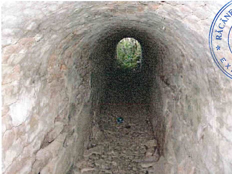
FOTO 2. Interior podeț boltit
